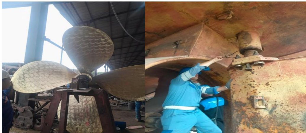
Gambar 3.20 Pengecekan pada propeller dan rudder stock
