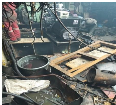
Gambar 3.120 Pemasangan Diesel Generator
