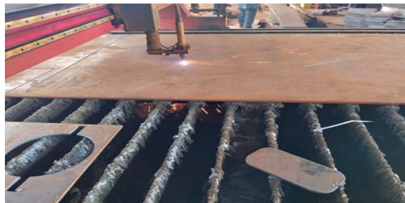
Gambar 3.48 Pemotongan Manhole Tangki
