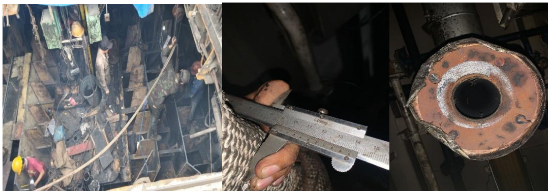
Gambar 3. 115 pengukuran Pipa AE
