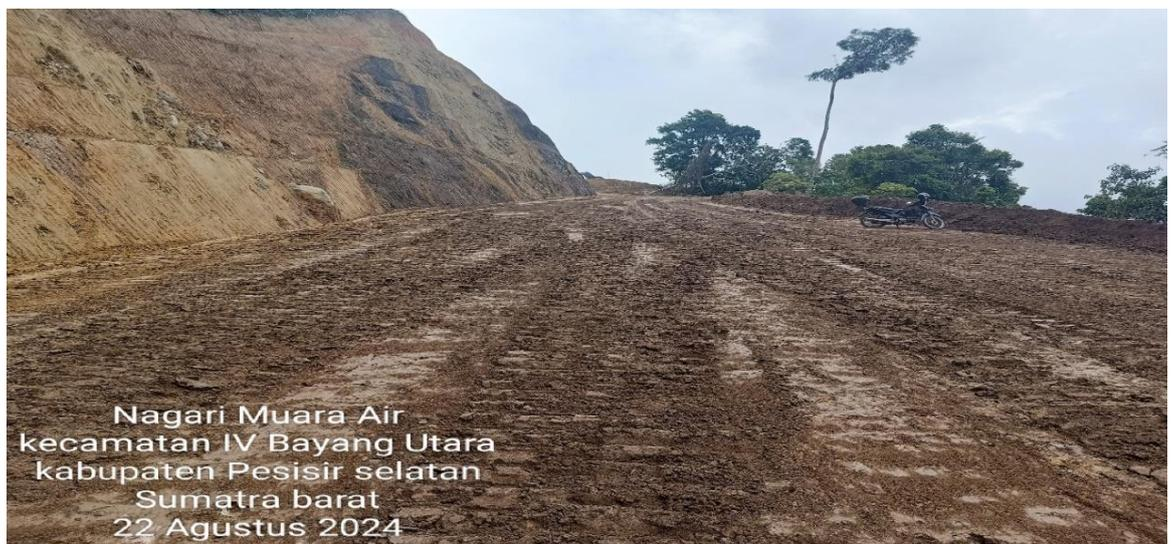
**Gambar 1. 2** Penyiapan Badan Jalan Pengaspalan Segmen 2
