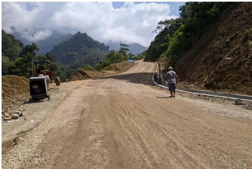
**Gambar 3. 33** Hasil pemadatan setelah di siram
