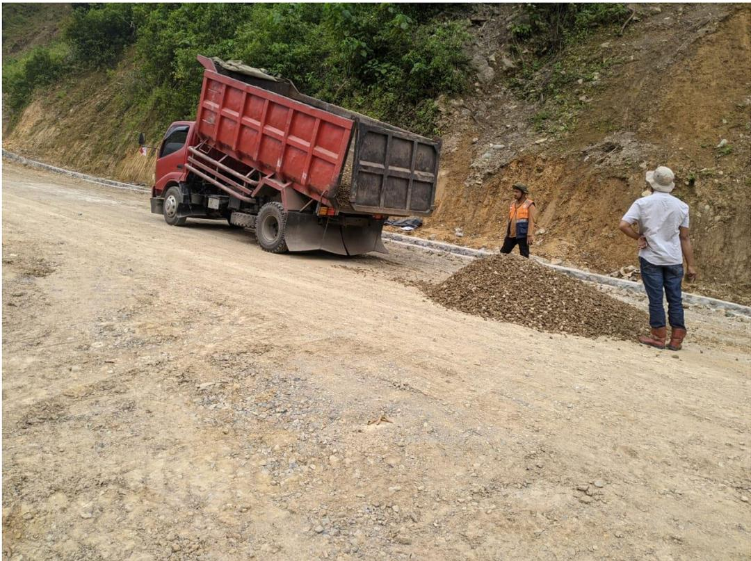
**Gambar 3. 25** Penurunan base B pada segmen 1
