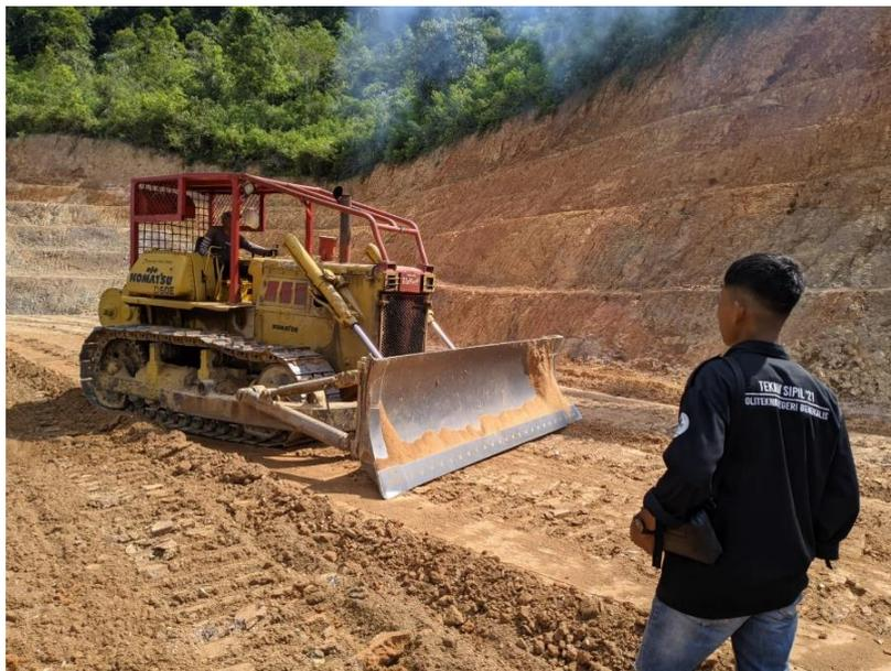
**Gambar 3. 9** Perataan badan jalan pada segmen 2 menggunakan dozer
