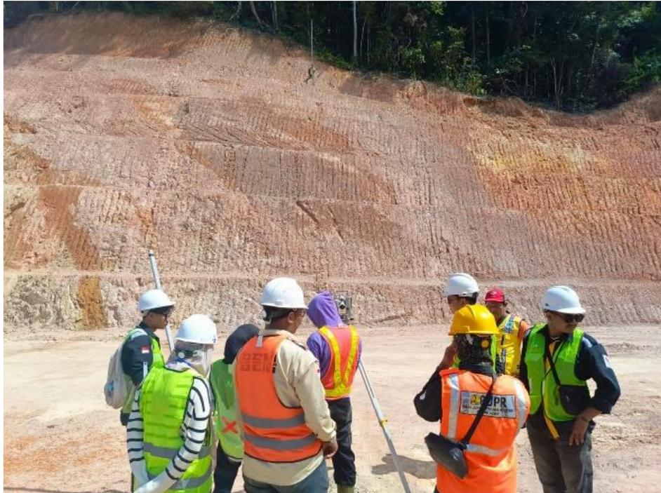
**Gambar 4. 22** Pengukuran sudut menggunakan theodolite
