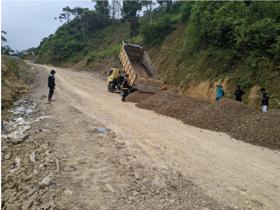
**Gambar 3. 26** Penurunan base B pada segmen 1
