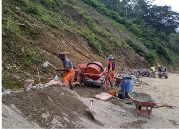
**Gambar 3. 12** Pembuatan mortar
