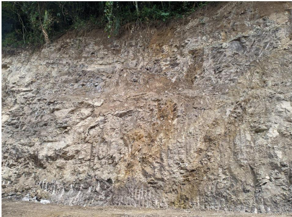
**Gambar 3. 5** tanah bebatuan pada daerah tebing yang lumayan tinggi yang di breaker
