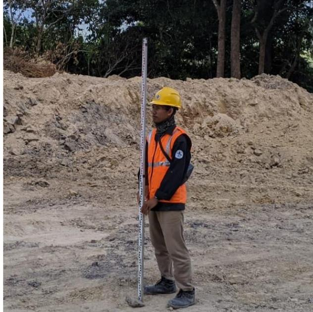
**Gambar 4. 18** Bak ukur untuk pengukuran
