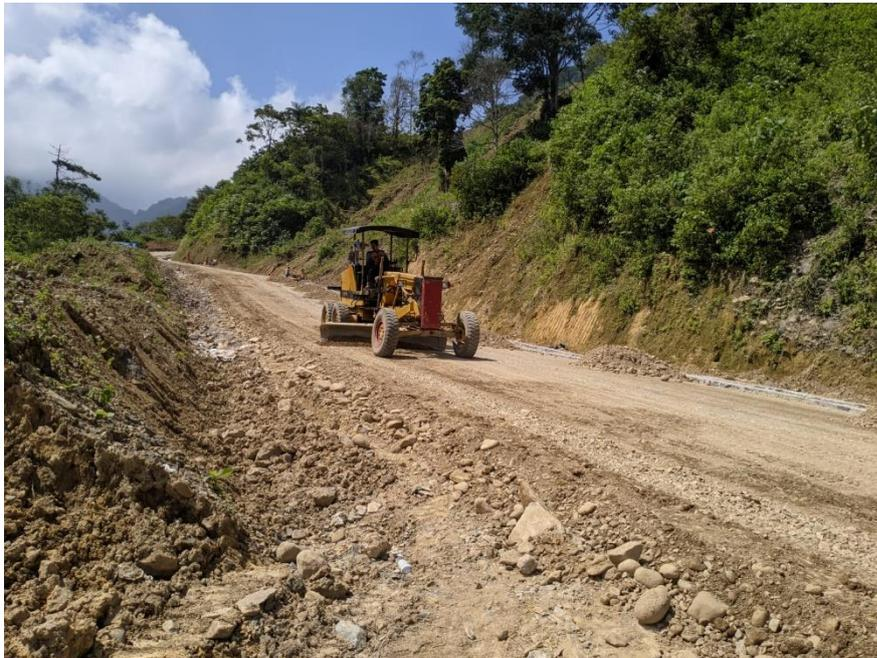
**Gambar 3. 27** Pemerataan base B menggunakan dozer pada segmen 1
