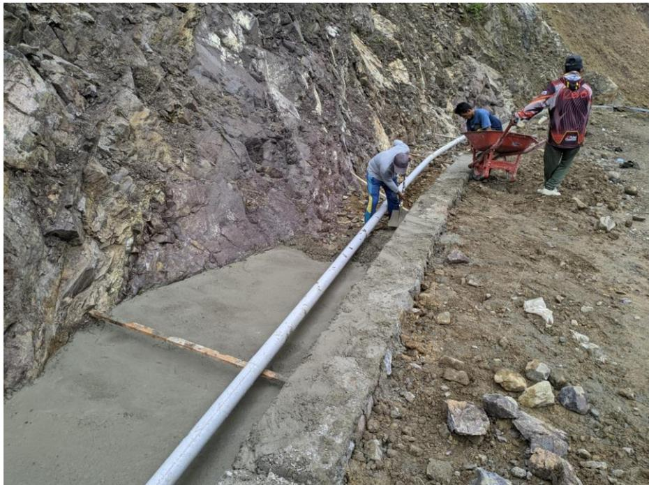
**Gambar 3. 17** Pengecoran lantai drainase
