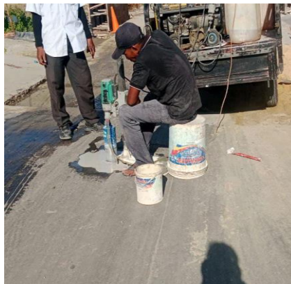
Gambar 3. 46 Mesin Core Drill (Sumber: Dokumentasi KP, 2024)
