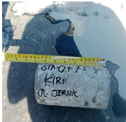
Gambar 3. 65 Hasil Core Drill (Sumber: Dokumentasi KP, 2024)
