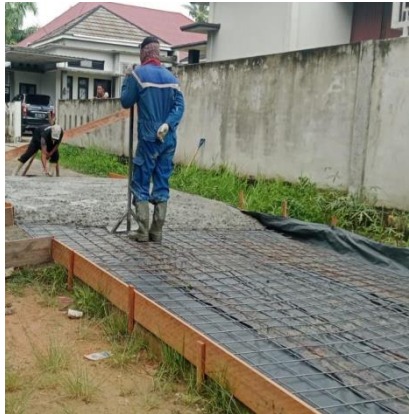
Gambar 3. 91 Pemasangan Besi Wiremesh (Sumber: Dokumentasi KP, 2024)
