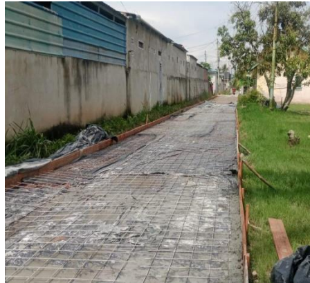
Gambar 3. 89 Pemasangan Bekisting (Sumber: Dokumentasi KP, 2024)
