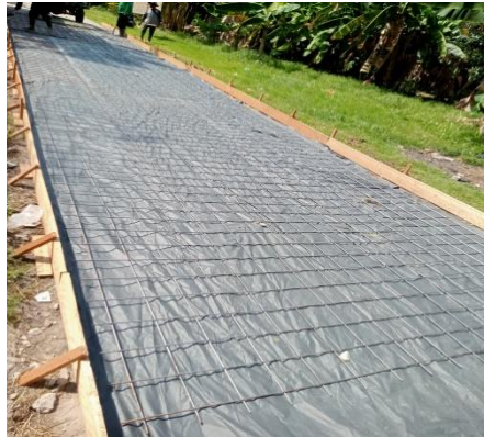
Gambar 3. 9 Pemasangan Besi Wiremesh (Sumber: Dokumentasi KP, 2024)
