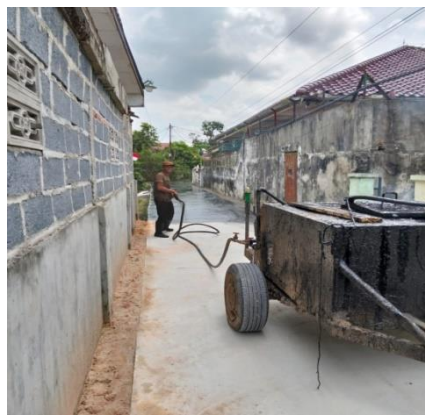
Gambar 3. 38 Pekerjaan Buras (Sumber: Dokumentasi KP, 2024)
