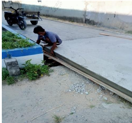
Gambar 3. 16 Pembongkaran Bekisting (Sumber: Dokumentasi KP, 2024)
