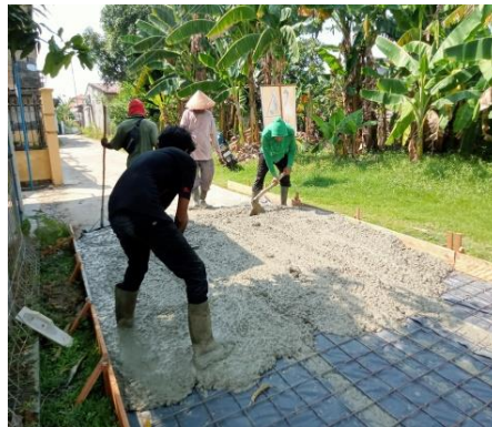
Gambar 3. 12 Pemadatan Beton (Sumber: Dokumentasi KP, 2024)
