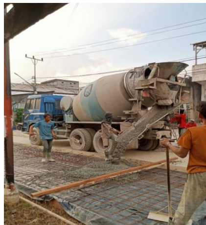
Gambar 3. 55 Penuangan Ready Mix (Sumber: Dokumentasi KP, 2024)
