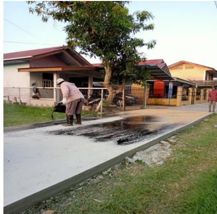
Gambar 3. 20 Pekerjaan Buras (Sumber: Dokumentasi KP, 2024)
