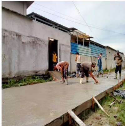
Gambar 3. 94 Perataan Permukaan Beton (Sumber: Dokumentasi KP, 2024)
