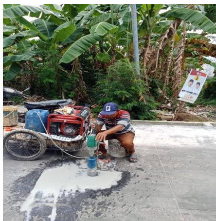
Gambar 3. 70 Mesin Core Drill (Sumber: Dokumentasi KP, 2024)
