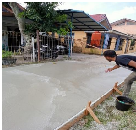
Gambar 3. 15 Perawatan Beton (Sumber: Dokumentasi KP, 2024)
