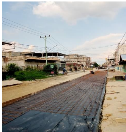
Gambar 3. 53 Pemasangan Besi Wiremesh (Sumber: Dokumentasi KP, 2024)
