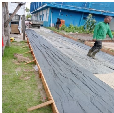
Gambar 3. 8 Pemasangan Plastik Cor (Sumber: Dokumentasi KP, 2024)
