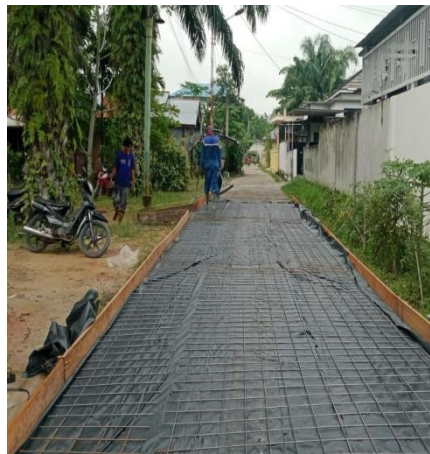
Gambar 3. 90 Pemasangan Plastik Co (Sumber: Dokumentasi KP, 2024)
