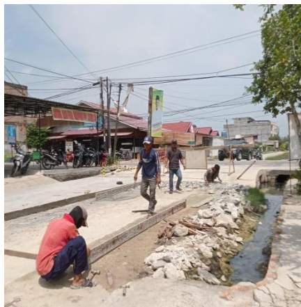
Gambar 3. 51 Pemasangan Bekisting (Sumber: Dokumentasi KP, 2024)
