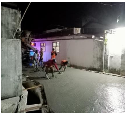
Gambar 3. 76 Perataan Permukaan Beton (Sumber: Dokumentasi KP, 2024)
