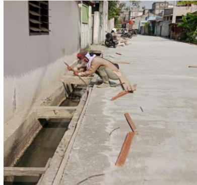
Gambar 3. 79 Pembongkaran Bekisting (Sumber: Dokumentasi KP, 2024)
