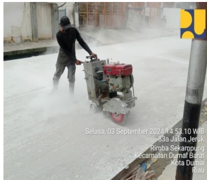
Gambar 3. 61 Pekerjaan Cutting
