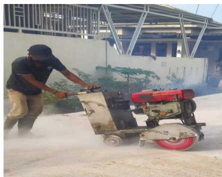
Gambar 3. 97 Pekerjaan Cutting
