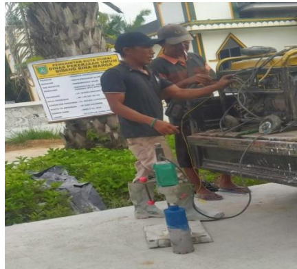
Gambar 3. 98 Pekerjaan Core Drill
