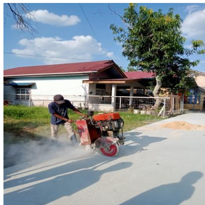
Gambar 3. 17 Pekerjaan Cutting (Sumber: Dokumentasi KP, 2024)
