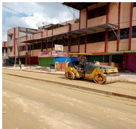
Gambar 3. 50 Pekerjaan Pemadatan Agg Kelas B (Sumber: Dokumentasi KP, 2024)
