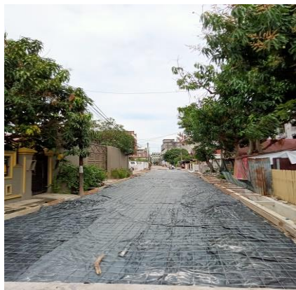
Gambar 3. 73 Pemasangan Besi Wiremesh (Sumber: Dokumentasi KP, 2024)
