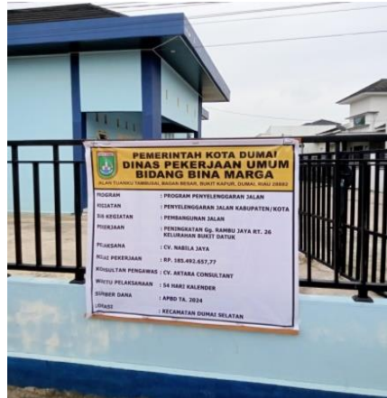
Gambar 2. 2 Papan Proyek (Sumber: Dokumentasi KP,2024)
