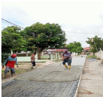
Gambar 3. 32 Pemadatan Beton (Sumber: Dokumentasi KP, 2024)
