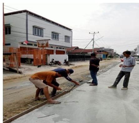
Gambar 3. 60 Pembongkaran Bekisting
