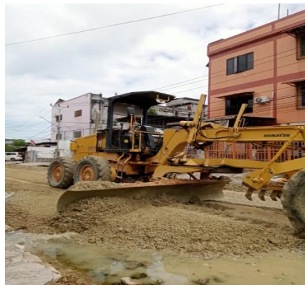
Gambar 3. 49 Pekerjaan Penghamparan Atau Perataan Agg Kelas B (Sumber: Dokumentasi KP, 2024)
