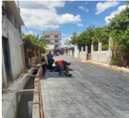
Gambar 3. 72 Pemasangan Plastik Cor (Sumber: Dokumentasi KP, 2024)
