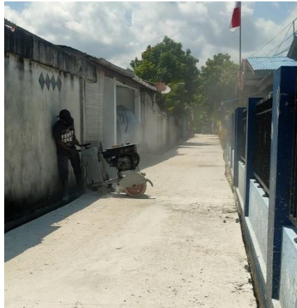
Gambar 3. 36 Pekerjaan Cutting (Sumber: Dokumentasi KP, 2024)
