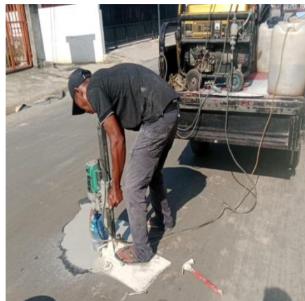
Gambar 3. 64 Pekerjaan Core Drill (Sumber: Dokumentasi KP, 2024)
