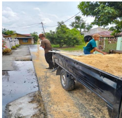
Gambar 3. 39 Pelebaran Pasir (Sumber: Dokumentasi KP, 2024)
