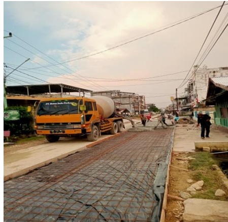
Gambar 3. 41 Truck Mixer (Sumber: Dokumentasi KP, 2024)
