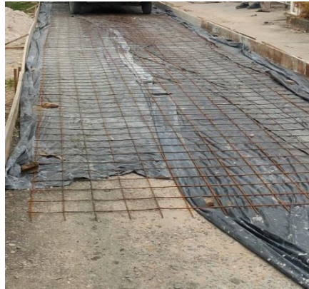
Gambar 3. 29 Pemasangan Besi Wiremesh (Sumber: Dokumentasi KP, 2024)
