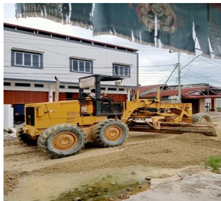
Gambar 3. 42 Motor Grader (Sumber: Dokumentasi KP, 2024)
