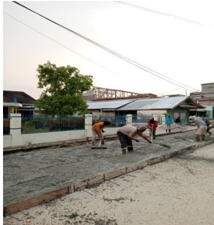
Gambar 3. 56 Pemadatan Beton (Sumber: Dokumentasi KP, 2024)
