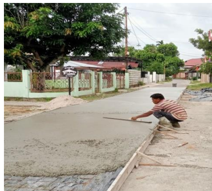
Gambar 3. 33 Perataan Permukaan Beton (Sumber: Dokumentasi KP, 2024)
