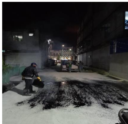
Gambar 3. 82 Pekerjaan Buras (Sumber: Dokumentasi KP, 2024)
