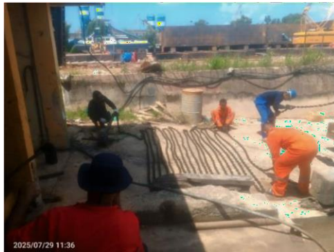
Gambar 3. 30 Proses membersihkan rantai & epoxy
