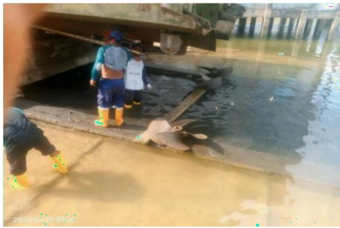
Gambar 3. 16 Melepas propeller dan mengganti life raft
