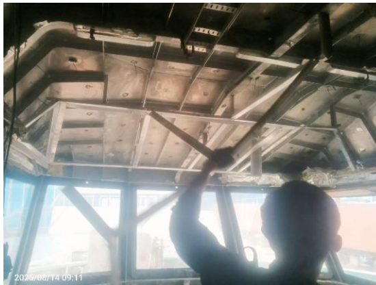
Gambar 3. 56 Pembongkaran dudukan triplek interior
