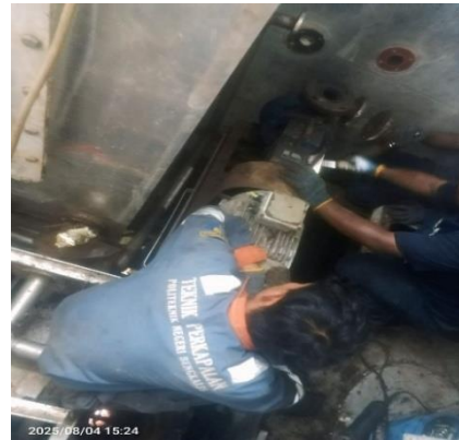
Gambar 3 . 40 Proses membuka pompa dan komponen yang sudah di dikeluarkan.
