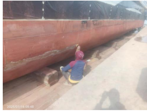
Gambar 3. 5 Proses Filler test dan sanding
