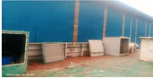
Gambar 3. 61 Cover blower sebelah kiri yang sudah terbuka
