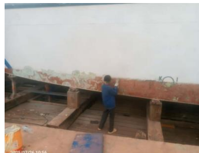
Gambar 3. 22 Proses pendempulan dan sanding
