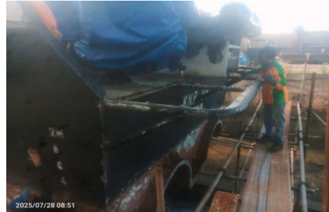
Gambar 3. 26 Proses Epoxy dan pembersihan frame grating plate
