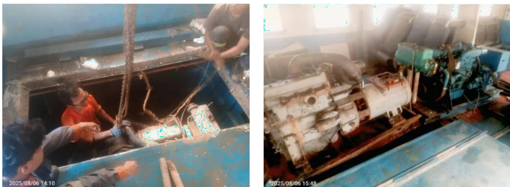
Gambar 3.45 Proses pengangkatan generator
