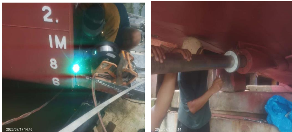
Gambar 3.9 Proses pengelasan trim dan pemasangan anode
