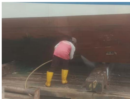
Gambar 3. 3 Membersihkan lambung kapal
