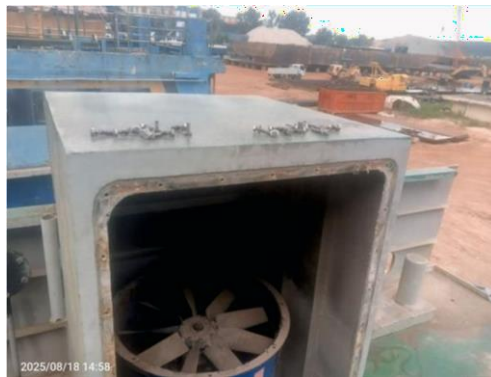
Gambar 3. 60 cover blower yang sudah terbuka
