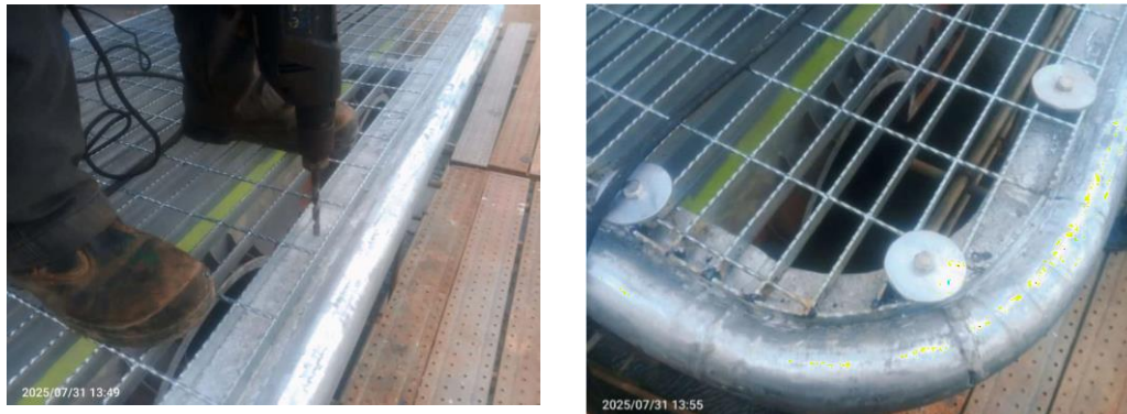
Gambar 3. 34 Proses pemasangan grating plate dan yang sudah terpasang
