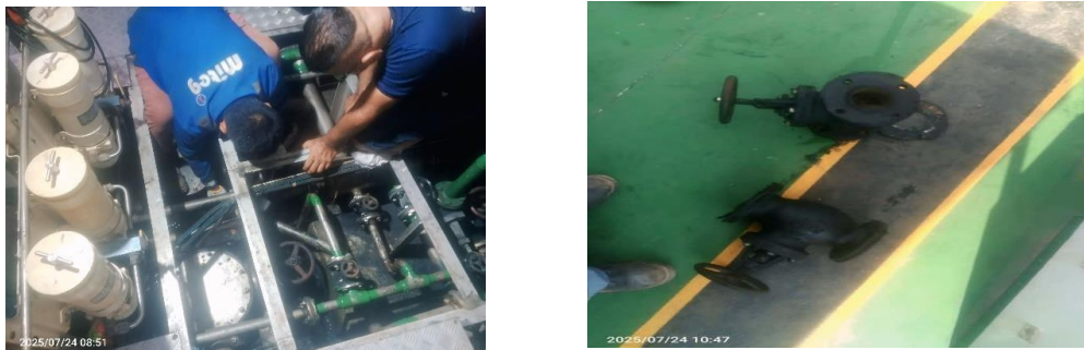
Gambar 3. 19 Proses membuka valve dan valve yang sudah di lepas
