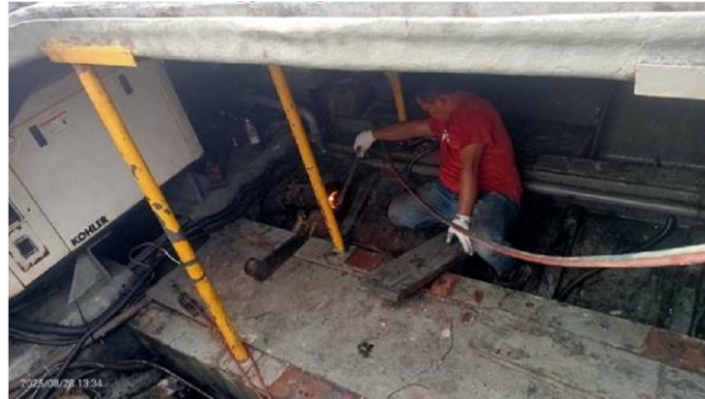
Gambar 3. 74 Proses pemasansan coupling
