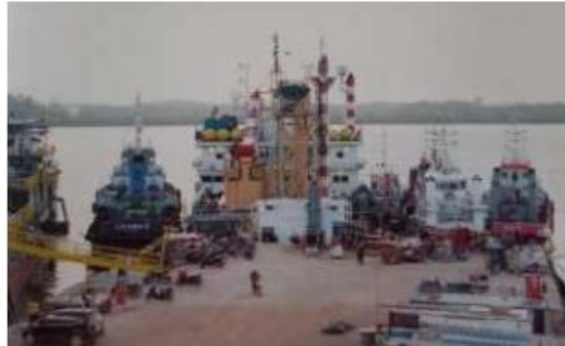
Gambar 2.8 Jetty sebagai tempat bersandar kapal
