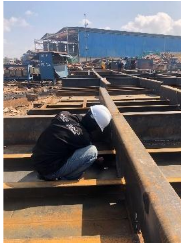
Gambar 3. 29 Inspek visual pengelasan
