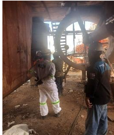
Gambar 3. 31 Inspeksi air test
