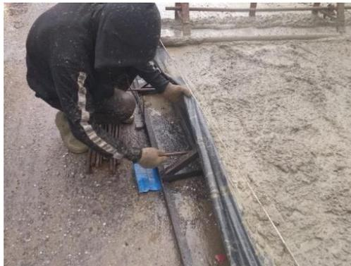
**Gambar 4. 13** Proses Pemasangan Tiebars
