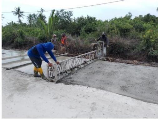
**Gambar 4.12** Proses Pemeratan Beton
