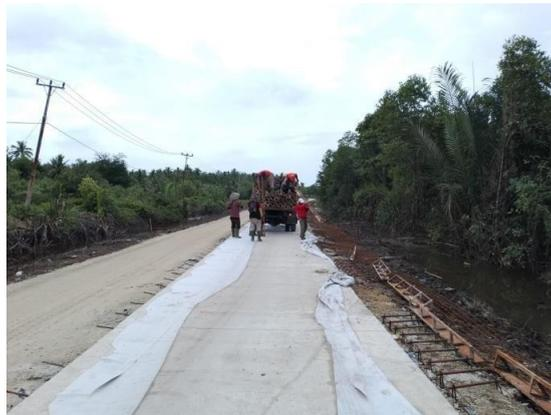
**Gambar 4. 15** Hasil Pengecoran
