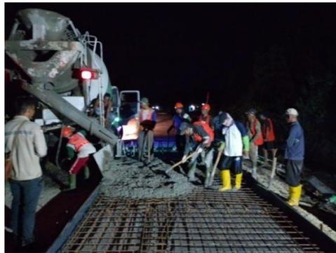
**Gambar 4. 9** Penuangan adukan beton
