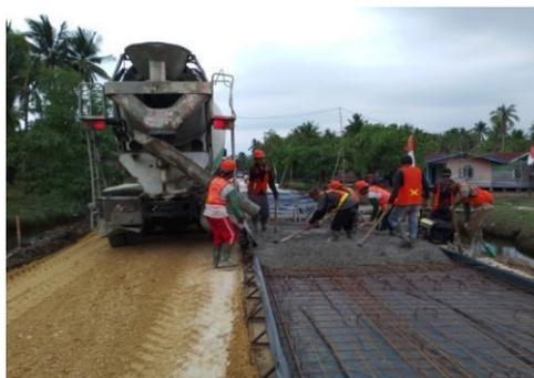
**Gambar 4. 6** Truck Mixer Dilokasi Pengecoran
