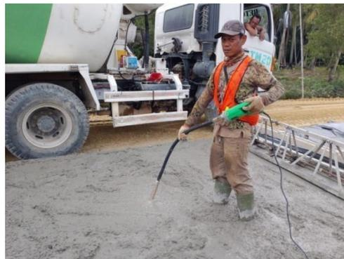
**Gambar 4. 11** Proses Pemadatan Beton
