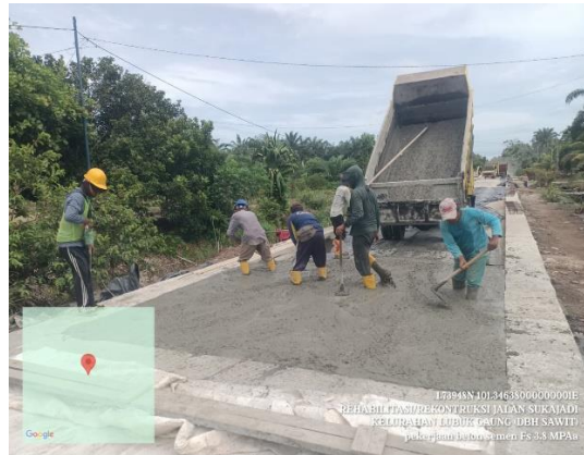
Gambar 3. 20 Pengecoran Rigid (sumber : Dokumentasi Lapangan, Kerja Praktek 2025)
