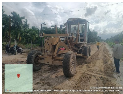
Gambar 3. 10 Perataan agregat base A (sumber : Dokumentasi Lapangan, Kerja Praktek 2025)
