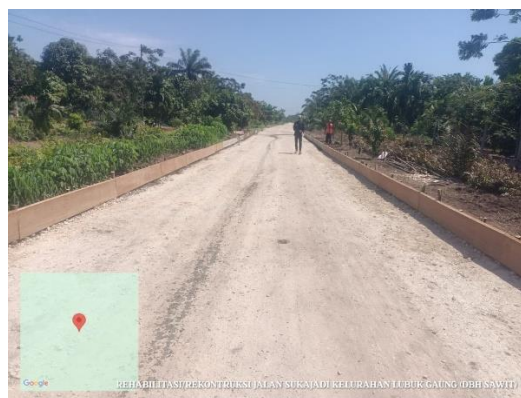
Gambar 3. 14 Pemasangan Bekisting LC (sumber : Dokumentasi Lapangan, Kerja Praktek 2025)
