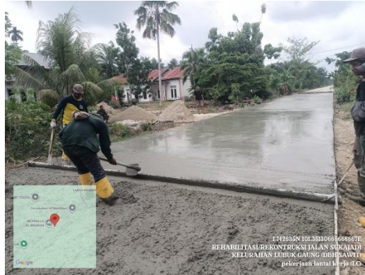
Gambar 3. 22 Meratakan Permukaan Beton (sumber : Dokumentasi Lapangan, Kerja Praktek 2025)
