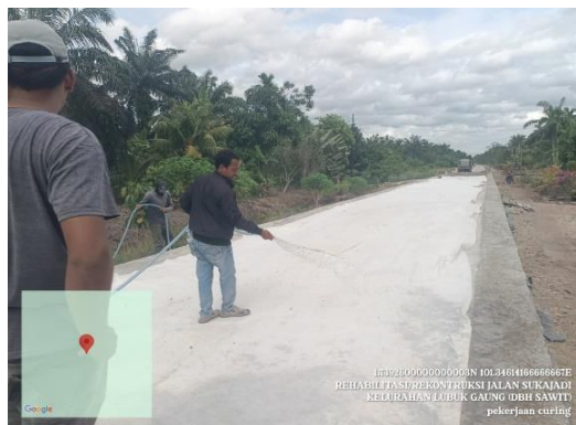
Gambar 3. 25 Pekerjaan Perawatan Beton curring (sumber : Dokumentasi Lapangan, Kerja Praktek 2025)
