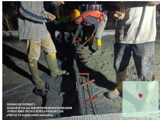
Gambar 3. 19 Pemasangan Tie Bar (sumber : Dokumentasi Lapangan, Kerja Praktek 2025)
