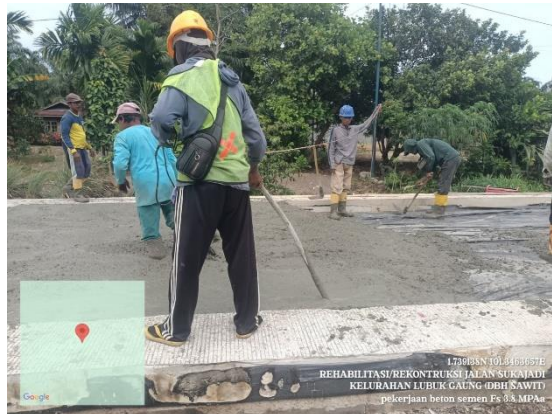
Gambar 3. 21 Pemadatan Beton Menggunakan Vibrator (sumber : Dokumentasi Lapangan, Kerja Praktek 2025)
