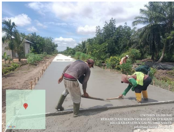
Gambar 3. 23 Finishing (sumber : Dokumentasi Lapangan, Kerja Praktek 2025)
