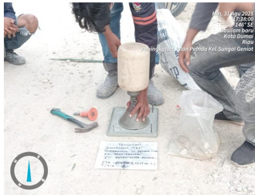
Gambar 3. 13 Pengujian Sand Cone (sumber : Dokumentasi Lapangan, Kerja Praktek 2025)
