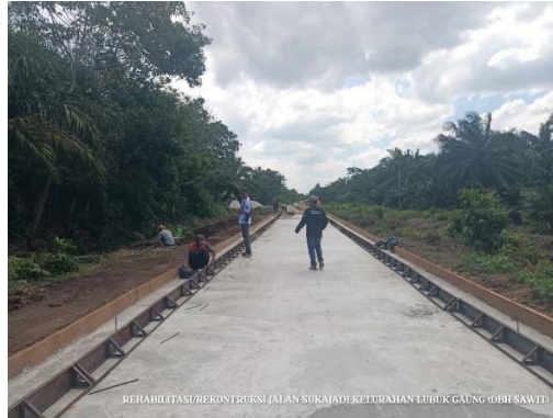
Gambar 3. 16 pemasangan bekisting bahu jalan
