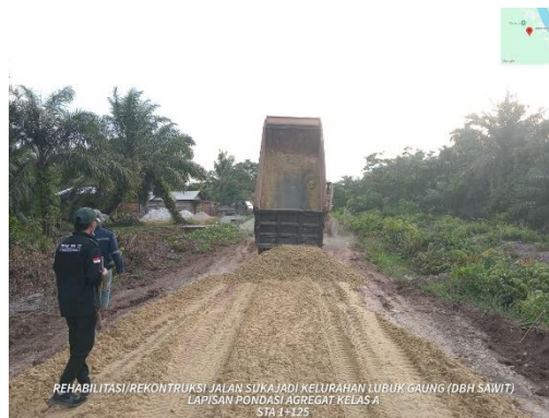
Gambar 3. 4 Penghamparan Base A dari Dump Truck
