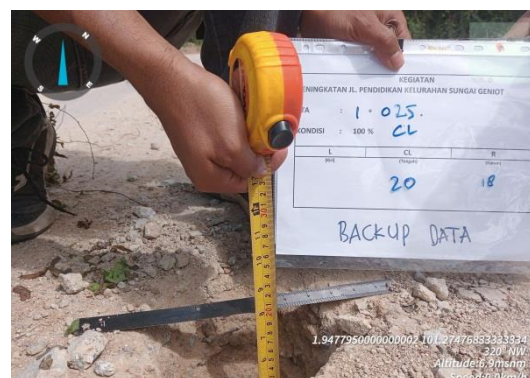
Gambar 3. 12 Pengukuran ketebalan Base A (sumber : Dokumentasi Lapangan, Kerja Praktek 2025)
