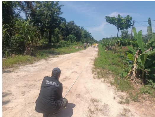
Gambar 3. 9 Pemasangan patok STA (sumber : Dokumentasi Lapangan, Kerja Praktek 2025)
