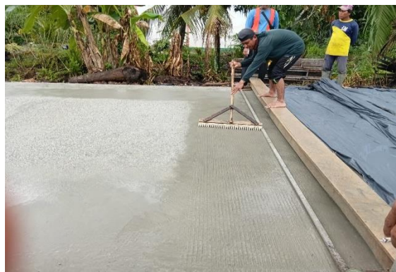
Gambar 3. 24 Pekerjaan Grooving (sumber : Dokumentasi Lapangan, Kerja Praktek 2025)
