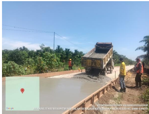
Gambar 3. 15 Pengecoran LC (sumber : Dokumentasi Lapangan, Kerja Praktek 2025)
