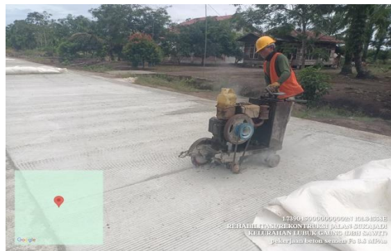
Gambar 3. 26 Pekerjaan Cutting (sumber : Dokumentasi Lapangan, Kerja Praktek 2025)
