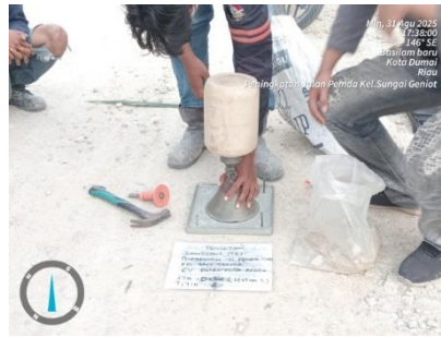
Gambar 3. 7 Pengujian Kepadatan Base A (Sumber: Dokumentasi Lapangan 2025)
