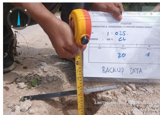
Gambar 3. 6 Test sand cone Base A (Sumber: Dokumentasi Lapangan 2025)
