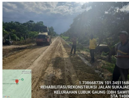
Gambar 3. 11 Pemadatan agregat base A (sumber : Dokumentasi Lapangan, Kerja Praktek 2025)
