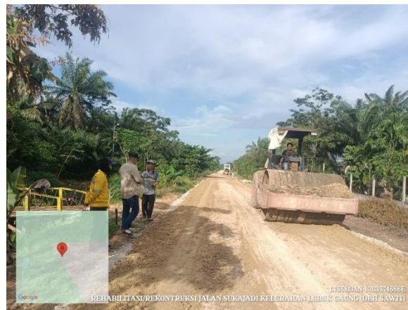
Gambar 3. 5 Pemadatan Base A (Sumber: Dokumentasi Lapangan 2025)
