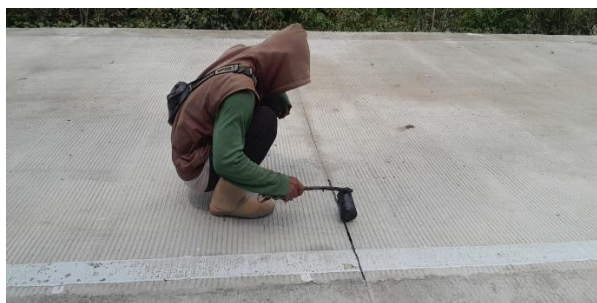
Gambar 3. 27 Pekerjaan Joint Sealent (sumber : Dokumentasi Lapangan, Kerja Praktek 2025)
