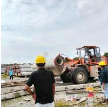
gambar 3.31 proses pemindahan spun pile ke area stock
