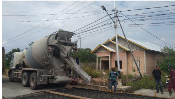
Gambar 3.2 Proses pekerjaan pengecoran beton
