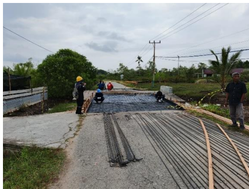
Gambar 3.3 Pemasangan bekisting dan tulangan pelat jembatan
