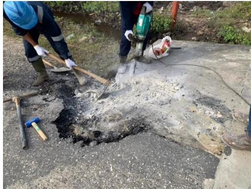
Gambar 3.2 Proses pembongkaran beton jembatan yang rusak
