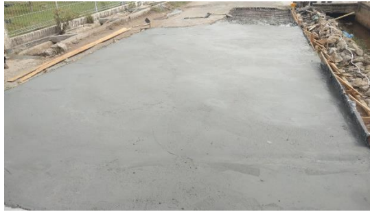
Gambar 3.4 Kondisi setelah di lakukan pengecoran
