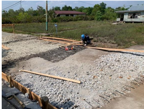
Gambar 3.9 Pembongkaran beton
