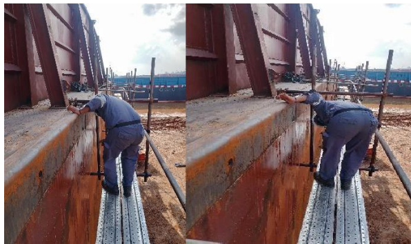
Gambar 3.18 Pengujian air test external
