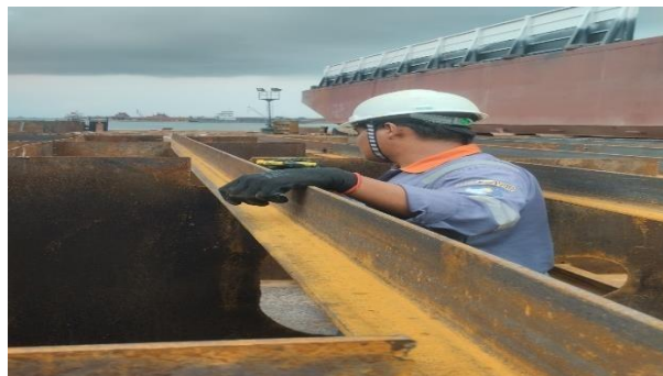
Gambar 3.32 Inspeksi pengelasan
