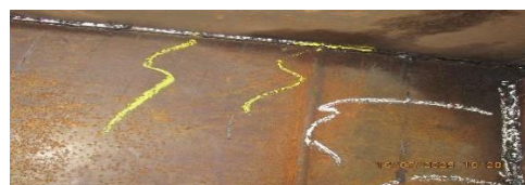
Gambar 3.3 Inspeksi pengelasan void tank
