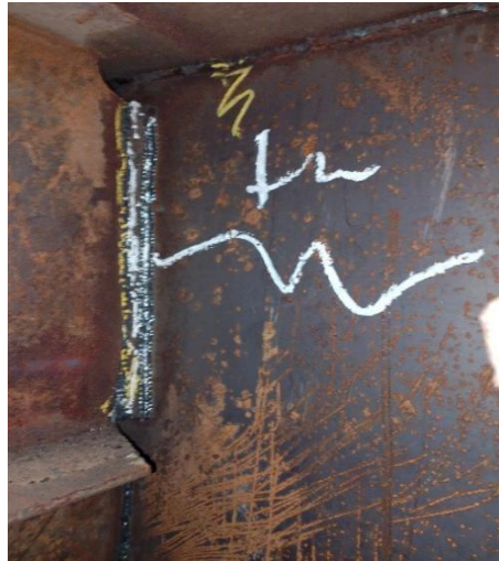
Gambar 3.7 Inspect welding pada bagian void tank
