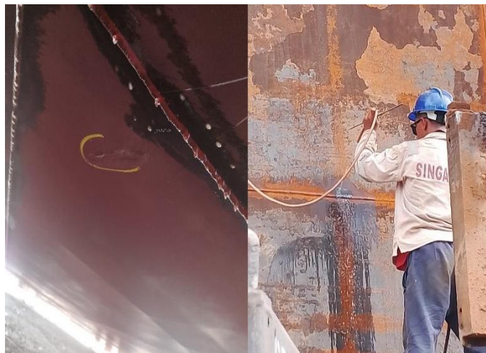
Gambar 3.8 Melakukan pengujian air test
