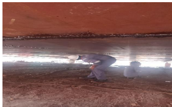
Gambar 3.36 Pengujian air test pada plat keel
