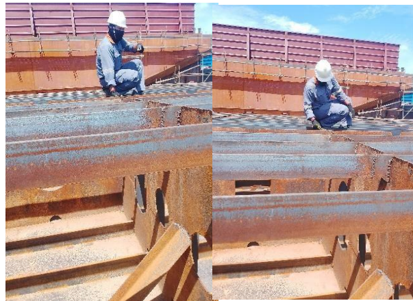
Gambar 3.37 Inspect welding pada bagian Double Bottom
