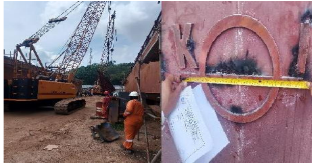
Gambar 3.21 pemasangan side board dan plimsol mark
