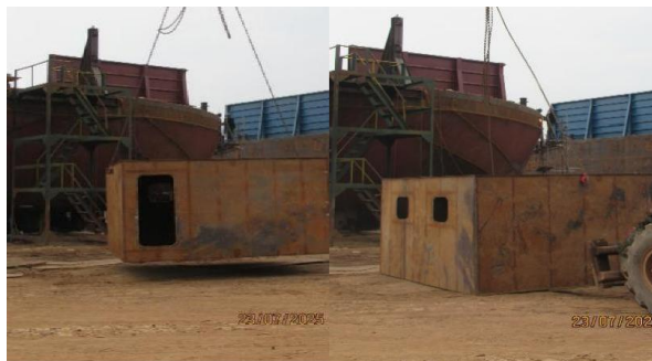
Gambar 3.13 pemasangan chain loker pada kapal tongkang
