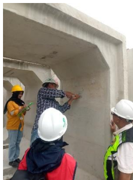
Gambar 3.18 menguji box dengan hammer test Sumber: dokumentasi kerja praktek PT. Kj 2025
