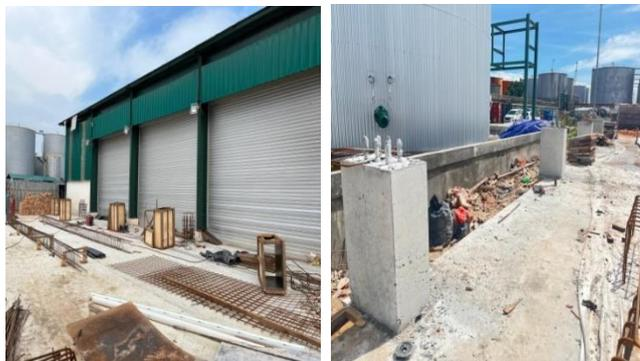
Gambar 3.53 kolom pedestal yang sudah di cor
