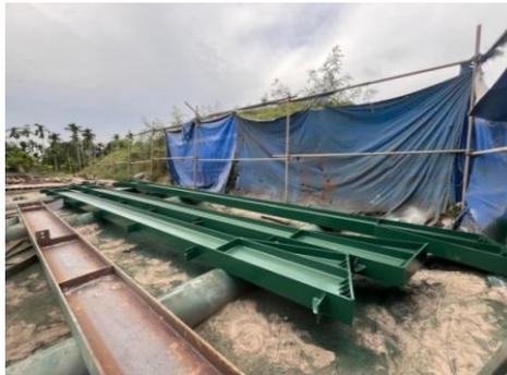
Gambar 3. 16 Proses pengecatan
