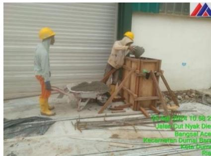
Gambar 3.52 Pekerjaan pengecoran kolom
