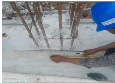
Gambar 3.49 Pekerjaan marking pedestal
