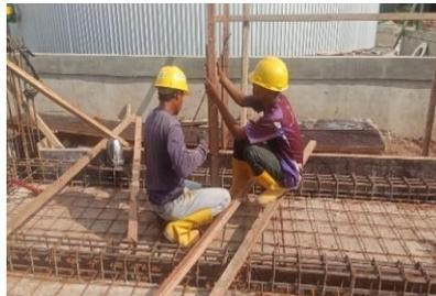
Gambar 3.43 Pemasangan *Bekisting* Lantai
