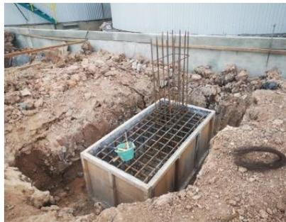
Gambar 3. 27 Setelah bekisting dipasang
