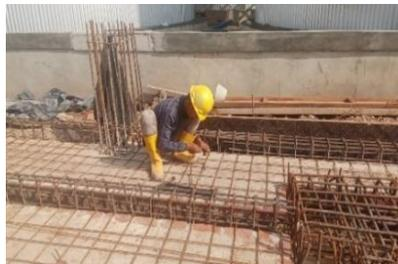
Gambar 3.42 Pemasangan Besi Suport Bar
