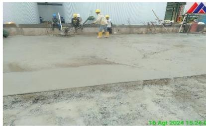
Gambar 3.46 Pekerjaan Finishing
