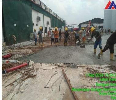
Gambar 3.35 Pengecoran *Ground Beam*
