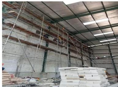
Gambar 3.69 Pekerjaan plasteran dinding
