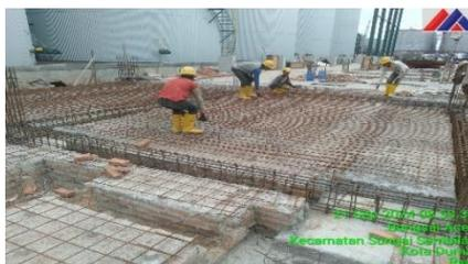
Gambar 3.40 Pemasangan Ware Mesh 2 Layer
