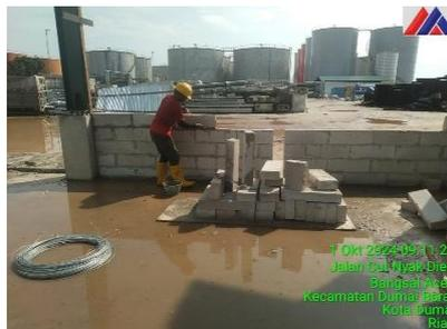
Gambar 3.64 Pekerjaan pemasangan Bata Ringan
