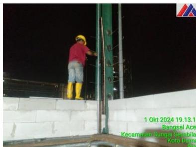
Gambar 3.66 Pekerjaan pemasangan Stick Bar
