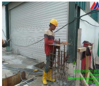
Gambar 3.50 Pekerjaan perakitan dan pemasangan besi angkur
