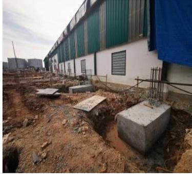
Gambar 3.29 Hasil setelah pengecoran
