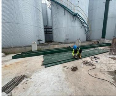
Gambar 3.55 *Erection* struktur baja WF dengan *Scaffolding* plan
