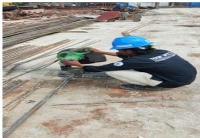
Gambar 3. 22 Pekerjaan Pemotongan besi utama
