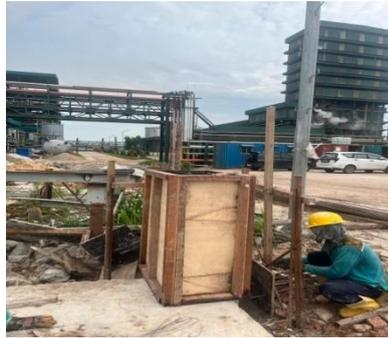
Gambar 3.51 Pekerjaan pemasangan bekisting kolom
