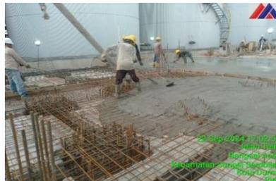
Gambar 3.44 Pekerjaan Pengecoran K300
