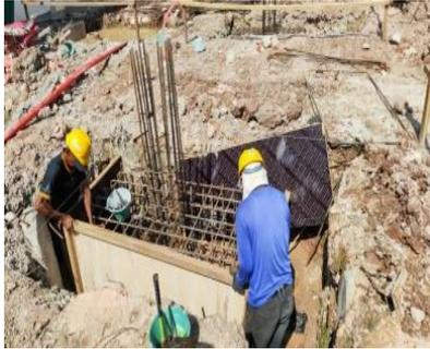
Gambar 3. 26 Pekerjaan Pemasangan bekisting
