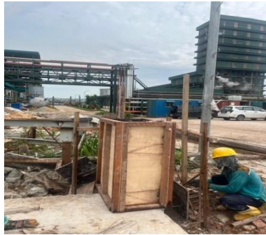
Gambar 3.51 Pekerjaan pemasangan bekisting kolom ( Sumber : Dokumentasi lapangan 2024 )
