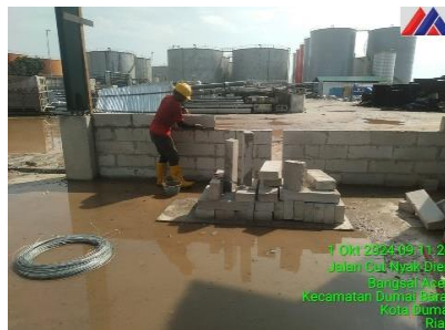
Gambar 3.64 Pekerjaan pemasangan Bata Ringan ( Sumber : Dokumentasi lapangan 2024 )
