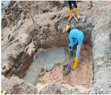
Gambar 3. 21 Pekerjaan lantai kerja ( Sumber : Dokumentasi lapangan 2024 )
