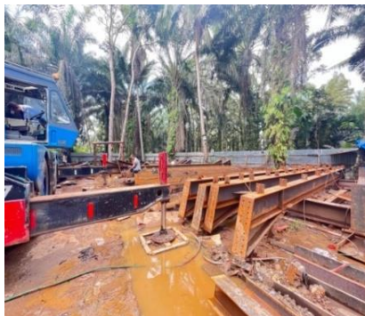
Gambar 3. 14 Proses finishing ( Sumber : Dokumentasi lapangan 2024 )
