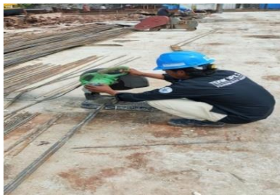
Gambar 3. 22 Pekerjaan Pemotongan besi utama ( Sumber : Dokumentasi lapangan 2024 )
