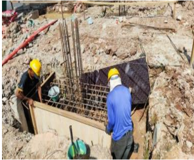
Gambar 3. 26 Pekerjaan Pemasangan bekisting ( Sumber : Dokumentasi lapangan 2024 )
