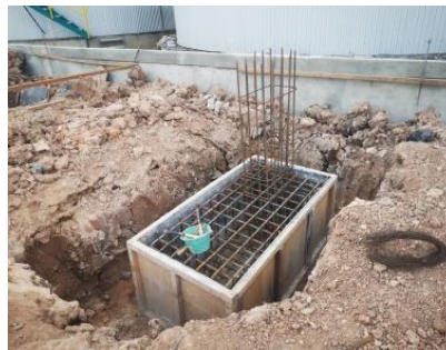
Gambar 3. 27 Setelah bekisting dipasang ( Sumber : Dokumentasi lapangan 2024 )
