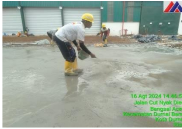
Gambar 3.45 Pekerjaan Tabur Sika ( Sumber : Dokumentasi lapangan 2024 )
