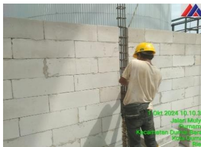
Gambar 3.65 Pekerjaan Kolom Praktis ( Sumber : Dokumentasi lapangan 2024 )
