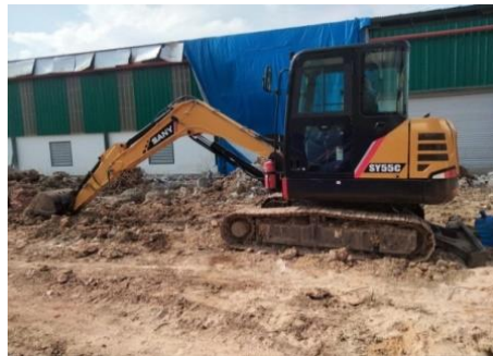
Gambar 3. 17 Pekerjaan galian ( Sumber : Dokumentasi lapangan 2024 )
