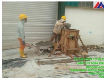
Gambar 3.52 Pekerjaan pengecoran kolom Sumber : Dokumentasi lapangan
