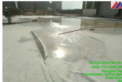
Gambar 3.47 Pekerjaan Curing ( Sumber : Dokumentasi lapangan 2024 )
