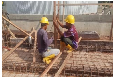
Gambar 3.43 Pemasangan Bekisting Lantai ( Sumber : Dokumentasi lapangan 2024 )
