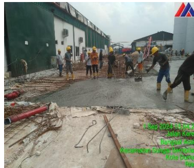
Gambar 3.35 Pengecoran Ground Beam ( Sumber : Dokumentasi lapangan 2024 )
