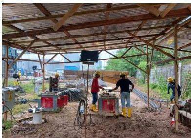
Gambar 3. 23 Pekerjaan Pembengkokan tulangan ( Sumber : Dokumentasi lapangan 2024 )
