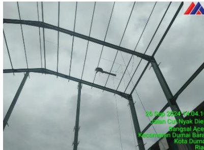
Gambar 3.60 Erection Round Bar ( Sumber : Dokumentasi lapangan 2024 )
