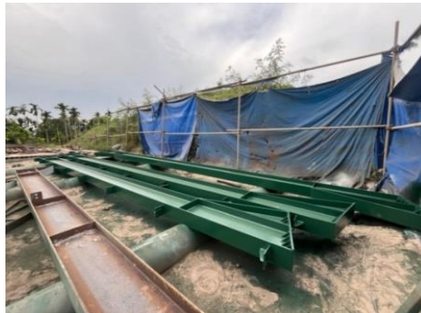
Gambar 3. 16 Proses pengecatan ( Sumber : Dokumentasi lapangan 2024 )
