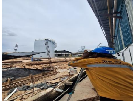
Gambar 3. 19 Pekerjaan Penentuan as pile cap ( Sumber : Dokumentasi lapangan 2024 )
