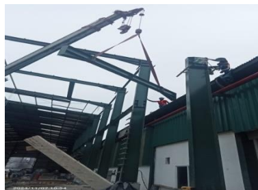
Gambar 3.57 Erection WF-200 Beam ( Sumber : Dokumentasi lapangan 2024 )
