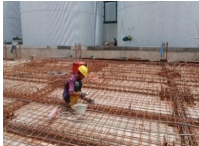
Gambar 3.41 Pemasangan besi relak ( Sumber : Dokumentasi lapangan 2024 )
