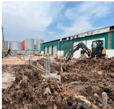
Gambar 3.30 Pekerjaan galian Ground Beam ( Sumber : Dokumentasi lapangan 2024 )
