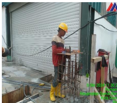
Gambar 3.50 Pekerjaan perakitan dan pemasangan besi angkur ( Sumber : Dokumentasi lapangan 2024 )
