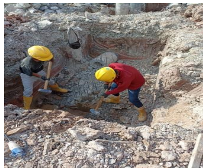
Gambar 3. 18 Pekerjaan pembobokan ( Sumber : Dokumentasi lapangan 2024 )
