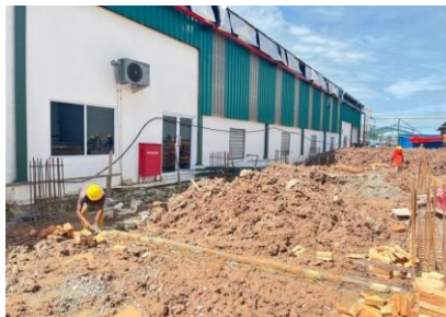
Gambar 3.33 Pekerjaan menyusun batu bata ( Sumber : Dokumentasi lapangan 2024 )
