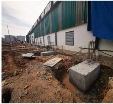
Gambar 3.29 Hasil setelah pengecoran ( Sumber : Dokumentasi lapangan 2024 )
