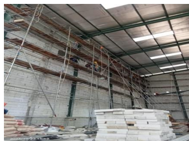
Gambar 3.69 Pekerjaan plesteran dinding ( Sumber : Dokumentasi lapangan 2024 )
