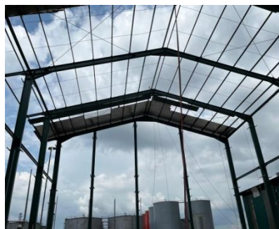
Gambar 3.62 Pekerjaan pemasangan atap ( Sumber : Dokumentasi lapangan 2024 )
