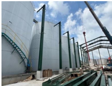
Gambar 3.56 Erection WF 500 Colum ( Sumber : Dokumentasi lapangan 2024 )
