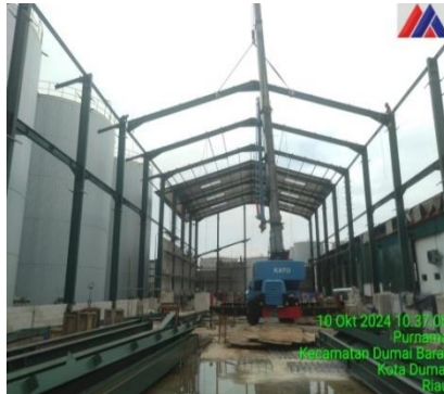
Gambar 3.58 Erection WF 400 Rafter ( Sumber : Dokumentasi lapangan 2024 )
