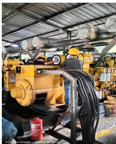
Gambar 3. 10 Penggantian filter udara pada unit 4.
