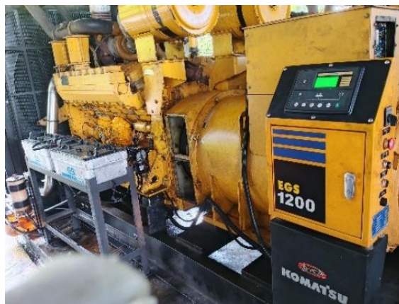
Gambar 3. 24 Perakitan kembali unit ke posisi generator unit 5
