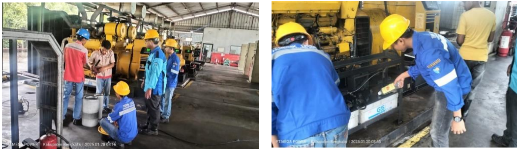
Gambar 3. 5 Pembersihan filter udara dan pengisian air baterai (aki).
