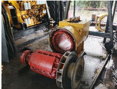
Gambar 3. 20 Pencucian stator dan rotor generator.
