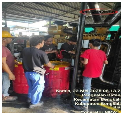
Gambar 3. 62 Penambahan oli pada unit genset
