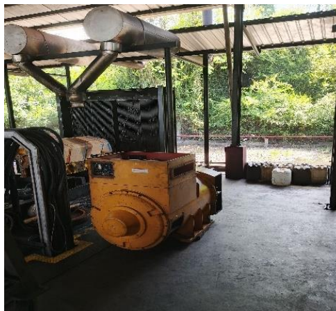
Gambar 3. 23 Penukaran posisi unit 5 dengan unit pengganti
