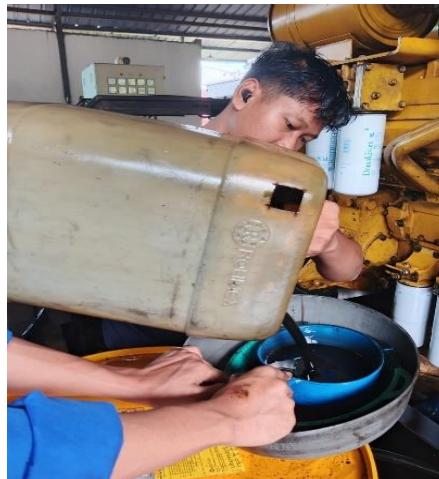
Gambar3. 63 Proses pengurasan dan pengisian oli mesin genset.
