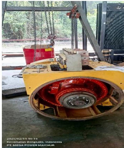
Gambar 3. 14 Pemasangan kembali part pada generator unit 7.
