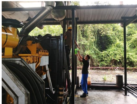
Gambar3. 28 Pengisian air radiator untuk perawatan sistem pendingin
