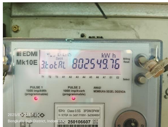
Gambar 3. 30 Pencatatan data kWh PLN dari panel monitoring.
