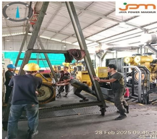
Gambar 3. 17 Pemindahan dan pemasangan ulang generator unit 6 dan 7
