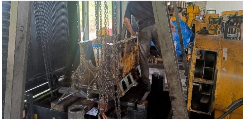
Gambar 3. 67 Proses pembongkaran generator unit 6
