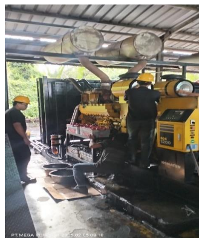
Gambar 3. 10 Penggantian filter udara pada unit 4.
