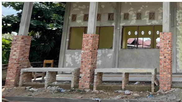
Gambar 3. 60 Pengecoran Tempat Duduk
