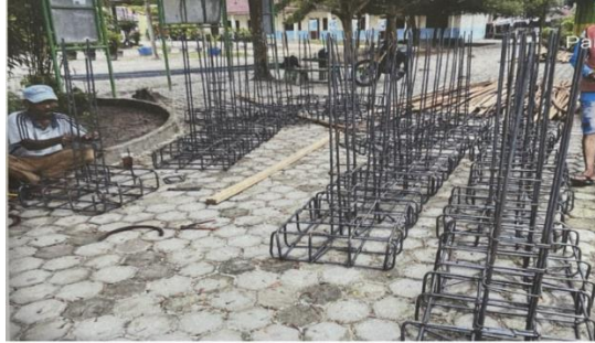
Gambar 3. 4 Perakitan Tulangan Pondasi
