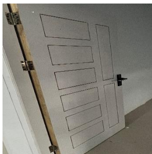
Gambar 3. 35 Pemasangan Engsel Pintu
