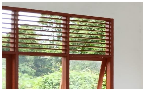
Gambar 3. 51 Pengecatan Papan Jalusi
