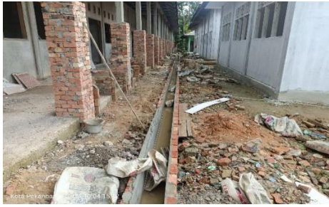
Gambar 3. 78 Pekerjaan plasteran saluran air
