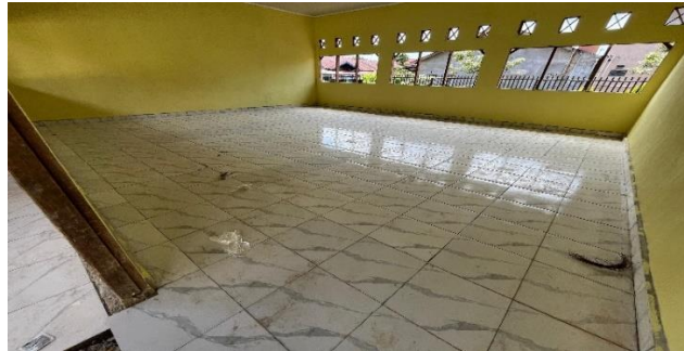
Gambar 3. 54 Pemasangan Plint Keramik
