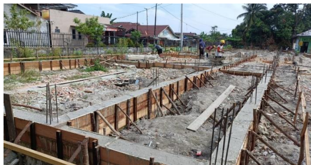
Gambar 3. 9 Penegecoran Pondasi Menerus
