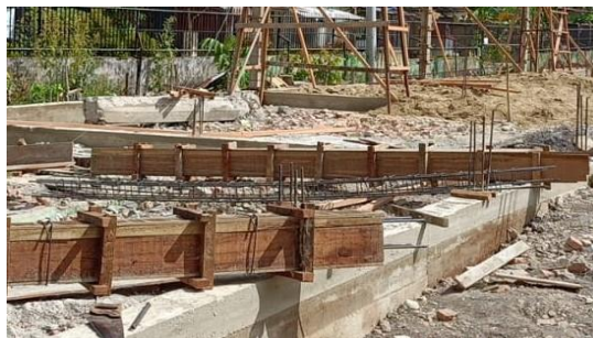
Gambar 3. 17 Penulangan Kolom
