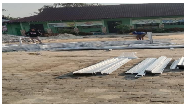
Gambar 3. 62 Pembuatan Rangka Atap
