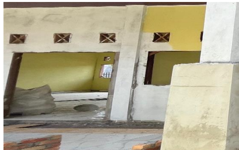
Gambar 3. 32 Pemasangan Kusen Pintu
