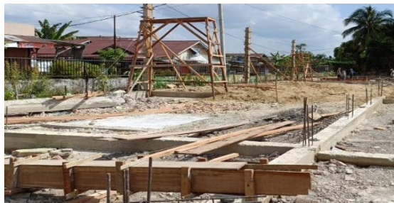
Gambar 3. 16 Pemasangan Bekisting Kolom
