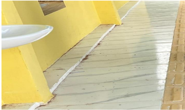
Gambar 3. 57 Pemasangan plint keramik
