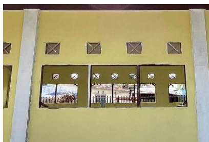
Gambar 3. 47 Pemasangan Ventilasi Jendela
