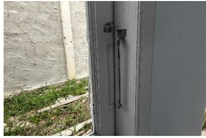
Gambar 3. 43 Pemasangan Hak angin Jendela
