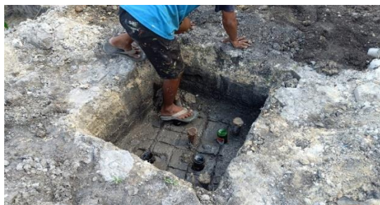
Gambar 3. 3 Pemasangan Kayu Cerocok
