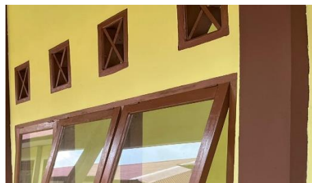
Gambar 3. 41 Pemasangan Engsel Jendela
