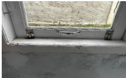
Gambar 3. 42 Pemasangan Grendel Jendela
