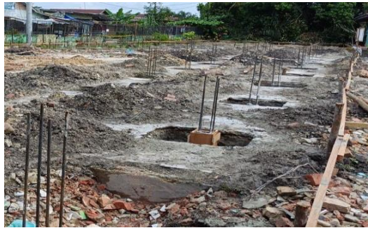
Gambar 3. 10 Pemasangan Bekisting Kolom Pedestel
