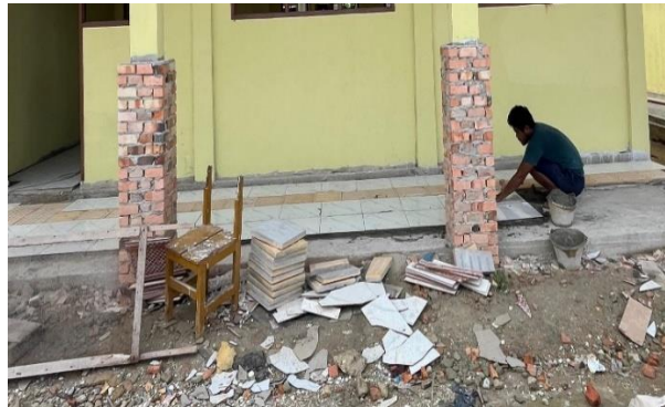
Gambar 3. 55 Pemasangan Keramik Selasar
