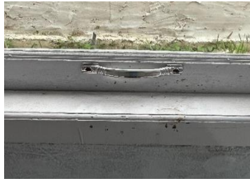
Gambar 3. 44 Pemasangan Handle Jendela
