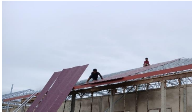
Gambar 3. 63 Pemasangan Atap Long Spandek
