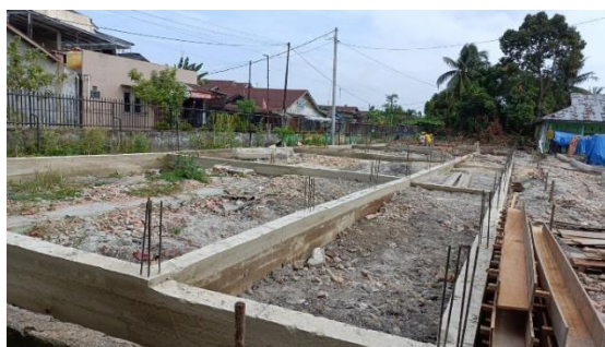
Gambar 3. 15 Pembongkaran bekisting
