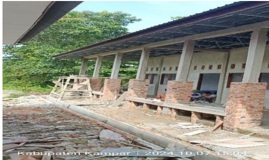
Gambar 3. 59 Pembuatan Bekisting Tempat Duduk
