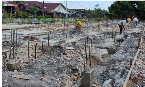
Gambar 3. 11 Pembongkaran Beskiting
