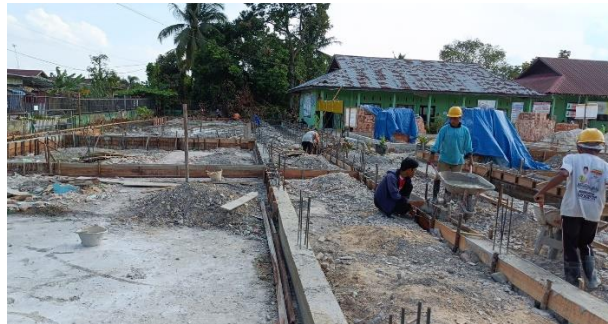
Gambar 3. 14 Pengecoran Sloof
