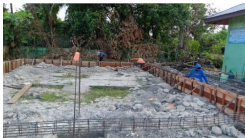
Gambar 3. 13 Pemasangan Bekisting Sloof
