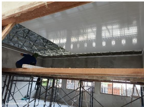
Gambar 3. 67 Pemasangan Plavon PVC
