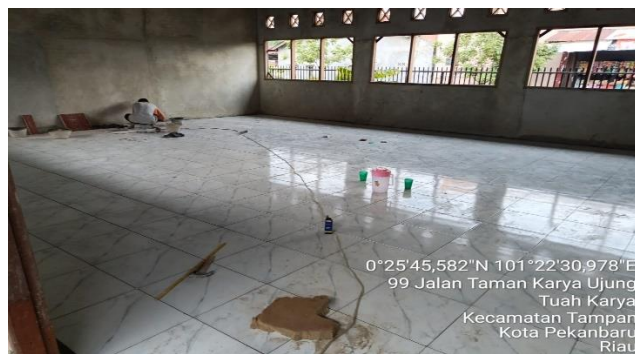
Gambar 3. 53 Pemasangan Keramik
