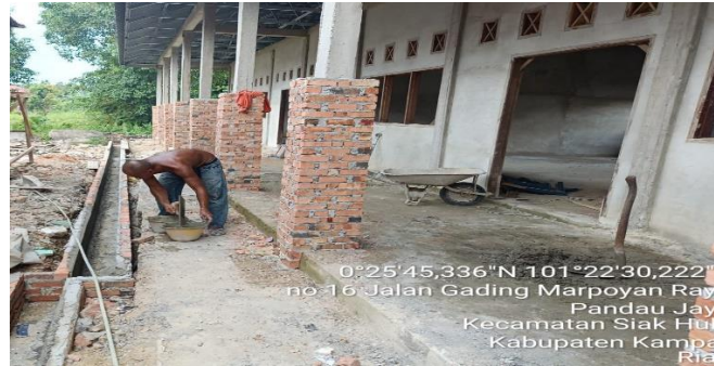
Gambar 3. 28 Plasteran Kolom Teras
