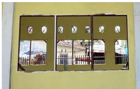
Gambar 3. 39 Pemasangan Kusen Kayu
