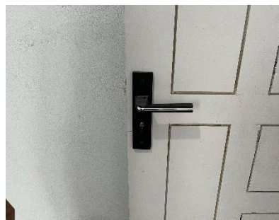
Gambar 3. 36 Pemasangan Grendel Pintu
