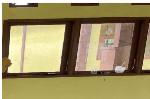
Gambar 3. 40 Pemasangan Bingkai Kaca
