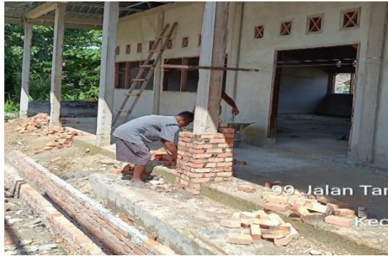
Gambar 3. 27 Pemasangan Bata Kolom
