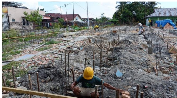
Gambar 3. 8 Pemasangan Batu Bata
