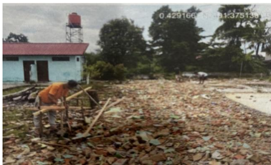
Gambar 3. 1 Pemasangan Bowplank
