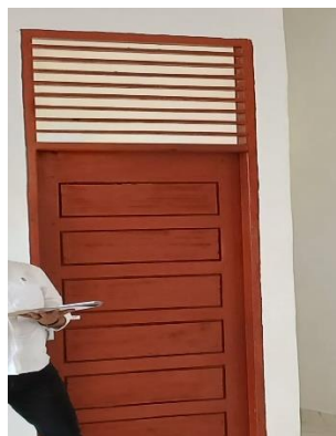
Gambar 3. 37 Pengecatan kusen pintu
