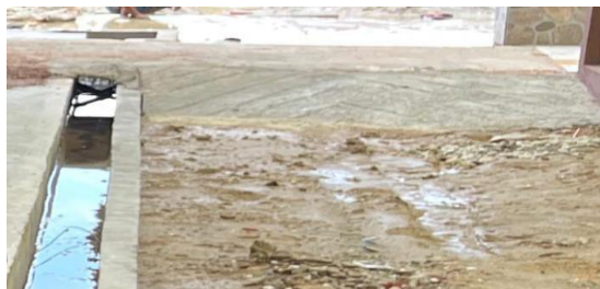
Gambar 3. 79 Pekerjaan acian rabat
