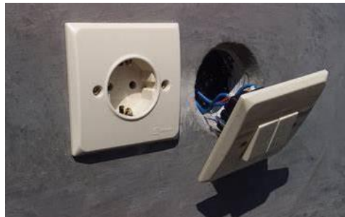
Gambar 3. 70 Pemasangan Stop Kontak
