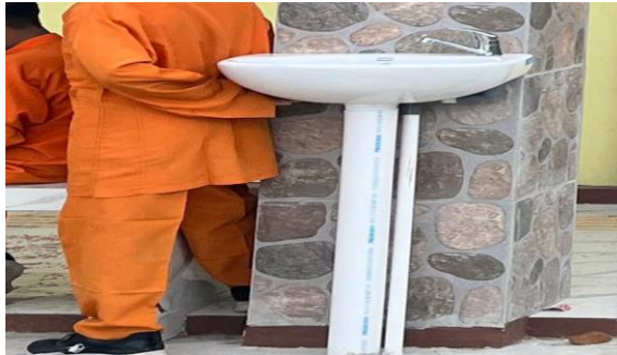
Gambar 3. 84 Pemasangan pipa PVC 3/4
