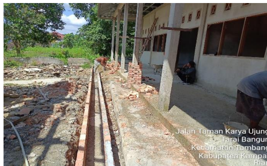
Gambar 3. 77 Pekerjaan Pasangan Bata
