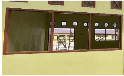
Gambar 3. 45 Pengecatan Kusen Jendela
