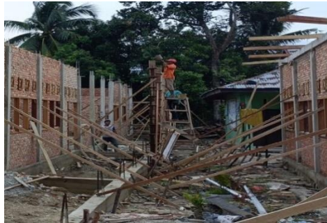
Gambar 3. 21 Pengecoran Kolom Praktis
