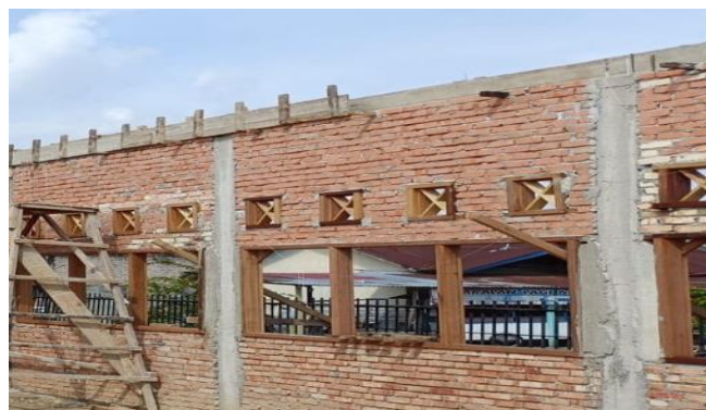
Gambar 3. 22 Pemasangan Bekisting Balok
