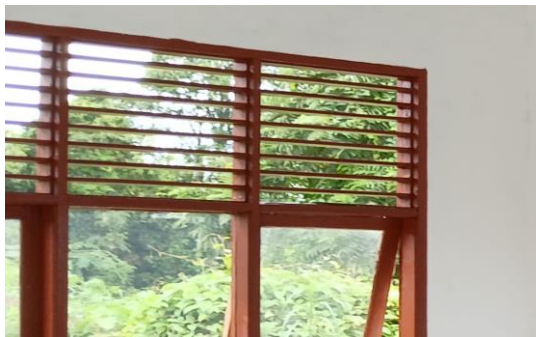
Gambar 3. 50 Pengecatan kusen
