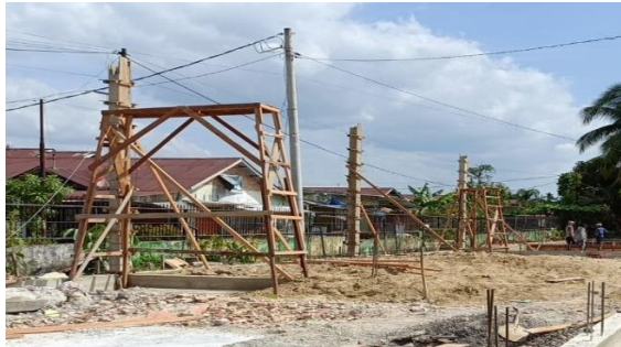
Gambar 3. 18 Pengecoran Kolom
