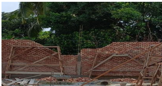
Gambar 3. 25 Pemasangan Batu Bata
