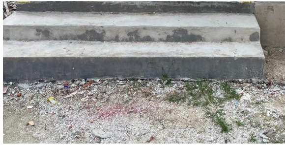
Gambar 3. 80 Pekerjaan tangga teras
