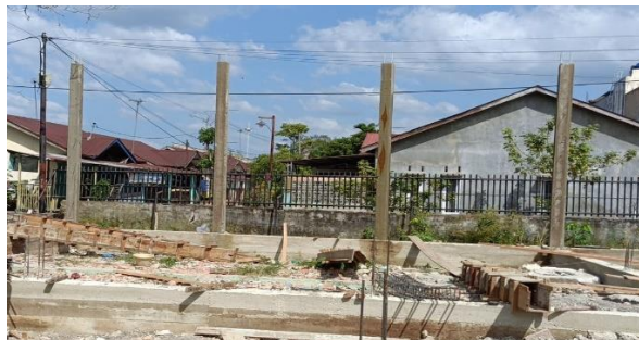
Gambar 3. 19 Pembongkaran Bekisting Kolom
