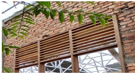
Gambar 3. 49 Pemasangan Papan Jalusi
