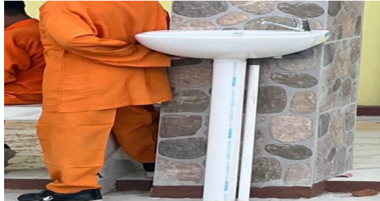
Gambar 3. 85 Pemasangan pipa PVC 2”
