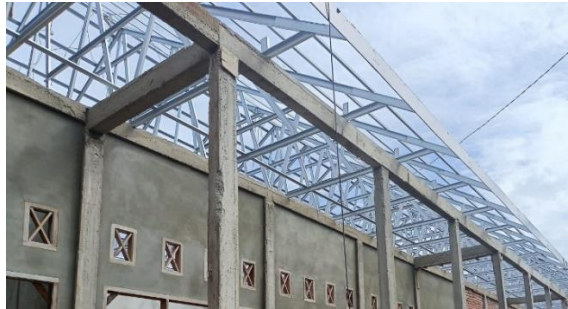
Gambar 3. 64 Pemasangan List Plank GRC
