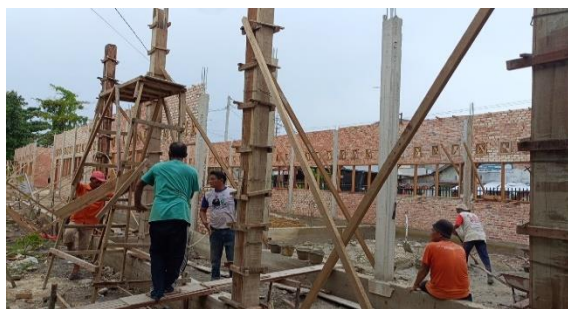
Gambar 3. 20 Pemasangan Bekisting Kolom Praktis
