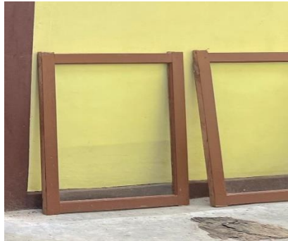
Gambar 3. 46 Pengecatan Bingkai Jendela
