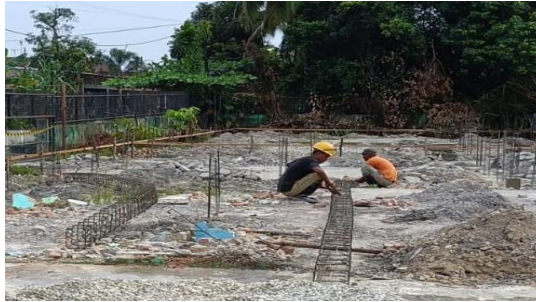
Gambar 3. 12 Pembesian Kolom Sloof
