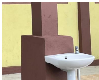
Gambar 3. 83 Pemasangan Tempat Cuci Tangan
