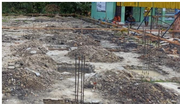
Gambar 3. 6 Pengecoran Pondasi Setempat
