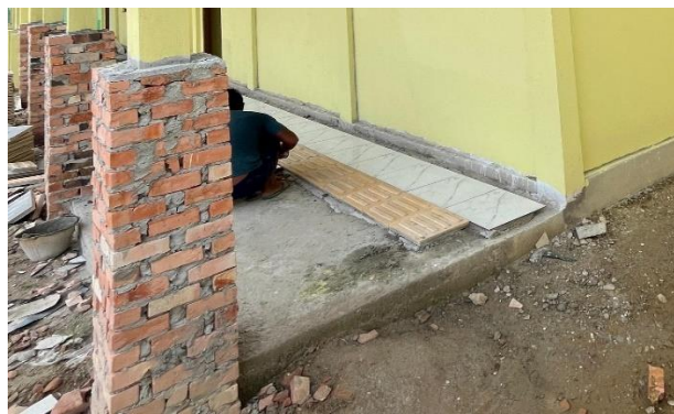
Gambar 3. 56 Pemasangan Block Dan Warning Block
