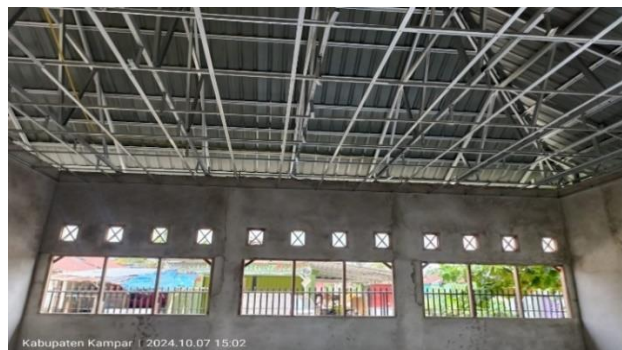
Gambar 3. 66 Pemasangan Rangka Hollow
