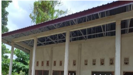
Gambar 3. 65 Pengecatan List Plank GRC
