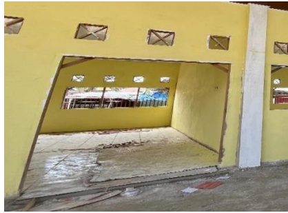
Gambar 3. 48 Pemasangan Ventilasi Pintu
