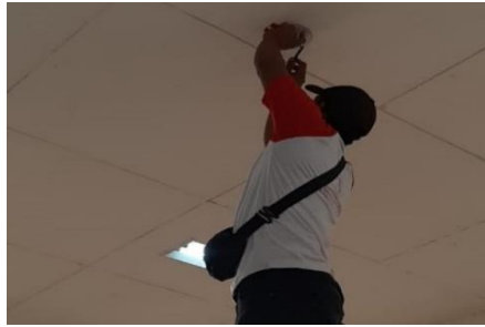
Gambar 3. 74 Pemasangan Lampu Down Light
