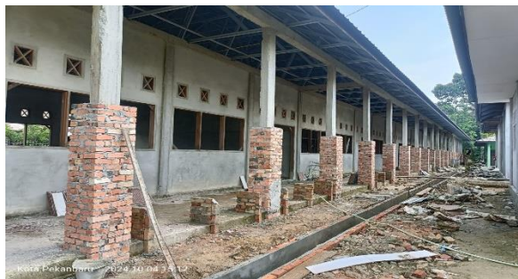
Gambar 3. 58 Pemasangan Bata
