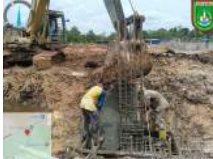
Gambar 3. 124 Penuangan beton segar menggunakan plywood Sumber: Dokumentasi kerja praktek lapangan
