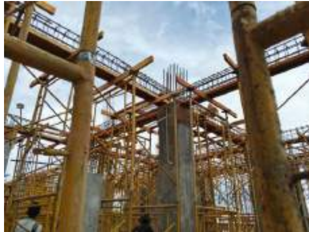
Gambar 3. 15 Scaffolding Sumber: dokumentasi Kerja Praktek
