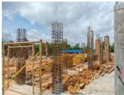
Gambar 3. 178 Pembesian kolom K3 Sumber: dokumentasi Kerja Praktek
