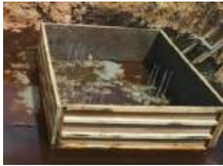
Gambar 3. 111 Bekisting pondasi PC1A Sumber : Dokumentasi lapangan
