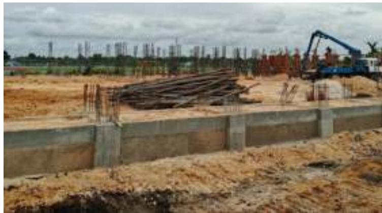
Gambar 3. 95 Hasil dari pekerjaan reben pondasi bata Sumber: dokumentasi Kerja Praktek
