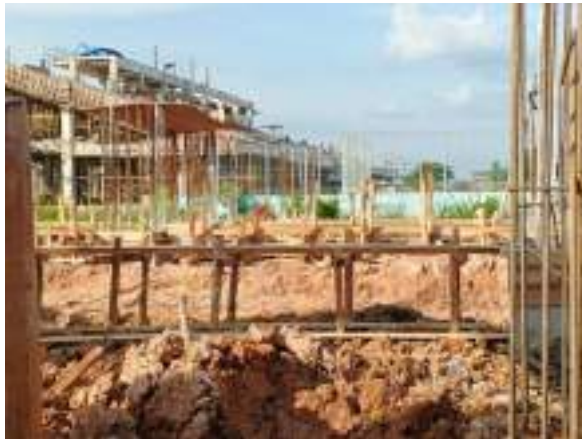
Gambar 3. 171 Pemasangan bekisting sloff Sumber: dokumentasi Kerja Praktek
