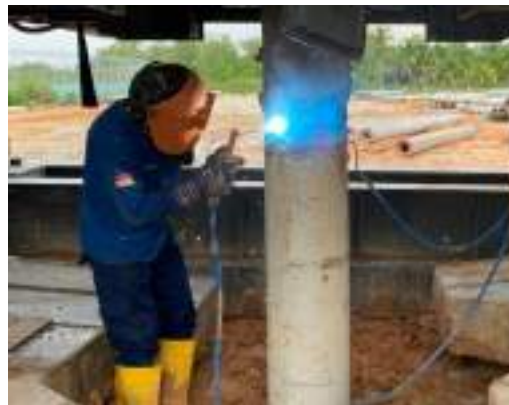
Gambar 3. 59 Upper tiang pancang prestressed yang disambung menggunakan welding system Sumber: Dokumentasi lapangan
