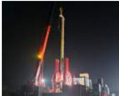
Gambar 3. 63 Tiang pancang upper pile di angkat menggunakan crane yang ada pada HSPD Sumber: Dokumentasi lapangan
