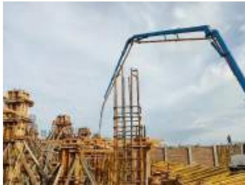
Gambar 3. 197 Pengecoran menggunakan concrete pump Sumber: dokumentasi Kerja Praktek
