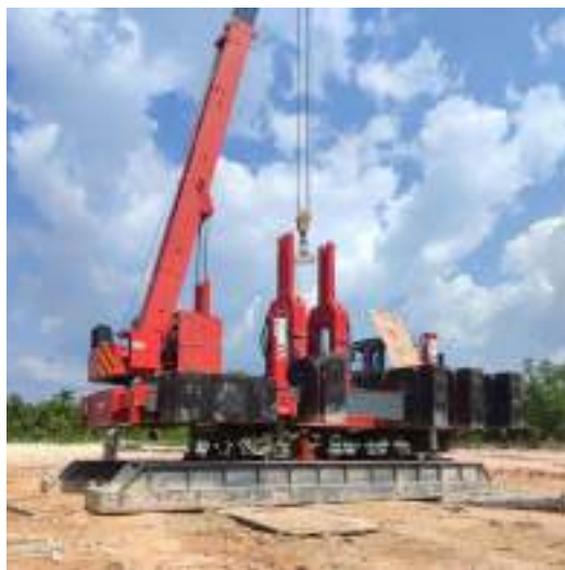
Gambar 3. 10 Hydraulic Static Pile Driver Sumber: dokumentasi Kerja Praktek
