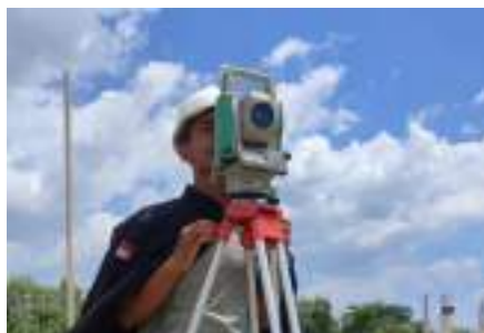
Gambar 3. 130 Penentuan level titik pondasi menggunakan total station Sumber: dokumentasi Kerja Praktek
