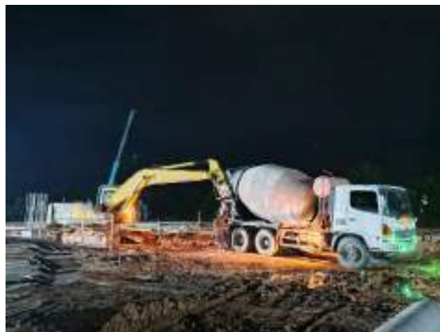
Gambar 3. 100 Beton dari Concrete mixer Sumber: dokumentasi Kerja Praktek lapangan
