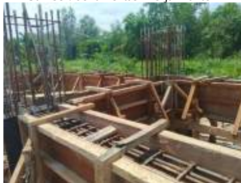
Gambar 3. 172 Pemasangan bekisting pada pekerja sloof Sumber: dokumentasi Kerja Praktek
