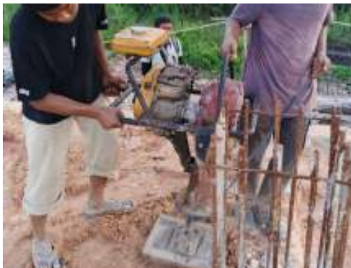
Gambar 3. 46 Stamper memadatkan area yang susah di jangkau alat berat Sumber: dokumentasi Kerja Praktek
