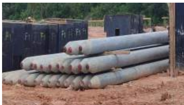
Gambar 3. 24 Spun pile Sumber: dokumentasi Kerja Praktek
