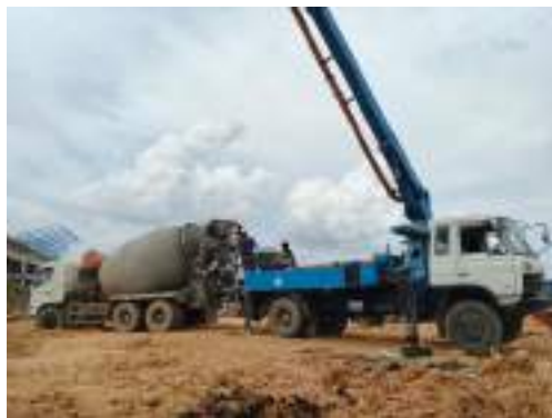
Gambar 3. 198 Mixer truck sebagai alat mobilisasi beton segar Sumber: dokumentasi Kerja Praktek
