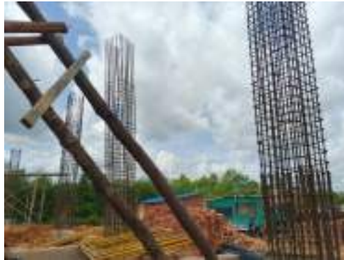
Gambar 3. 180 Pembesian kolom K1 Sumber: dokumentasi Kerja Praktek
