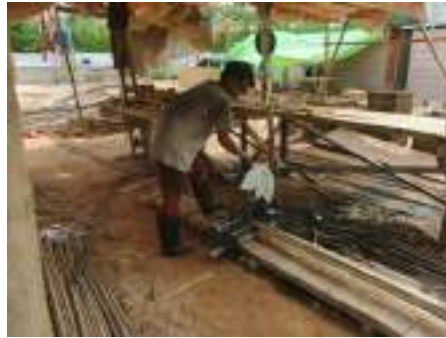
Gambar 3. 73 Proses pemotongan tulangan baja Sumber: dokumentasi Kerja Praktek
