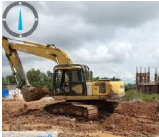
Gambar 3. 44 Excavator membantu penghamparan tanah ke area becek Sumber: dokumentasi Kerja Praktek
