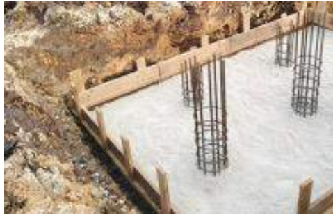
Gambar 3. 103 Pembatas bekisting lantai kerja Sumber: dokumentasi Kerja Praktek lapangan
