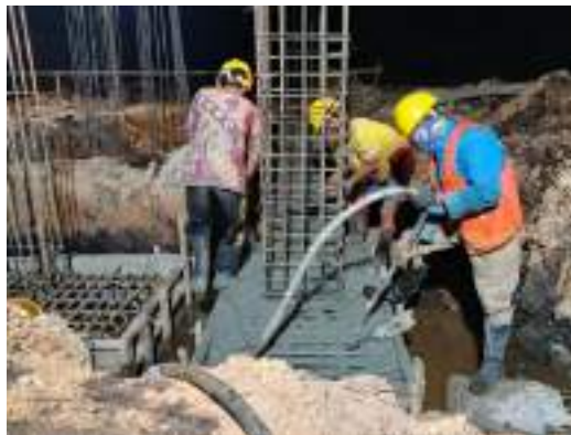
Gambar 3. 17 Beton ready mix Sumber: dokumentasi Kerja Praktek
