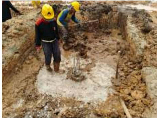
Gambar 3. 98 Perataan pasir urug Sumber: dokumentasi Kerja Praktek
