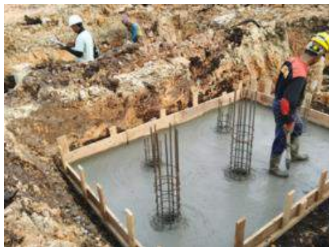
Gambar 3. 105 Kondisi lantai kerja setelah di cor Sumber: dokumentasi Kerja Praktek lapangan
