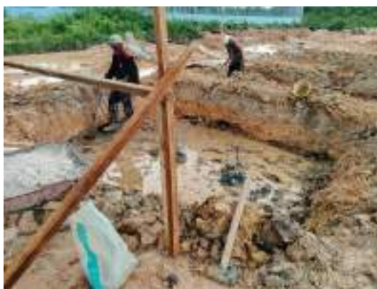
Gambar 3. 58 Kondisi spun pile yang sudah tertanam PC1 Sumber: Dokumentasi lapangan
