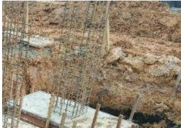
Gambar 3. 143 Pembesian kolom pedestal KP2 Sumber: dokumentasi Kerja Praktek
