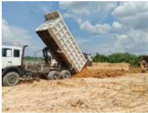
Gambar 3. 156 Urugan kembali tanah Sumber: dokumentasi Kerja Praktek
