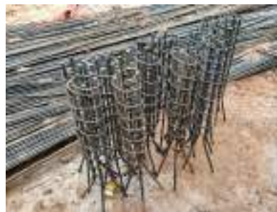
Gambar 3. 74 PHT Setelah di rakit Sumber: dokumentasi Kerja Praktek
