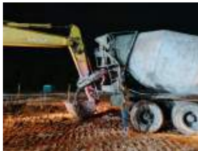
Gambar 3. 122 Penampungan beton segar menggunakan bucket excavator Sumber: dokumentasi Kerja Praktek
