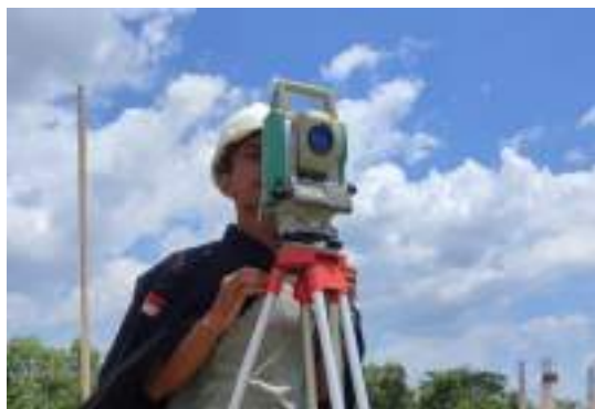
Gambar 3. 4 Total Station Sumber: dokumentasi Kerja Praktek
