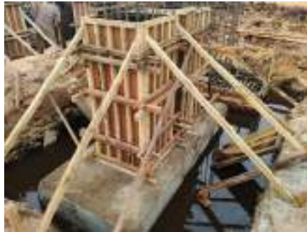
Gambar 3. 133 Bekisting kolom pedestal konvensional Sumber: dokumentasi Kerja Praktek
