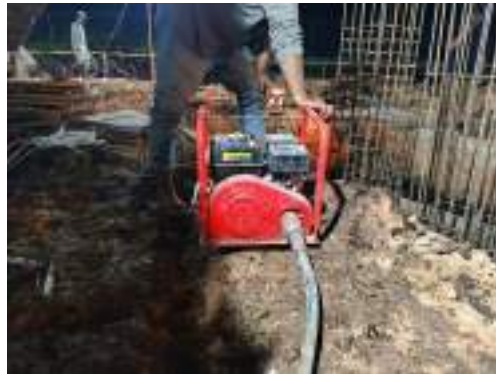
Gambar 3. 176 Vibrator machine sebagai pemadat Sumber: dokumentasi Kerja Praktek
