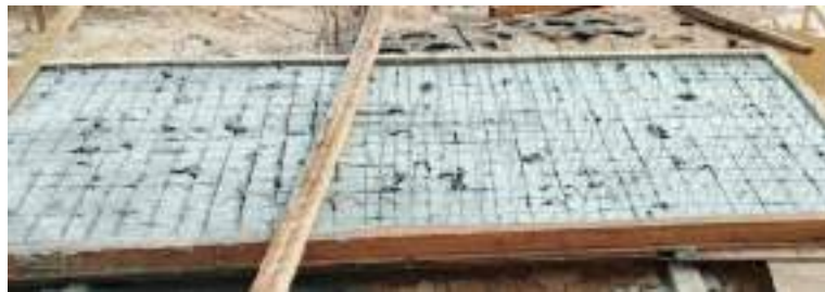
Gambar 3. 19 Concrete decking Sumber: dokumentasi Kerja Praktek
