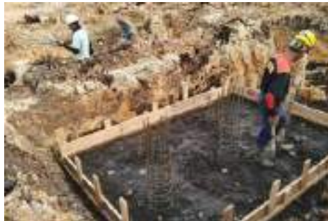
Gambar 3. 101 Kondisi persiapan area Sumber: dokumentasi Kerja Praktek lapangan
