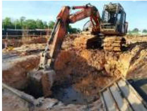
Gambar 3. 79 Proses penggalian pondasi menggunakan Excavator Sumber: dokumentasi Kerja Praktek
