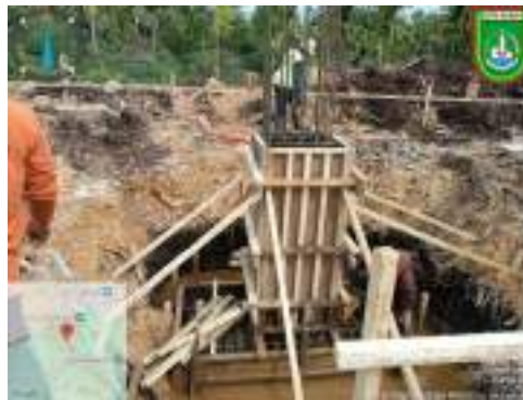
Gambar 3. 147 Bekisting konvensional KP3 Sumber: dokumentasi Kerja Praktek
