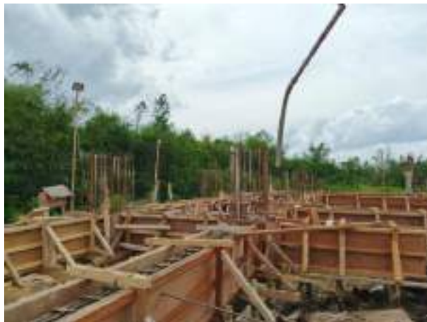
Gambar 3. 167 Bekisting sloof Sumber: dokumentasi Kerja Praktek
