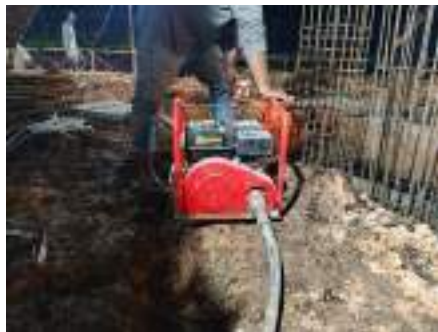
Gambar 3. 134 Vibrator machine sebagai pemadat coran Sumber: dokumentasi Kerja Praktek
