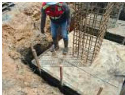
Gambar 3. 128 Hasil perkerasan pondasi tapak dan pengecekan oleh konsultan pengawas Sumber: dokumentasi Kerja Praktek
