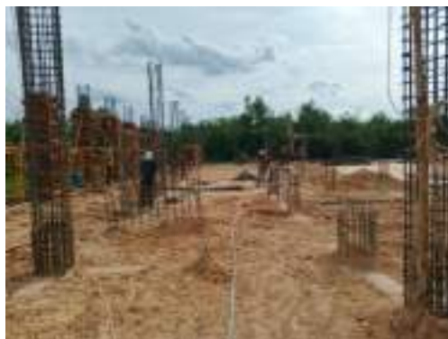
Gambar 3. 193 Perakitan tulangan kolom Sumber: dokumentasi Kerja Praktek
