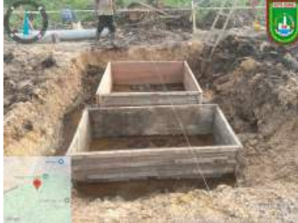
Gambar 3. 119 Kesiapan bekisting PC2, PC1A Sumber: Dokumentasi lapangan
