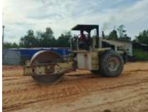
Gambar 3. 163 Vibrator roller sebagai pemadat tanah Sumber: dokumentasi Kerja Praktek
