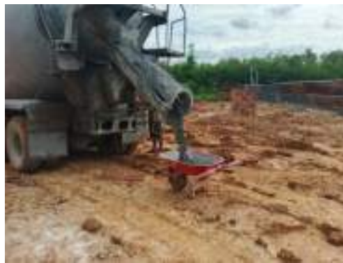
Gambar 3. 149 Pengiriman beton dan penampungan beton untuk uji Sumber: dokumentasi Kerja Praktek
