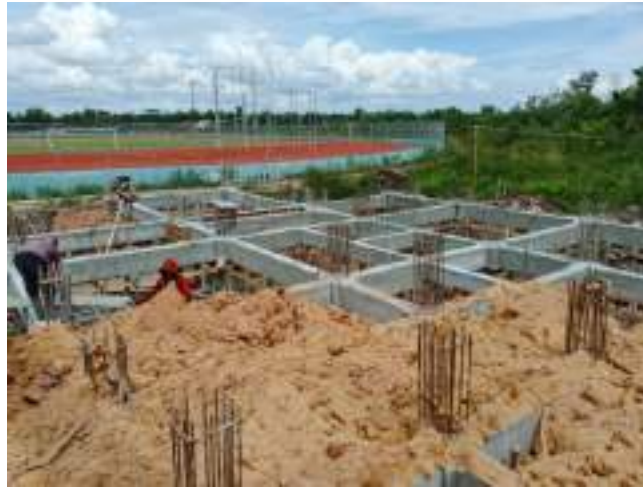
Gambar 3. 164 Sloof Sumber: dokumentasi Kerja Praktek
