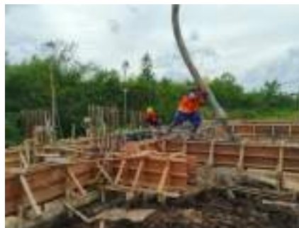
Gambar 3. 175 Pengecoran menggunakan Concrete pump Sumber: dokumentasi Kerja Praktek
