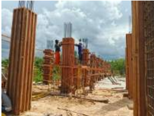
Gambar 3. 194 Pemasangan bekisiting kolom Elv 0.00 - +4.00 Sumber: dokumentasi Kerja Praktek
