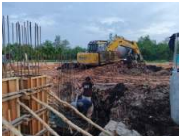
Gambar 3. 157 Proses pengurugan Kembali pada galian pondasi menggunakan excavator Sumber: dokumentasi Kerja Praktek
