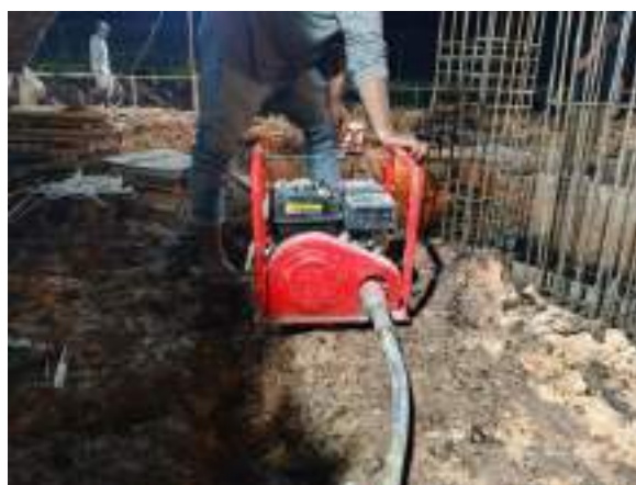
Gambar 3. 3 Concrate Vibrator Sumber: dokumentasi Kerja Praktek
