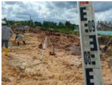
Gambar 3. 84 Proses leveling menggunakan waterpass Sumber: dokumentasi Kerja Praktek
