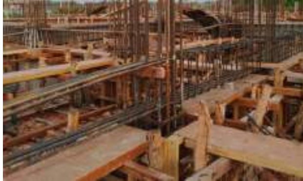
Gambar 3. 166 Pembesian sloof Sumber: dokumentasi Kerja Praktek
