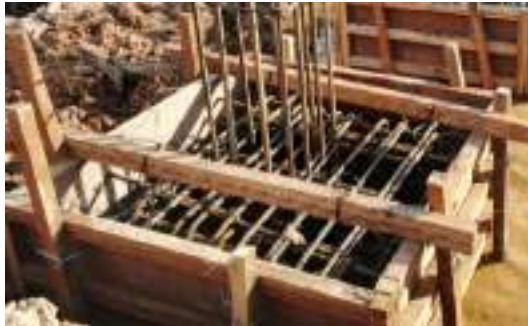
Gambar 3. 115 Pembesian pada pondasi tapak PC3 Sumber : Dokumentasi lapangan
