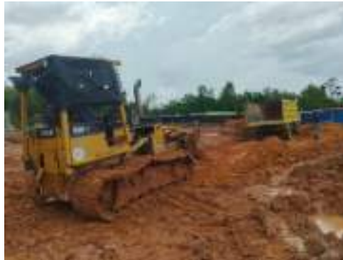
Gambar 3. 158 Penyebaran tanah menggunakan dozer Sumber: dokumentasi Kerja Praktek
