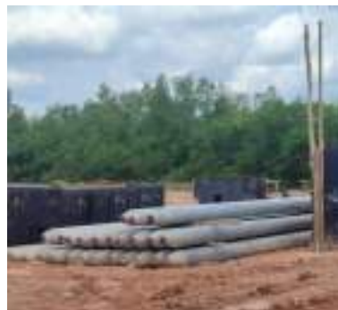
Gambar 3. 67 Spun pile D30 12M Sumber: dokumentasi Kerja Praktek
