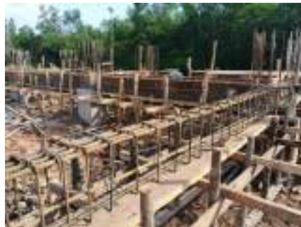
Gambar 3. 170 Pembesian sloof 25/40 Sumber: dokumentasi Kerja Praktek
