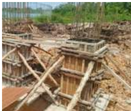
Gambar 3. 144 Bekisting konvensional KP2 Sumber: dokumentasi Kerja Praktek
