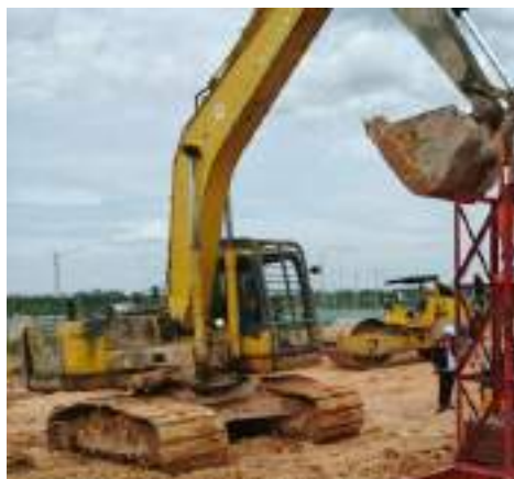
Gambar 3. 6 Excavator Sumber: dokumentasi Kerja Praktek
