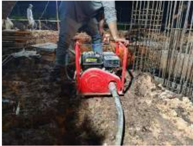
Gambar 3. 199 Pemadatan menggunakan vibrator machine Sumber: dokumentasi Kerja Praktek
