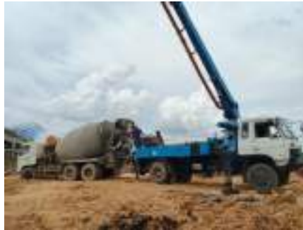
Gambar 3. 173 Beton diantar dengan mixer truck Sumber: dokumentasi Kerja Praktek
