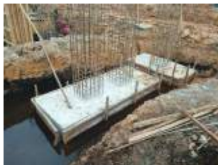
Gambar 3. 129 Hasil perkerasan beton pondasi tapak type PC1 dan PC2 Sumber: dokumentasi Kerja Praktek
