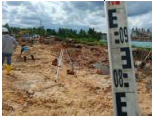
Gambar 3. 195 Pengukuran level menggunakan waterpass dan rambu ukur Sumber: dokumentasi Kerja Praktek
