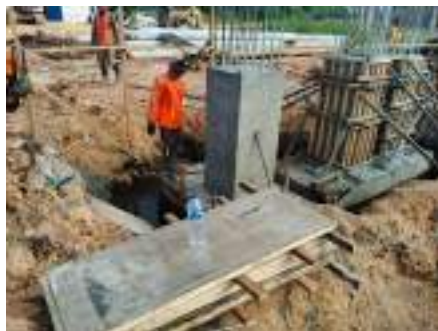
Gambar 3. 138 Hasil perkerasan beton kolom pedestal dan pelepasan bekisting Sumber: dokumentasi Kerja Praktek
