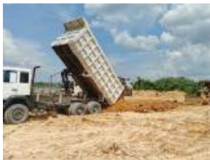
Gambar 3. 155 Proses penurunan tanah urugan menggunakan dump truck Sumber: dokumentasi Kerja Praktek
