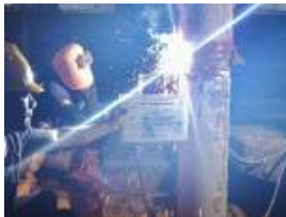
Gambar 3. 62 Proses penyambungan Uppuer pile dengan sistem las Sumber: Dokumentasi lapangan
