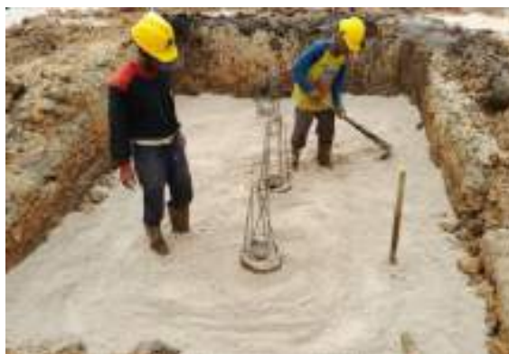
Gambar 3. 118 Proses persiapan galian perataan urugan pasir Sumber: Dokumentasi lapangan
