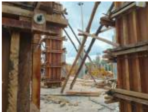
Gambar 3. 181 Bekisting kolom K1 Sumber: dokumentasi Kerja Praktek
