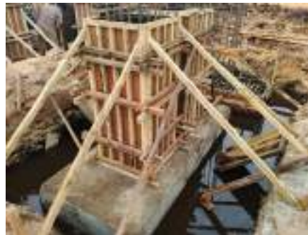
Gambar 3. 141 Bekisting konvensional Kolom KP1 Sumber: dokumentasi Kerja Praktek
