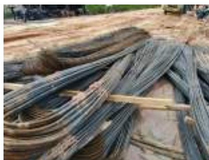
Gambar 3. 16 Baja tulangan Sumber: dokumentasi Kerja Praktek
