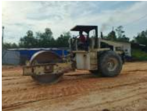
Gambar 3. 45 Proses penghamparan tanah menggunakan Dozer Sumber: dokumentasi Kerja Praktek
