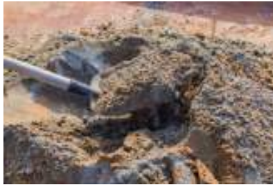
Gambar 3. 92 Adukan mortar reben pondasi Sumber: dokumentasi Kerja Praktek
