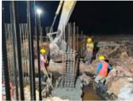
Gambar 3. 126 Proses pengecoran pondasi tapak Sumber: dokumentasi Kerja Praktek
