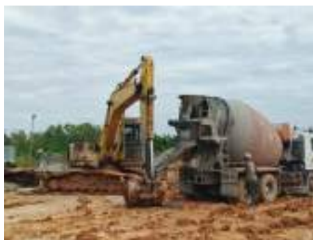
Gambar 3. 152 Proses penampungan untuk pelangsiran beton menggunakan excavator Sumber: dokumentasi Kerja Praktek
