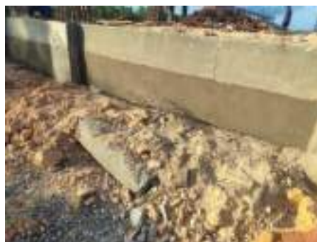
Gambar 3. 94 Hasil reben pondasi Sumber: dokumentasi Kerja Praktek
