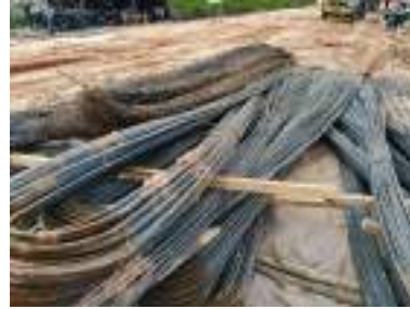
Gambar 3. 185 Besi tulangan Sumber: Dokumentasi lapangan
