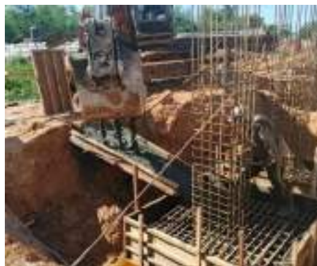
Gambar 3. 125 Proses pengecoran pondasi tapak Sumber: dokumentasi Kerja Praktek
