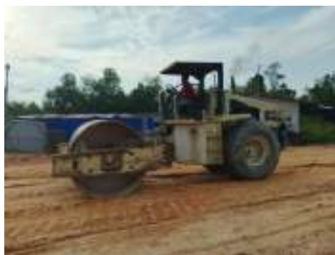
Gambar 3. 159 Vibrator roller sebagai pemadat Sumber: dokumentasi Kerja Praktek
