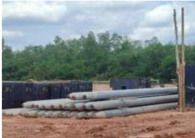
Gambar 3. 61 Spun pile D30 12M Sumber: dokumentasi Kerja Praktek
