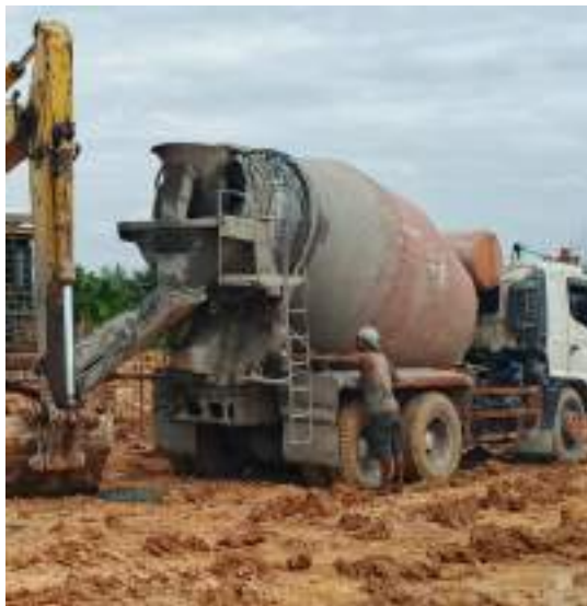
Gambar 3. 1 Truck Mixer Sumber: dokumentasi Kerja Praktek
