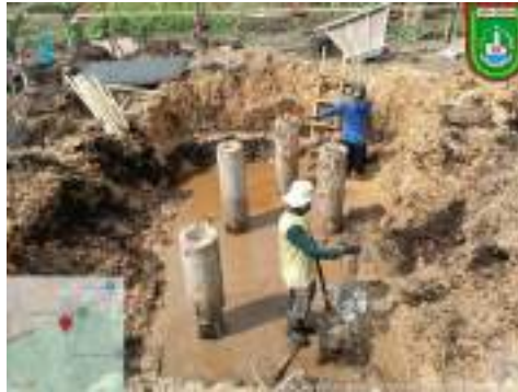
Gambar 3. 83 Proses perapian galian secara manual Sumber: dokumentasi Kerja Praktek
