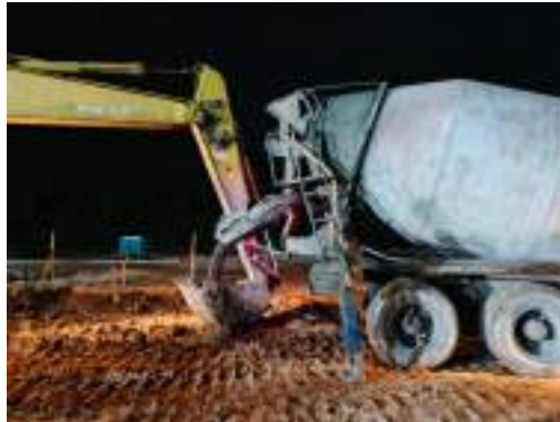
Gambar 3. 121 Pengiriman menggunakan truck mixer Sumber: dokumentasi Kerja Praktek
