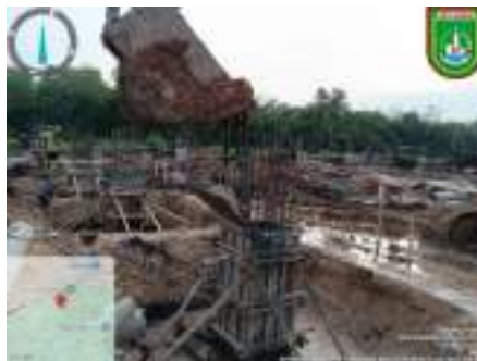
Gambar 3. 137 Proses pengecoran kolom pedestal menggunakan excavator Sumber: dokumentasi Kerja Praktek
