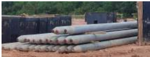
Gambar 3. 57 Bottom spun pile 12m Sumber: Dokumentasi lapangan
