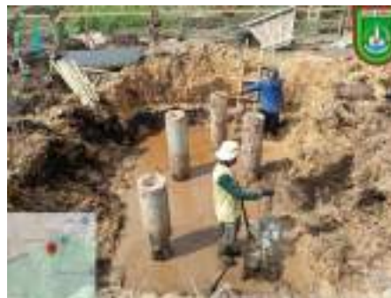
Gambar 3. 80 Proses perapian galian pondasi secara manual Sumber: dokumentasi Kerja Praktek
