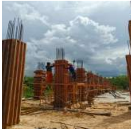
Gambar 3. 179 Bekisting konvensional K3 Sumber: dokumentasi Kerja Praktek
