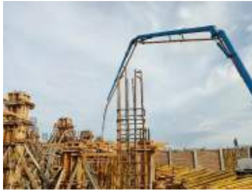
Gambar 3. 192 Pengecoran menggunakan concrete pump Sumber: dokumentasi Kerja Praktek
