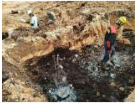
Gambar 3. 96 Proses persiapan pembersihan area dalam pondasi Sumber: dokumentasi Kerja Praktek
