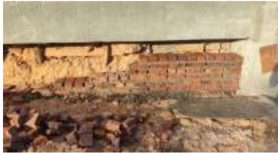
Gambar 3. 85 Pekerjaan pemasangan pondasi bata Sumber: dokumentasi Kerja Praktek
