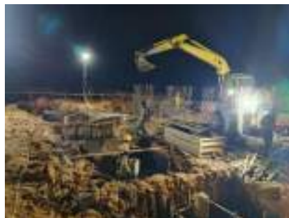
Gambar 3. 123 Pelangsiran menggunakan excavator Sumber: dokumentasi Kerja Praktek
