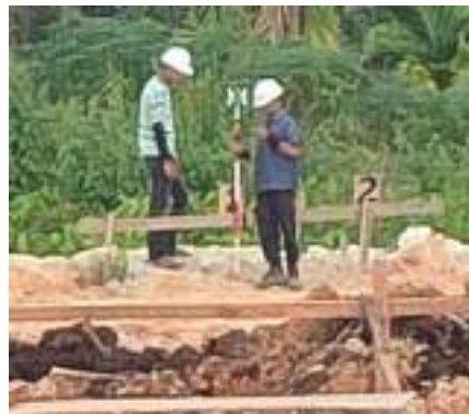
Gambar 3. 47 Proses pemasangan penitikan patok kayu Sumber: dokumentasi Kerja Praktek
