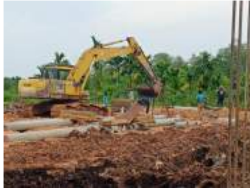
Gambar 3. 168 Proses pemindahan material dan pembersihan sisa material Sumber: dokumentasi Kerja Praktek
