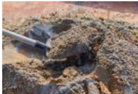
Gambar 3. 89 Adukan mortar Sumber: dokumentasi Kerja Praktek
