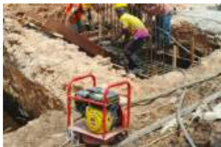
Gambar 3. 127 Proses pemadatan dengan metode getar menggunakan Vibrator Machine Sumber: dokumentasi Kerja Praktek
