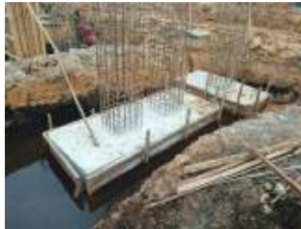
Gambar 3. 148 Hasil perkerasan beton pondasi tapak type PC1 dan PC2 Sumber: dokumentasi Kerja Praktek
