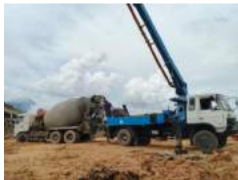
Gambar 3. 13 Concrate Pump Sumber: dokumentasi Kerja Praktek
