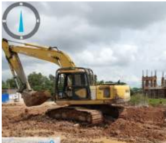
Gambar 3. 40 Excavator Sumber: Dokumentasi lapangan
