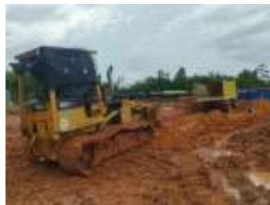
Gambar 3. 161 Dozer sebagai pengopir tanah Sumber: dokumentasi Kerja Praktek
