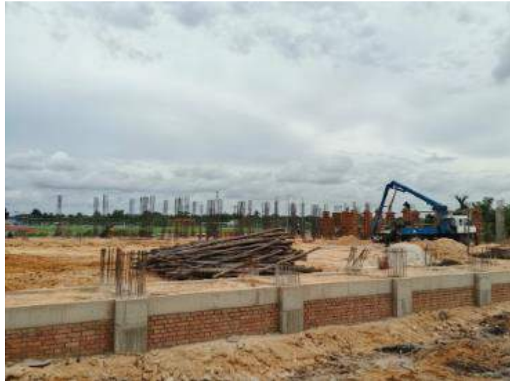
Gambar 3. 91 Hasil pemasangan pondasi bata Sumber: dokumentasi Kerja Praktek
