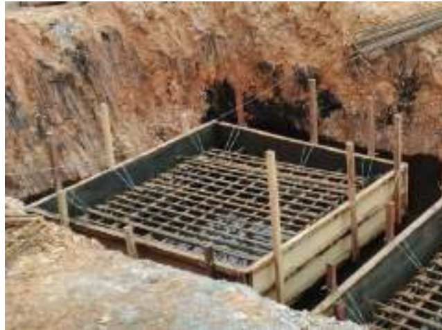
Gambar 3. 109 Tulangan pondasi PC1A Sumber : Dokumentasi lapangan
