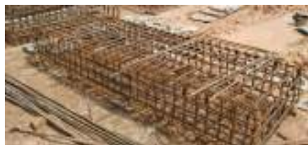
Gambar 3. 106 Tulangan pondasi tapak PC1 Sumber : Gambar struktur
