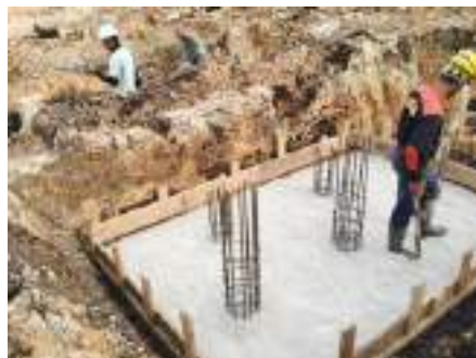
Gambar 3. 102 Kondisi setelah di beri pasir urug Sumber: dokumentasi Kerja Praktek lapangan
