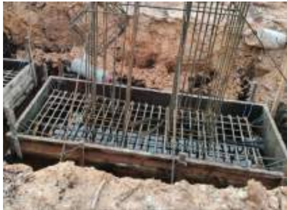
Gambar 3. 108 Bekisting dan pembesian pondasi tapak PC1 Sumber : Gambar struktur
