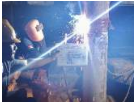
Gambar 3. 65 Metode pengelasan keliling penuh pada joint plate spun pile Sumber: Dokumentasi lapangan
