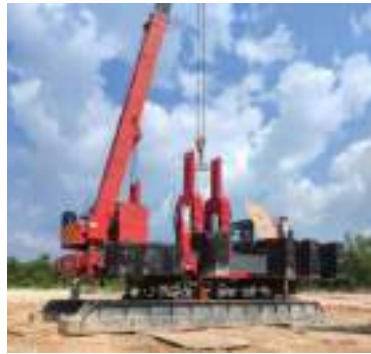
Gambar 3. 66 Hydraulic Static Pile Driver Sumber: dokumentasi Kerja Praktek
