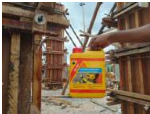
Gambar 3. 196 Sika sebagai tambahan zat adiktif perekat beton lama dan beton baru Sumber: dokumentasi Kerja Praktek
