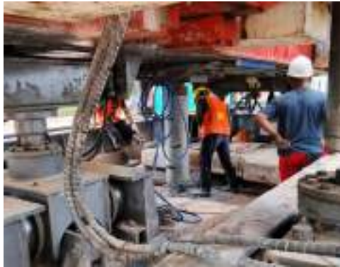
Gambar 3. 71 Proses Pembobokan Menggunakan Palu Godam Sumber: dokumentasi Kerja Praktek
