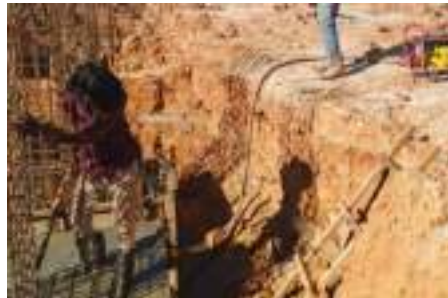
Gambar 3. 77 Proses getar dengan Vibrator Machine Sumber: dokumentasi Kerja Praktek
