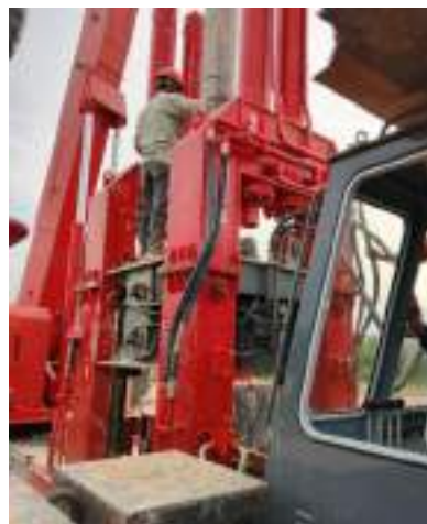
Gambar 3. 64 Proses penjepitan clamp pada HSPD Sumber: Dokumentasi lapangan
