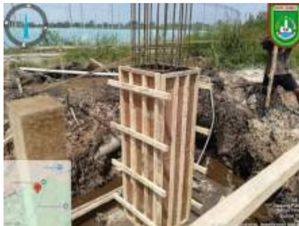
Gambar 2. 9 Bekisting Konvensional Sumber: dokumentasi Kerja Praktek
