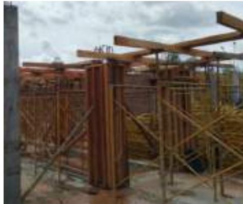
Gambar 3. 183 Bekisting konvensional kolom K2 Sumber: dokumentasi Kerja Praktek
