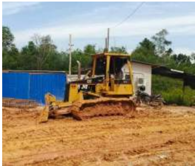
Gambar 3. 7 Dozer Sumber: dokumentasi Kerja Praktek
