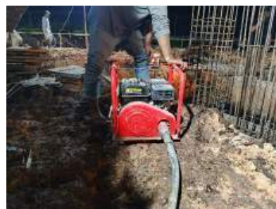
Gambar 3. 191 Vibrator machine Sumber: Dokumentasi lapangan
