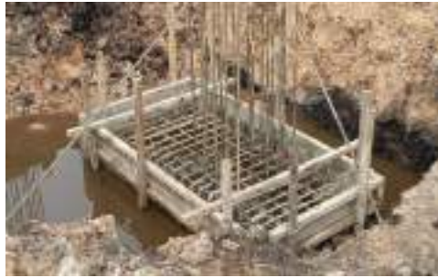
Gambar 3. 112 Pembesian pondasi tapak PC2 Sumber : Dokumentasi lapangan
