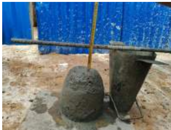
Gambar 3. 120 Slump test beton segar 12cm Sumber: Dokumentasi lapangan
