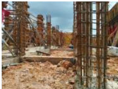
Gambar 3. 182 Pembesian kolom K2 Sumber: dokumentasi Kerja Praktek
