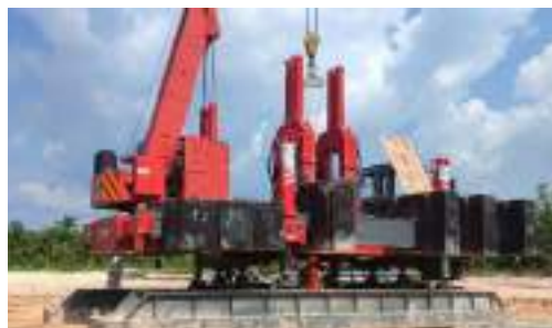
Gambar 3. 55 Alat pancang Hydraulic Static Pile Drive Sumber: Dokumentasi lapangan
