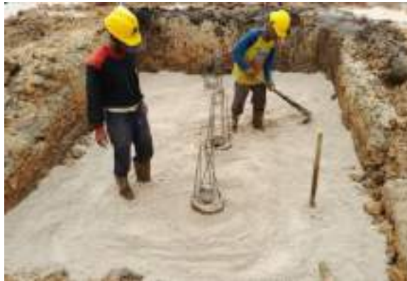
Gambar 3. 99 Hasil dari perataan pasir urug 5cm Sumber: dokumentasi Kerja Praktek lapangan
