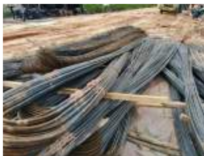
Gambar 2. 8 Besi beton Sumber: dokumentasi Kerja Praktek
