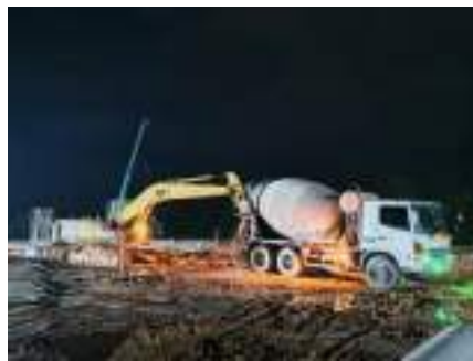
Gambar 3. 151 Proses mobilisasi dan penampungan beton segar Sumber: dokumentasi Kerja Praktek
