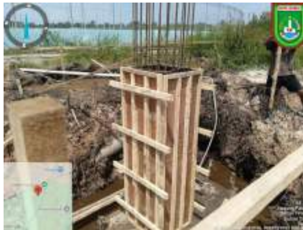
Gambar 3. 2 Bekisting Konvensional Sumber: dokumentasi Kerja Praktek
