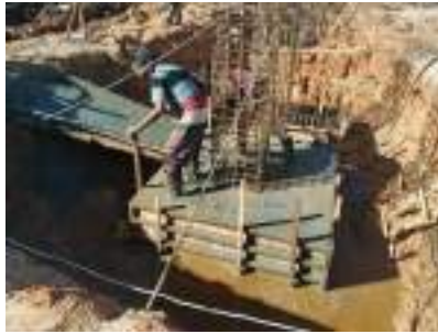
Gambar 3. 76 Pengecoran pile cap Sumber: dokumentasi Kerja Praktek
