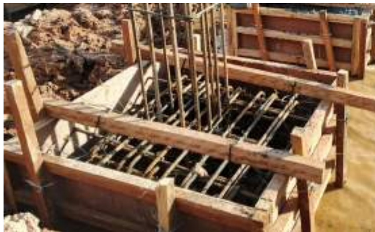
Gambar 3. 117 Bekisting pondasi tapak PC3 Sumber : Dokumentasi lapangan
