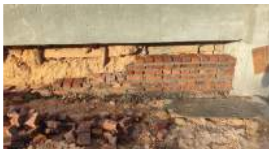
Gambar 3. 90 Proses pemasangan pondasi bata Sumber: dokumentasi Kerja Praktek
