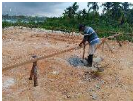
Gambar 3. 49 Pemasangan bowplank Sumber: dokumentasi Kerja Praktek
