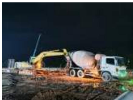
Gambar 3. 135 Menggunakan truck mixer sebagai mobilisasi, dan excavator sebagai pelangsir Sumber: dokumentasi Kerja Praktek
