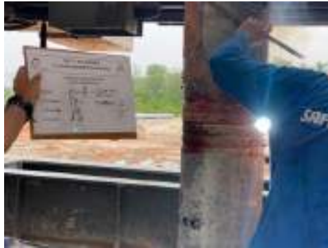
Gambar 3. 69 Penyambungan pile metode las Sumber: dokumentasi Kerja Praktek
