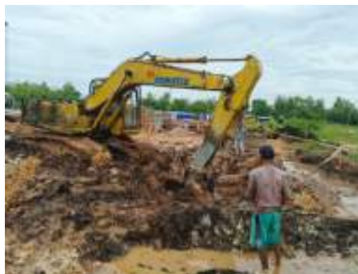
Gambar 3. 82 Excavator untuk menggali tanah
