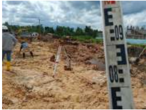
Gambar 3. 48 Proses leveling pengukuran Bowplank Sumber: dokumentasi Kerja Praktek
