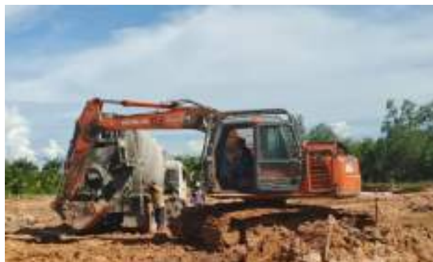
Gambar 3. 78 Truck mixer sebagai mobilisasi beton segar dan excavator sebagai pelangsir Sumber: dokumentasi Kerja Praktek
