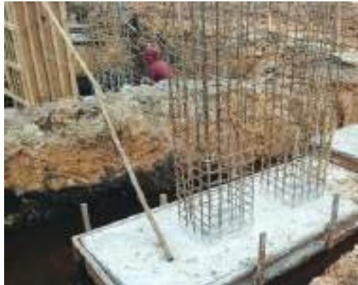
Gambar 3. 139 Besi tulangan kolom pedestal KP1 Sumber: dokumentasi Kerja Praktek
