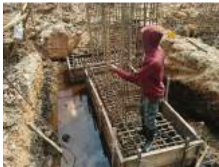
Gambar 3. 132 Proses pemasangan tulangan kolom pedestal Sumber: dokumentasi Kerja Praktek
