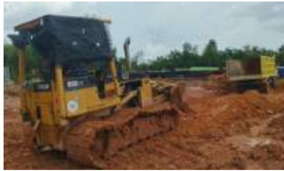
Gambar 3. 43 Proses penghamparan tanah urug menggunakan dozer Sumber: dokumentasi Kerja Praktek
