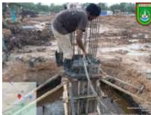
Gambar 3. 154 Proses pemadatan menggunakan vibrator machine Sumber: dokumentasi Kerja Praktek
