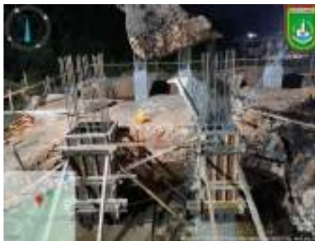
Gambar 3. 153 Proses pengecoran KP Sumber: dokumentasi Kerja Praktek
