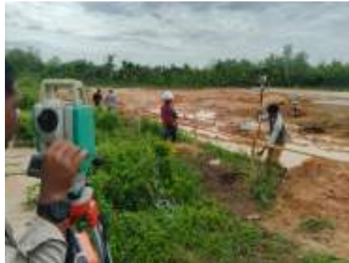
Gambar 3. 169 Proses leveling sloof Sumber: dokumentasi Kerja Praktek
