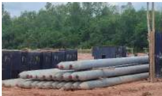
Gambar 3. 54 Tiang pancang spun pile D30 12m Sumber: Dokumentasi lapangan
