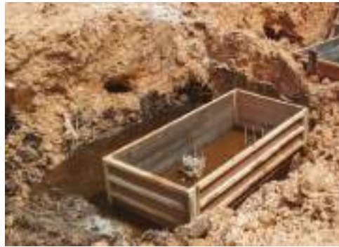
Gambar 3. 114 Bekisting pondasi tapak PC2 Sumber : Dokumentasi lapangan
