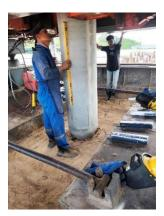
Gambar 3. 4 Proses mengatur kepresisian spun pile
