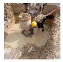
Gambar 3. 12 Pemotongan tulangan spun pile
