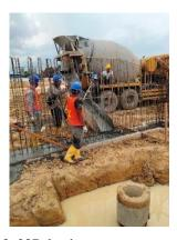
Gambar 3. 23Pekerjaan pengecoran tie bim
