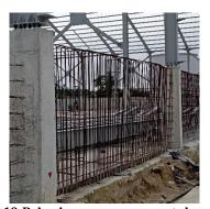
Gambar 3. 19 Pekerjaan pemasangan tulangan dinding
