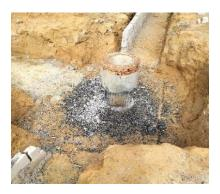
Gambar 3. 13 Pekerjaan pembobokan spun pile
