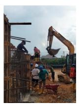
Gambar 3. 28Pekerjaan pengecoran kolom pedestal
