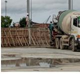
Gambar 3. 30Pekerjaan pengecoran dinding
