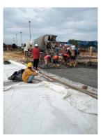
Gambar 3. 34Proses penuangan beton
