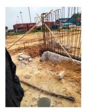
Gambar 3. 18Pekerjaan pemasangan tulangan pedestal
