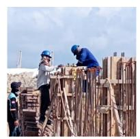
Gambar 3. 26ekerjaan pemasangan angkor
