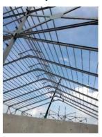
Gambar 3. 38Pekerjaan erection atap
