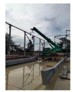
Gambar 3. 35Pekerjaan erection kolom daan balok baja
