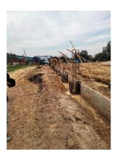
Gambar 3. 17Pekerjaan pengikatan tulangan pedestal
