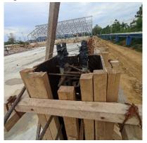
Gambar 3. 25Proses pemasangan angkor
