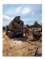
Gambar 3. 21Pekerjaan pengecoran mengunakan truk mixer
