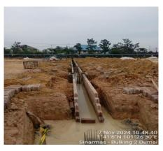
Gambar 3. 11Pekerjaan pemasangan formwork
