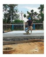
Gambar 3. 33Proses penghalusan coran mengunakan alat Trowel
