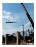
Gambar 3. 36Pekerjaan erection balok baja
