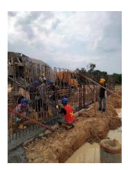
Gambar 3. 22Pekerjaan pengecoran pile cap dan tie bim
