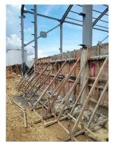
Gambar 3. 20Pekerjaan penegecoran dinding
