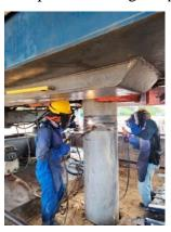
Gambar 3. 5 Proses mengatur kepresisian spun pile
