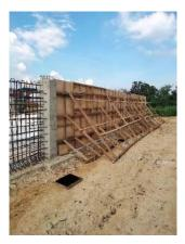
Gambar 3. 29Pekerjaan pemasangan formwork dinding
