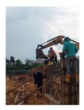
Gambar 3. 27Proses penuangan beton kedalam pedestal
