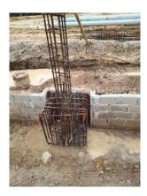
Gambar 3. 15Pekerjaan pemasangan tulangan
