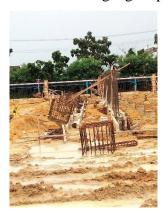
Gambar 3. 14Pekerjaan pemasangan tulangan pilecap dan tibe bem
