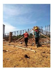
Gambar 3. 24Pekerjaan pemasangan formwork pedestal
