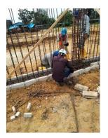
Gambar 3. 16Pekerjaan pemasangan formwork
