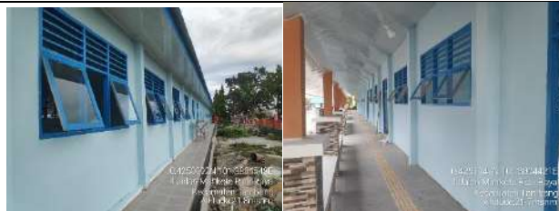
Pembangunan Rkb 5 Lokal
