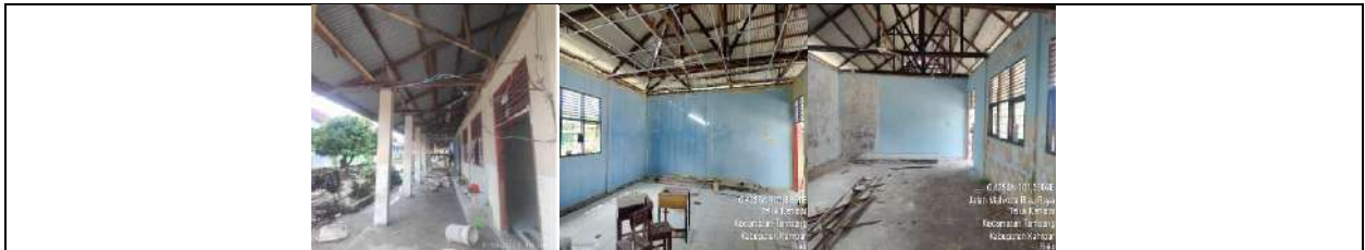
Rehab Gedung A
