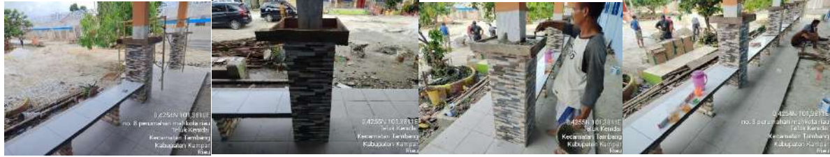
Rehab Gedung B
