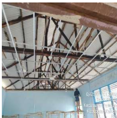
(f) Gedung ADM
