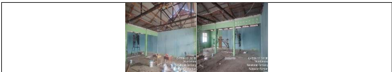
Rehab Gedung Administrasi/R.Guru
