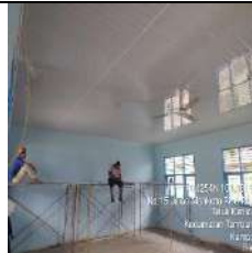
Rehab Gedung D
