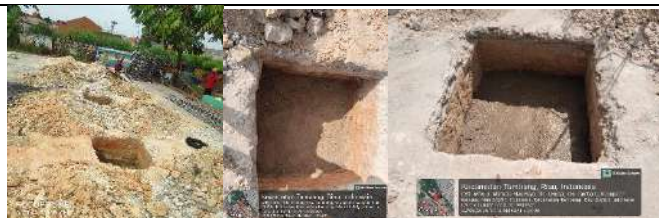
Pembangunan Rkb 2 Lokal
