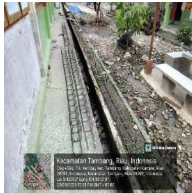
Gambar 3. 8 Pekerjaan Pembesian Sloof
