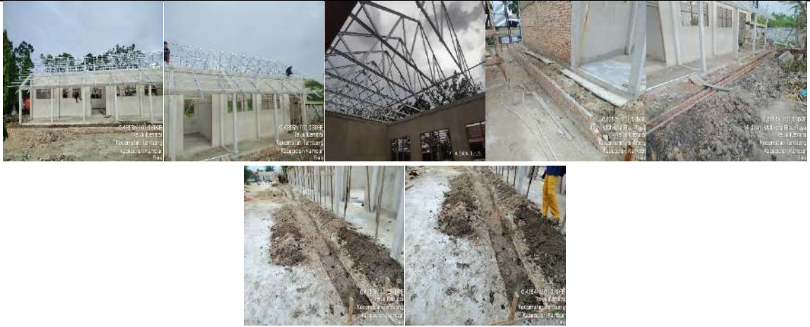
Pembangunan Rkb 5 Lokal
