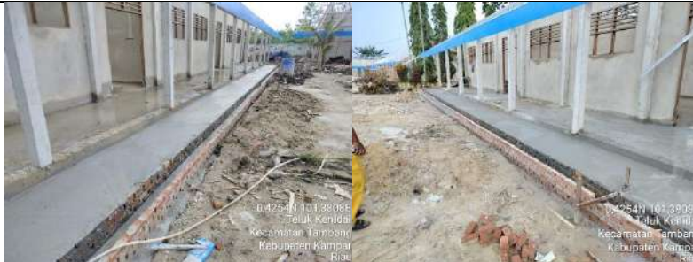
Pembangunan Rkb 5 Lokal
