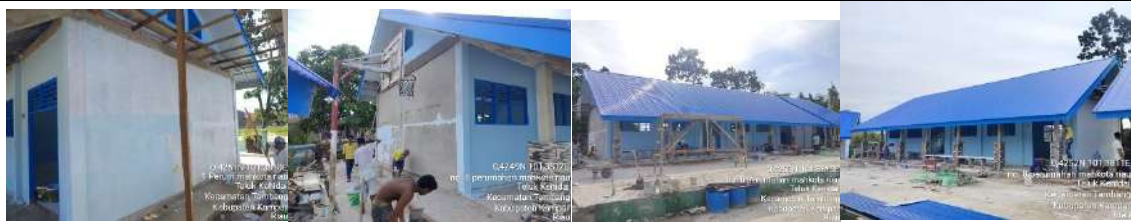
Pembangunan Rkb 2 Lokal
