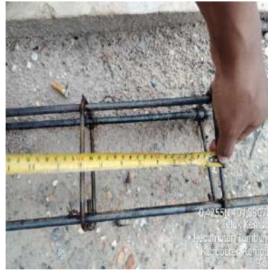
Gambar 3. 11 Pekerjaan Pembesian Kolom K1
