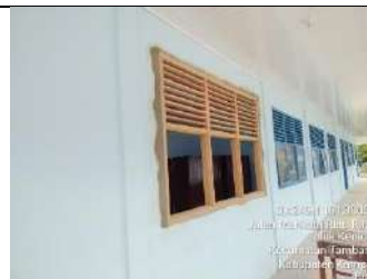
Rehab Gedung A
