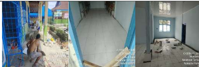
Rehab Gedung Administrasi/R.Guru
