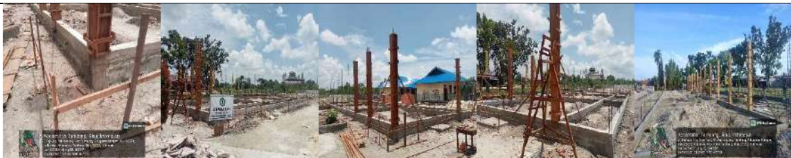
Pembangunan Rkb 5 Lokal
