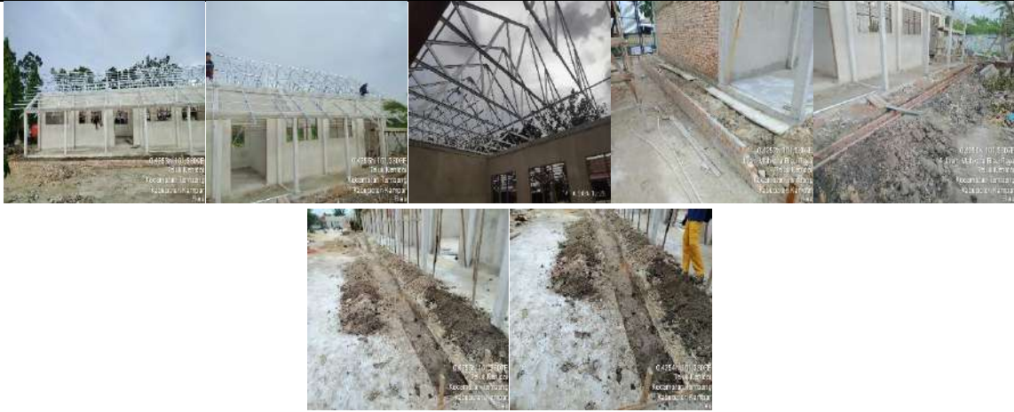
Pembangunan Rkb 5 Lokal
