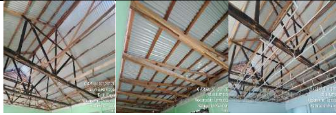
Rehab Gedung R.Guru
