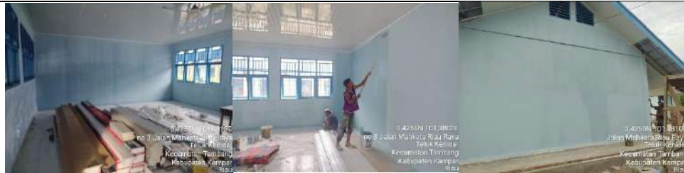
Pembangunan Rkb 5 Lokal
