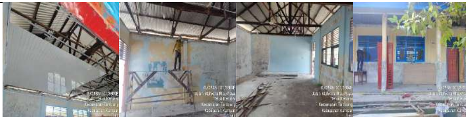
Rehab Gedung B
