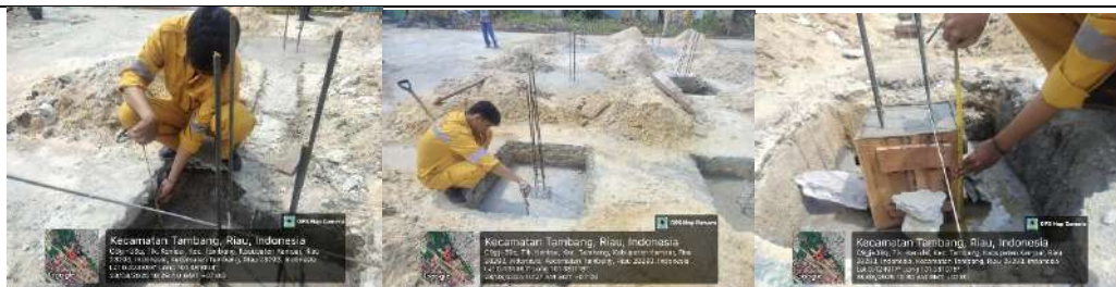
Pembangunan Rkb 2 Lokal
