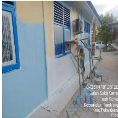
(f) Gedung ADM
