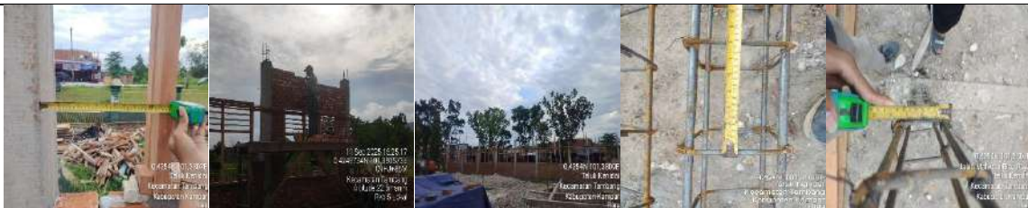
Pembangunan Rkb 5 Lokal
