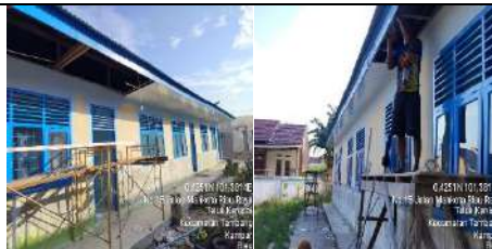
Rehab Gedung F
