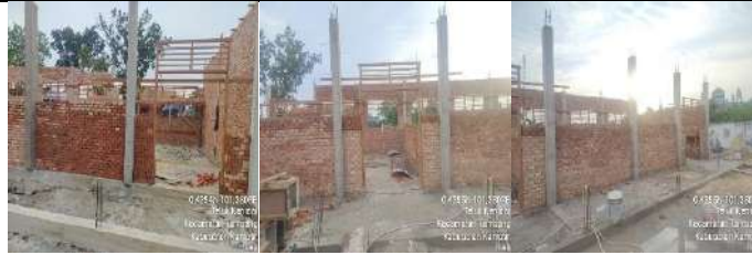
Pembangunan Rkb 5 Lokal
