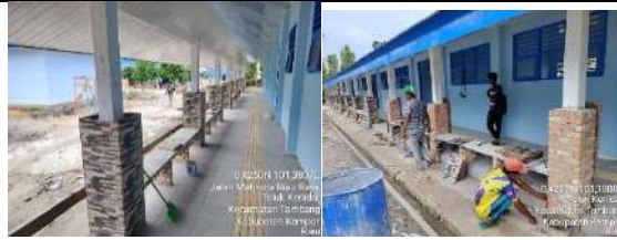
Pembangunan Rkb 5 Lokal
