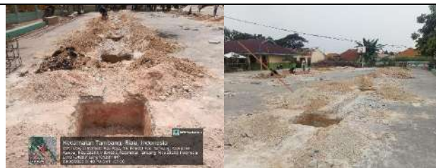
Pembangunan Rkb 2 Lokal
