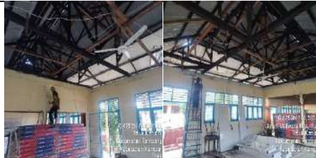
Rehab Gedung Lab.Komputer
