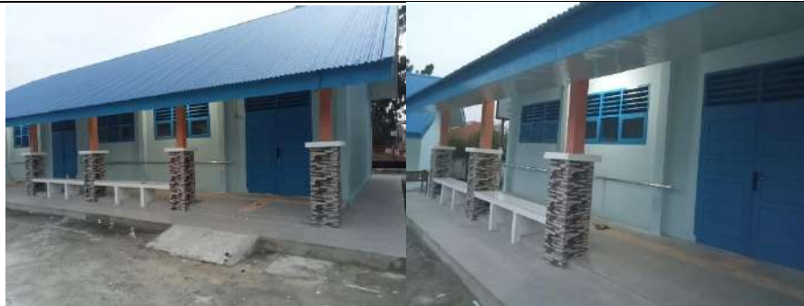
Pembangunan Rkb 2 Lokal
