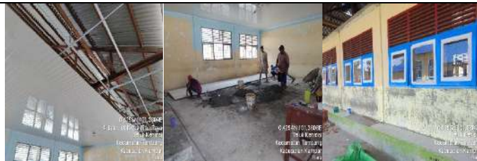
Rehab Gedung A
