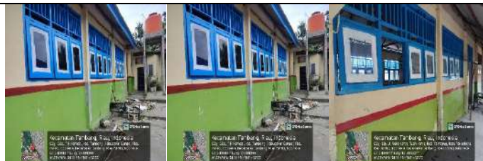
Rehab Gedung C
