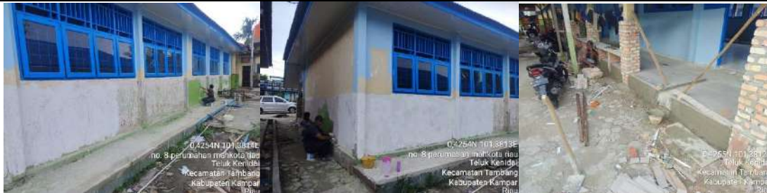
Rehab Gedung C
