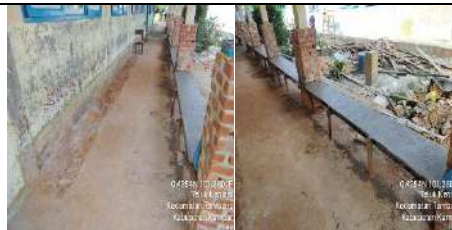
Rehab Gedung A
