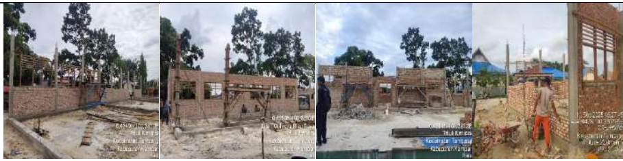
Pembangunan Rkb 2 Lokal
