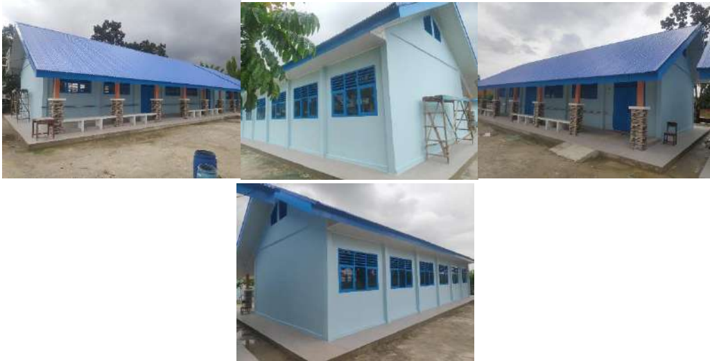
Pembangunan Rkb 2 Lokal
