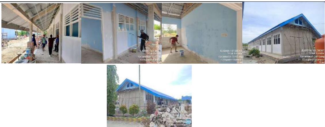
Pembangunan Rkb 5 Lokal
