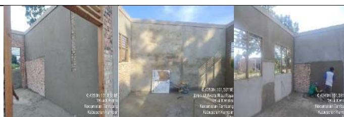
Pembangunan Rkb 2 Lokal
