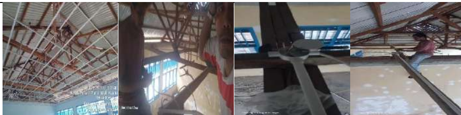
Rehab Gedung D
