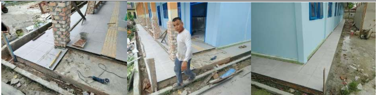
Rehab Gedung D
