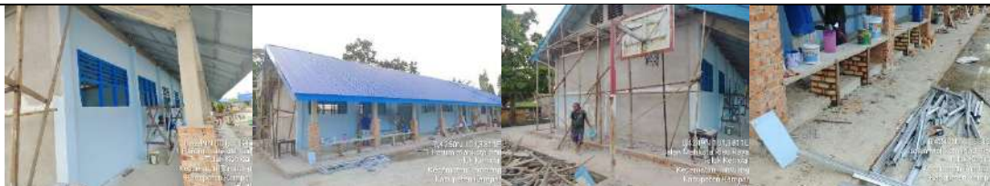
Pembangunan Rkb 2 Lokal
