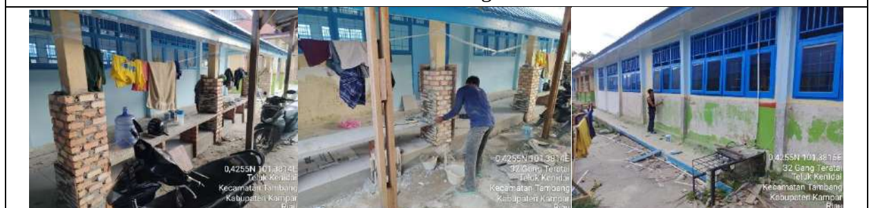
Rehab Gedung C
