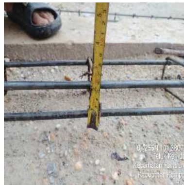
Gambar 3. 15 Pekerjaan Pembesian Ring Balok
