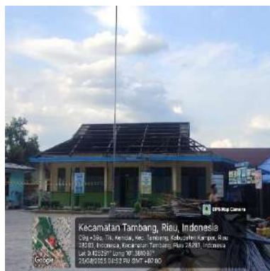
(f) Gedung ADM
