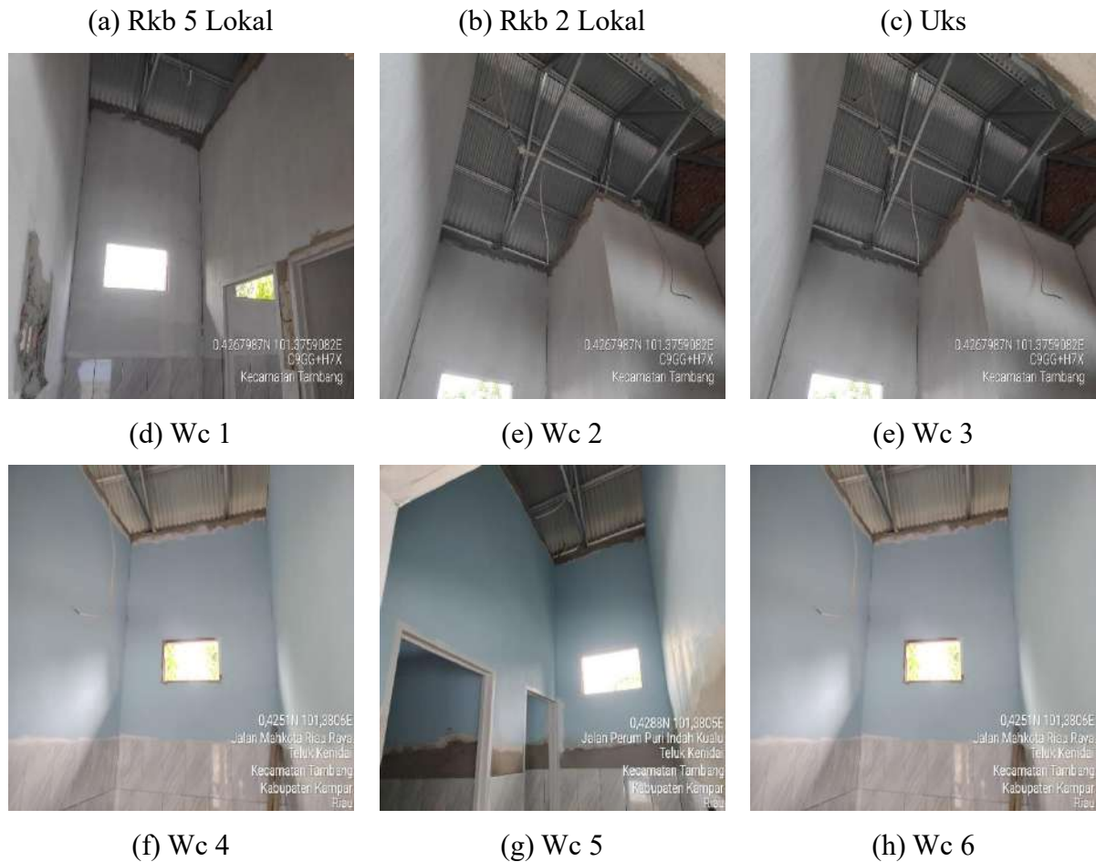
Gambar 3. 28 Pekerjaan Pemasangan Instalasi Listrik
