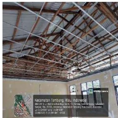
(e) Gedung E
