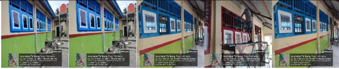
Rehab Gedung C
