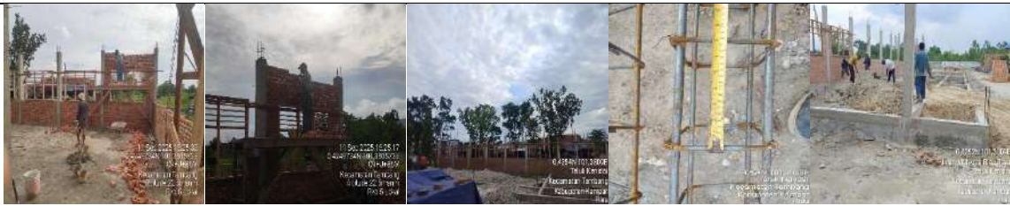
Pembangunan Rkb 5 Lokal
