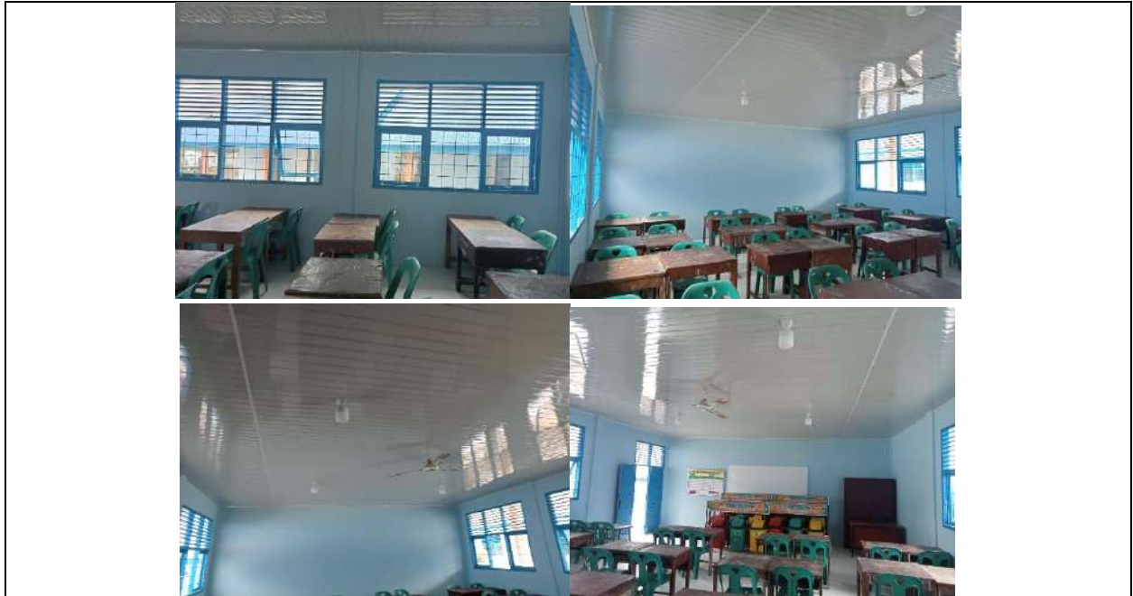
Rehab Gedung A
