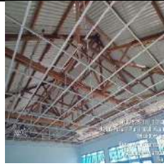
Rehab Gedung D
