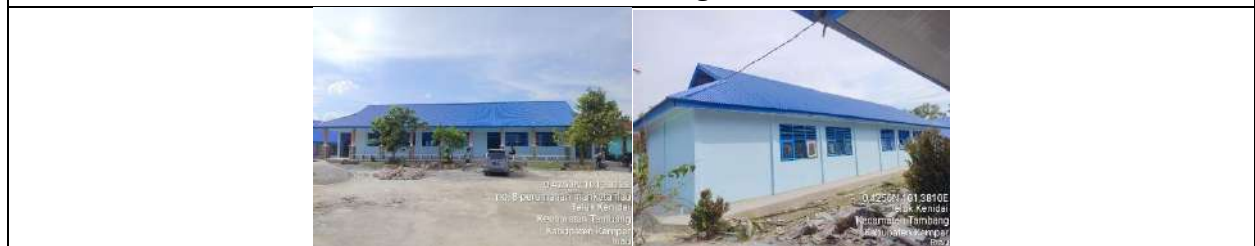
Rehab Gedung B
