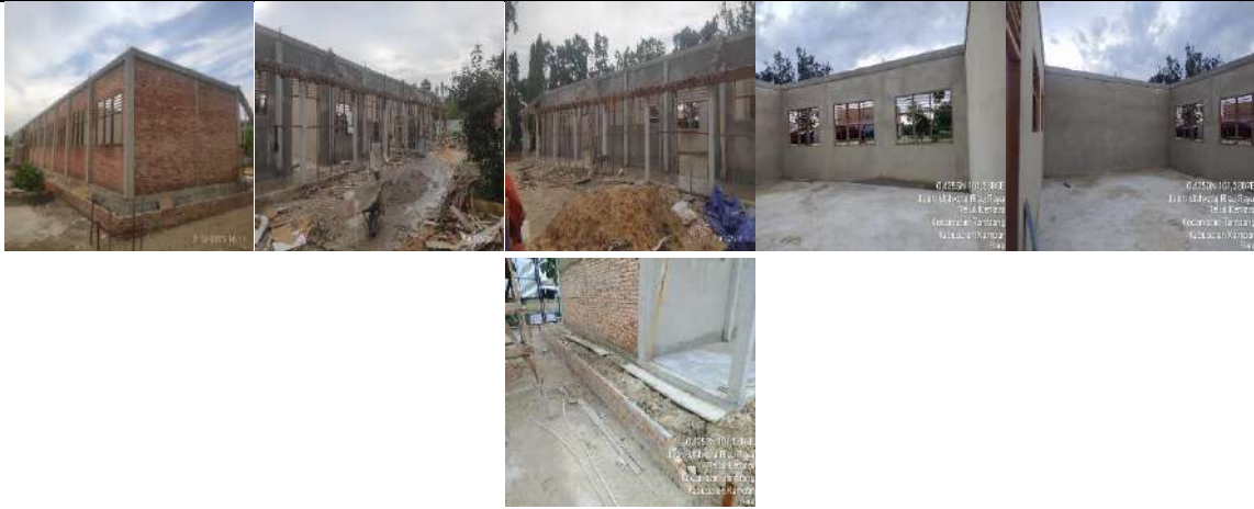
Pembangunan Rkb 5 Lokal
