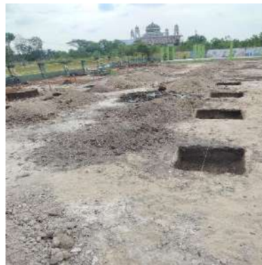
Gambar 3. 5 Pekerjaan Persiapan dan Galian
