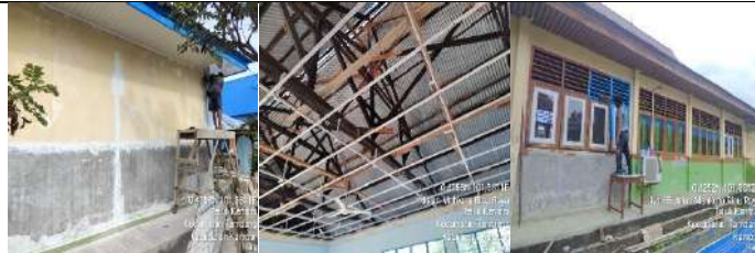
Rehab Gedung Lab.Komputer
