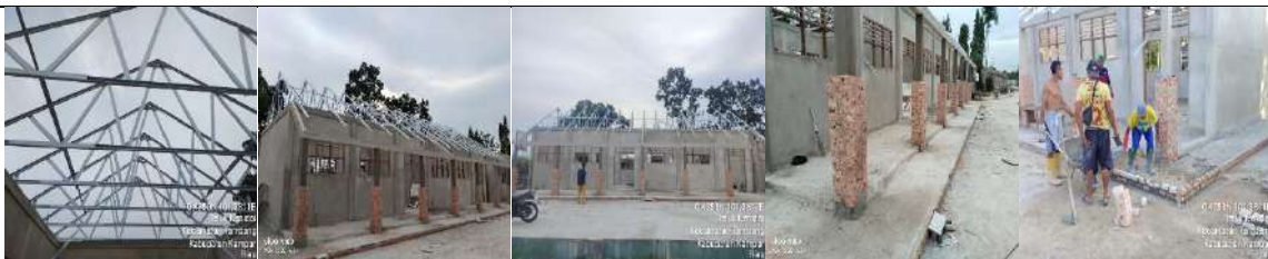
Pembangunan Rkb 2 Lokal
