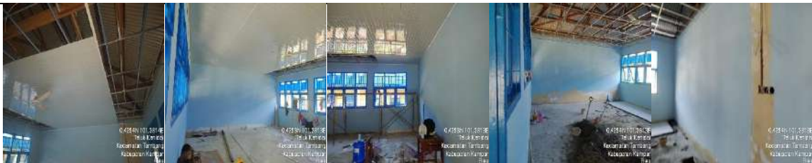
Rehab Gedung C
