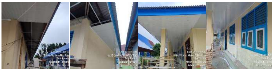
Rehab Gedung E
