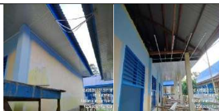
Rehab Gedung D
