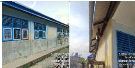
Rehab Gedung B
