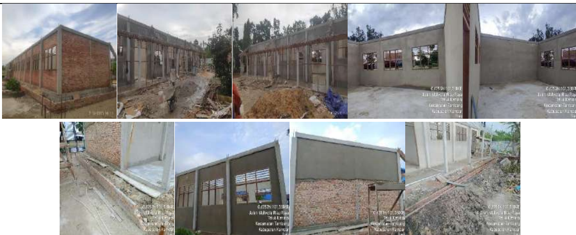
Pembangunan Rkb 5 Lokal
