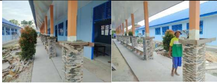
Rehab Gedung A
