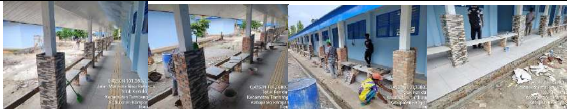
Pembangunan Rkb 5 Lokal
