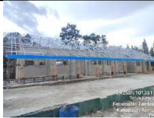
Pembangunan Rkb 2 Lokal
