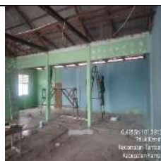
Rehab Gedung Administrasi/R.Guru
