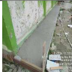
Rehab Gedung C
