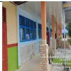
Rehab Gedung Lab.Komputer
