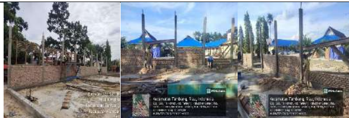
Pembangunan Rkb 2 Lokal
