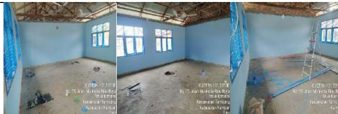
Rehab Gedung D
