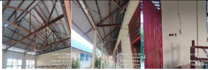
Rehab Gedung A
