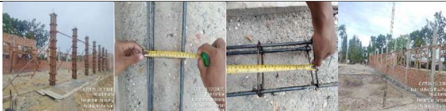
Pembangunan Rkb 5 Lokal
