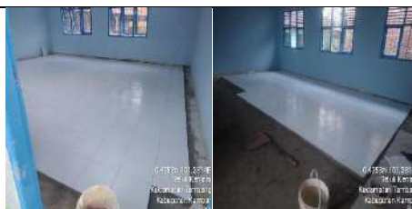
Rehab Gedung F
