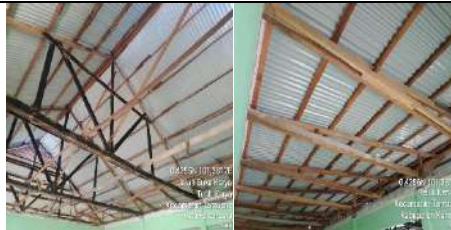
Rehab Gedung R.Guru
