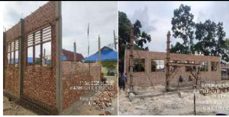
Pembangunan Rkb 2 Lokal
