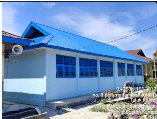
Rehab Gedung C
