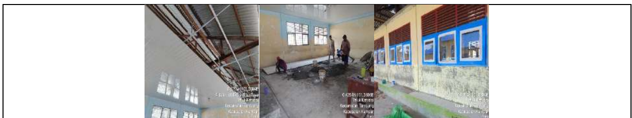
Rehab Gedung A
