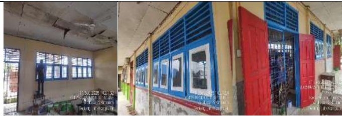
Rehab Gedung Lab.Komputer
