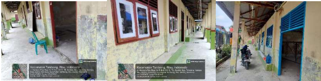
Rehab Gedung D
