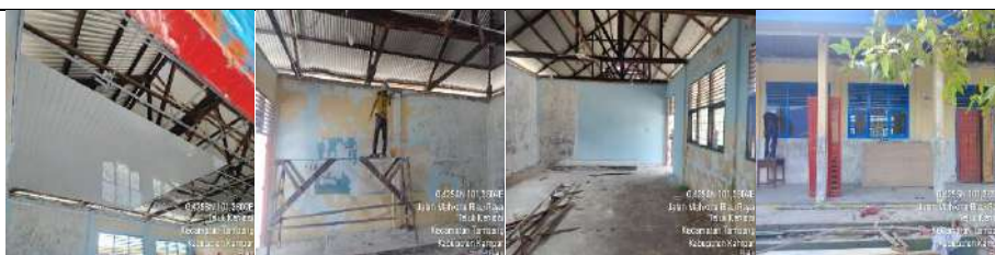
Rehab Gedung B
