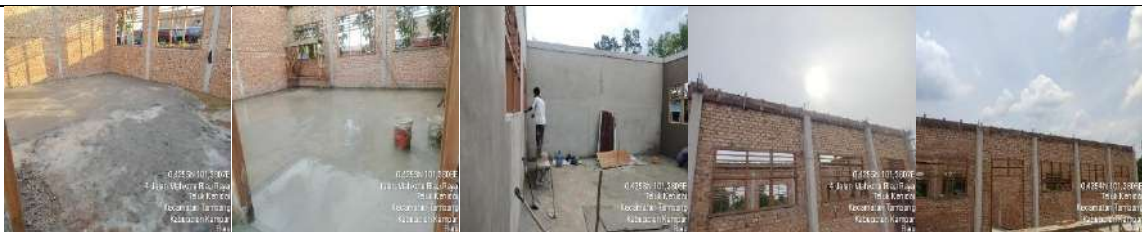
Pembangunan Rkb 5 Lokal
