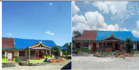
Rehab Gedung Lab.Komputer
