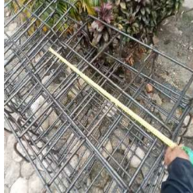
Gambar 3. 6 Pekerjaan Pembesian Pondasi
