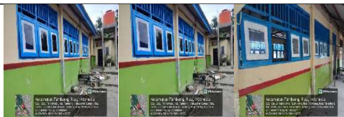
Rehab Gedung C
