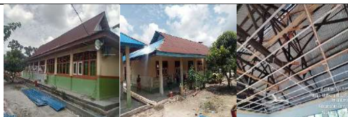
Rehab Gedung E
