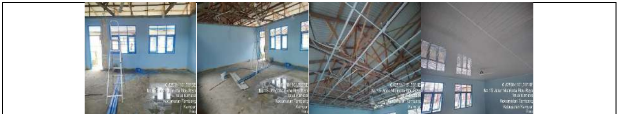
Rehab Gedung F
