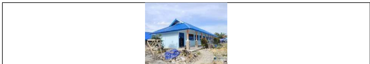
Rehab Gedung A
