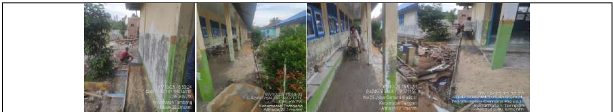
Rehab Gedung B
