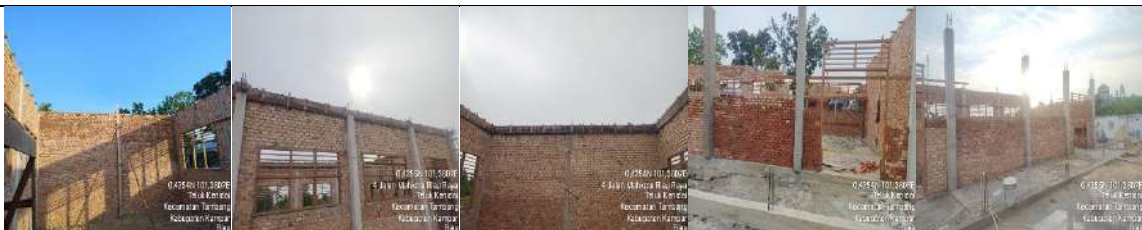
Pembangunan Rkb 5 Lokal
