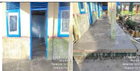
Rehab Gedung Administrasi/R.Guru
