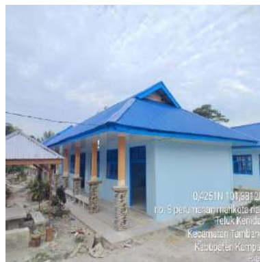
(e) Gedung E
