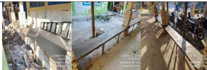
Rehab Gedung C
