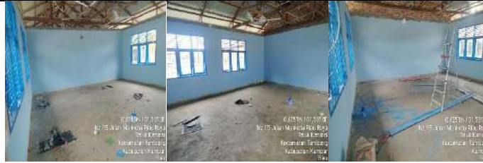
Rehab Gedung D
