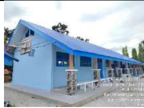
Pembangunan Rkb 2 Lokal
