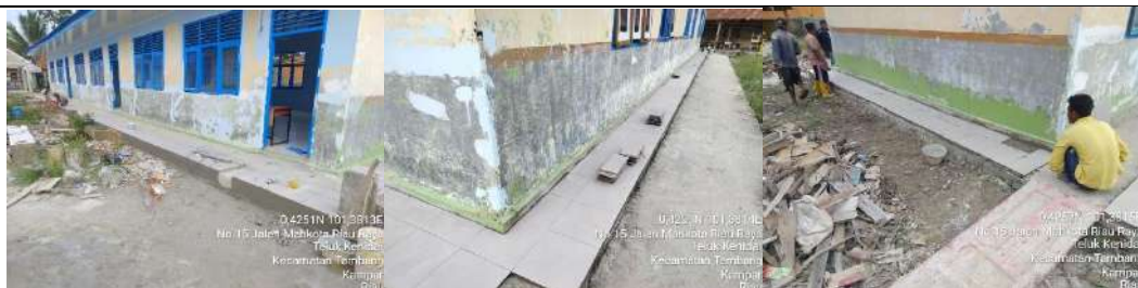
Rehab Gedung F
