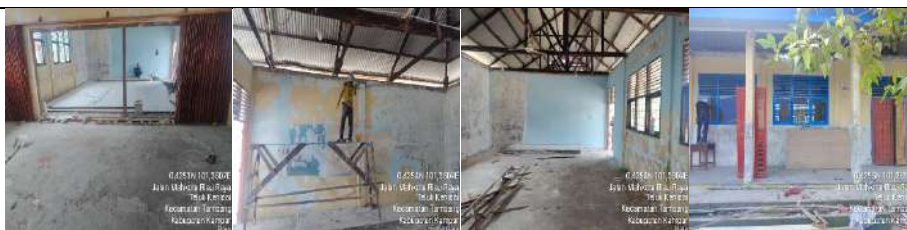
Rehab Gedung B
