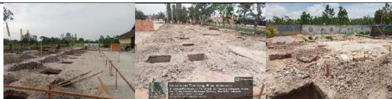
Pembangunan Rkb 5 Lokal
