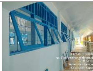
Rehab Gedung C
