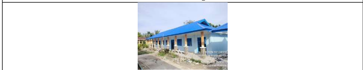
Rehab Gedung D
