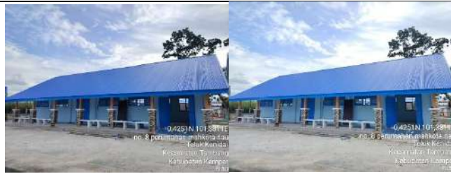
Pembangunan Rkb 2 Lokal
