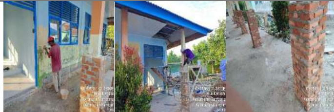
Rehab Gedung A
