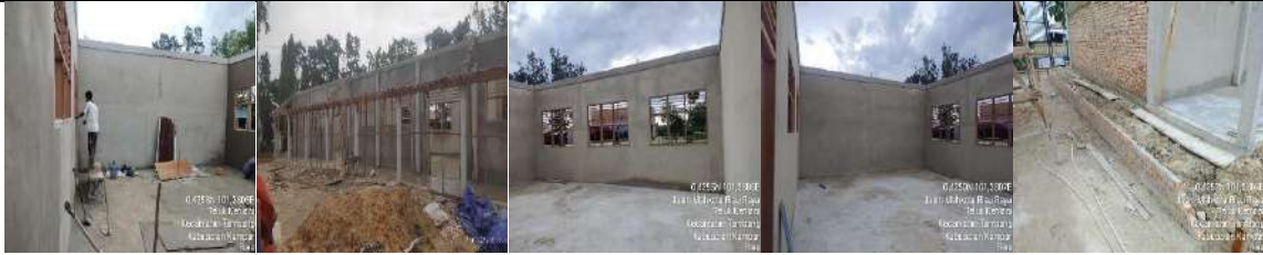
Pembangunan Rkb 5 Lokal
