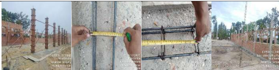
Pembangunan Rkb 5 Lokal
