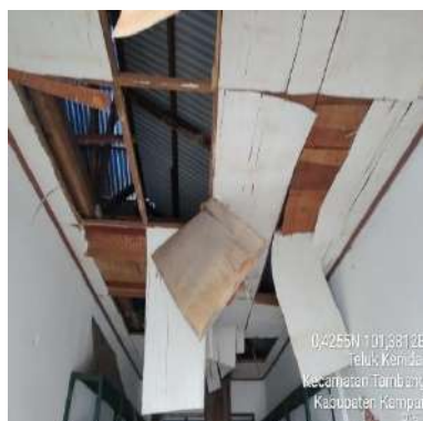
(f) Gedung ADM
