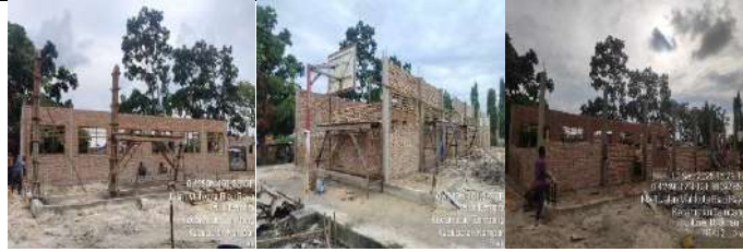
Pembangunan Rkb 2 Lokal
