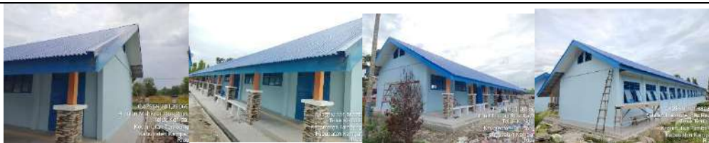
Pembangunan Rkb 5 Lokal
