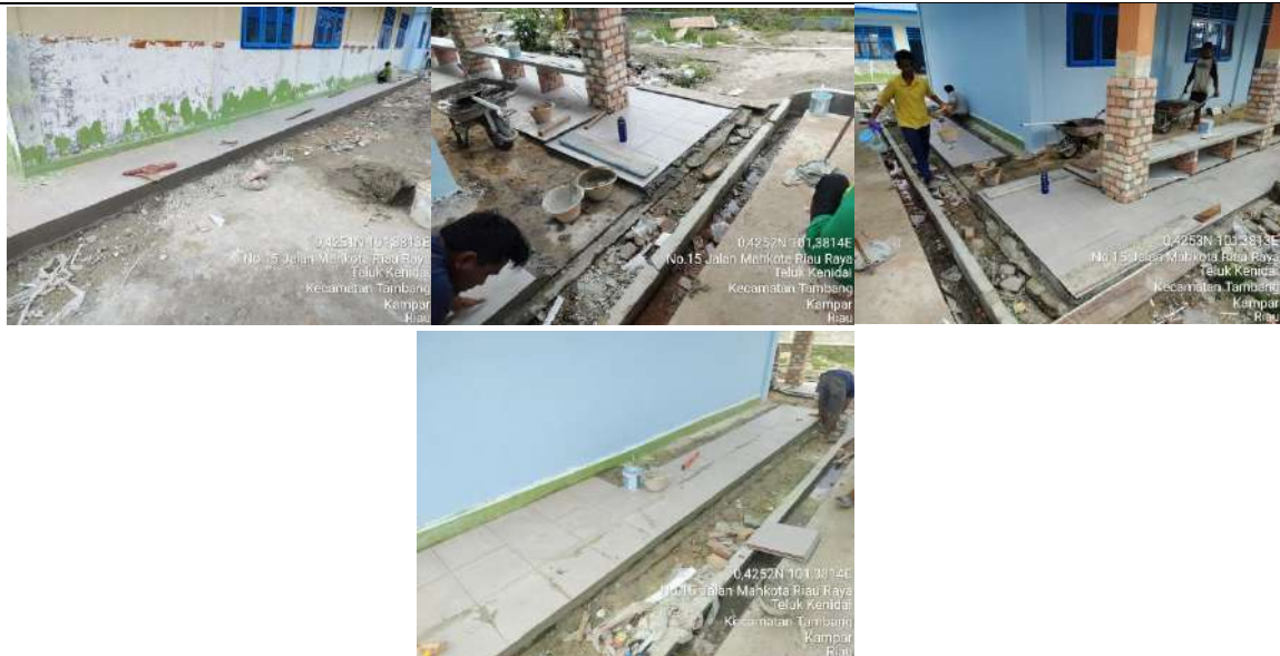
Rehab Gedung E
