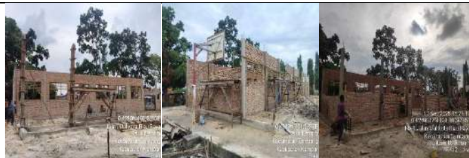
Pembangunan Rkb 2 Lokal
