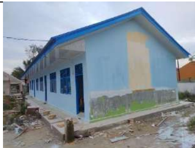
Rehab Gedung F
