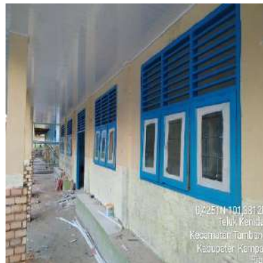
(e) Gedung E
