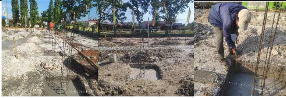
Pembangunan Rkb 5 Lokal
