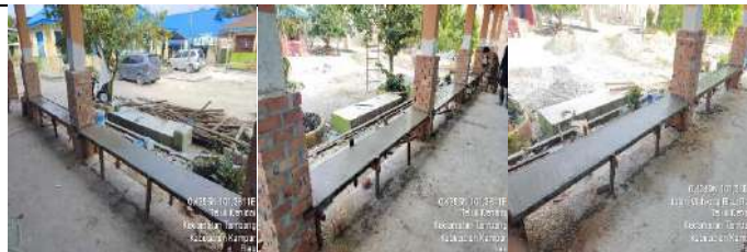
Rehab Gedung B
