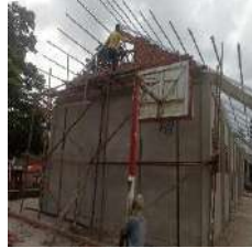
Pembangunan Rkb 2 Lokal
