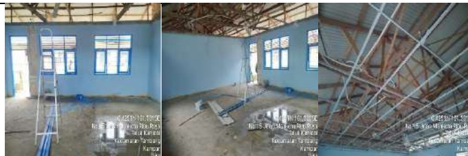
Rehab Gedung F
