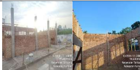
Pembangunan Rkb 5 Lokal
