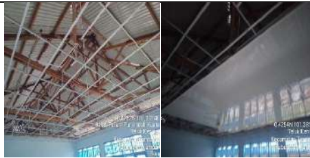
Rehab Gedung C
