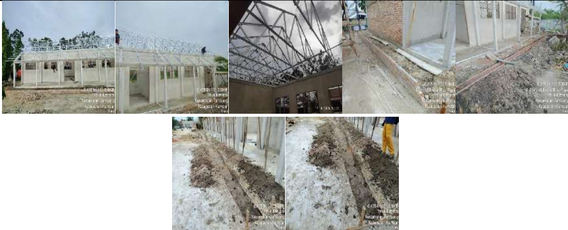
Pembangunan Rkb 5 Lokal
