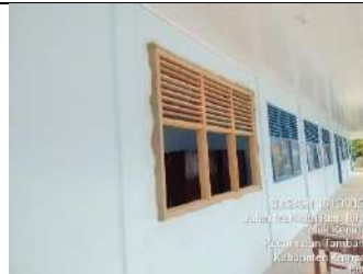
Rehab Gedung A
