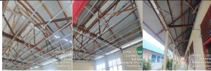
Rehab Gedung A
