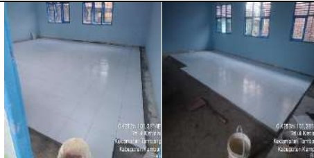
Rehab Gedung F
