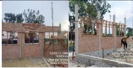
Pembangunan Rkb 5 Lokal
