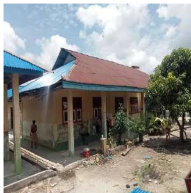
(e) Gedung E
