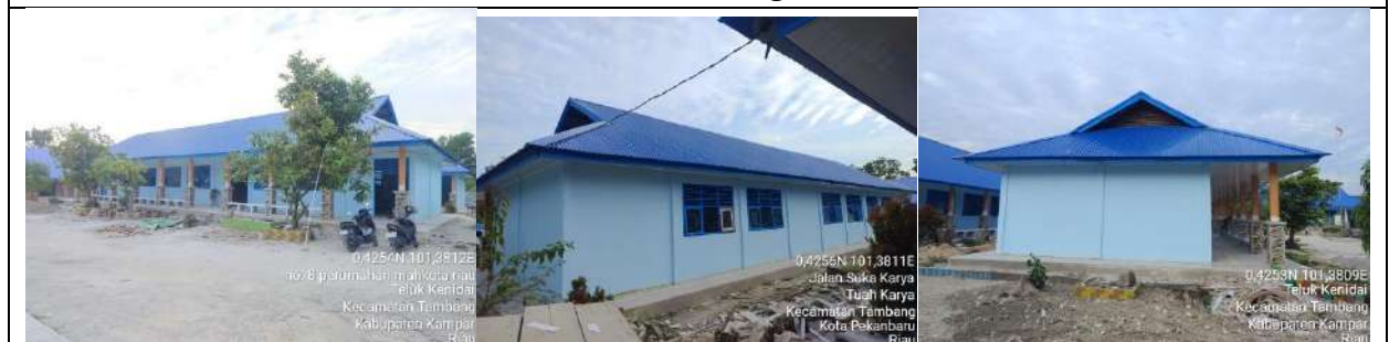
Rehab Gedung B
