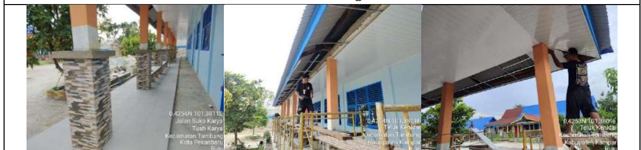
Rehab Gedung B
