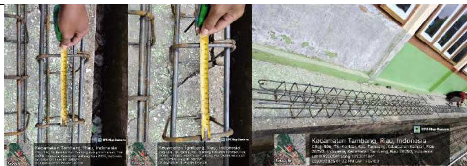
Pembangunan Rkb 2 Lokal
