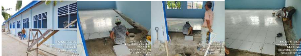
Pembangunan Rkb 2 Lokal
