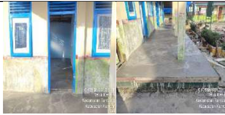
Rehab Gedung Administrasi/R.Guru
