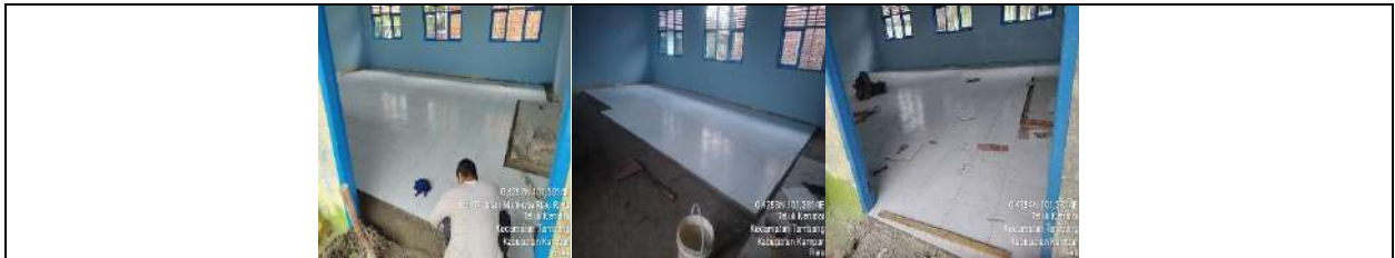
Rehab Gedung D
