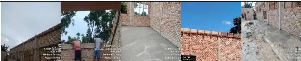
Pembangunan Rkb 2 Lokal
