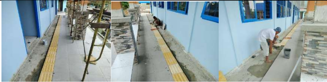
Rehab Gedung B
