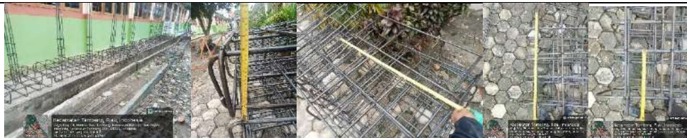
Pembangunan Rkb 5 Lokal
