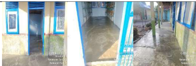
Rehab Gedung Administrasi/R.Guru
