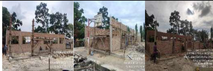
Pembangunan Rkb 2 Lokal
