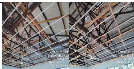
Rehab Gedung Lab. Komputer
