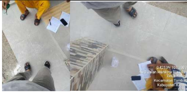
Pembangunan Rkb 2 Lokal
