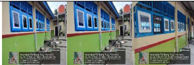
Rehab Gedung C
