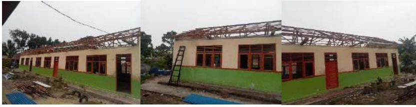
Rehab Gedung F
