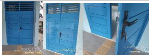
Pembangunan Rkb 5 Lokal
