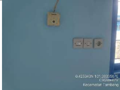
Rehab Gedung D
