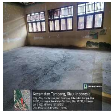
(e) Gedung E
