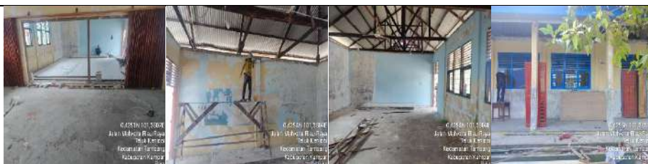
Rehab Gedung B
