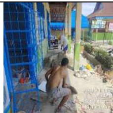
Rehab Gedung Administrasi/R.Guru
