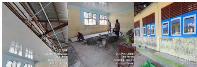
Rehab Gedung A
