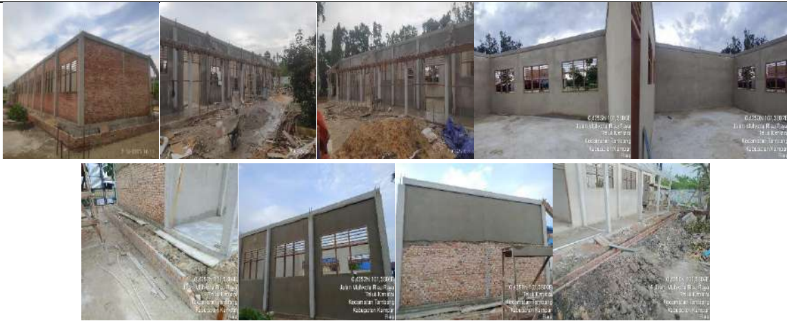
Pembangunan Rkb 5 Lokal
