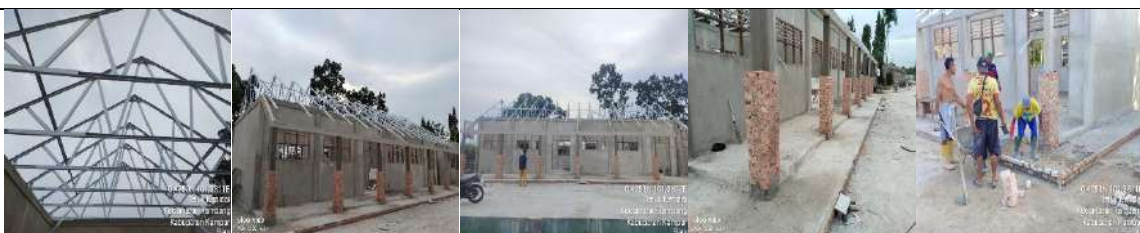
Pembangunan Rkb 2 Lokal
