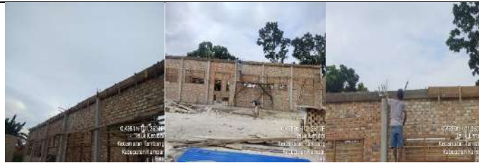
Pembangunan Rkb 2 Lokal
