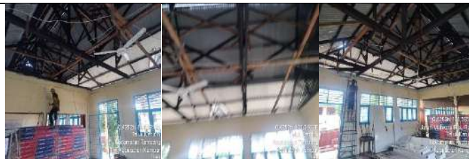
Rehab Gedung Lab.Komputer
