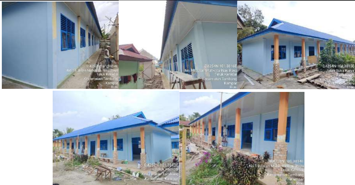
Rehab Gedung D
