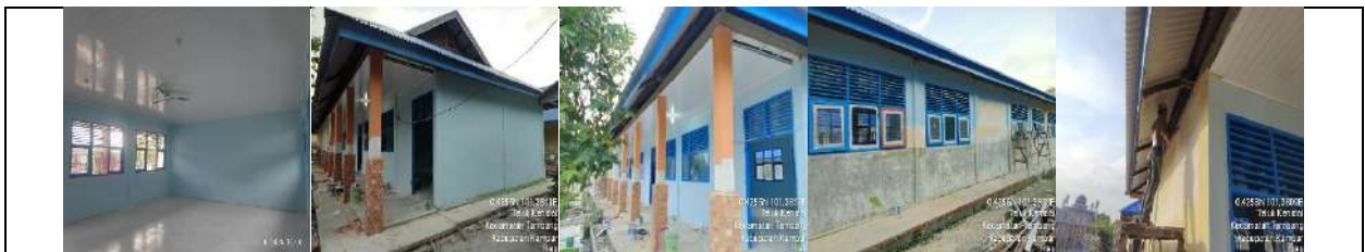
Rehab Gedung B
