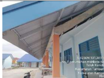
Pembangunan Rkb 2 Lokal
