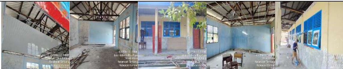
Rehab Gedung B
