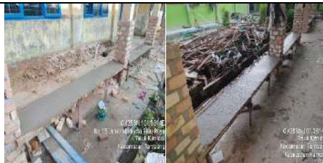
Rehab Gedung D
