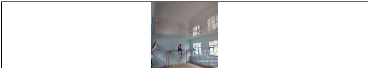
Rehab Gedung D
