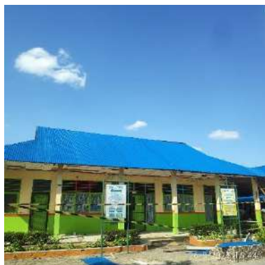
(f) Gedung ADM
