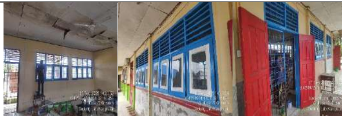
Rehab Gedung Lab.Komputer
