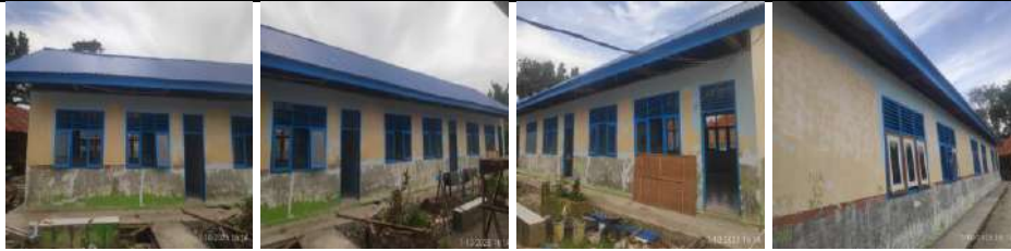
Rehab Gedung F
