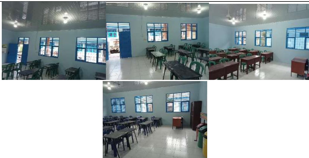
Rehab Gedung E
