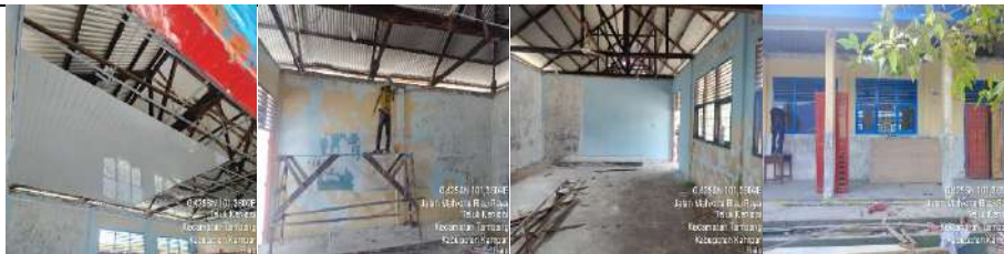
Rehab Gedung B
