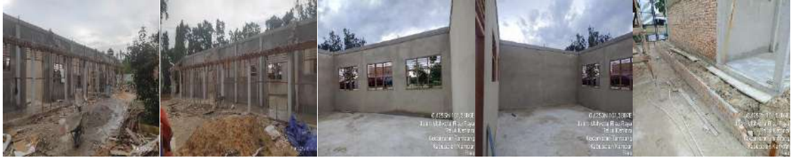
Pembangunan Rkb 5 Lokal
