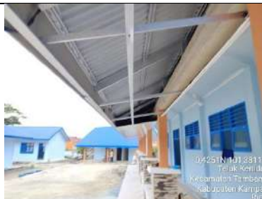
Pembangunan Rkb 2 Lokal
