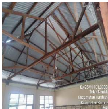
(e) Gedung E
