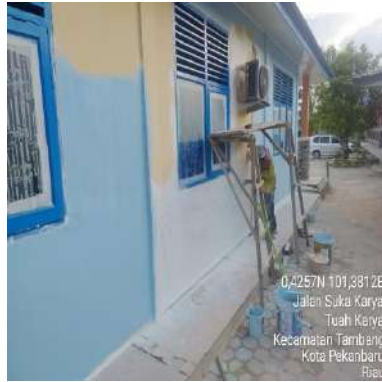
(f) Gedung ADM
