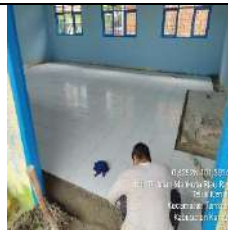
Rehab Gedung D
