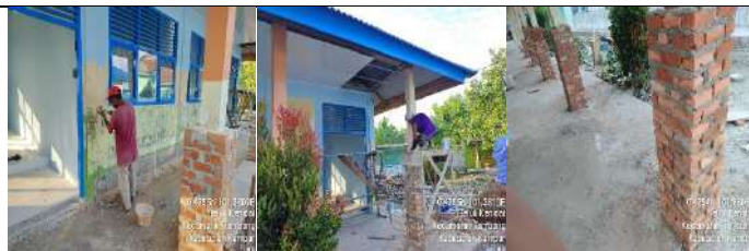
Rehab Gedung A
