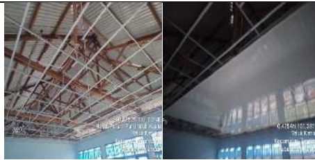
Rehab Gedung C
