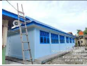
Rehab Gedung C
