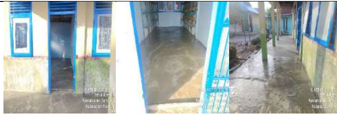
Rehab Gedung Administrasi/R.Guru
