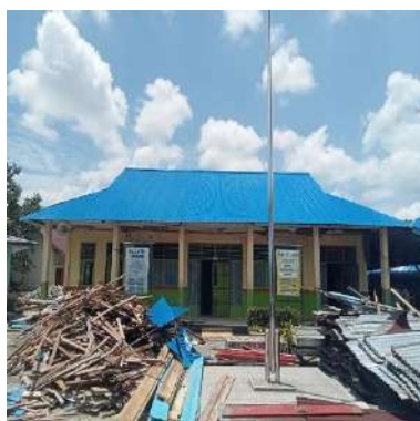
(f) Gedung ADM
