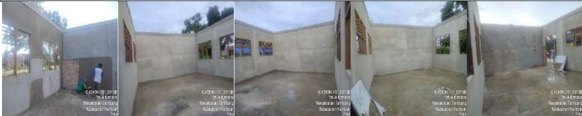
Pembangunan Rkb 2 Lokal
