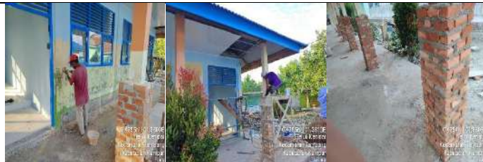
Rehab Gedung A
