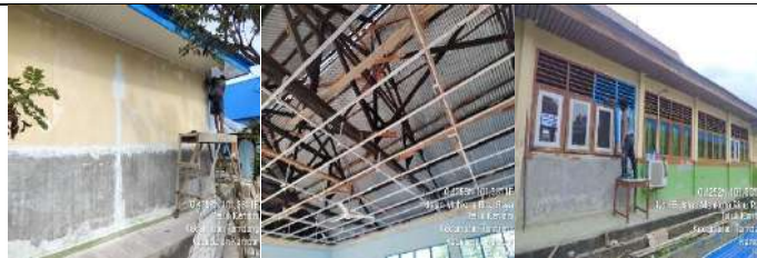
Rehab Gedung Lab.Komputer
