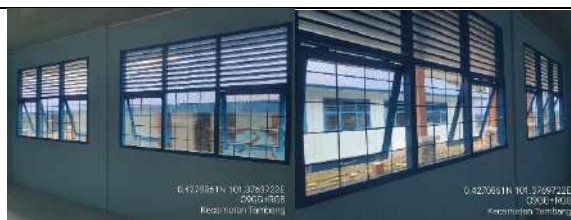
Rehab Gedung A
