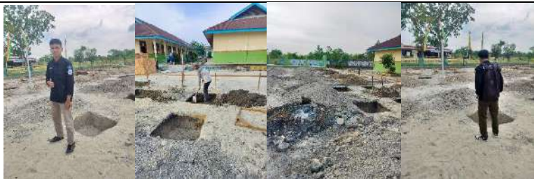
Pembangunan Rkb 5 Lokal
