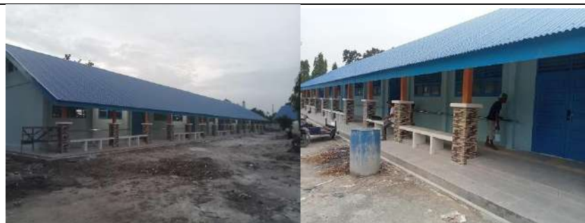
Pembangunan Rkb 5 Lokal
