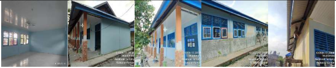
Rehab Gedung B
