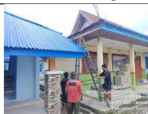
Rehab Gedung C
