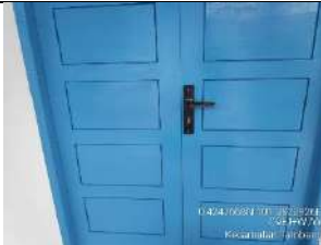
Rehab Gedung B
