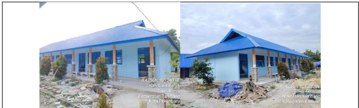
Rehab Gedung A
