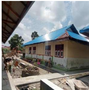
(e) Gedung E
