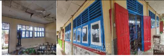
Rehab Gedung Lab.Komputer
