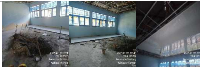
Rehab Gedung C
