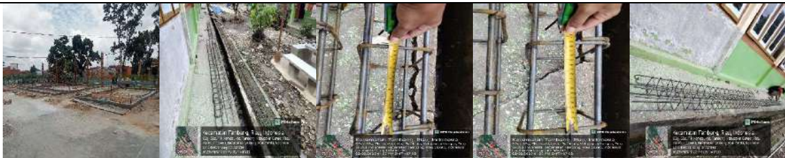
Pembangunan Rkb 2 Lokal
