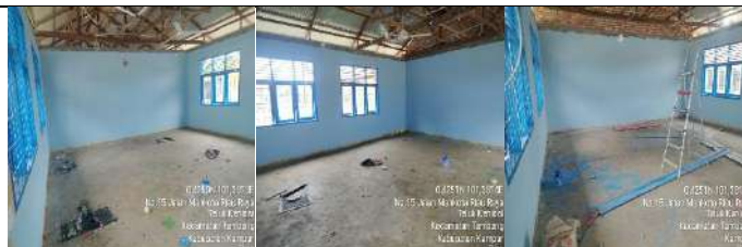
Rehab Gedung D
