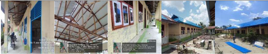
Rehab Gedung D
