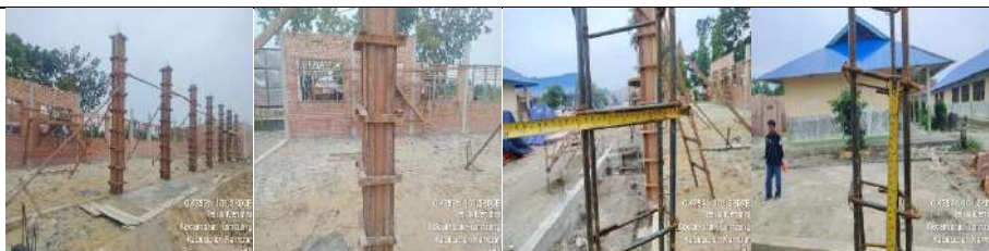
Pembangunan Rkb 5 Lokal
