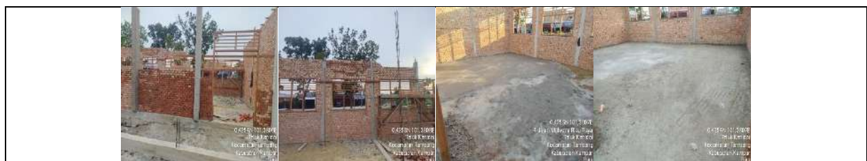
Pembangunan Rkb 5 Lokal
