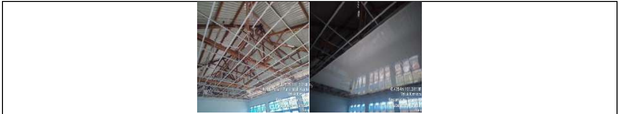
Rehab Gedung C
