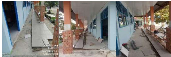
Rehab Gedung B
