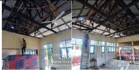
Rehab Gedung Lab.Komputer
