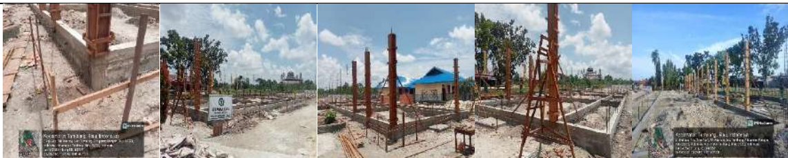
Pembangunan Rkb 5 Lokal
