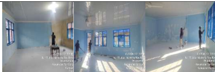
Rehab Gedung F
