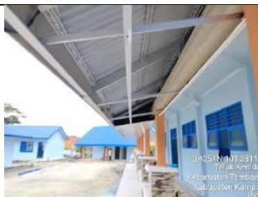
Pembangunan Rkb 2 Lokal
