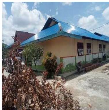
(e) Gedung E
