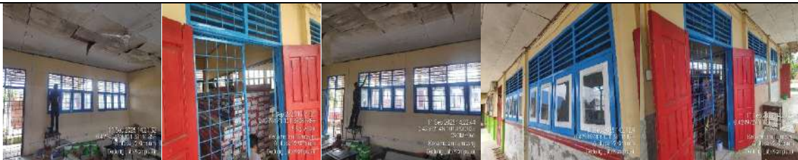
Rehab Gedung Lab.Komputer
