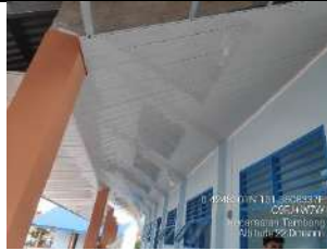
Pembangunan Rkb 2 Lokal
