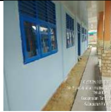
Rehab Gedung E
