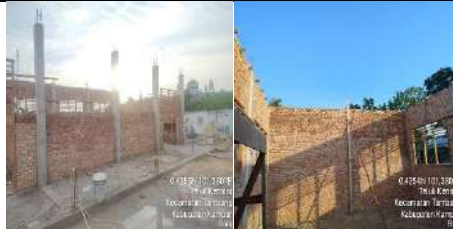
Pembangunan Rkb 5 Lokal
