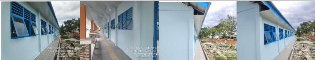
Pembangunan Rkb 5 Lokal
