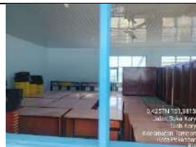
Rehab Gedung A
