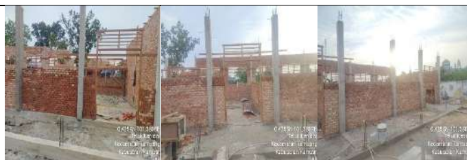
Pembangunan Rkb 5 Lokal
