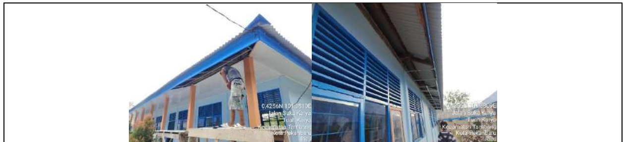
Rehab Gedung A
