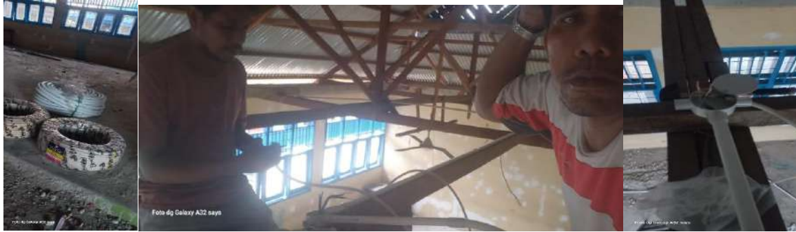
Rehab Gedung C
