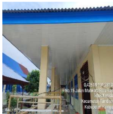
(e) Gedung E
