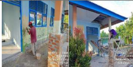
Rehab Gedung A
