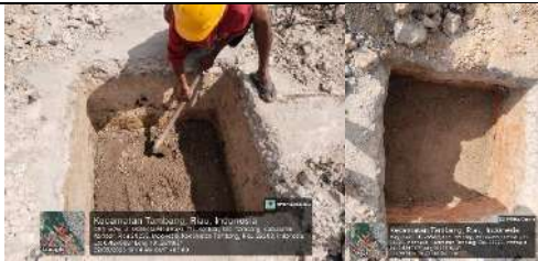
Pembangunan Rkb 2 Lokal
