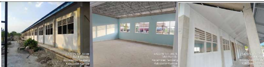
Pembangunan Rkb 5 Lokal
