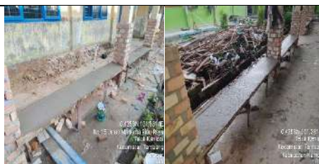
Rehab Gedung D
