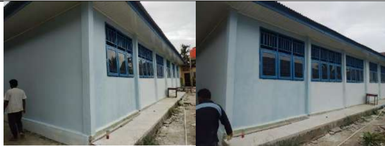
Rehab Gedung C
