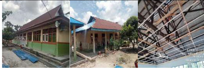
Rehab Gedung E
