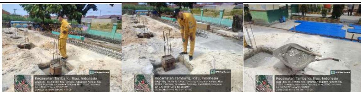
Pembangunan Rkb 2 Lokal
