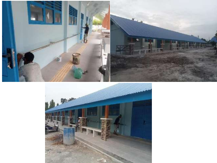
Pembangunan Rkb 5 Lokal
