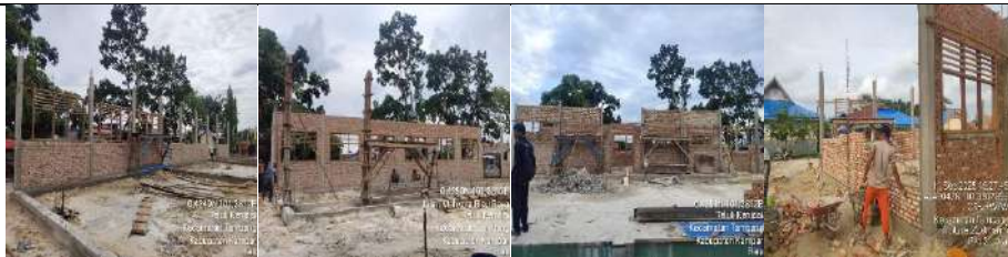
Pembangunan Rkb 2 Lokal
