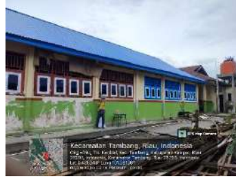
Rehab Gedung C
