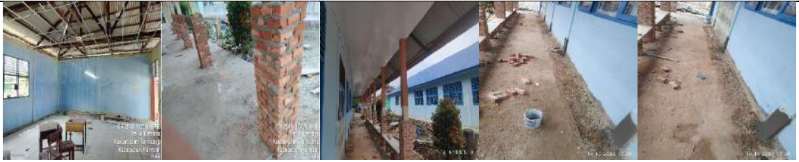
Rehab Gedung A
