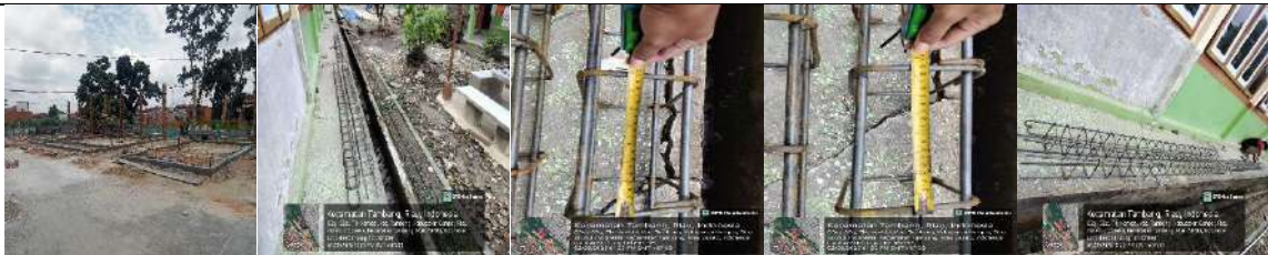
Pembangunan Rkb 2 Lokal
