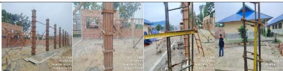
Pembangunan Rkb 5 Lokal
