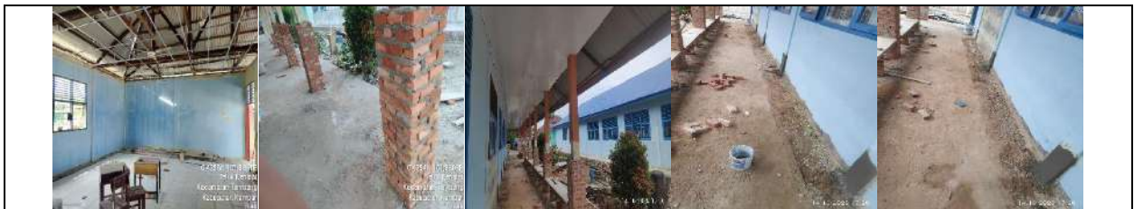
Rehab Gedung A
