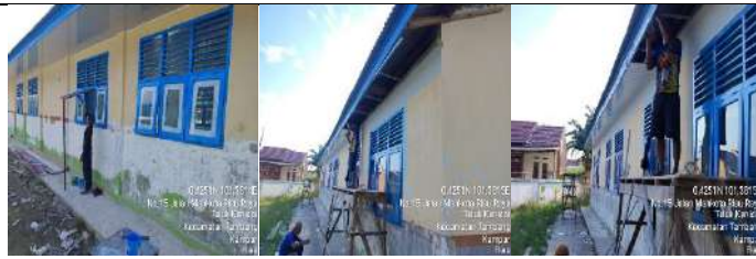
Rehab Gedung F
