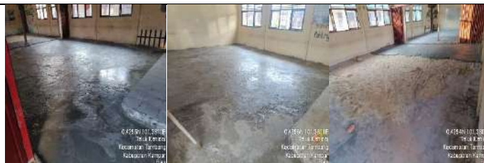
Rehab Gedung A
