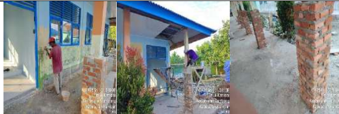
Rehab Gedung A
