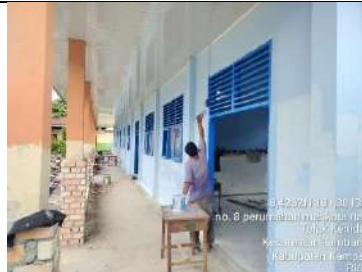
Rehab Gedung D
