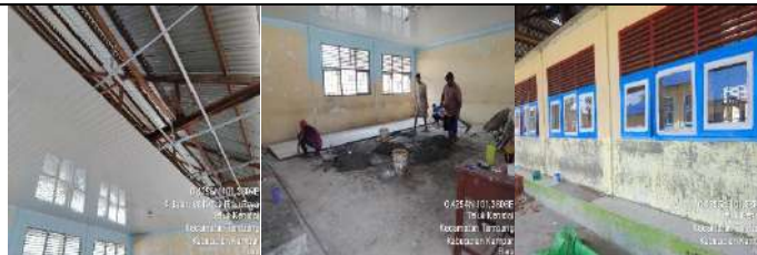
Rehab Gedung A
