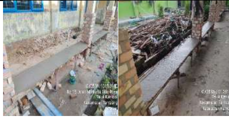
Rehab Gedung D
