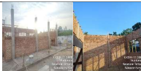
Pembangunan Rkb 5 Lokal
