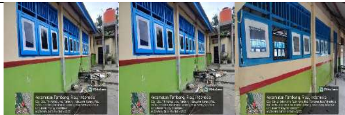
Rehab Gedung C
