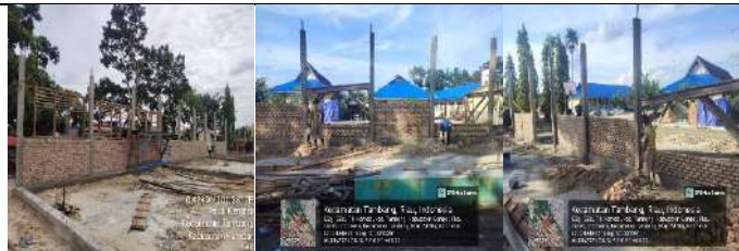
Pembangunan Rkb 2 Lokal
