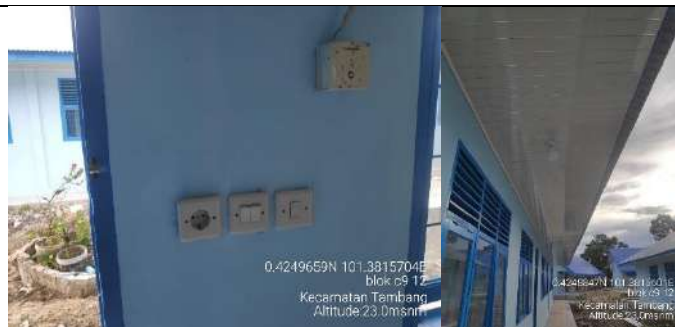
Rehab Gedung F
