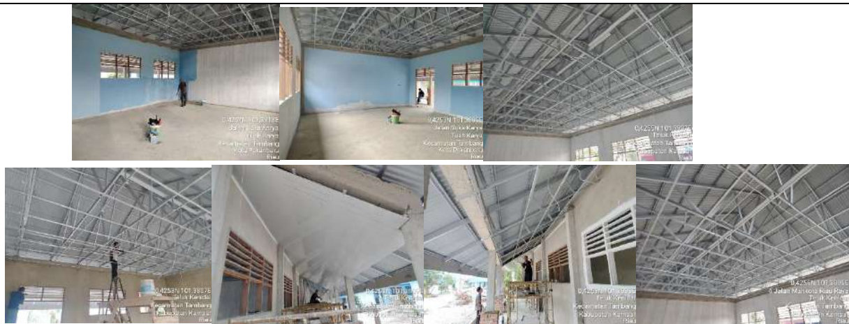
Pembangunan Rkb 5 Lokal
