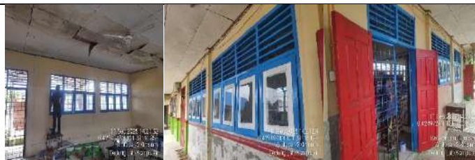
Rehab Gedung Lab. Komputer
