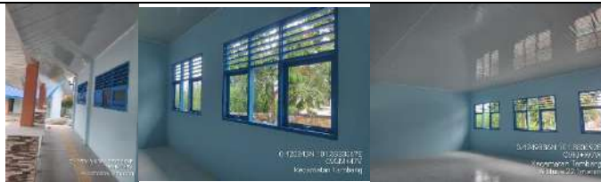
Pembangunan Rkb 2 Lokal
