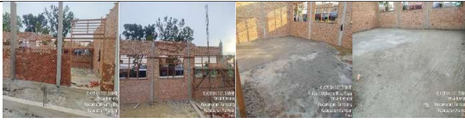
Pembangunan Rkb 5 Lokal
