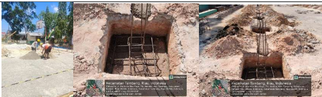
Pembangunan Rkb 2 Lokal
