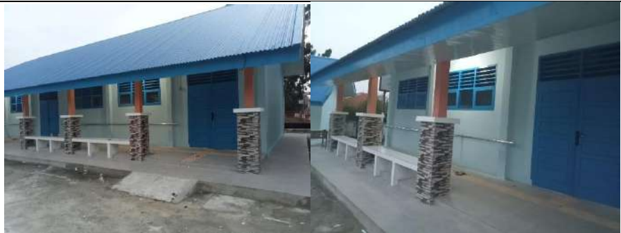
Pembangunan Rkb 2 Lokal
