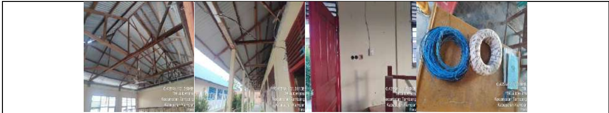
Rehab Gedung A
