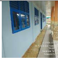
Rehab Gedung E
