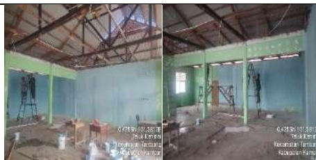
Rehab Gedung Administrasi/R.Guru
