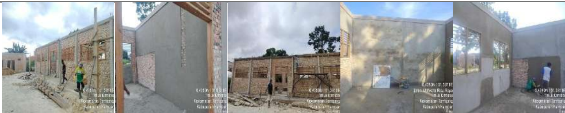
Pembangunan Rkb 2 Lokal
