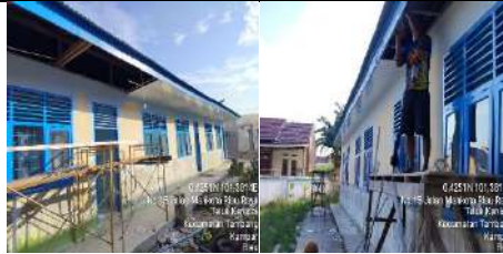
Rehab Gedung F
