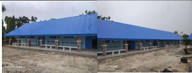
Pembangunan Rkb 5 Lokal
