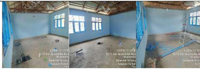
Rehab Gedung D
