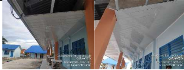
Pembangunan Rkb 2 Lokal
