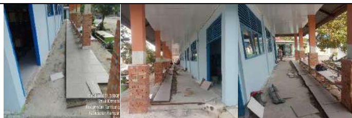
Rehab Gedung B
