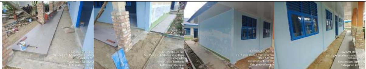
Rehab Gedung E
