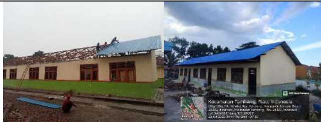
Rehab Gedung F
