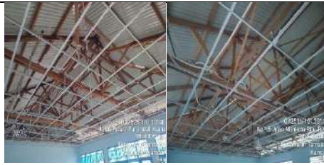
Rehab Gedung C
