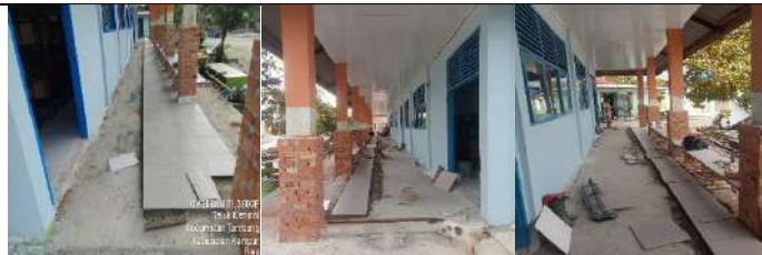
Rehab Gedung B
