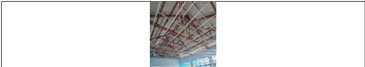
Rehab Gedung C
