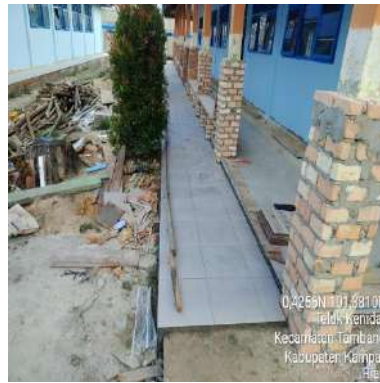
(e) Gedung E
