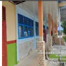
Rehab Gedung Lab.Komputer
