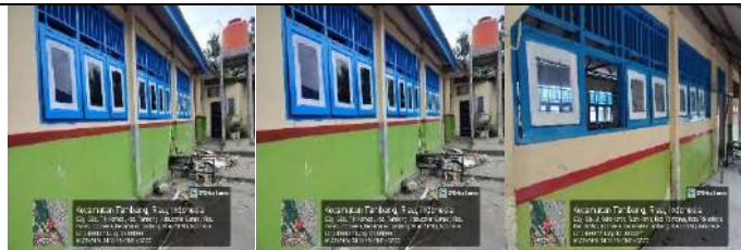
Rehab Gedung C
