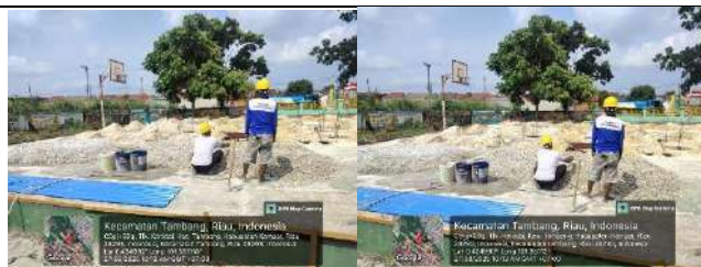
Pembangunan Rkb 2 Lokal
