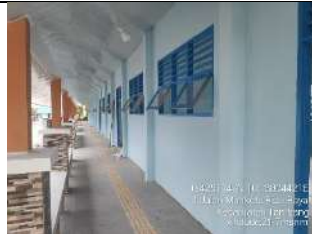
Pembangunan Rkb 5 Lokal
