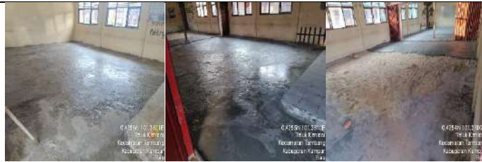
Rehab Gedung B
