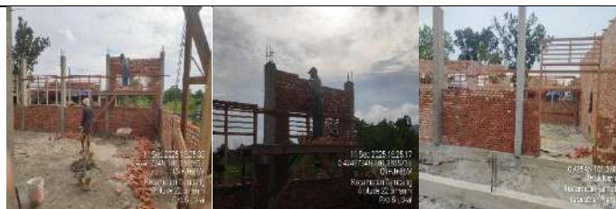
Pembangunan Rkb 5 Lokal
