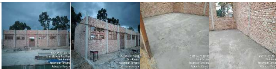
Pembangunan Rkb 2 Lokal
