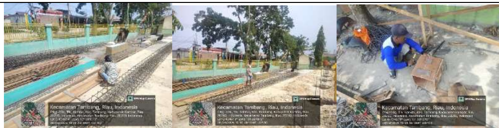
Pembangunan Rkb 2 Lokal
