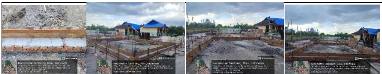
Pembangunan Rkb 5 Lokal
