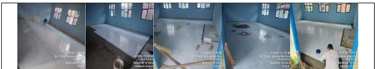
Rehab Gedung D
