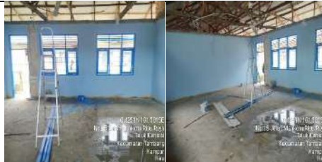
Rehab Gedung F
