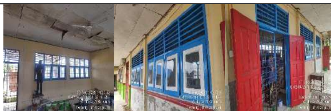
Rehab Gedung Lab. Komputer
