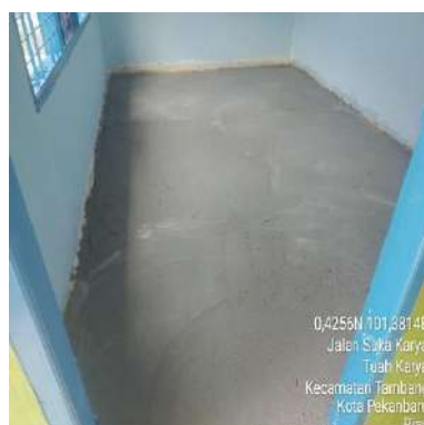
(f) Gedung ADM
