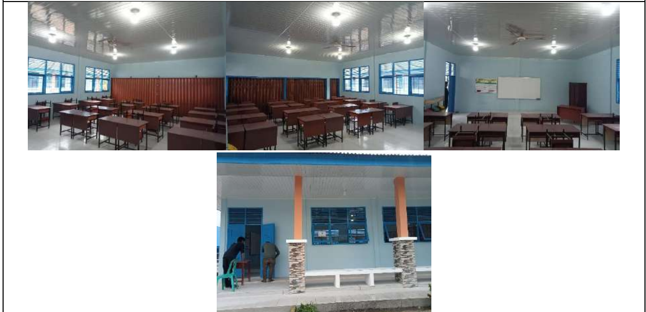
Rehab Gedung B
