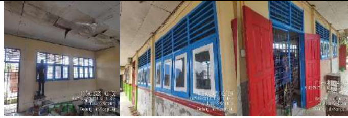
Rehab Gedung Lab.Komputer
