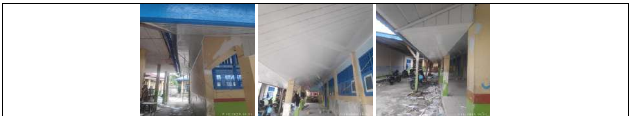
Rehab Gedung C
