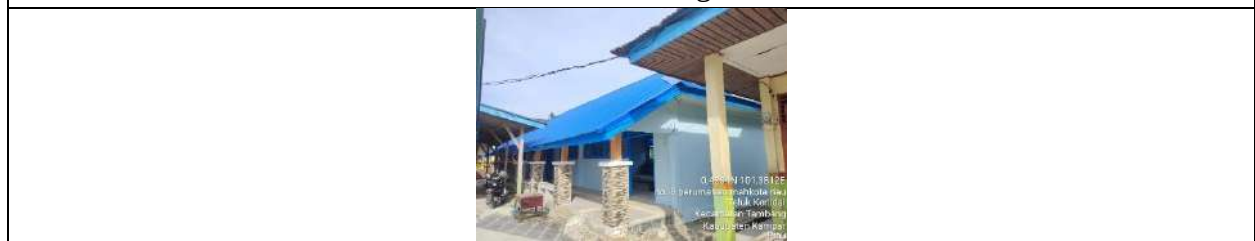
Rehab Gedung C
