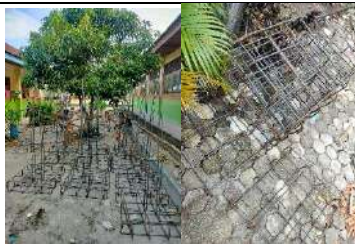
Pembangunan Rkb 2 Lokal
