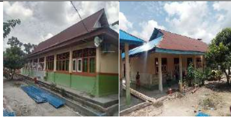
Rehab Gedung E
