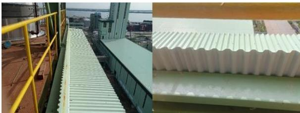
128. (Sabtu, 28 Desember 2024) Pemasangan Sharingan cooling tower dan mengecek lantai Chequered plate yang belum di las.
