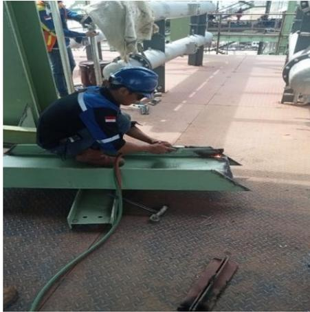
*Gambar 3.3 Pekerjaan pemotongan*
