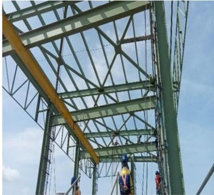
*Gambar 3.13 Pemasangan Bracing dan sagrod*
