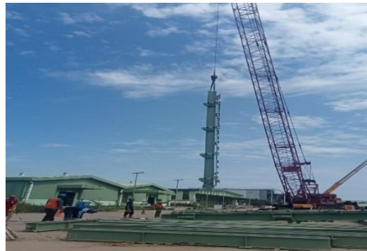
Gambar 3.8 Proses penaikan Sumber : Dokumentasi lapangan, 2024
