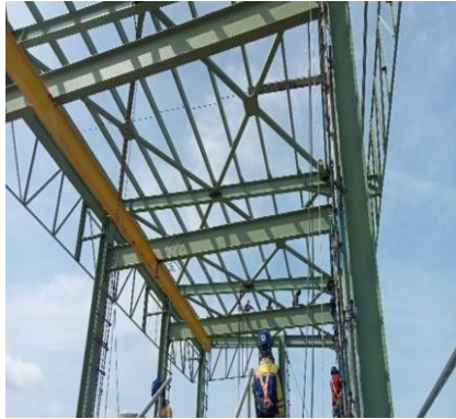
Gambar 3.13 Pemasangan Bracing dan sagrod Sumber : Dokumentasi lapangan, 2024
