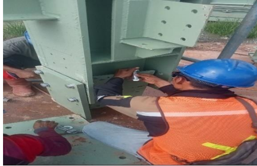
Gambar 3.7 Persiapan peralatan dan material Sumber : Dokumentasi lapangan, 2024
