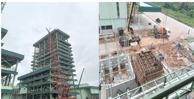
116. (Jum'at, 13 Desember 2024) Erection kanopi dan pengecoran Dinding cooling tower.
