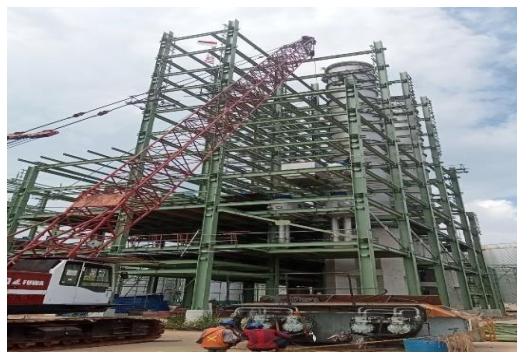
Gambar 3.9 Proses pemasangan Sumber : Dokumentasi lapangan, 2024
