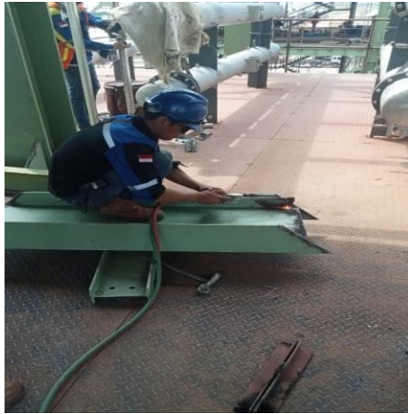
Gambar 3.3 Pekerjaan pemotongan Sumber : Dokumentasi lapangan, 2024
