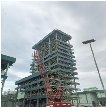
115. (Rabu, 11 Desember 2024) Erection kanopi dan marking atap dan clading fasciah.
