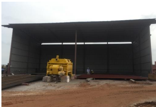
Gambar 2. 11 Chamber Blasting Sumber: Penulis
