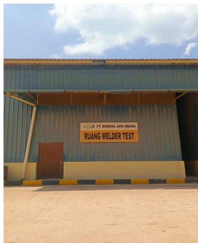
Gambar 2. 13 Welder Test room Sumber: Penulis
