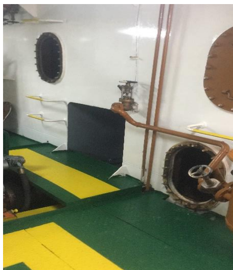
Gambar 3. 28 Pengecekan Pemasangan Pintu Man Hole Sumber: Penulis
