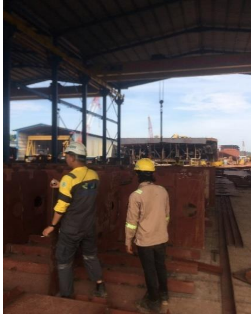
Gambar 3. 35 Visual Welding Inspection Sumber: Penulis
