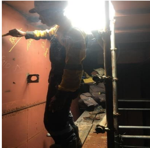
Gambar 3. 37 Visual Welding Inspection Sumber: Penulis
