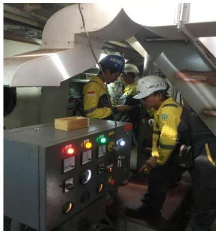
Gambar 3. 6 Load Test Sumber: Penulis
