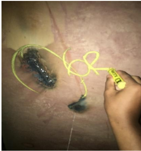
Gambar 3. 33 Visual Welding Inspection Sumber: Penulis
