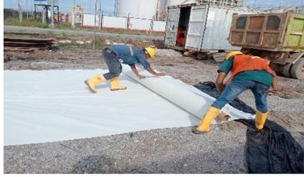
**Gambar 2. 37** *Geotextil*
