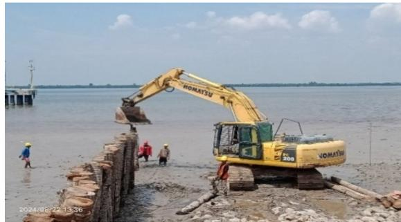
**Gambar 3. 19** Pemancangan Batang Kelapa
