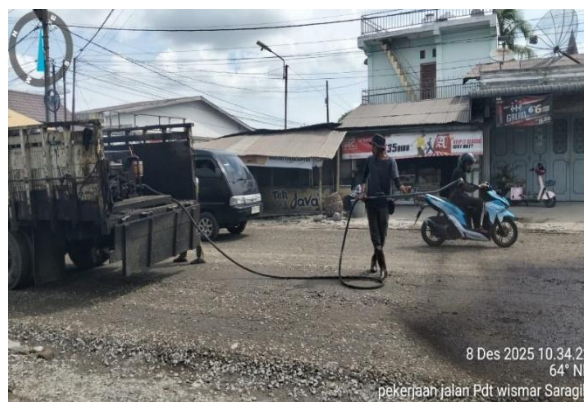
Gambar 3. 24 Pekerjaan Prime Coat Sumber : Dokumentasi lapangan, 2025
