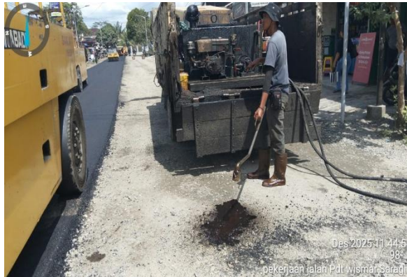
Gambar 3. 12 Aspal spreyer (PTR) Sumber : Dokumentasi lapangan, 2025
