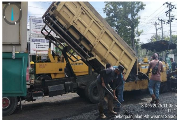
Gambar 3. 26 Pekerjaan penuangan aspal ke alat aspal finisher . Sumber : Dokumentasi lapangan, 2025
