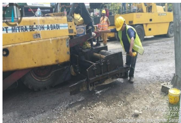
Gambar 3. 25 Pekerjaan Penghamparan Aspal AC-WC Sumber : Dokumentasi lapangan, 2025
