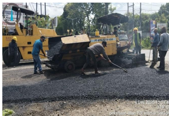
Gambar 3. 27 Pekerjaan Penghamparan Aspal AC-WC Sumber : Dokumentasi lapangan, 2025
