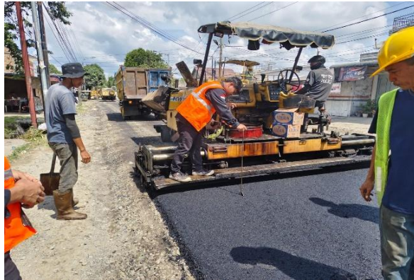
Gambar 3. 28 Pekerjaan pengukuran aspal sebelum dipadatkan. Sumber : Dokumentasi lapangan, 2025
