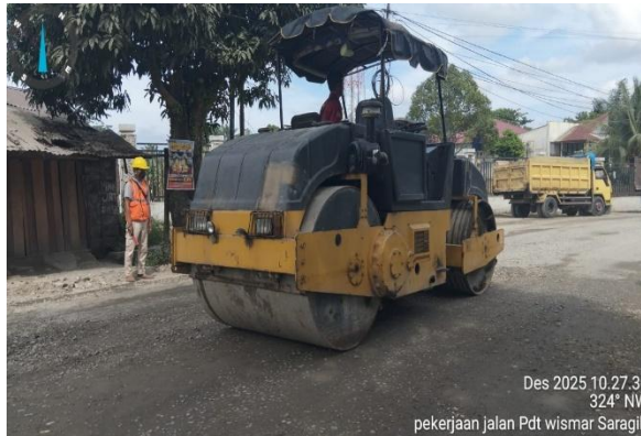
Gambar 3. 10 Tandem roller Sumber : Dokumentasi lapangan, 2025
