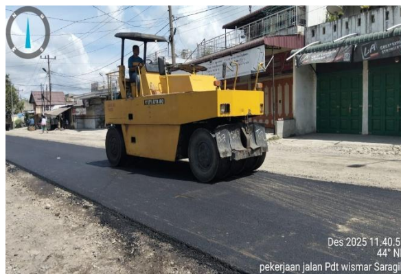
Gambar 3. 30 Pekerjaan pemadatan akhir aspal AC-WC menggunakan Pneumatic Tire roller Sumber : Dokumentasi lapangan, 2025
