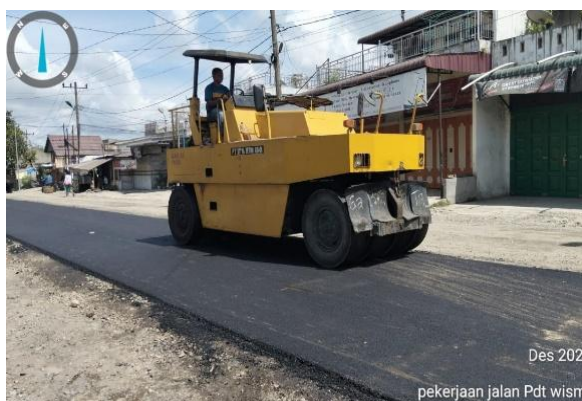
Gambar 3. 11 Pneumatic Tyre Roller (PTR) Sumber : Dokumentasi lapangan, 2025
