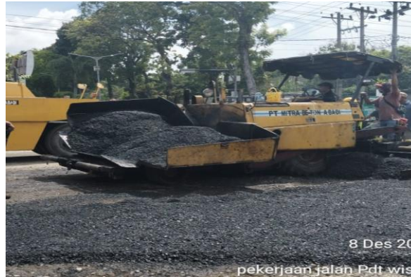
Gambar 3. 20 Aspal AC-WC Sumber : Dokumentasi lapangan, 2025
