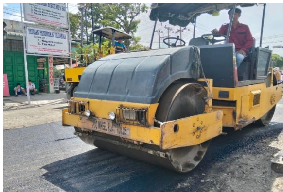
Gambar 3. 29 Pekerjaan Pemadatan awal AC-WC menggunakan tandem roller Sumber : Dokumentasi lapangan, 2025
