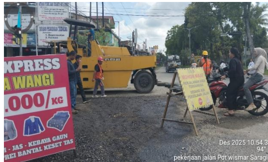
Gambar 3. 31 Penutupan jalur. Sumber : Dokumentasi lapangan, 2025
