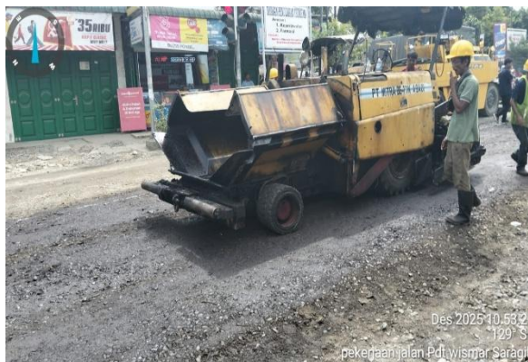
Gambar 3. 9 Aspal finisher Sumber : Dokumentasi lapangan, 2025
