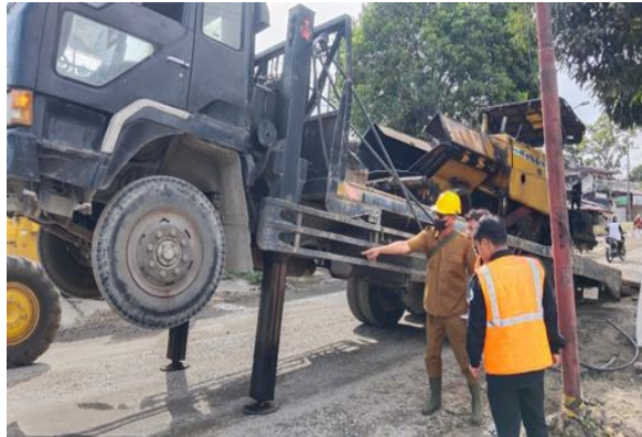
Gambar 3. 22 Aspal finisher Sumber : Dokumentasi lapangan, 2025
