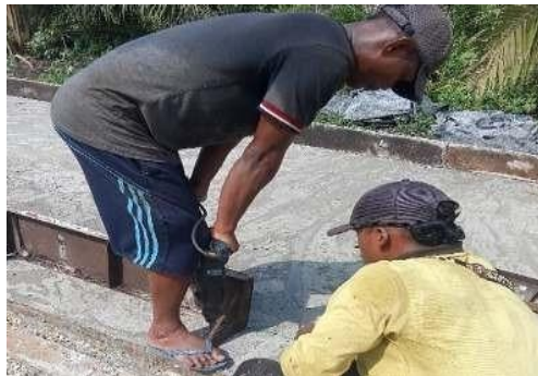
Gambar 3. 13 Pengeboran LC untuk Pemasangan Besi Penahan Bekisting Rigid (sumber : Dokumentasi Lapangan, Kerja Praktek 2024)
