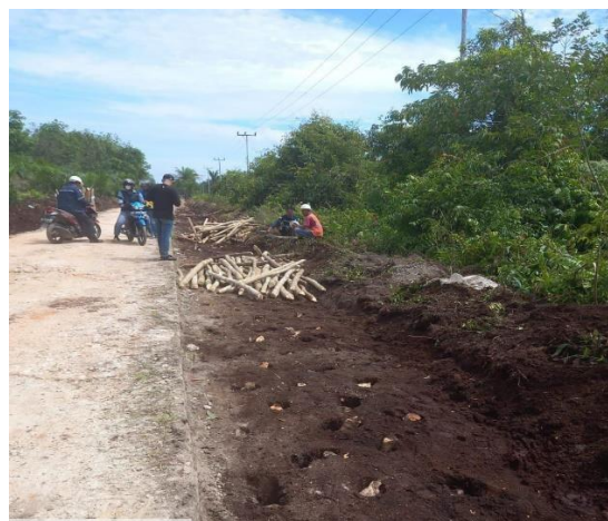
Gambar 3. 1 Pemasangan cerocok (sumber : Dokumentasi Lapangan, Kerja Praktek 2024)
