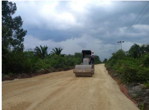
Gambar 3. 5 Pemadatan agregat base B (sumber : Dokumentasi Lapangan, Kerja Praktek 2023)
