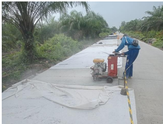
Gambar 3. 24 Pekerjaan Cutting (sumber : Dokumentasi Lapangan, Kerja Praktek 2024)
