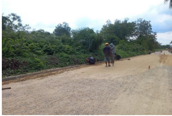
Gambar 3.10 Pemasangan Bekisting LC (sumber : Dokumentasi Lapangan, Kerja Praktek 2024)
