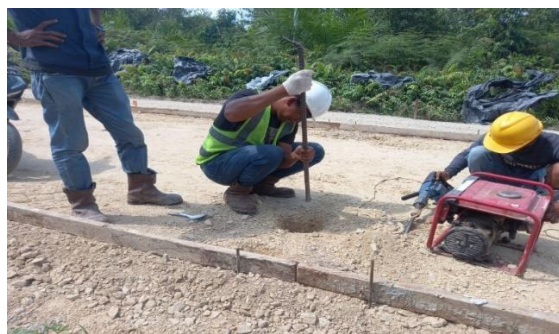
Gambar 4.4 Test Pit Base B (Sumber: Dokumentasi Lapangan 2024)
