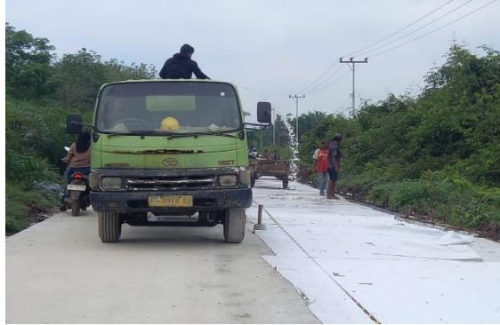
Gambar 3. 23 Pekerjaan Perawatan Beton curing (sumber : Dokumentasi Lapangan, Kerja Praktek 2024)
