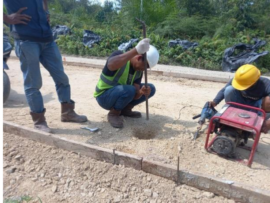
Gambar 3. 7 Penggalian lubang Test Pit Base B (sumber : Dokumentasi Lapangan, Kerja Praktek 2023)
