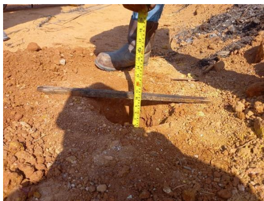
Gambar 3. 6 Pengukuran Test Pit Tanah Timbunan (sumber : Dokumentasi Lapangan, Kerja Praktek 2023)
