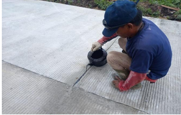
Gambar 3. 25 Pekerjaan Joint Sealent (sumber : Dokumentasi Lapangan, Kerja Praktek 2024)
