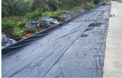
Gambar. 14 Pemasangan Tulangan Dowel & Dudukan Wiremesh (sumber : Dokumentasi Lapangan, Kerja Praktek 2024)
