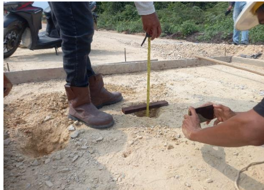
Gambar 3. 8 Pengukuran Test Pit Base B (sumber : Dokumentasi Lapangan, Kerja Praktek 2023)
