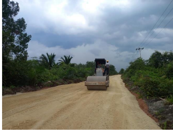
Gambar 4.3 Pemadatan Base B (Sumber: Dokumentasi Lapangan 2024)
