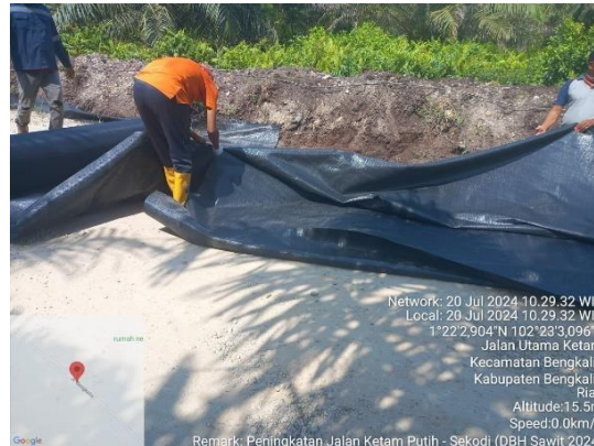
Gambar 3. 2 Pemasangan Geotextile
