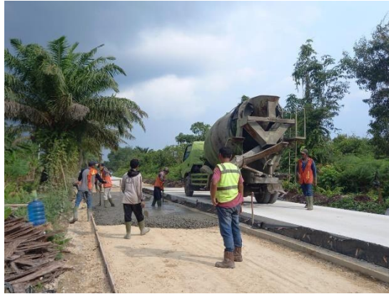
Gambar 3. 12 Pengecoran LC (sumber : Dokumentasi Lapangan, Kerja Praktek 2024)
