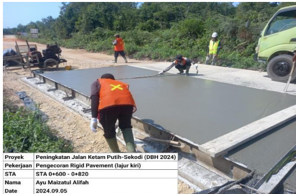
Gambar 3. 20 Finishing (sumber : Dokumentasi Lapangan, Kerja Praktek 2024)
