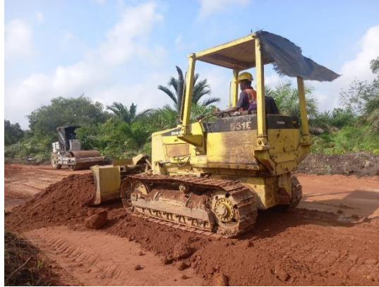
Gambar 3. 3 Penghamparan dan Pemadatan Tanah Urugan Pilihan (sumber : Dokumentasi Lapangan, Kerja Praktek 2024)
