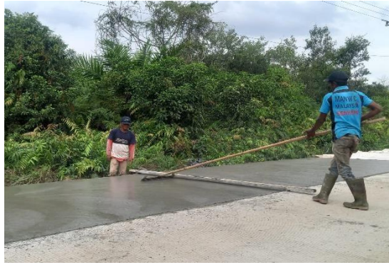
Gambar 3. 21 Pekerjaan Grooving (sumber : Dokumentasi Lapangan, Kerja Praktek 2024)
