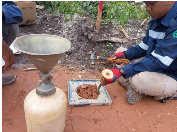
Gambar 3. 9 Pengujian Sand Cone (sumber : Dokumentasi Lapangan, Kerja Praktek 2024)
