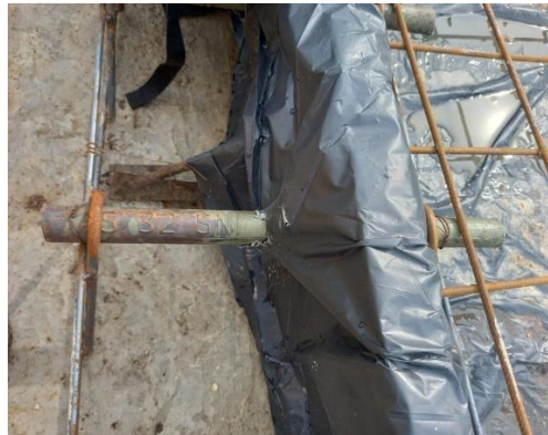
Gambar 3. 15 Pemasangan Tie Bar (sumber : Dokumentasi Lapangan, Kerja Praktek 2024)
