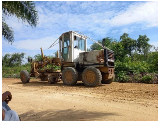
Gambar 3. 4 Perataan agregat base B (sumber : Dokumentasi Lapangan, Kerja Praktek 2024)
