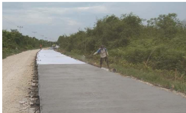
Gambar 3. 22 Pekerjaan Curing Compound (sumber : Dokumentasi Lapangan, Kerja Praktek 2024)
