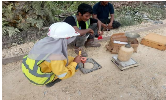
Gambar 4.5 Pengujian Kepadatan Base B (Sumber: Dokumentasi Lapangan 2024)
