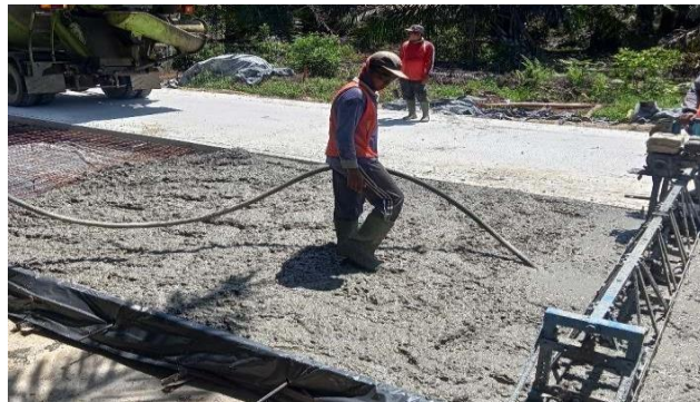
Gambar 3. 18 Pemadatan Beton Menggunakan Vibrator (sumber : Dokumentasi Lapangan, Kerja Praktek 2024)
