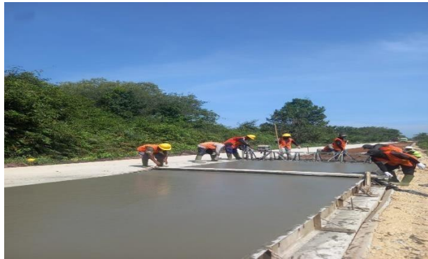
Gambar 3. 17 Pengecoran Rigid (sumber : Dokumentasi Lapangan, Kerja Praktek 2024)
