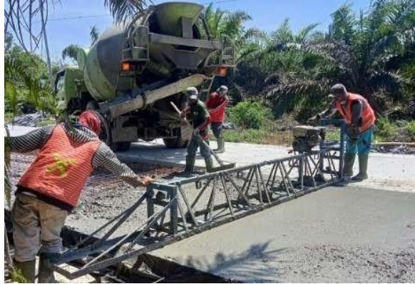
Gambar 3. 19 Meratakan Permukaan Beton (sumber : Dokumentasi Lapangan, Kerja Praktek 2024)
