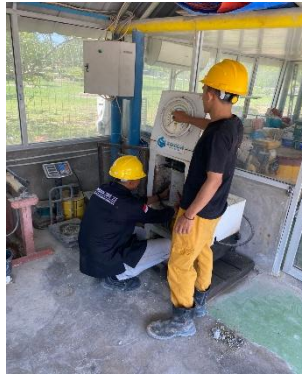
Gambar 3.4. Pengujian Sampel Beton
