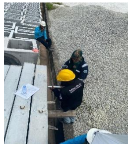
Gambar 3.7. Pengujian Hammer Test
