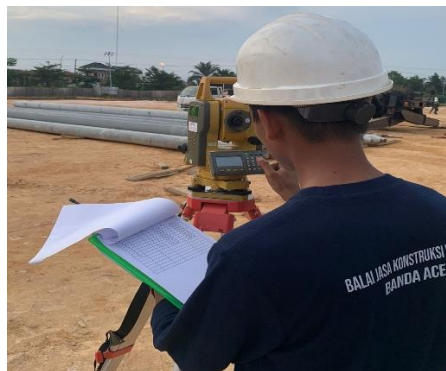
Gambar 3. 39 Pengukuran titik koordinat tiang pancang
