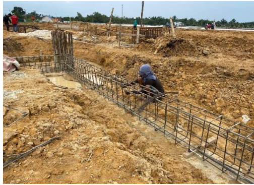
Gambar 3. 50 Pengecoran pondasi setempat
