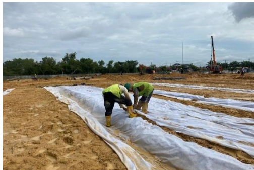
Gambar 3. 10 Pekerjaan lapisan geotextile non woven 150gr/m 2
