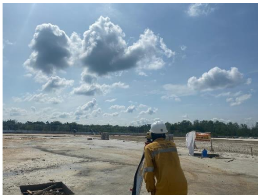
Gambar 3. 31 Pengukuran elevasi ketebalan aspal
