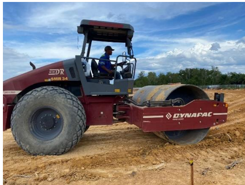
Gambar 3. 4 Pemadatan tanah timbun
