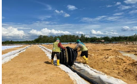
Gambar 3. 11 Pekerjaan instalasi pipa HDPE Dia. 4 cm
