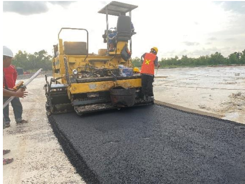
Gambar 3. 33 Pengelaran aspal AC-WC
