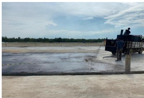
Gambar 3. 32 Pengawasan pekerjaan prime coat (Sumber : Dokumentasi Pribadi, 2024)
