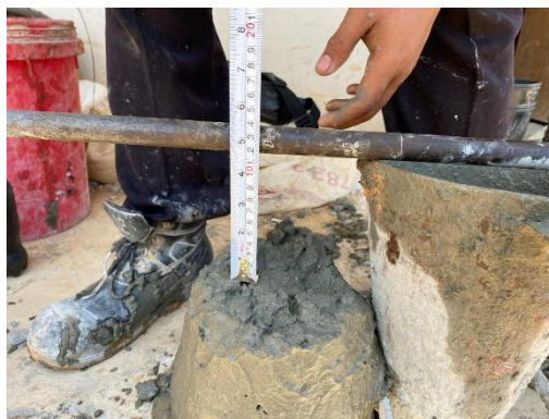
Gambar 3. 52 Pengujian slump beton sloof
