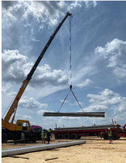
Gambar 3. 38 Pengadaan tiang pancang Spun pile
