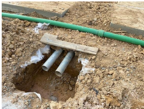
Gambar 3. 21 Pekerjaan cable trench
