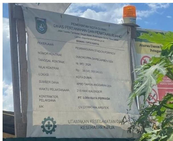
Gambar 2. 5 Papan nama proyek
