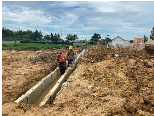
Gambar 3. 8 Pemasangan U-ditch
