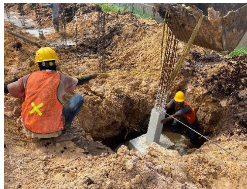
Gambar 3. 55 Pemasangan pondasi setempat dan kolom pedestal
