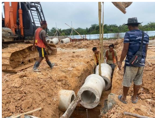
Gambar 3. 17 Pekerjaan pemasangan buis beton RCP 40 cm
