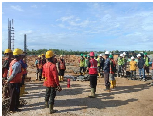
Gambar 3. 1 TBM Proyek Stadion
