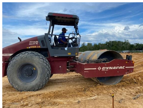
Gambar 3. 26 Pemadatan tanah
