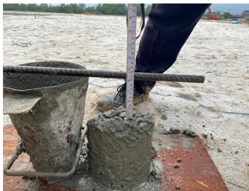
Gambar 3. 56 Pengujian slump beton
