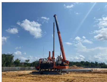
Gambar 3. 41 Pemancangan tiang pancang
