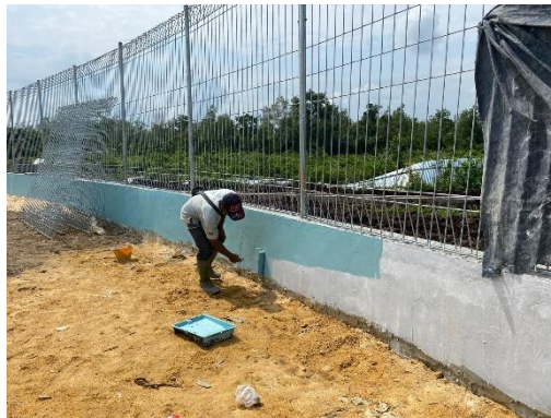
Gambar 3. 60 Pengecatan dinding beton
