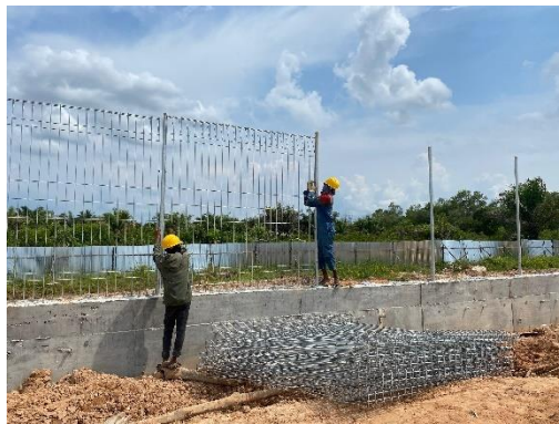
Gambar 3. 58 Pemasangan pagar type-b BRC
