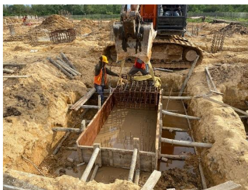
Gambar 3. 46 Pekerjaan pondasi tapak pile cap
