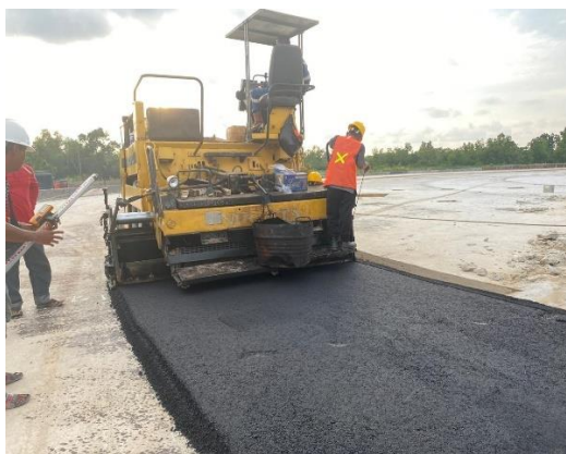
Gambar 3. 96 Pekerjaan penghamparan aspal
