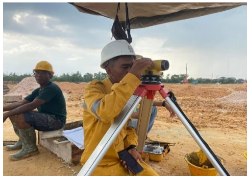
Gambar 3. 51 Pengukuran elevasi top cor beton sloof
