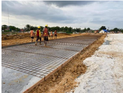
Gambar 3. 28 Pemasangan besi wiremesh m8
