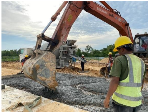
Gambar 3. 30 Pengecoran landasan lintasan atletik K-225
