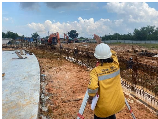
Gambar 3. 7 Pengukuran U-ditch
