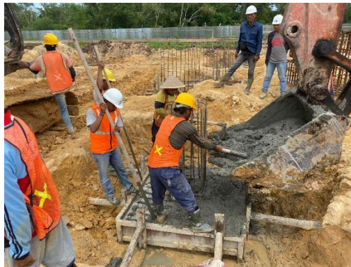
Gambar 3. 49 Pengecoran pondasi setempat
