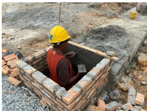
Gambar 3. 20 Pekerjaan bak kontrol
