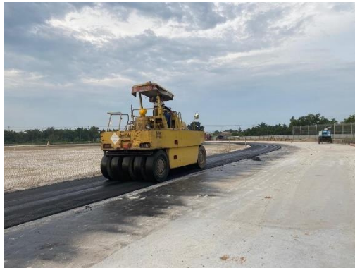
Gambar 3. 34 Pengilasan lapisan aspal AC-WC
