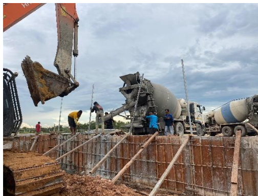
Gambar 3. 57 Pengecoran dinding
