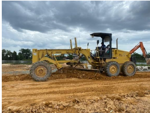
Gambar 3. 3 Perataan tanah
