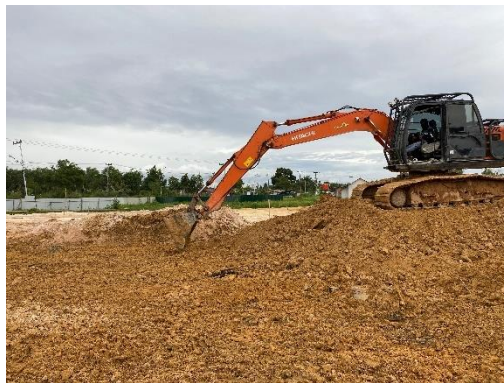
Gambar 3. 2 Pengurugan tanah timbun
