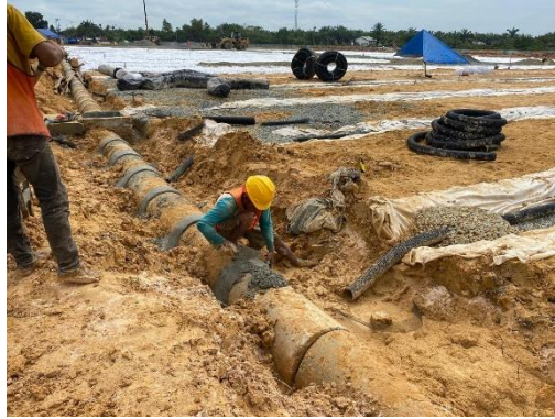
Gambar 3. 16 Pemasangan buis beton diameter 30 cm
