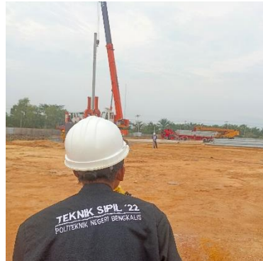
Gambar 3. 40 Pengukuran elevasi top pancang spun pile
