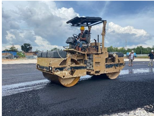
Gambar 3. 35 Pemadatan aspal AC-WC
