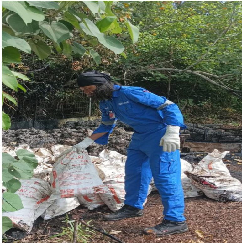
Gambar 3.6 pembersihan sisa kebocoran pipa minyak area marine (Sumber: Dokumentasi Lapangan, 2024)
