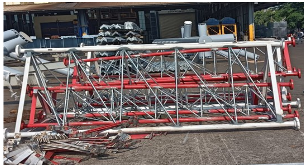
Gambar 3.9 Persiapan painting setelah touch-up (Sumber, Dokumentasi Lapangan, 2024)
