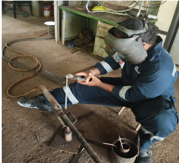
Gambar 3.2 Pengelasan pipa (Sumber: Dokumentasi Lapangan, 2024)
