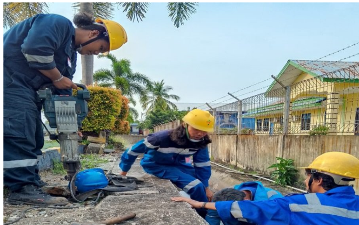
Gambar 3.5 penggantian line pipa air 2 inch (Sumber: Dokumentasi Lapangan, 2024)
