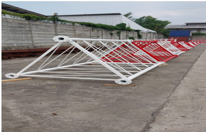
Gambar 3.8 Dilakukan trial assemblyng ulang (Sumber: Dokumentasi Lapangan, 2024)
