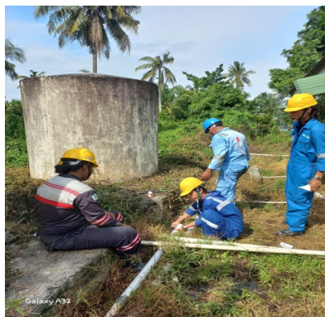
Gambar 3.1 Pemasangan Line Pipa Air (Sumber: Dokumentasi Lapangan, 2024)
