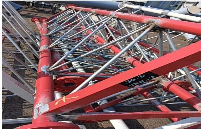
Gambar 3.7 Tower setelah direpair (Sumber: Dokumentasi Lapangan, 2024)
