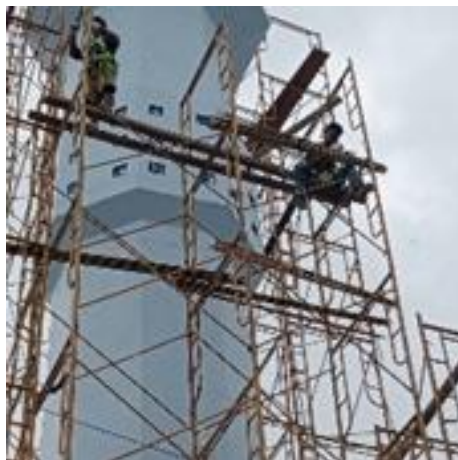
Gambar 3.9 Pemasangan Scaffolding
