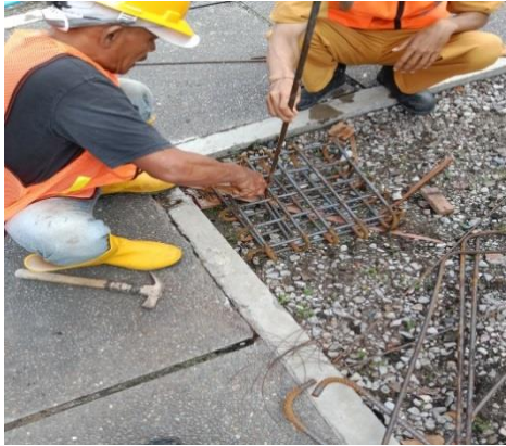
Gambar 3.8 Pembuatan Tulangan Pondasi
