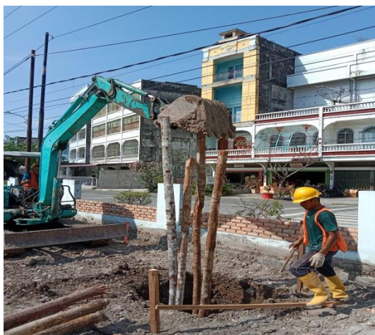
Gambar 3.6 Pemasangan Cerucuk Kayu (Sumber: Dokumentasi Pribadi,2024)
