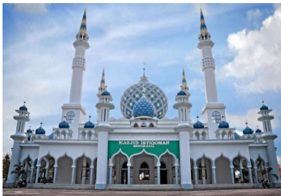
Gambar 2. 6 Visualisasi Sebelum Rehabilitasi (Sumber: Google, 2023)
