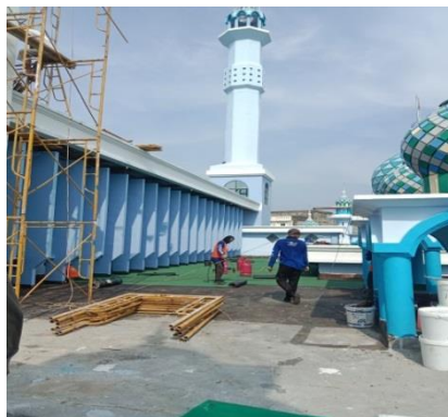
Gambar 3.16 Pelapisan lantai Atap Dengan Membran
