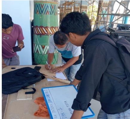
Gambar 3.17 Dokumentasi Pekerjaan Injeksi
