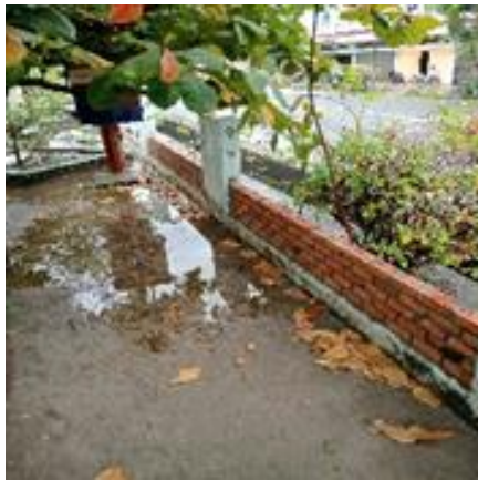
Gambar 3.7 Pemasangan Dinding Bata (Sumber: Dokumentasi Pribadi,2024)
