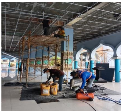
Gambar 3.12 Perbaikan Struktur (Sumber: Dokumentasi Pribadi,2024)
