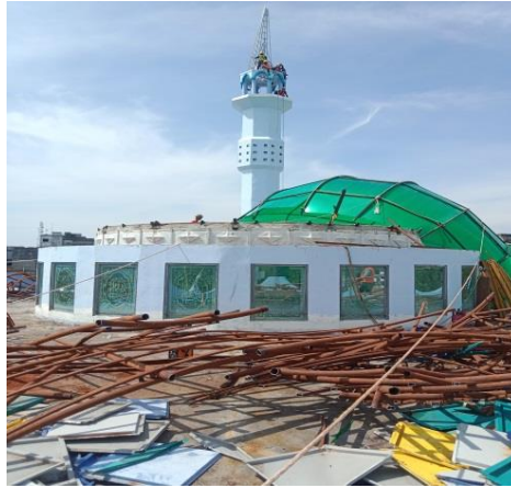
Gambar 3.14 Pembongkaran Kubah (Sumber: Dokumentasi Pribadi,2024)
