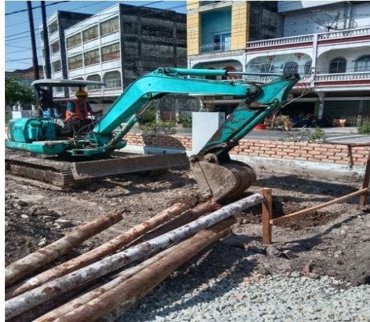
Gambar 3.5 Penggalian Pondasi (Sumber: Dokumentasi Pribadi,2024)
