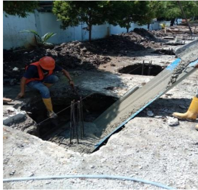
Gambar 3.11 Pengecoran Pondasi Parkiran (Sumber: Dokumentasi Pribadi,2024)
