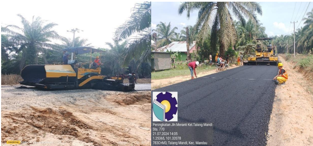
Gambar 3.8 : Pekerjaan Penghamparan Aspal AC-BC
