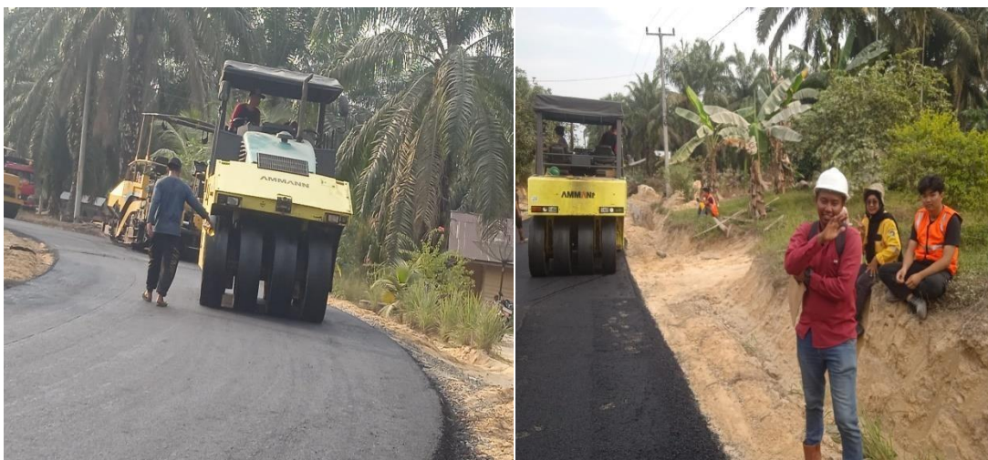
Gambar Pekerjaan Pemadatan Akhir Aspal AC-BC Menggunakan Pneumatic Tire Sumber : Dokumentasi lapangan, 2024
