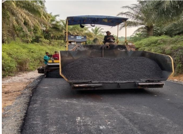
Gambar 3.9: asphalt pinisher Sumber : dokumentasi lapangan,
