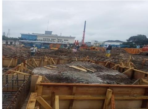
Gambar 3. 22 Pekerjaan Pemasangan Bekisting
