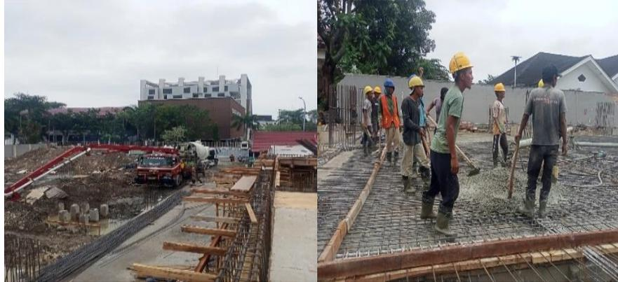
Gambar 3. 28 Pengecoran Lantai
