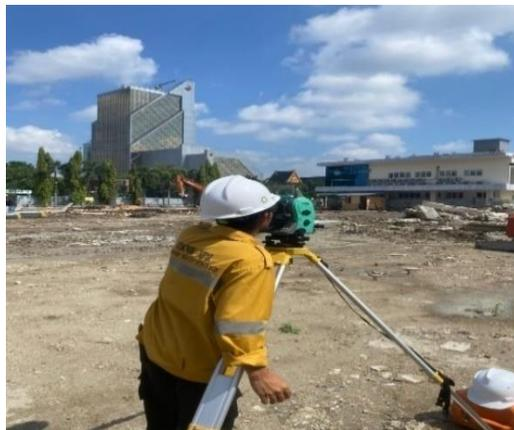
Gambar 3. 6 Penentuan titik Pancang dengan Total Station
