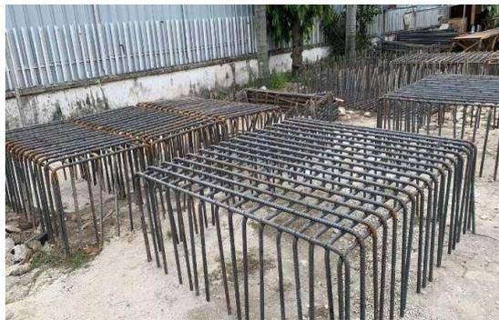
Gambar 3. 8 Perakitan pembesian Pile Cap
