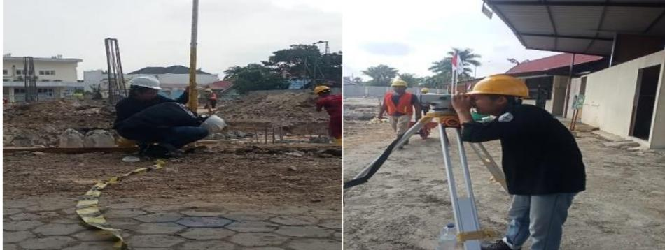
Gambar 3. 11 Pengukuran Dan Pemasangan Bowplank
