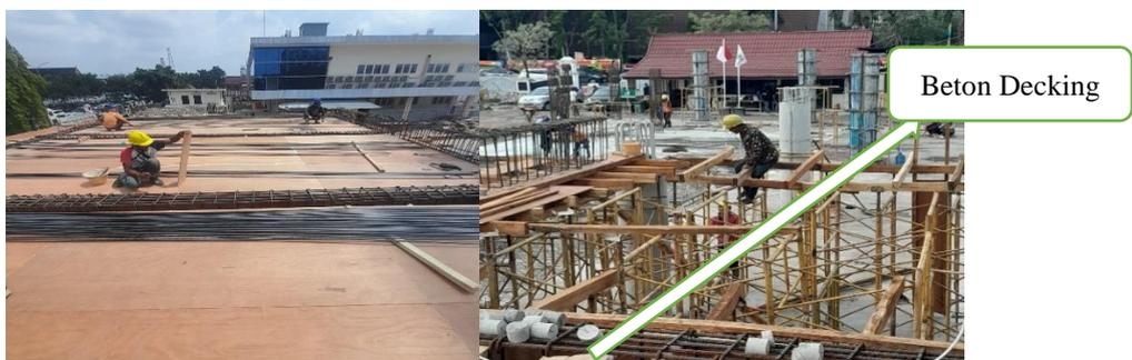
Gambar 3. 35 Pemasangan Dan Penulangan Balok
