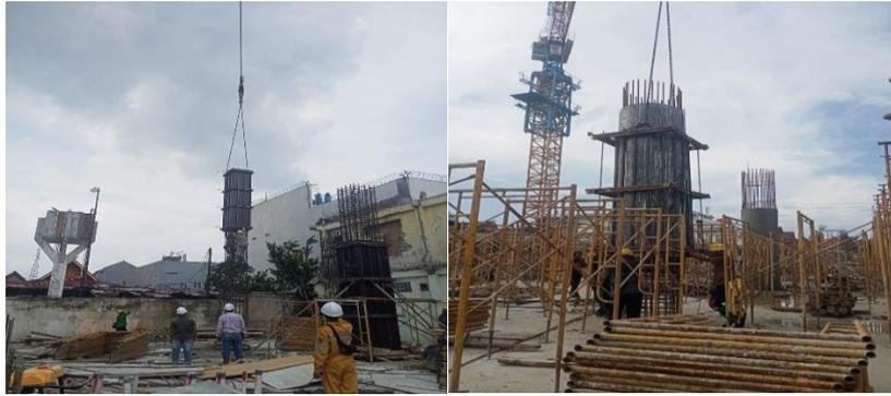
Gambar 3. 33 Pemasangan Bekisting Kolom
