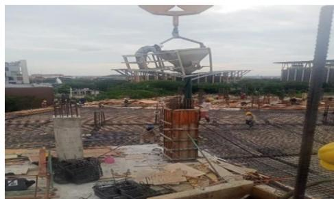
Gambar 3. 34 Pengecoran Kolom
