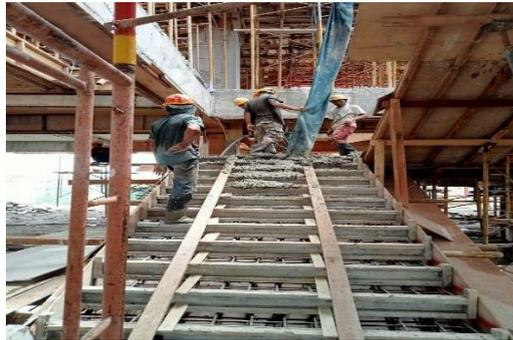
Gambar 3. 44 Pengecoran Tangga
