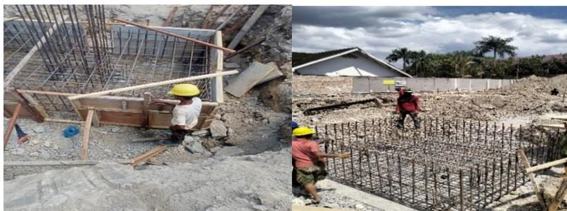
Gambar 3. 14 Penulangan Pile Cap
