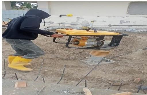
Gambar 3. 24 Pekerjaan Pemadatan Tanah
