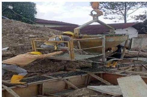
Gambar 3. 23 Pekerjaan Pengecoran Balok Sloff
