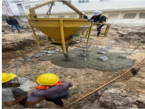
Gambar 3. 13 Pengecoran Lantai Kerja
