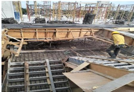
Gambar 3. 41 Pemasangan Bekisting Tangga
