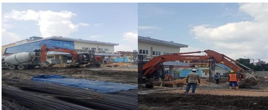
Gambar 3. 26 Pekerjaan Pengecoran Lantai Kerja
