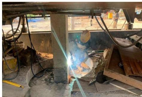
Gambar 3. 8 Pekerjaan Pemancangan dan Penyambungan Pancang
