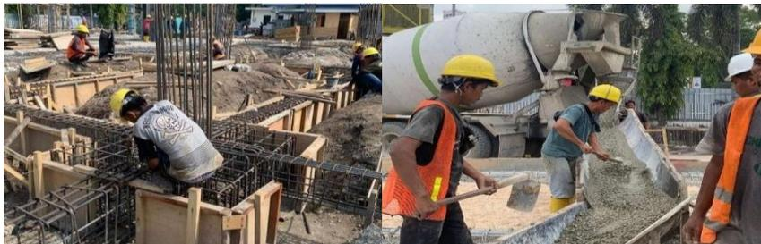
Gambar 3. 16 Penempatan Tulangan dan Pengecoran Pile Cap
