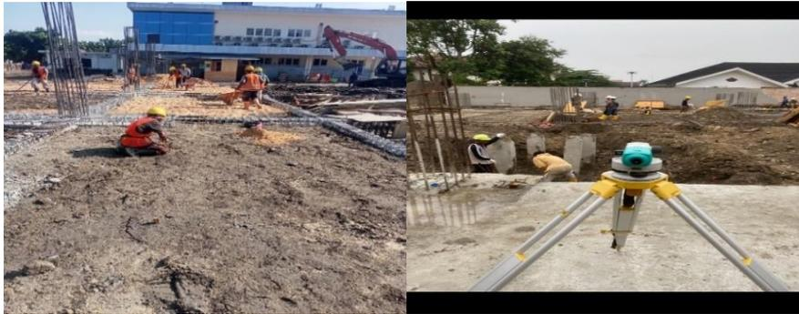
Gambar 3. 25 Pekerjaan Patok Tinggi Lantai Kerja
