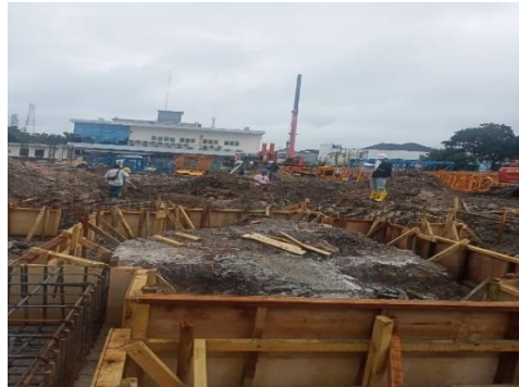
Gambar 3. 22 Pekerjaan Pemasangan Bekisting (Sumber : dokumentasi Lapangan 2024)
