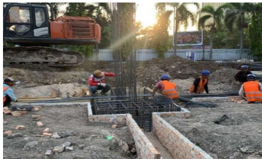
Gambar 3. 18 Pekerjaan Fabrikasi Sloof (Sumber : dokumentasi Lapangan 2024)
