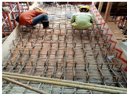
Gambar 3. 43 Pemasangan Besi Tangga (Sumber : dokumentasi Lapangan 2024)
