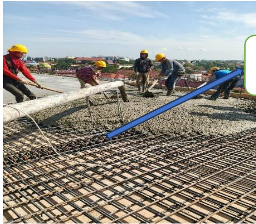
Gambar 3. 37 Pengecoran Balok (Sumber : dokumentasi Lapangan 2024)
