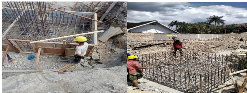
Gambar 3. 14 Penulangan Pile Cap (Sumber : dokumentasi Lapangan 2024)
