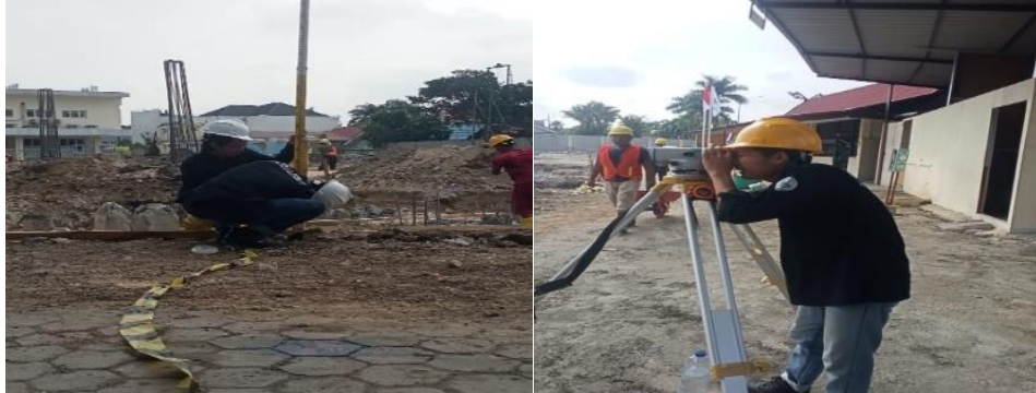
Gambar 3. 11 Pengukuran Dan Pemasangan Bowplank (Sumber : dokumentasi Lapangan 2024)
