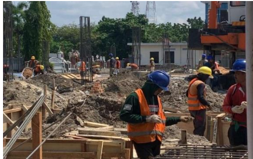
Gambar 3. 3 Helm Safety Pengawas dan Pekerja (Sumber : dokumentasi Lapangan 2024)
