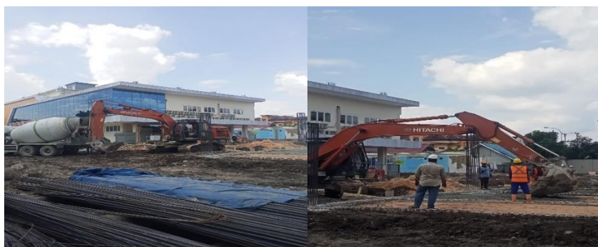
Gambar 3. 26 Pekerjaan Pengecoran Lantai Kerja (Sumber: dokumentasi Lapangan 2024)
