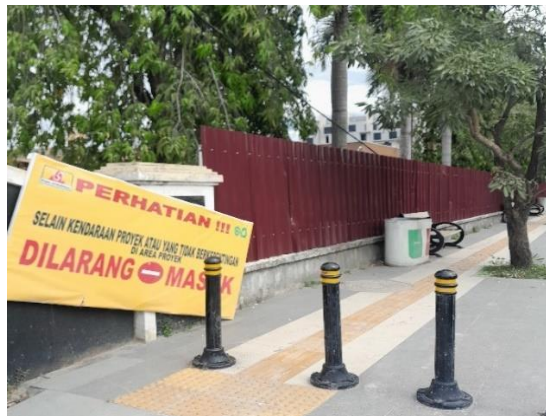
Gambar 3. 5 Pagar Pengaman Proyek (Sumber : dokumentasi Lapangan 2024)
