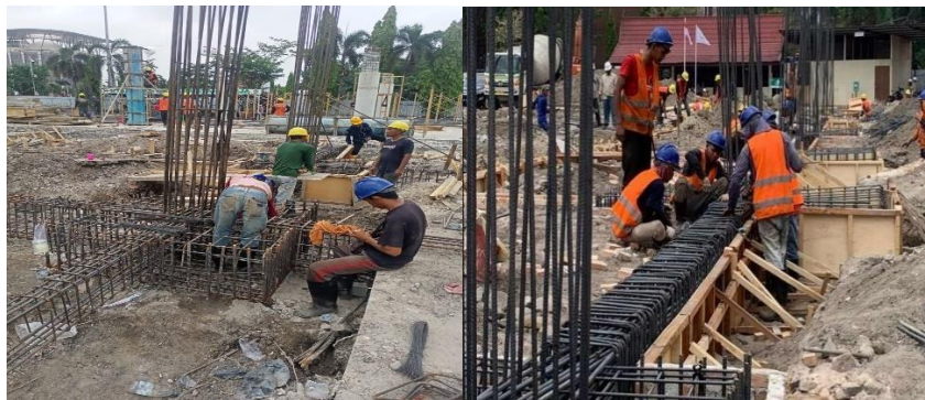
Gambar 3. 21 Pekerjaan Perakitan Tulangan (Sumber : dokumentasi Lapangan 2024)
