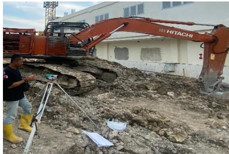
Gambar 2 9 Excavator (Sumber : dokumentasi Lapangan 2024)
