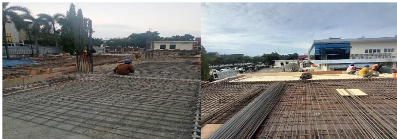
Gambar 3. 27 Pemasangan Wiremesh (Sumber : dokumentasi Lapangan 2024)
