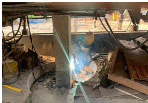
Gambar 3. 8 Pekerjaan Pemancangan dan Penyambungan Pancang (Sumber : dokumentasi Lapangan 2024)
