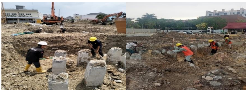
Gambar 3. 11 Pembobokan Tiang Pancang (Sumber : dokumentasi Lapangan 2024)
