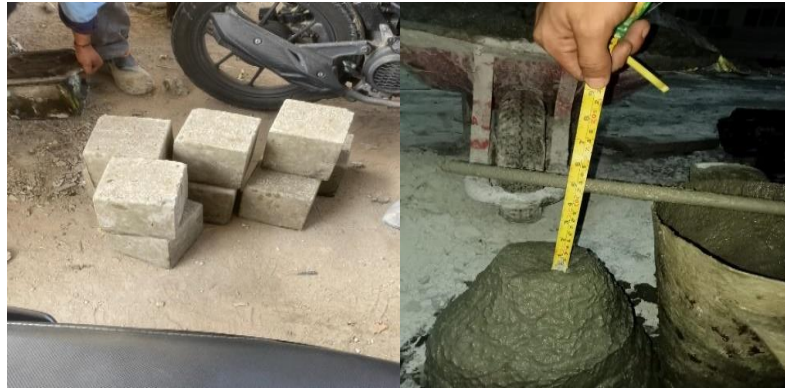
Gambar 3. 17 Pembuatan Sampel Pegujian Dan Uji Slump (Sumber : dokumentasi Lapangan 2024)
