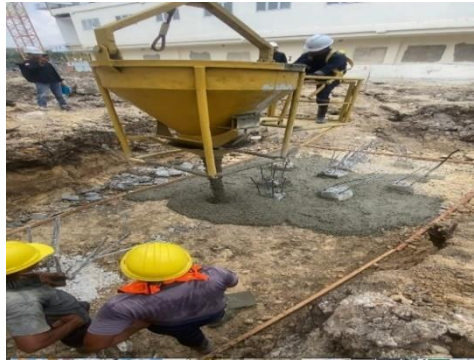
Gambar 3. 13 Pengecoran Lantai Kerja (Sumber : dokumentasi Lapangan 2024)
