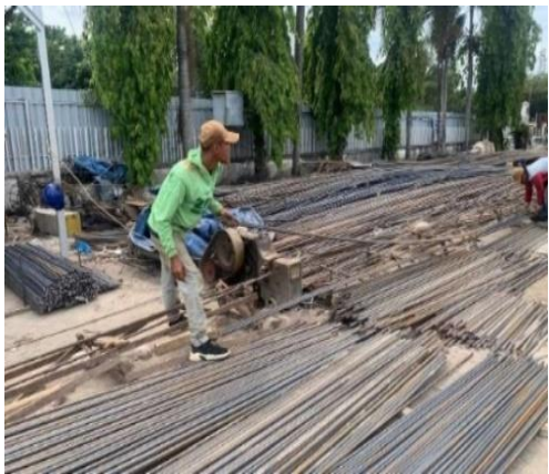
Gambar 3. 29 Fabrikasi Besi (Sumber : dokumentasi Lapangan 2024)
