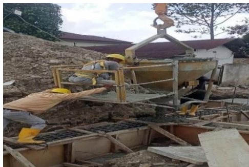
Gambar 3. 23 Pekerjaan Pengecoran Balok Sloff (Sumber : dokumentasi Lapangan 2024)
