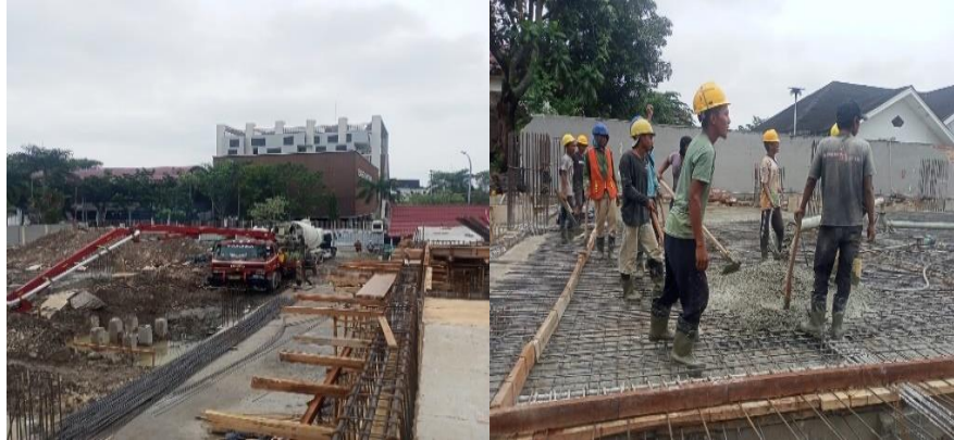
Gambar 3. 28 Pengecoran Lantai (Sumber : dokumentasi Lapangan 2024)
