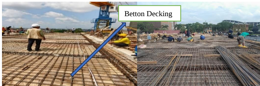
Gambar 3. 39 Pemasangan Tulangan Plat Lantai (Sumber : dokumentasi Lapangan 2024)
