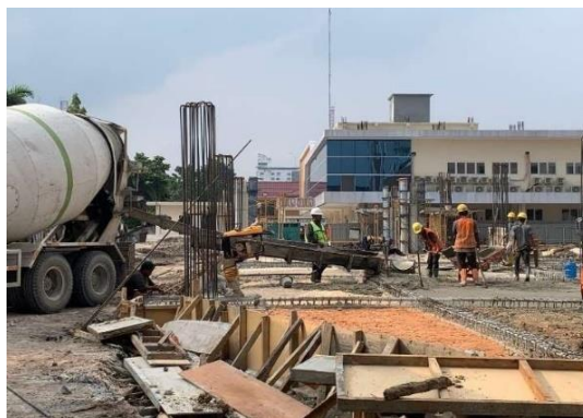
Gambar 2 3 Beton Ready Mix (Sumber : dokumentasi Lapangan 2024)
