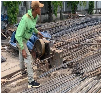
Gambar 2 14 Bar Bender (Sumber : dokumentasi Lapangan 2024)
