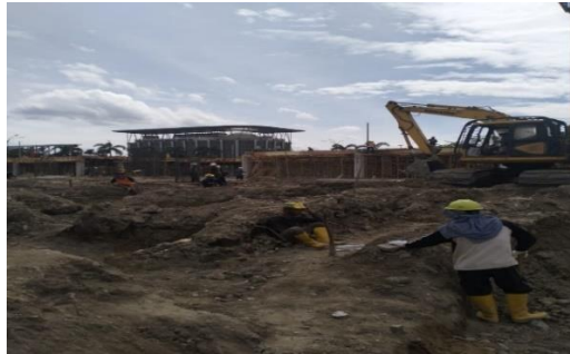
Gambar 3. 19 Pekerjaan Penggalian (Sumber : dokumentasi Lapangan 2024)
