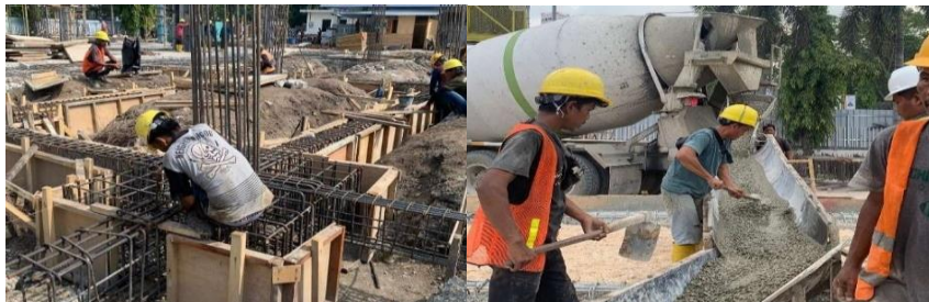
Gambar 3. 16 Penempatan Tulangan dan Pengecoran Pile Cap (Sumber : dokumentasi Lapangan 2024)
