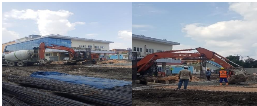
Gambar 3. 26 Pekerjaan Pengecoran Lantai Kerja (Sumber: dokumentasi Lapangan 2024)
