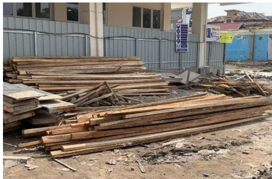
Gambar 2 7 Kayu (Sumber : dokumentasi Lapangan 2024)
