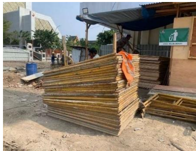
Gambar 2 17 Scaffolding (Sumber : dokumentasi Lapangan 2024)
