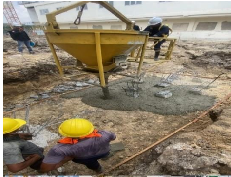
Gambar 3. 13 Pengecoran Lantai Kerja (Sumber : dokumentasi Lapangan 2024)
