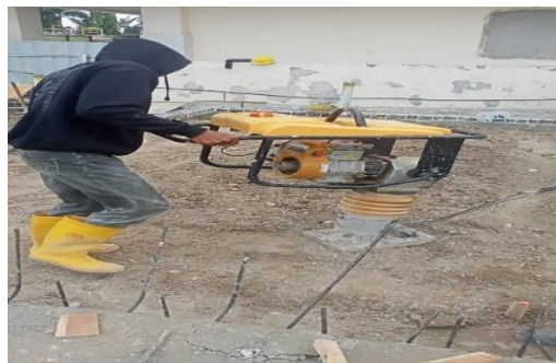
Gambar 3. 24 Pekerjaan Pemadatan Tanah (Sumber : dokumentasi Lapangan 2024)
