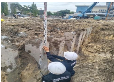
Gambar 3. 10 Pengukuran Elevasi Tiang Pancang (Sumber : dokumentasi Lapangan 2024)
