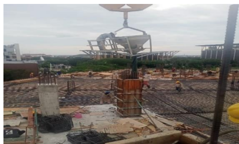
Gambar 3. 34 Pengecoran Kolom (Sumber: dokumentasi Lapangan 2024)
