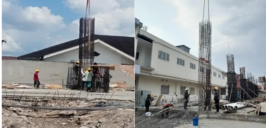
Gambar 3. 32 Pemasangan Tulangan (Sumber : dokumentasi Lapangan 2024)
