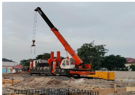
Gambar 2 10 HSPD (Hidrolic Static Pile Driver) (Sumber : dokumentasi Lapangan 2024)
