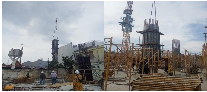
Gambar 3. 33 Pemasangan Bekisting Kolom (Sumber : dokumentasi Lapangan 2024)
