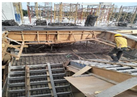
Gambar 3. 41 Pemasangan Bekisting Tangga (Sumber : dokumentasi Lapangan 2024)
