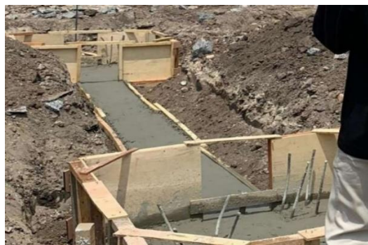
Gambar 3. 20 Pekerjaan Lantai Kerja (Sumber : dokumentasi Lapangan 2024)
