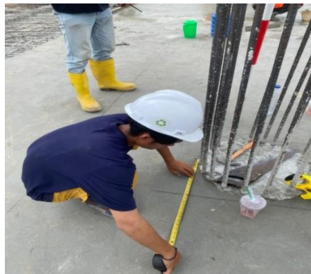
Gambar 3. 31 Pekerjaan Marking (Sumber : dokumentasi Lapangan 2024)
