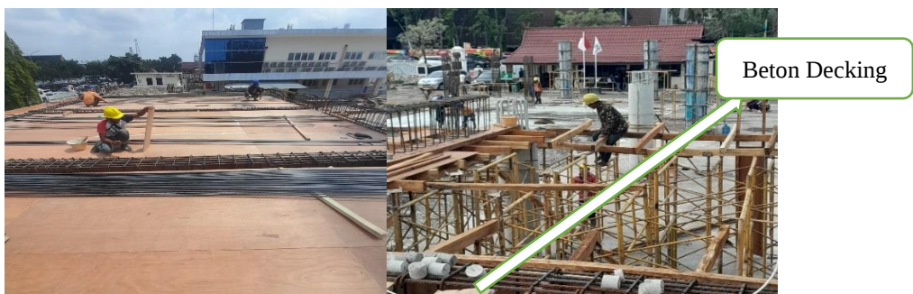
Gambar 3. 35 Pemasangan Dan Penulangan Balok (Sumber : dokumentasi Lapangan 2024)
