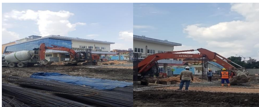
Gambar 3. 26 Pekerjaan Pengecoran Lantai Kerja (Sumber: dokumentasi Lapangan 2024)
