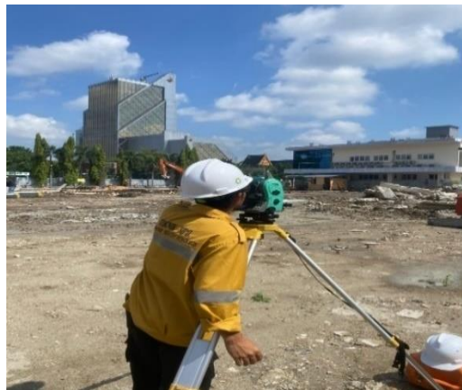
Gambar 3. 6 Penentuan titik Pancang dengan Total Station (Sumber : dokumentasi Lapangan 2024)
