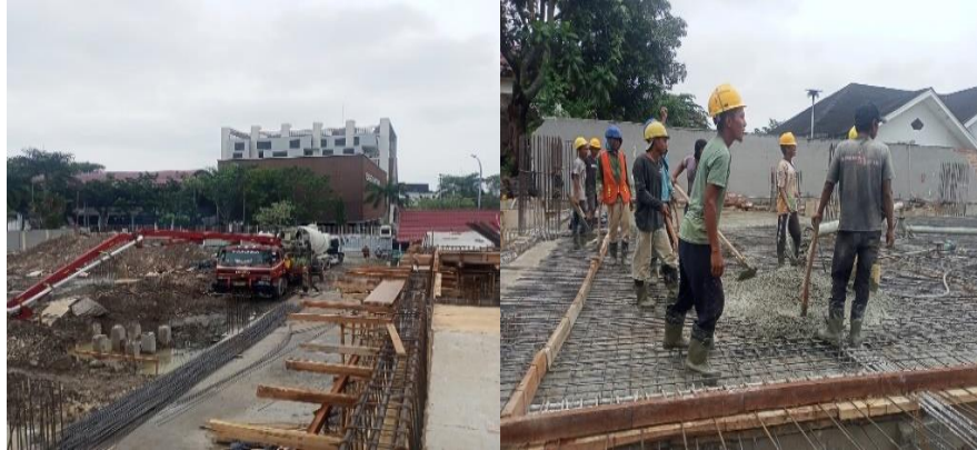
Gambar 3. 28 Pengecoran Lantai (Sumber : dokumentasi Lapangan 2024)
