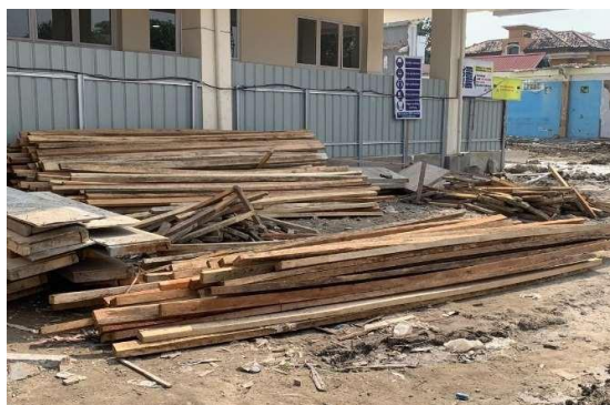
Gambar 2 7 Kayu (Sumber : dokumentasi Lapangan 2024)
