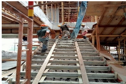
Gambar 3. 44 Pengecoran Tangga (Sumber : dokumentasi Lapangan 2024)
