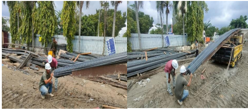
Gambar 2 2 Besi Tulangan (Sumber : dokumentasi Lapangan 2024)
