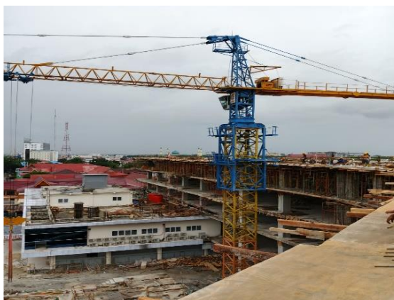
Gambar 2 8 Tower Crane (Sumber : dokumentasi Lapangan 2024)
