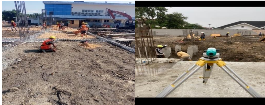
Gambar 3. 25 Pekerjaan Patok Tinggi Lantai Kerja (Sumber : dokumentasi Lapangan 2024)
