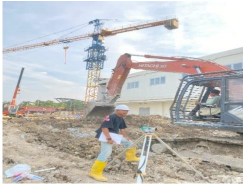
Gambar 3. 9 Penggalan Pile Cap dengan Excavator (Sumber : dokumentasi Lapangan 2024)
