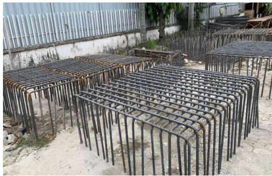
Gambar 3. 8 Perakitan pembesian Pile Cap (Sumber : dokumentasi Lapangan 2024)
