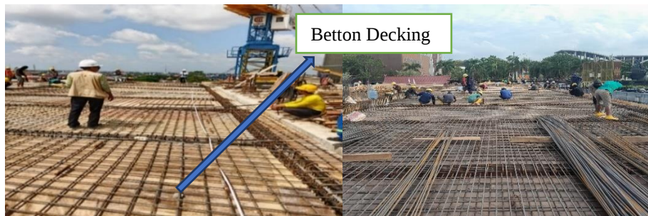
Gambar 3. 39 Pemasangan Tulangan Plat Lantai (Sumber : dokumentasi Lapangan 2024)
