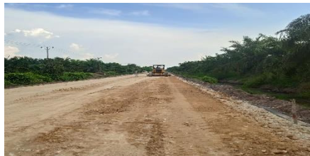
GAMBAR 3. 18 Pekerjaan pemadatan dan perataan agregat kelas B (Sumber) : Dokumen Lapangan, 2024
