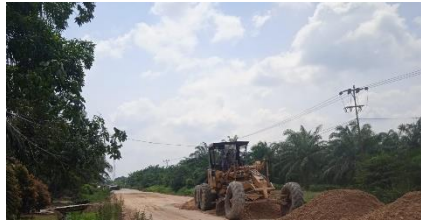
GAMBAR 3. 17 Pekerjaan agregat kelas B (Sumber) : Dokumen Lapangan, 2024
