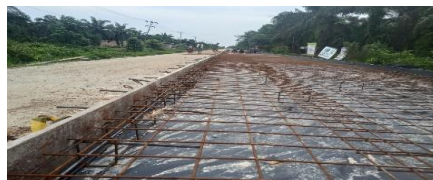
GAMBAR 3. 20 Penyusunan tulangan beton (Sumber) : Dokumen Lapangan, 2024
