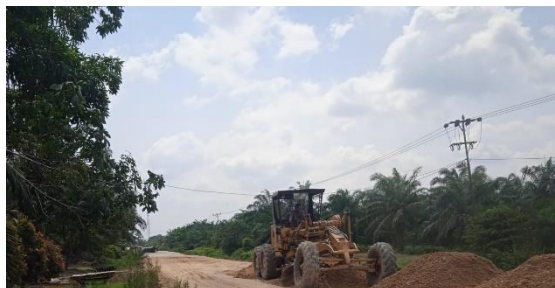
GAMBAR 4. 2 Motor Grader (Sumber) : Dokumen Lapangan, 2024
