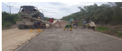
GAMBAR 3. 21 Pengecoran beton (Sumber) : Dokumen Lapangan, 2024
