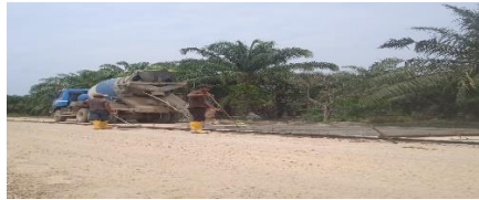
GAMBAR 3. 19 Pekerjaan pemasangan mal lc (Sumber) : Dokumen Lapangan, 2024
