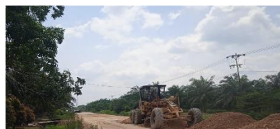
GAMBAR 4. 6 Pengangkutan material (Sumber) : Dokumen Lapangan, 2024
