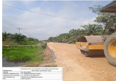
GAMBAR 4. 7 Pekerjaan Pemadatan Base B (Sumber) : Dokumentasi lapangan, 2024
