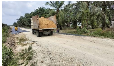
GAMBAR 3. 15 Lapisan pondasi Agregat kelas B (Sumber) : Dokumen Lapangan, 2024
