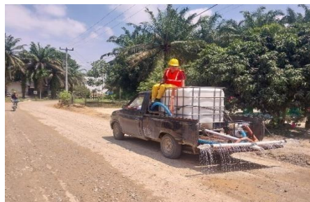
GAMBAR 4. 8 Pekerjaan Penyiraman Base B (Sumber) : Dokumentasi lapangan, 2024
