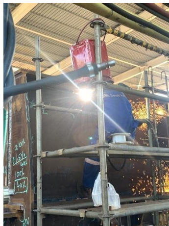
Gambar 110 Pemasangan side plate Sumber : Penulis
