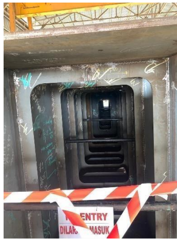
Gambar 111 Pemasangan Stiffener Sumber : Penulis
