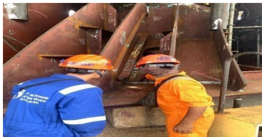
Gambar 10 Mempelajari Sambungan Las FCAW Sumber : Penulis
