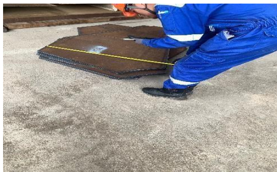
Gambar 85 Aktivitas Pengukuran Material Plat Project Saddle Sumber : Penulis
