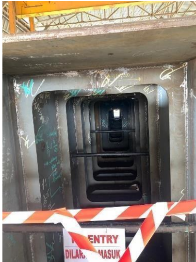
Gambar 113 Pemasangan Stifener Sumber : Penulis
