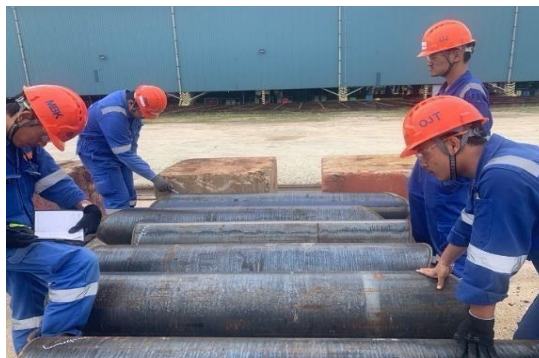
Gambar 94 Aktivitas Marking Material Pipa Sumber : Penulis
