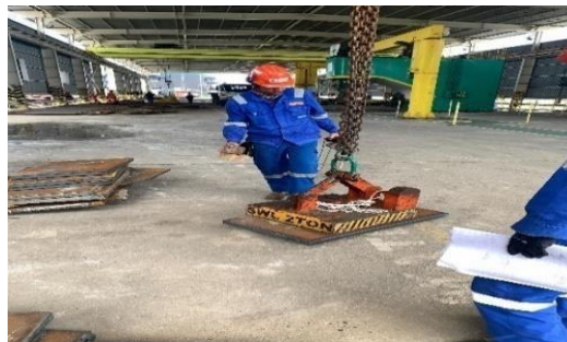
Gambar 61 Proses Pemindahan Menggunakan Oover Head Crane Sumber : Penulis
