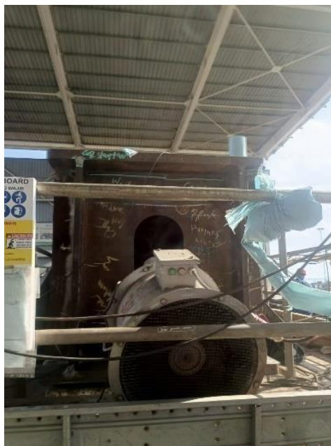
Gambar 112 Pemasangan base plate Sumber : Penulis
