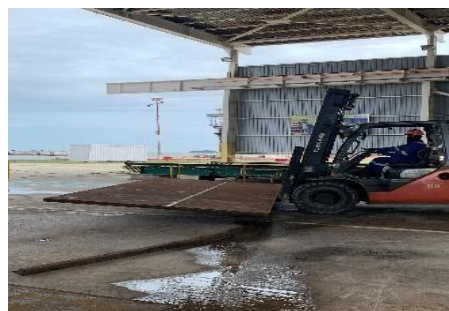
Gambar 79 Proses Pengangkatan Material Sumber : Penulis
