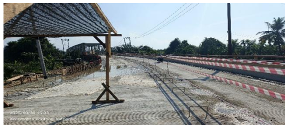
Gambar 3.32 Proses curing Sumber: Dokumentasi Lapangan
