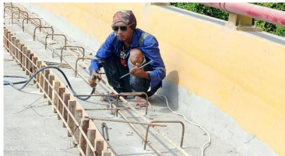
Gambar 3.51 Pemasangan tulangan trotoar Sumber: Dokumentasi Lapangan
