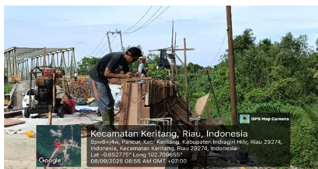
Gambar 3.47 Pemasangan Dudukan atau Angkur Railing Sumber: Dokumentasi Lapangan
