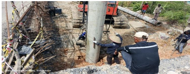
Gambar 3.14 Pemeriksaan kelurusan tiang Sumber: Dokumentasi Lapangan
