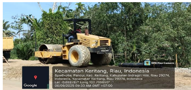
Gambar 3.62 Pemadatan Timbunan Sumber: Dokumentasi Lapangan
