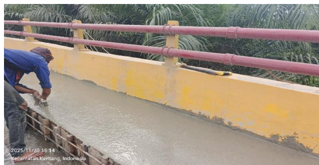
Gambar 3.54 perataan permukaan trotoar Sumber: Dokumentasi Lapangan
