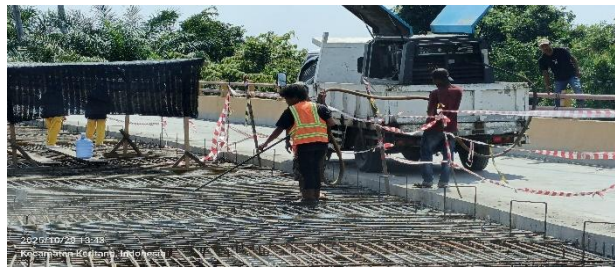
Gambar 3.27 Pembersihan bekisting Sumber: Dokumentasi Lapangan
