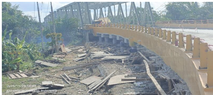
Gambar 3.59 Pembongkaran Bekisting Jembatan Sumber: Dokumentasi Lapangan
