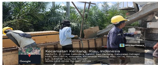
Gambar 3.41 Pengecoran beton parapet Sumber: Dokumentasi Lapangan
