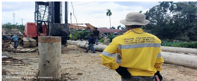
Gambar 3.17 Pencatatan data pemancangan Sumber: Dokumentasi Lapangan
