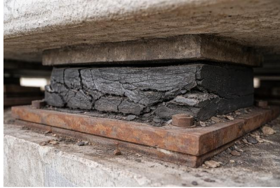
Gambar 3.73 Pelepasan Bearing Pad Lama Sumber: Dokumentasi Lapangan
