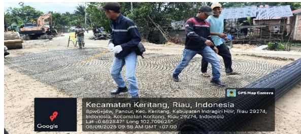
Gambar 3.67 Perbaikan tanah dengan geotek Sumber: Dokumentasi Lapangan
