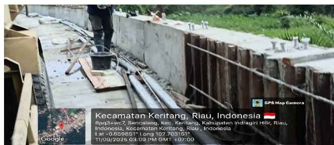
Gambar 3.42 pembongkran bekisting Sumber: Dokumentasi Lapangan
