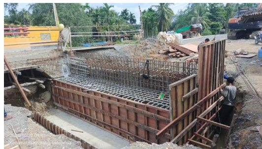
Gambar 3.44 Pemasangan Tulangan Sumber: Dokumentasi Lapangan
