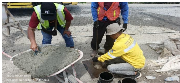
Gambar 3.30 Uji slump di lapangan Sumber: Dokumentasi Lapangan
