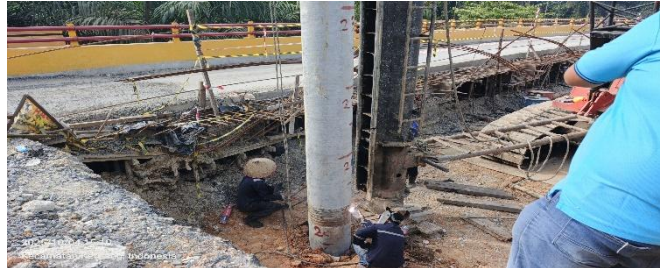
Gambar 3.16 Penyambungan tiang Sumber: Dokumentasi Lapangan
