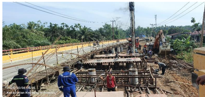
Gambar 3.21 Pembuatan perancah pada (slab dan balok)
