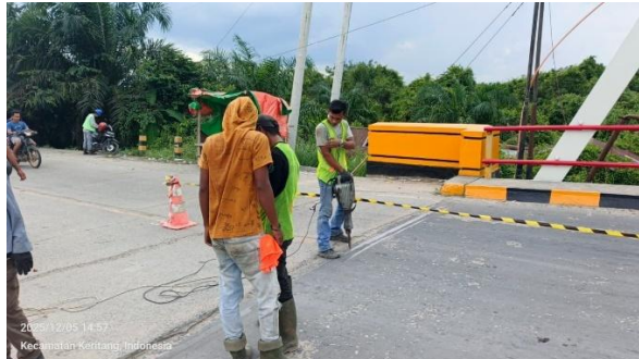
Gambar 3.72 Pembobokan Sambungan Siar Muai Sumber: Dokumentasi Lapangan
