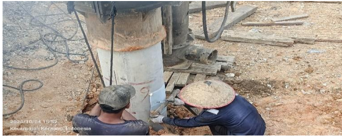
Gambar 3.18 Pengujian kalendring di lapangan Sumber: Dokumentasi Lapangan
