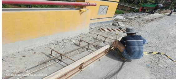
Gambar. 3.50 Pemasangan bekisting trotoar Sumber: Dokumentasi Lapangan
