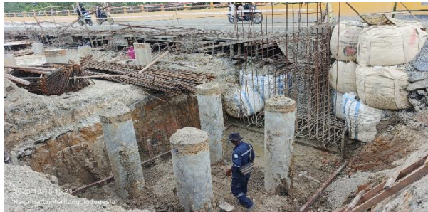
Gambar 3.33 Galian Abutment Sumber: Dokumentasi Lapangan
