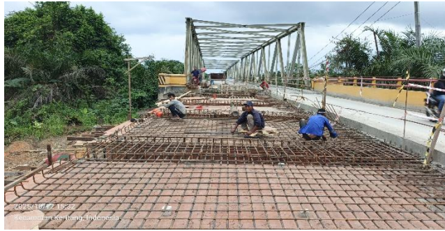
Gambar 3.25 Pemasangan tulangan pada slab
