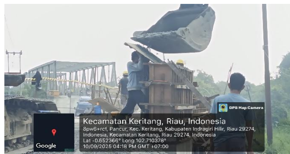
Gambar 3.45 pengecoran loneng Sumber: Dokumentasi Lapangan
