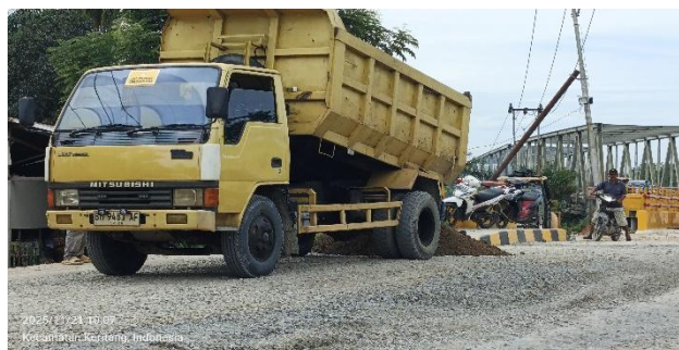
Gambar. 3.63 Penimbunan Ulang (Re-Timbunan) Sumber: Dokumentasi Lapangan
