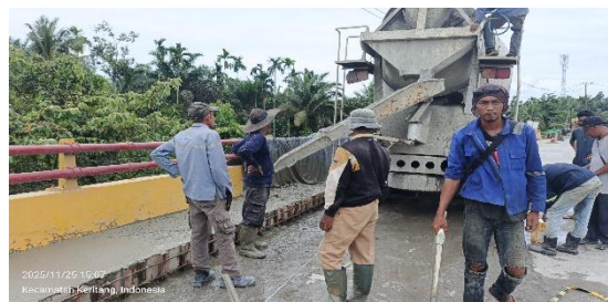
Gambar 3.53 Proses pengecoran trotoar Sumber: Dokumentasi Lapangan
