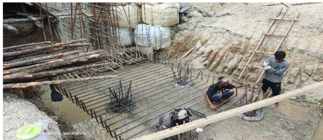
Gambar 3.35 Penulangan Abutment Sumber: Dokumentasi Lapangan
