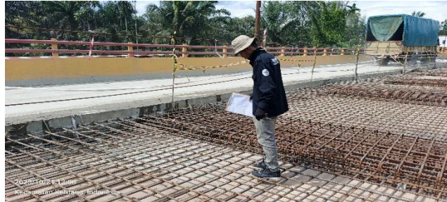
Gambar 3.26 Pemeriksaan penulangan Sumber: Dokumentasi Lapangan
