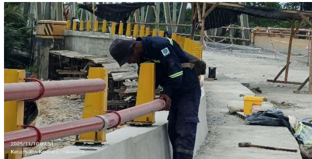
Gambar 3.49 Pemasangan Batang Railing Sumber: Dokumentasi Lapangan
