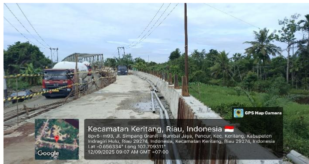
Gambar 3.48 Pemasangan Tiang Railing Sumber: Dokumentasi Lapangan
