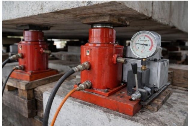
Gambar 3.71 Proses Pendongkrakan Bangunan Atas Jembatan Sumber: Dokumentasi Lapangan
