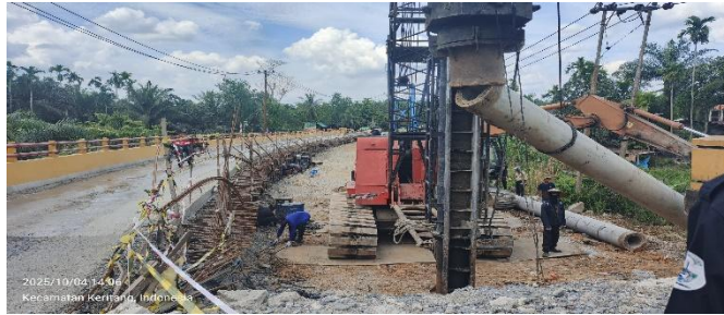
Gambar 3.13 Penegakan tiang pancang Sumber: Dokumentasi Lapangan
