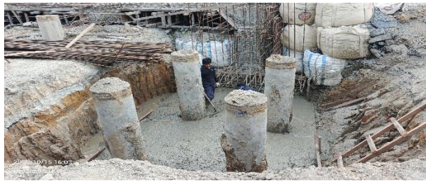
Gambar 3.34 Pengecoran Lantai Kerja Sumber: Dokumentasi Lapangan
