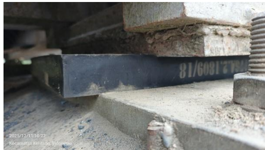
Gambar 3.74 Pemasangan Bearing Pad Baru Sumber: Dokumentasi Lapangan
