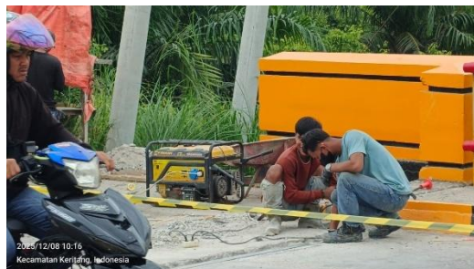
Gambar 3.75 Pemasangan Bearing Pad Baru Sumber: Dokumentasi Lapangan
