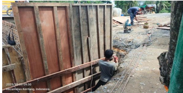
Gambar 3.46 Pembongkaran Bekisting Sumber: Dokumentasi Lapangan
