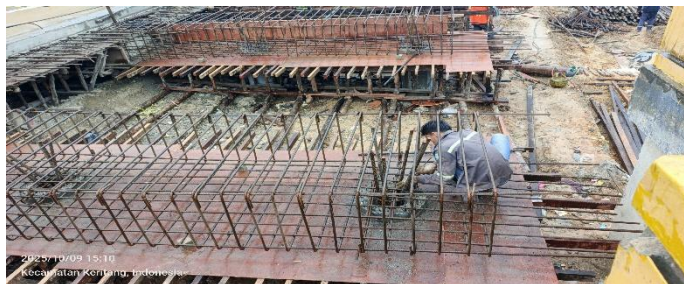
Gambar 3.24 Pemasangan tulangan pada balok Sumber: Dokumentasi Lapangan
