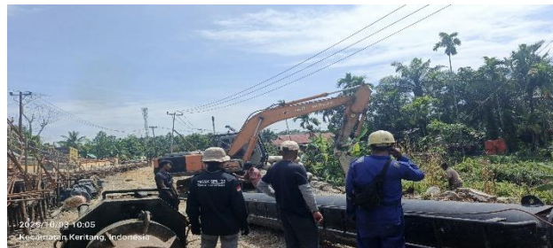
Gambar 3.12 Penyiapan alat pancang Sumber: Dokumentasi Lapangan
