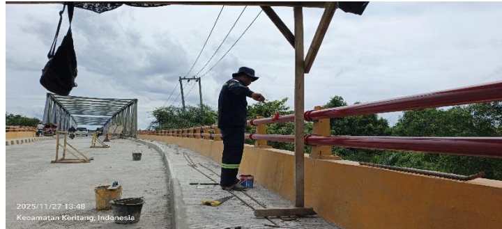
Gambar. 3.58 Pengecatan pada Railing Sumber: Dokumentasi Lapangan
