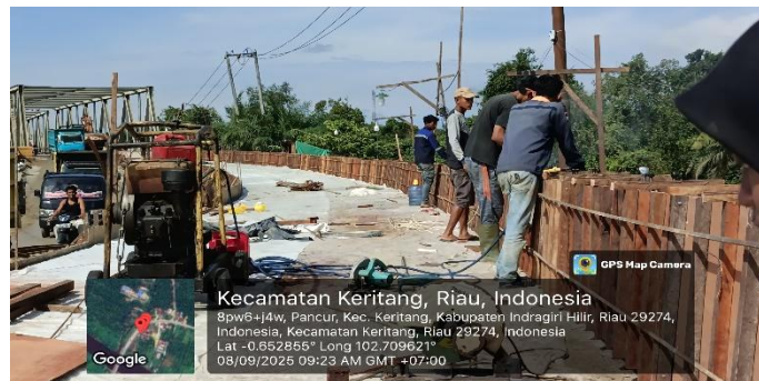
Gambar 3.38 Pemasangan Bekisting Parapet Sumber: Dokumentasi Lapangan
