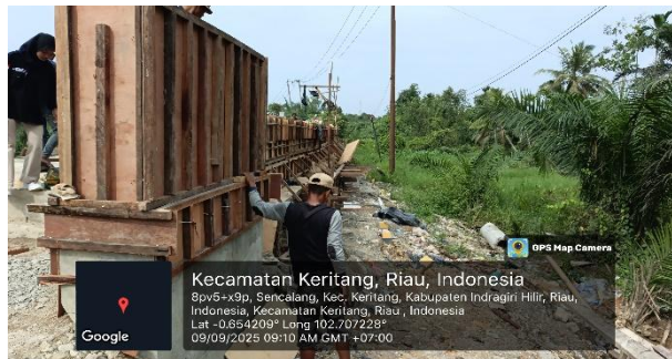
Gambar 3.43 Pemasangan bekesting loneng Sumber: Dokumentasi Lapangan
