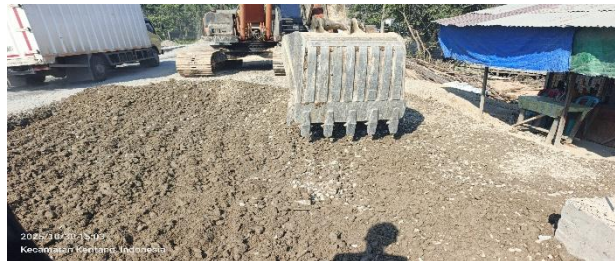
Gambar 3.60 Persiapan Area Timbunan Sumber: Dokumentasi Lapangan
