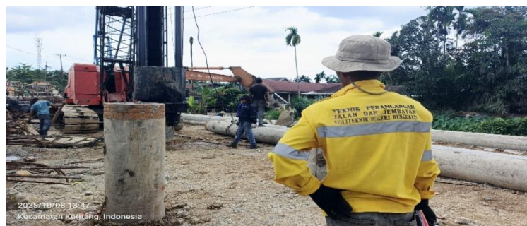
Gambar 3.6 Menghitung jumlah jatuhnya hammer Sumber : Dokumentasi Lapangan
