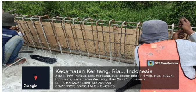
Gambar 3.40 Pemasangan tulangan parapet Sumber: Dokumentasi Lapangan
