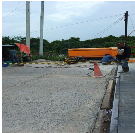
Gambar 3.68 Persiapan dan Pengamanan Lokasi Sumber: Dokumentasi Lapangan
