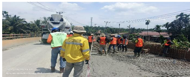
Gambar 3.29 Proses pengecoran Sumber: Dokumentasi Lapangan
