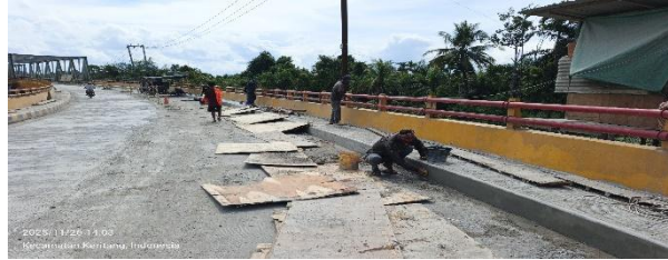
Gambar. 3. 55 Pembongkaran bekesting trotoar Sumber: Dokumentasi Lapangan
