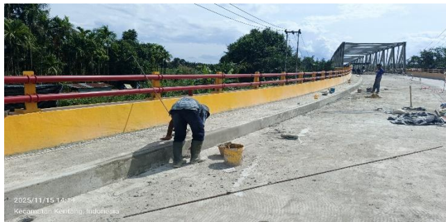
Gambar. 3.56 Pembersihan Permukaan yang Akan Dicat Sumber: Dokumentasi Lapangan
