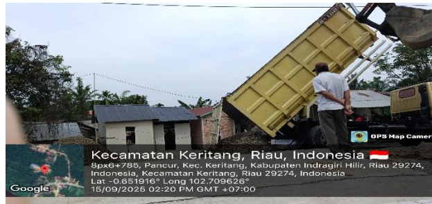
Gambar 3.61 Penimbunan Awal Jalan Pendekat Sumber: Dokumentasi Lapangan
