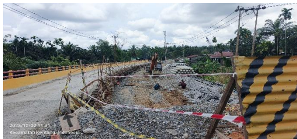
Gambar 3.10 Proses pembersihan area pemancangan Sumber: Dokumentasi lapangan
