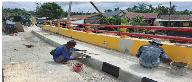
Gambar. 3.57 Pengecatan pada Trotoar dan Parapet Sumber: Dokumentasi Lapangan
