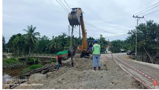
Gambar 3.66 Perbaikan tanah dengan cerocok Sumber: Dokumentasi Lapangan
