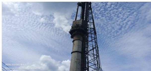
Gambar 3.15 Pemancangan Awal Sumber: Dokumentasi Lapangan
