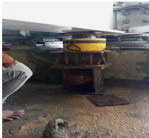
Gambar 3.70 Pemasangan Peralatan Pendongkrak Sumber: Dokumentasi Lapangan
