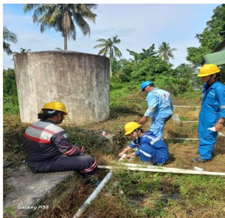
Gambar 3.1 Pemasangan *Line* Pipa Air
