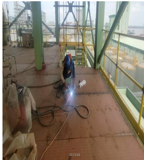
Gambar 3.15 pengelasan ceker plate
