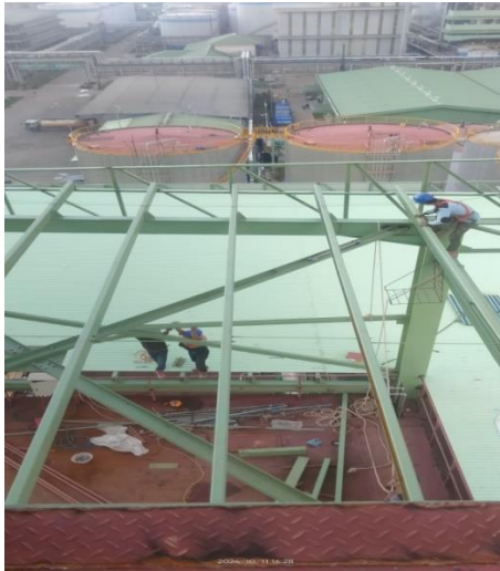
Gambar 3.16 pemasangan gording
