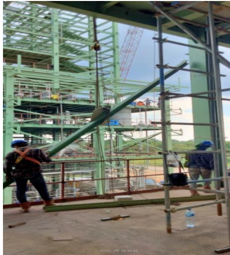
Gambar 3.18 pemasangan bracing
