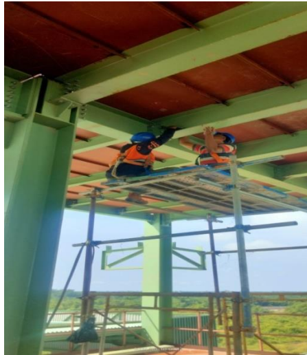
Gambar 3.12 pemasangan baja profil dengan baut
