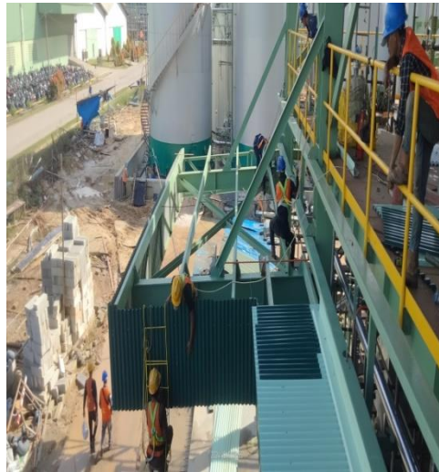
Gambar 3.21 pemasangan lisplang
