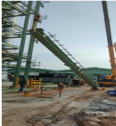
Gambar 3.6 erection kolom sambungan pertama
