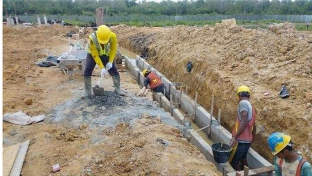
Gambar 3.71 Pekerjaan Pasang U-ditch
