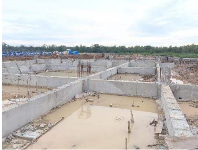
Gambar 3.66 Sloof Setelah Dibongkar Bekisting
