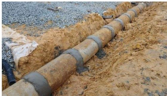
Gambar 3.77 Pemasangan Pipa beton Dia. 30 cm
