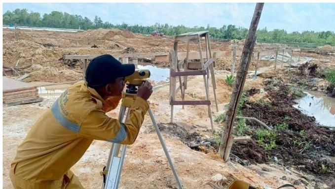
Gambar 3.59 Pengukuran Elevasi Bekisting Sloof
