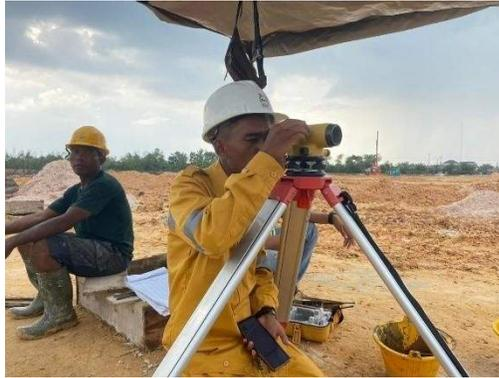
Gambar 3.69 Pengukuran Elevasi Lantai Kerja
