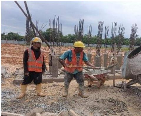
Gambar 3.10 pengadukan beton segar di lapangan dengan metode site mix
