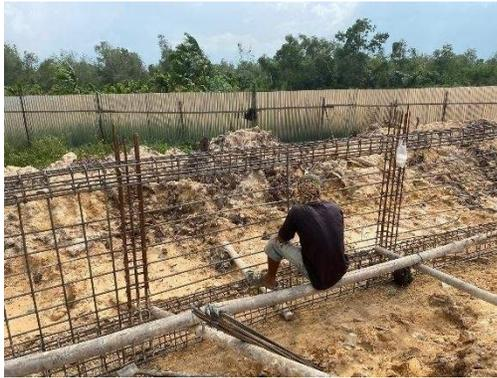
Gambar 3.29 Pembesian Balok dan Dinding Beton Bertulang
