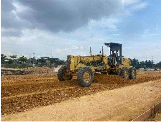
Gambar 3.74 Perataan Tanah Dengan Alat Motor grader
