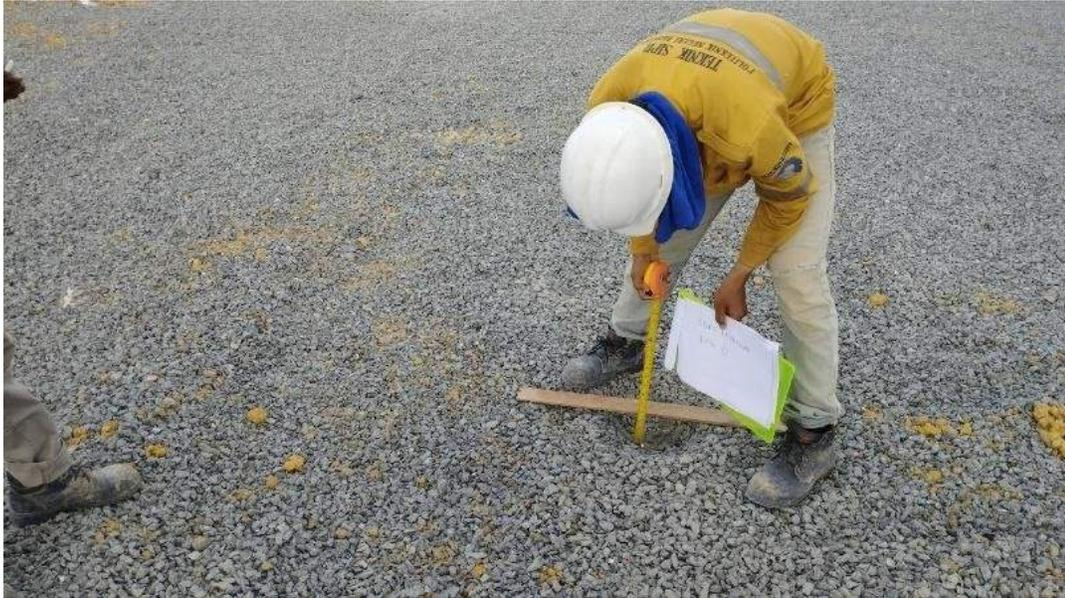
Gambar 3.112 Pengukuran ketebalan split lapangan
