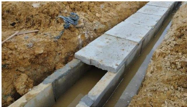
Gambar 3.72 Pemasangan Tutup U-Ditch
