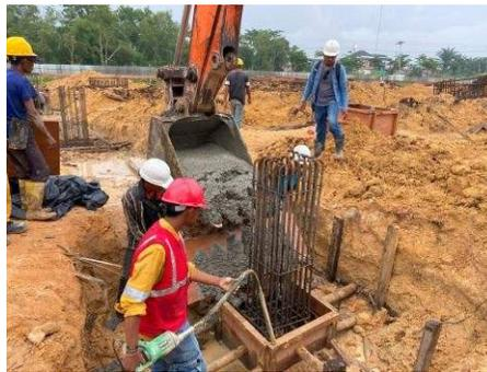
Gambar 3.56 Penggetaran Beton Menggunakan Vibrator
