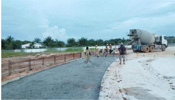
Gambar 3.83 Pengecoran Lantai Kerja K-100
