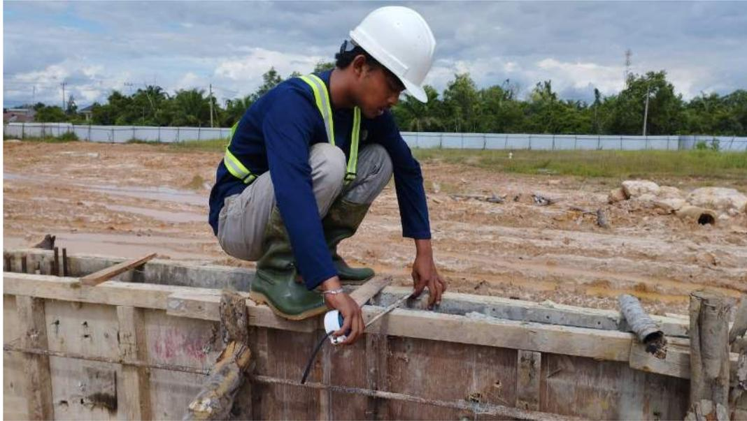
Gambar 3 106 inspeksi lebar bekisting pagar BRC
