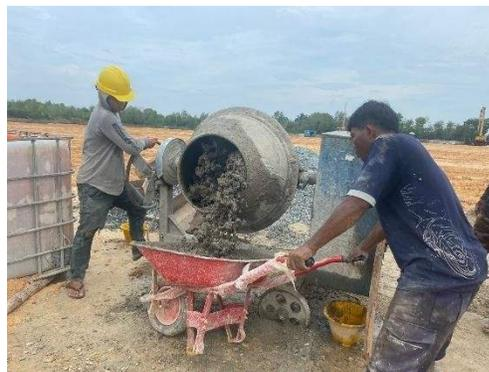
Gambar 3.18 Pengadukan Beton Metode Site Mix
