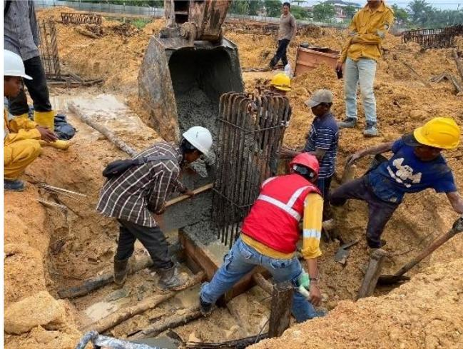
Gambar 3.55 Pengecoran Pondasi
