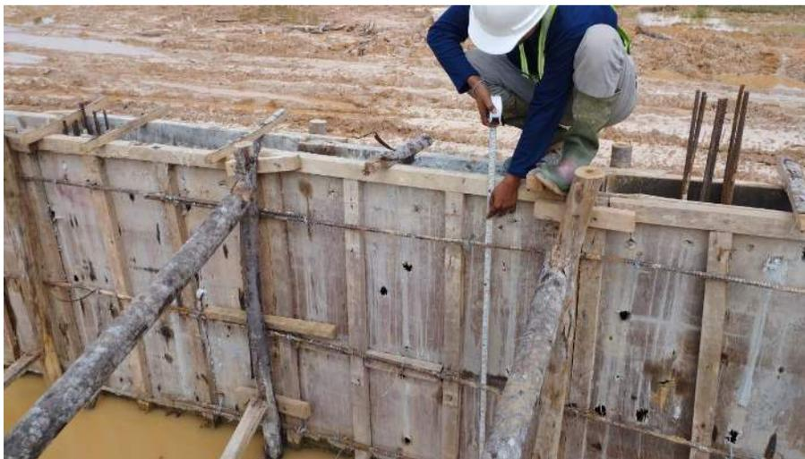
Gambar 3 105 inspeksi ketinggian bekisting pagar BRC
