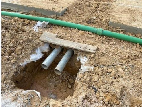
Gambar 3.80 Pemasangan Cabel Trench
