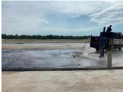
Gambar 3.86 Penyemprotan *Prime Coat*
