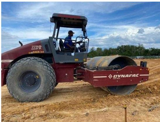
Gambar 3.75 Pematatan Tanah dengan Alat *Vibro Roller*
