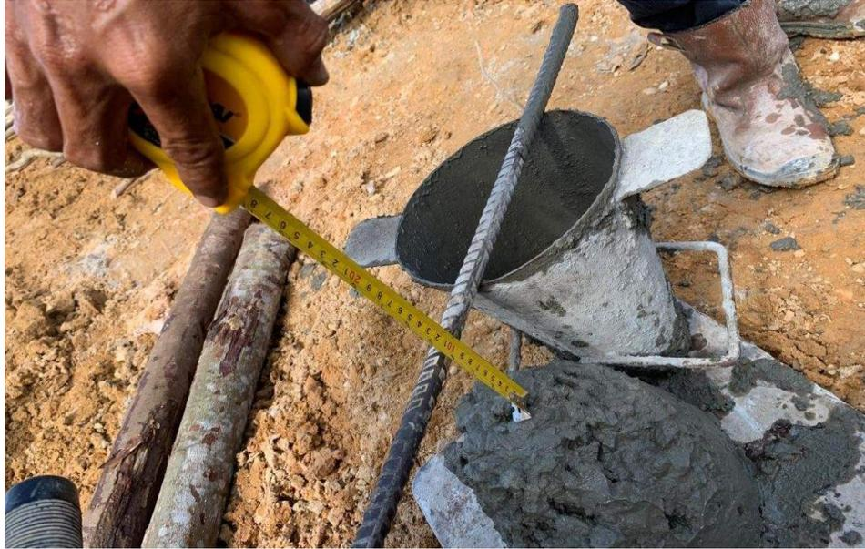
Gambar 3.102 pengecekan slump
