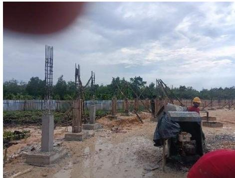
Gambar 3.13 Tapak Pondasi Pagar BRC Setelah Dibongkar Bekisting
