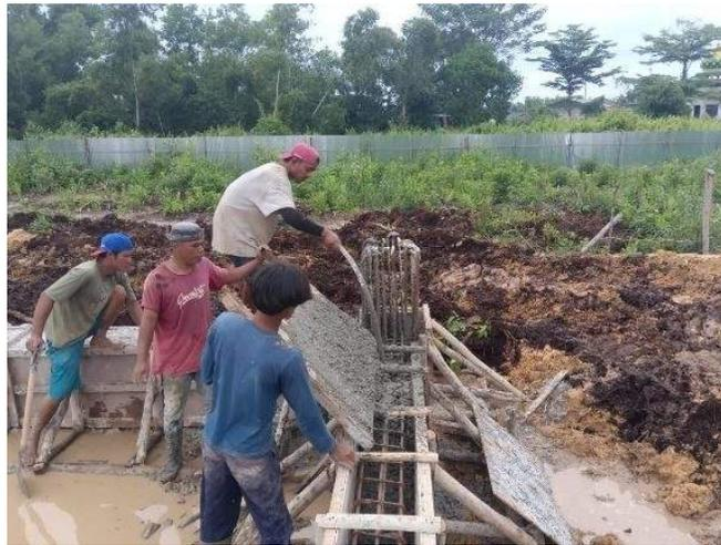
Gambar 3.65 Penggetaran Beton Menggunakan Vibrator
