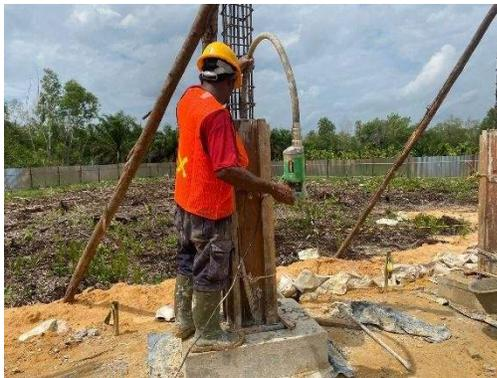
Gambar 3.20 Penggetaran Beton Menggunakan Vibrator Beton
