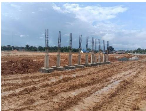
Gambar 3.21 Hasil Kolom Setelah Dibongkar
