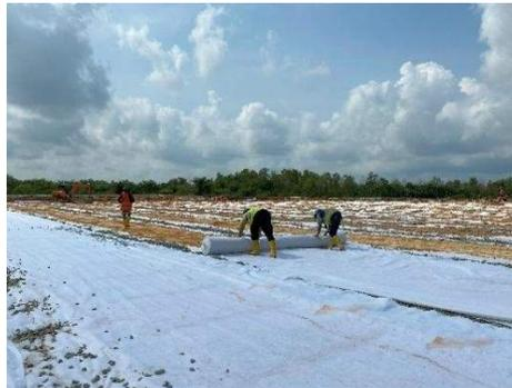
Gambar 3.65 Pekerjaan Lapisan *Geotextille Non Woven*
