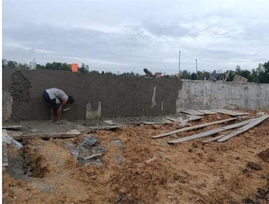
Gambar 3.37 Afwerking Beton
