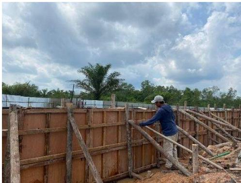
Gambar 3.30 Pemasangan Bekisting
