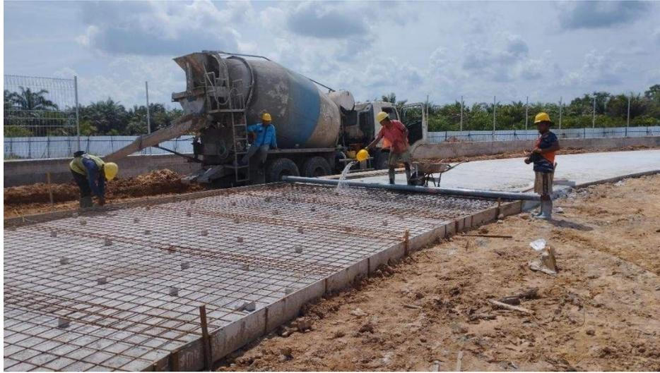
Gambar 3.119 penyiraman sebelum dilakukan pengecoran
