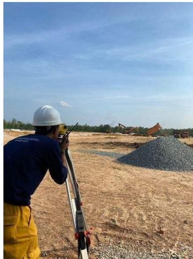
Gambar 3.22 Pengukuran Elevasi Pondasi
