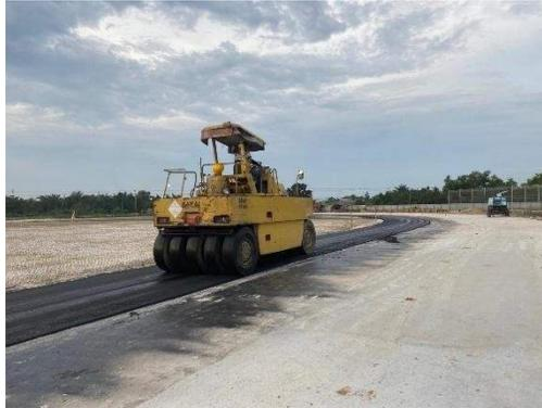
Gambar 3.88 Pengilasan lapisan aspal AC-WC
