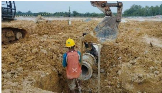
Gambar 3.76 Pemasangan Pipa RCP Dia.40 cm
