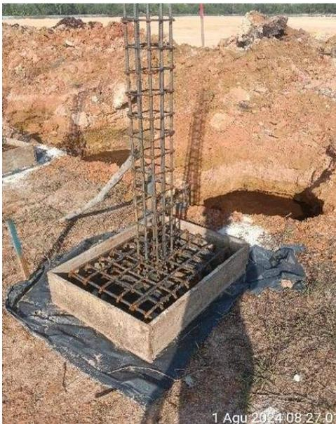
Gambar 3.9 Instal Tulangan dan Bekisting Tapak Pagar BRC
