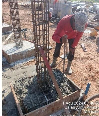
Gambar 3.12 Penggetaran Beton Menggunakan Vibrator
