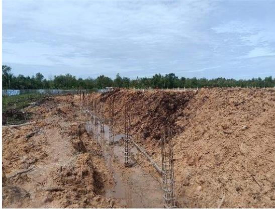
Gambar 3.23 Pondasi dan tulangan Kolom Setelah Dilakukan Pengurangan
