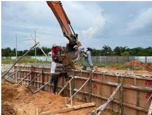
Gambar 3.34 Penggetaran Beton Menggunakan Vibrator
