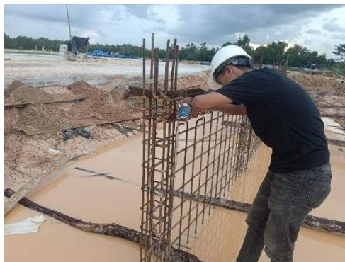
Gambar 3.16 Pengecekan Diameter Kolom
