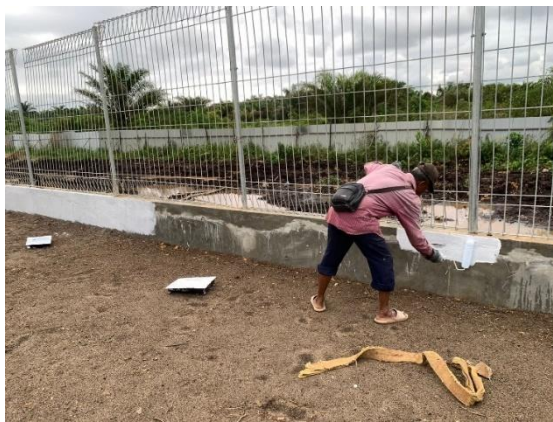
Gambar 3.38 Pengecatan Dinding Pagar BRC (Sumber: Dokumentasi Lapangan, 2024)
