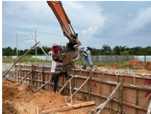
Gambar 3.34 Penggetaran Beton Menggunakan Vibrator (Sumber: Dokumentasi Lapangan, 2024)
