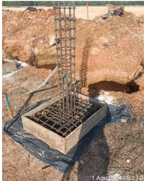
Gambar 3.9 Instal Tulangan dan Bekisting Tapak Pagar BRC (Sumber: Dokumentasi Lapangan, 2024)
