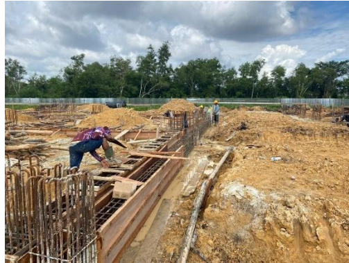
Gambar 3.60 Instal Bekisting Sloof (Sumber: Dokumentasi Lapangan, 2024)
