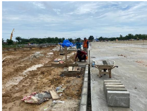
Gambar 3.81 Pemasangan Kanstin (Sumber: Dokumentasi Lapangan, 2024)
