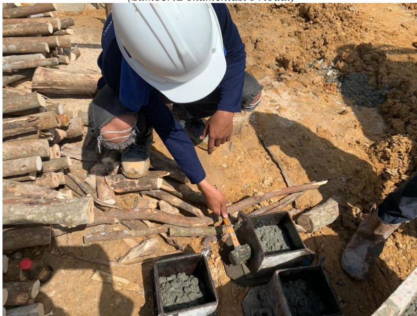
Gambar 3.130 Pembuatan sampel kubus (Sumber: Dokumentasi Pribadi)
