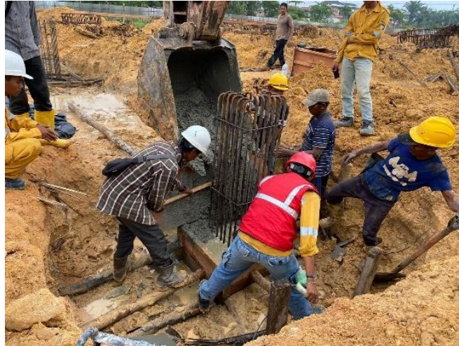
Gambar 3.55 Pengecoran Pondasi (Sumber: Dokumentasi Lapangan, 2024)
