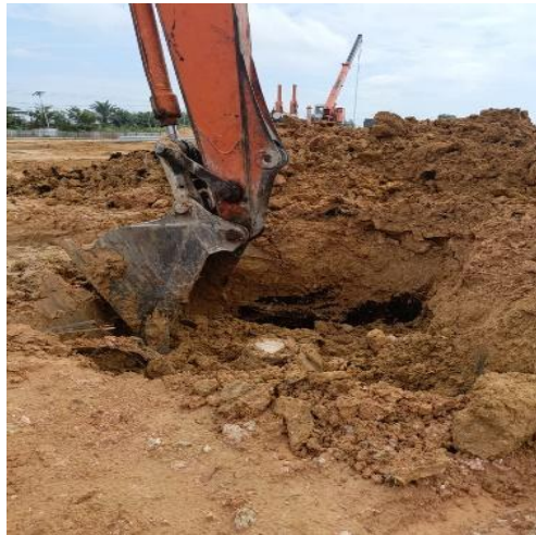
Gambar 3.46 Galian Tanah Spun Pile Cap (Sumber: Dokumentasi Lapangan, 2024 )
