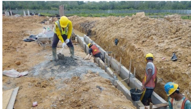
Gambar 3.71 Pekerjaan Pasang U-ditch (Sumber: Dokumentasi Lapangan, 2024)
