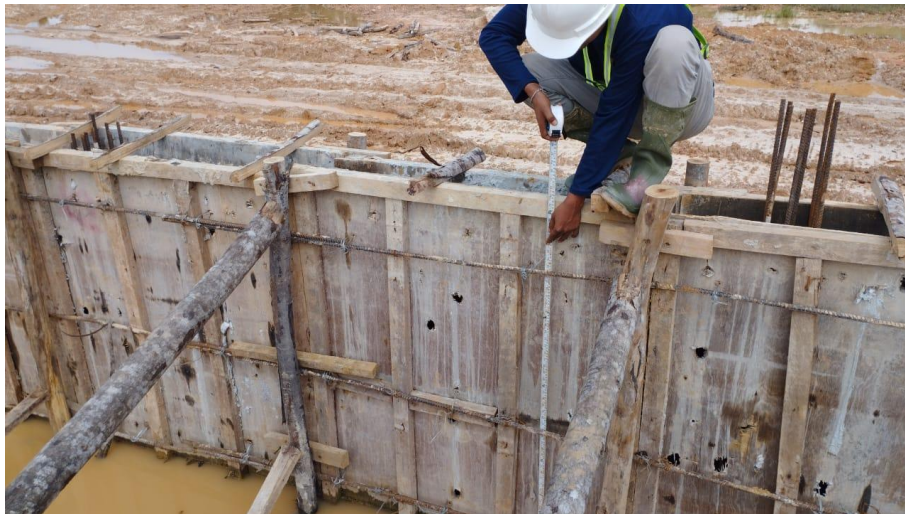
Gambar 3 105 inspeksi ketinggian bekisting pagar BRC (Sumber:Dokumentasi Pribadi)
