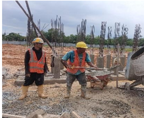
Gambar 3.10 pengadukan beton segar di lapangan dengan metode site mix (Sumber: Dokumentasi Lapangan, 2024)
