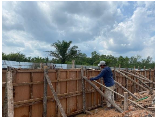
Gambar 3.30 Pemasangan Bekisting (Sumber: Dokumentasi Lapangan, 2024)
