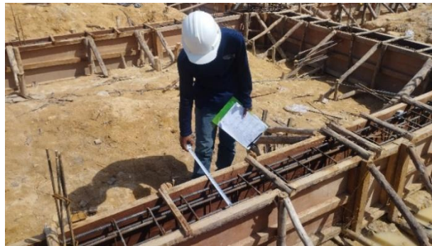
Gambar 3.61 Inspeksi Tulangan Sloof (Sumber: Dokumentasi Lapangan, 2024)
