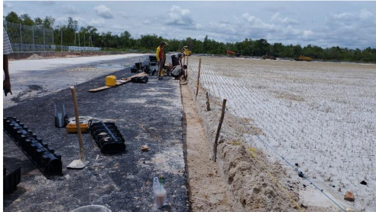
Gambar 3.78 Pemasangan ex. Aquatech sport (Sumber: Dokumentasi Lapangan, 2024)
