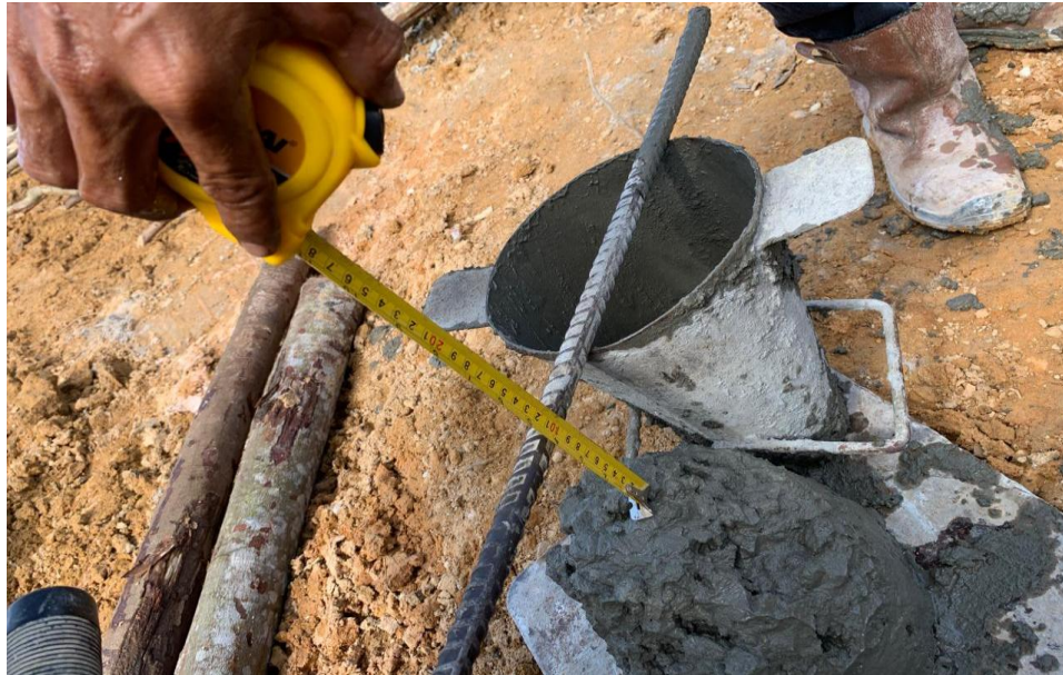
Gambar 3.102 pengecekan slump (Sumber:Dokumentasi Pribadi)
