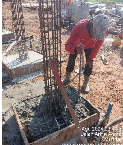
Gambar 3.12 Penggetaran Beton Menggunakan Vibrator (Sumber: Dokumentasi Lapangan, 2024)
