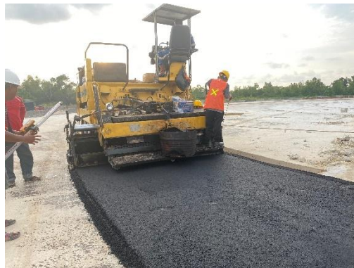
Gambar 3.87 Penggelaran Aspal AC-WC (Sumber: Dokumentasi Lapangan, 2024)
