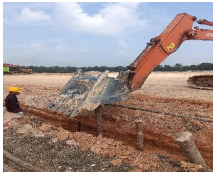
Gambar 3.7 Pekerjaan Pemancangan Cerucuk Kayu (Sumber: Dokumentasi Lapangan, 2024)
