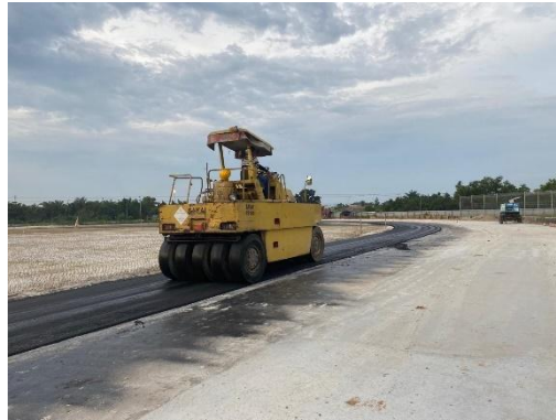
Gambar 3.88 Pengilasan lapisan aspal AC-WC (Sumber: Dokumentasi Lapangan, 2024)
