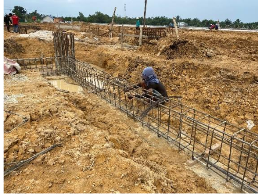
Gambar 3.58 Instal Besi Sloof 30 X 60 cm (Sumber: Dokumentasi Lapangan, 2024)
