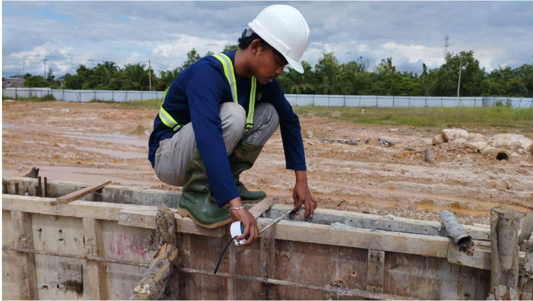
Gambar 3 106 inspeksi lebar bekisting pagar BRC (Sumber: Dokumentasi Pribadi)
