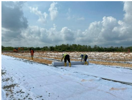
Gambar 3.65 Pekerjaan Lapisan Geotextille Non Woven (Sumber: Dokumentasi Lapangan, 2024)
