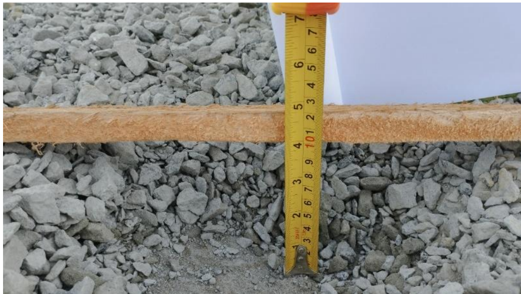
Gambar 2 28 Hasil pengukuran ketebalan split lapangan (Sumber: Dokumentasi Pribadi)
