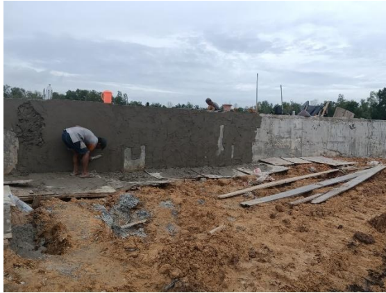
Gambar 3.37 Afwerking Beton (Sumber: Dokumentasi Lapangan, 2024)
