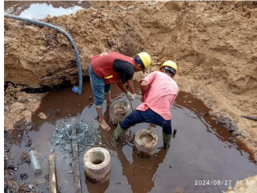
Gambar 3.50 Pemecahan Kepala Spun Pile (Sumber: Dokumentasi Lapangan, 2024)
