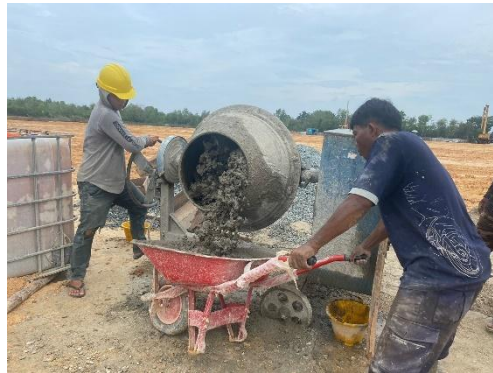
Gambar 3.18 Pengadukan Beton Metode Site Mix (Sumber: Dokumentasi Lapangan, 2024)
