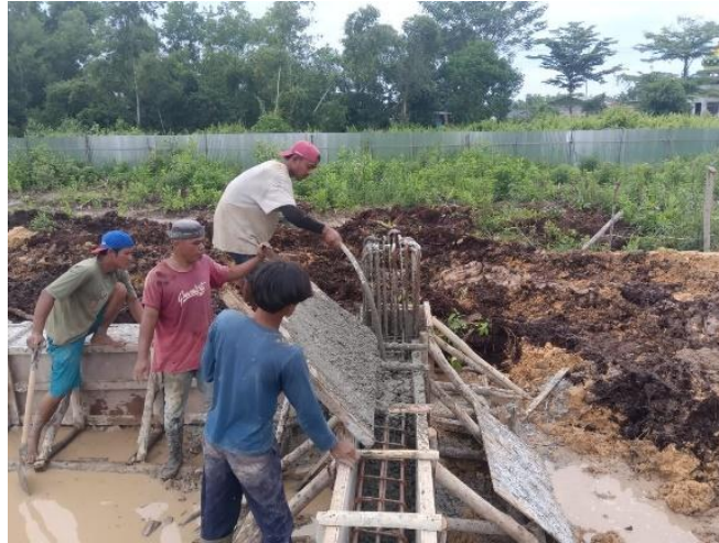
Gambar 3.65 Penggetaran Beton Menggunakan Vibrator (Sumber: Dokumentasi Lapangan, 2024)
