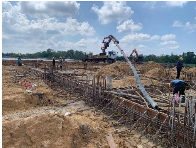
Gambar 3.64 Pengecoran Sloof (Sumber: Dokumentasi Lapangan, 2024)
