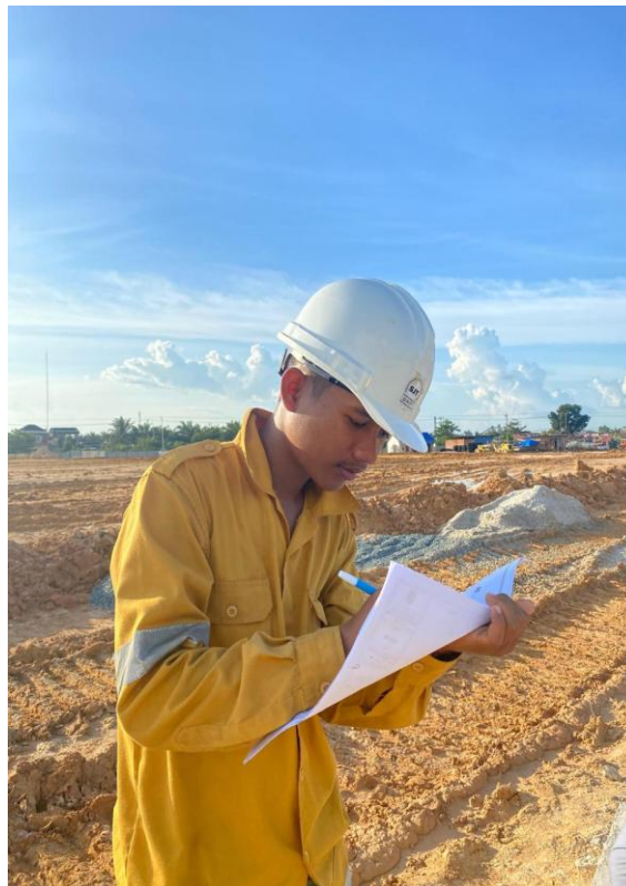
Gambar 3.96 inspeksi pagar BRC Hasil perhitungan progress pekerjaan pagar Beton B (Sumber:Dokumentasi Pribadi)
