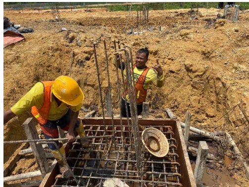
Gambar 3.52 Instal tulangan dan bekisting (Sumber: Dokumentasi Lapangan, 2024)
