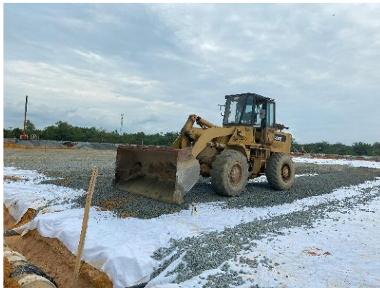
Gambar 3.69 Pengurugan Batu Split ( Sumber: Dokumentasi Lapangan, 2024)
