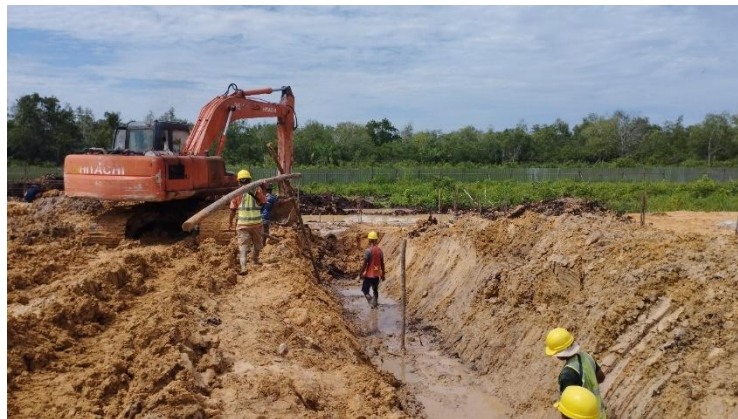
Gambar 3.67 Pekerjaan Galian Tanah (Sumber: Dokumentasi Lapangan, 2024)
