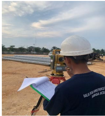
Gambar 3.39 Penentuan Titik Koordinat Tiang Pancang (Sumber: Dokumentasi Lapangan, 2024)
