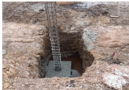
Gambar 3.11 Tapak Pondasi yang sudah Tercor (Sumber: Dokumentasi Lapangan, 2024)
