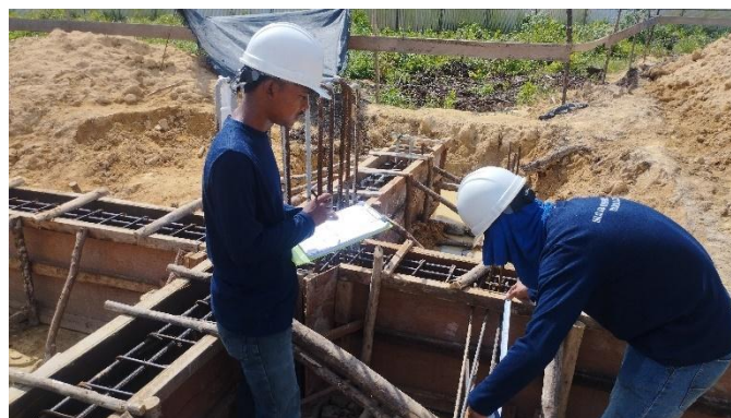
Gambar 3.62 Inspeksi Bekisting Sloof (Sumber: Dokumentasi Lapangan, 2024)
