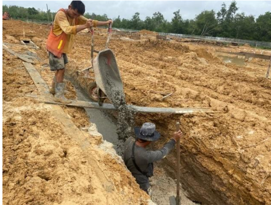
Gambar 3.70 Pekerjaan Lantai kerja (Sumber: Dokumentasi Lapangan, 2024)
