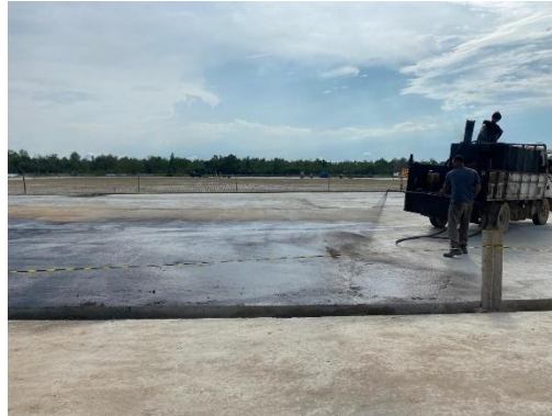
Gambar 3.86 Penyemprotan Prime Coat (Sumber: Dokumentasi Lapangan, 2024)
