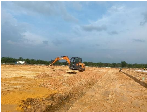
Gambar 3.64 Pekerjaan Galian Pipa HDPE (Sumber: Dokumentasi Lapangan, 2024)
