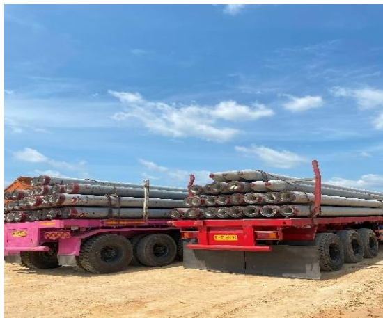
Gambar 3.40 Mobilisasi Spun Pile (Sumber: Dokumentasi Lapangan, 2024)
