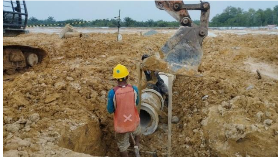
Gambar 3.76 Pemasangan Pipa RCP Dia.40 cm (Sumber: Dokumentasi Lapangan, 2024)
