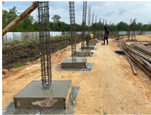
Gambar 3.15 Tulangan Kolom Setelah Dirakit (Sumber: Dokumentasi Lapangan, 2024)
