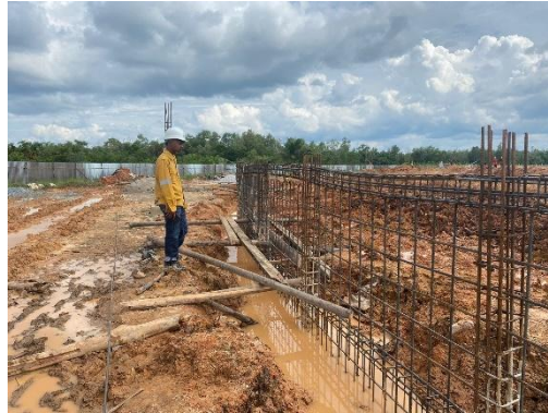
Gambar 3.31 Pengecekan balok dan pekerjaan dinding pagar BRC (Sumber: Dokumentasi Lapangan, 2024)
