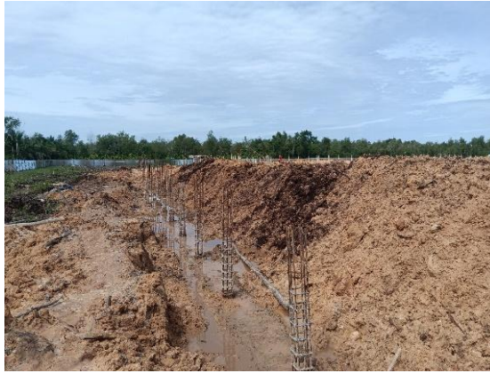
Gambar 3.23 Pondasi dan tulangan Kolom Setelah Dilakukan Pengurugan (Sumber: Dokumentasi Lapangan, 2024)
