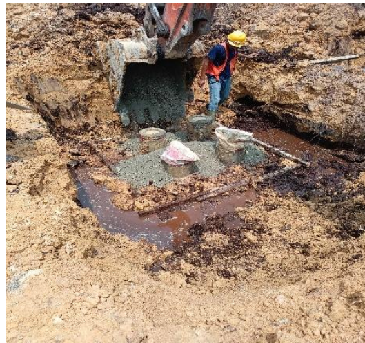
Gambar 3.49 Urugan Pasir (Sumber: Dokumentasi Lapangan, 2024)
