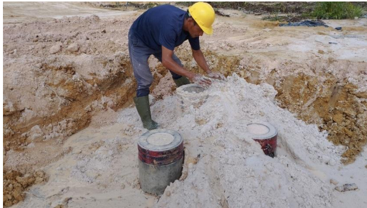
Gambar 3.47 Urugan Pasir (Sumber: Dokumentasi Lapangan, 2024 )
