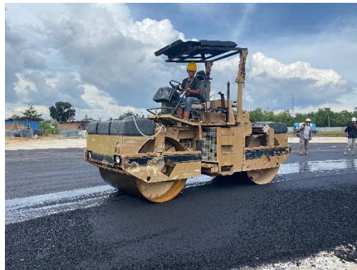
Gambar 3.89 Pemadatan aspal AC-WC (Sumber: Dokumentasi Lapangan, 2024)
