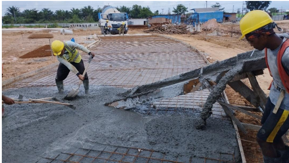
Gambar 3.120 proses beton dialirkan (Sumber: Dokumentasi Pribadi )
