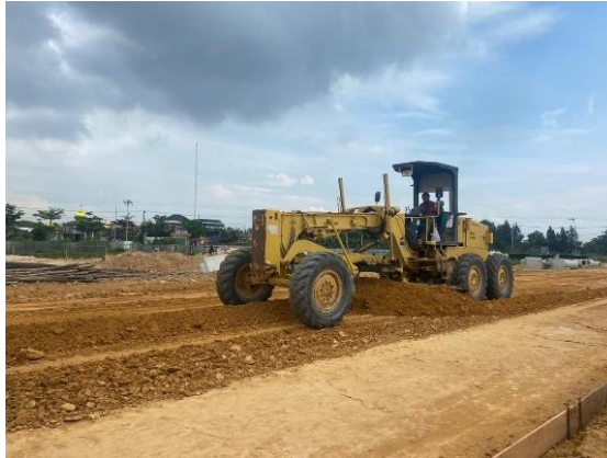
Gambar 3.74 Perataan Tanah Dengan Alat Motor grader ( Sumber: Dokumentasi Lapangan, 2024)
