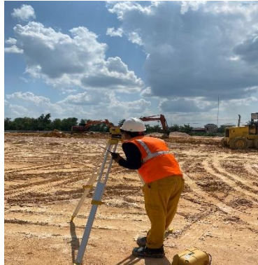
Gambar 3 43 Pengukuran Elevasi Tiang Pancang (Sumber: Dokumentasi Lapangan, 2024 )
