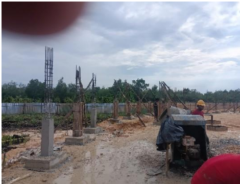
Gambar 3.13 Tapak Pondasi Pagar BRC Setelah Dibongkar Bekisting (Sumber: Dokumentasi Lapangan, 2024)
