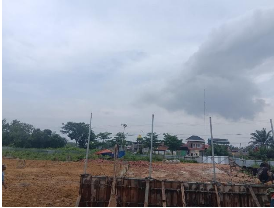
Gambar 3.35 Pekerjaan Pemasangan Pipa Galvanis (Sumber: Dokumentasi Lapangan, 2024)
