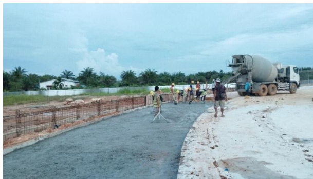
Gambar 3.83 Pengecoran Lantai Kerja K-100 (Sumber: Dokumentasi Lapangan, 2024)
