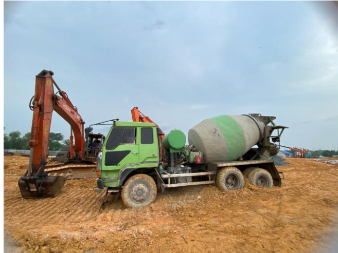
Gambar 3.53 Beton Ready Mix ( Sumber: Dokumentasi Lapangan, 2024)
