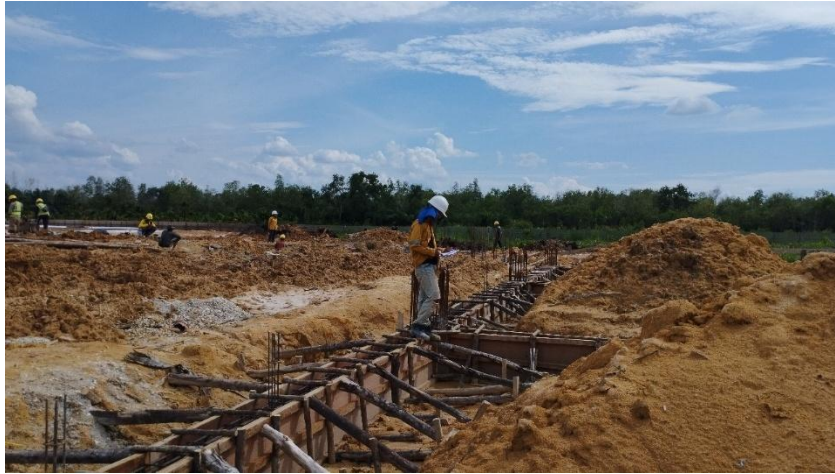
Gambar 3.131 Inspeksi pembesian sloof tribun (Sumber: Dokumentasi Pribadi)
