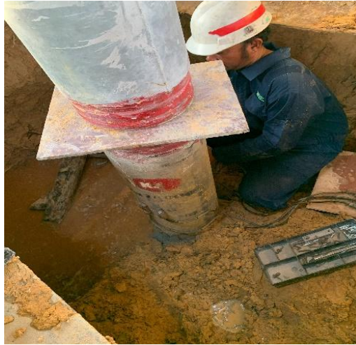
Gambar 3.45 PDA test (Sumber: Dokumentasi Lapangan, 2024 )
