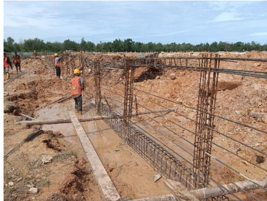
Gambar 3.26 Proses Fabrikasi Besi Sloof (Sumber: Dokumentasi Lapangan, 2024)
