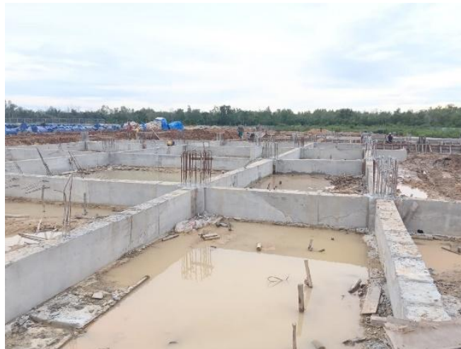
Gambar 3.66 Sloof Setelah Dibongkar Bekisting (Sumber: Dokumentasi Lapangan, 2024)
