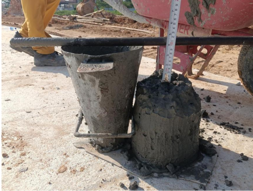
Gambar 3.129 Slump sloof tribun (Sumber: Dokumentasi Pribadi)
