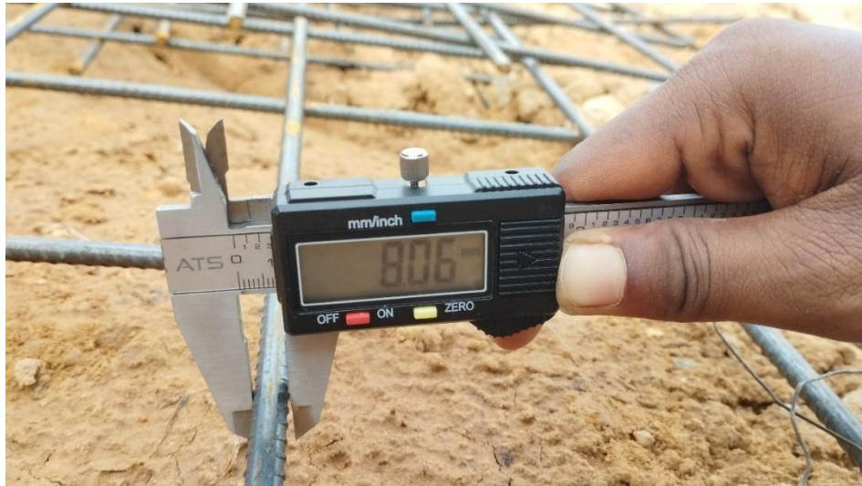
Gambar 3.118 Pengecekan dimensi tulangan (Sumber:Dokumentasi Pribadi)
