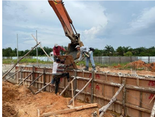
Gambar 3.33 Pengecoran Dinding (Sumber: Dokumentasi Lapangan, 2024)
