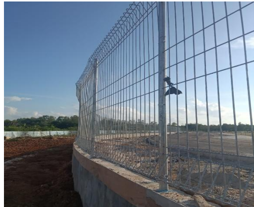
Gambar 3.36 Pasang BRC (Sumber: Dokumentasi Lapangan, 2024)
