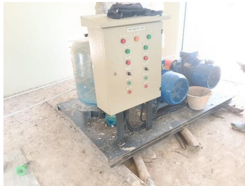
Gambar 3.75 Pompa Siram Rumput Type Centrifugal (Sumber: Dokumentasi Lapangan, 2024)
