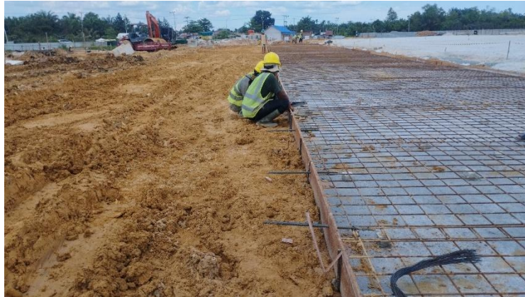
Gambar 3.84 Pembesian wiremesh M8 (Sumber: Dokumentasi Lapangan, 2024)
