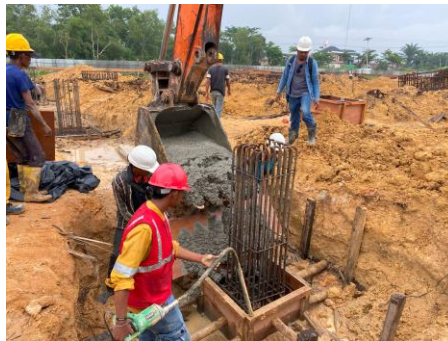
Gambar 3.56 Penggetaran Beton Menggunakan Vibrator (Sumber: Dokumentasi Lapangan, 2024)
