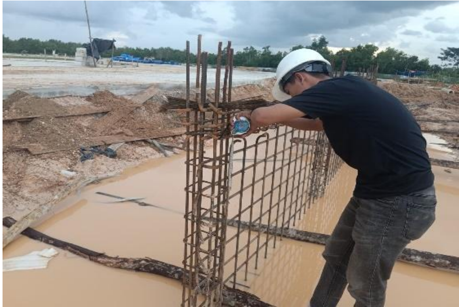
Gambar 3.104 infeksi pembesian pagar BRC (Sumber:Dokumentasi Pribadi)
