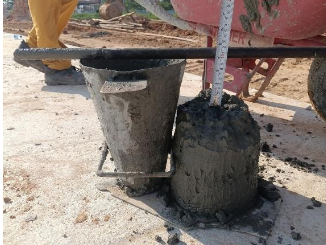
Gambar 3.63 Slump Test (Sumber: Dokumentasi Lapangan, 2024)
