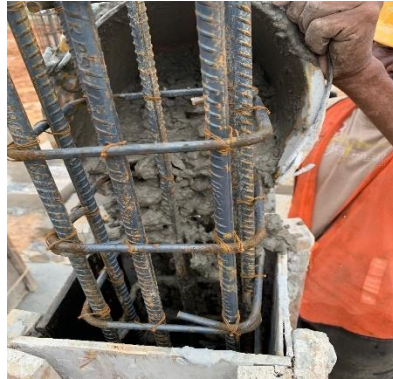
Gambar 3.19 Penuangan Beton Kedalam Bekisting (Sumber: Dokumentasi Lapangan, 2024)
