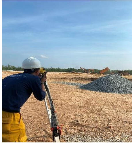
Gambar 3.48 Pengukuran Elevasi Tiang Pancang (Sumber: Dokumentasi Lapangan, 2024)
