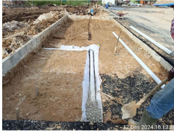
Gambar 3.82 Pekerjaan Bak Lompat Jauh (Sumber: Dokumentasi Lapangan, 2024)
