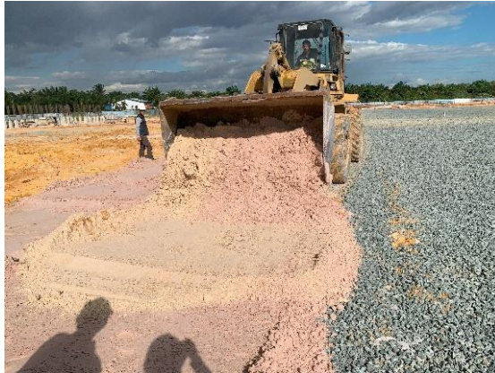
Gambar 3.70 Pengurugan Pasir ( Sumber: Dokumentasi Lapangan, 2024)
