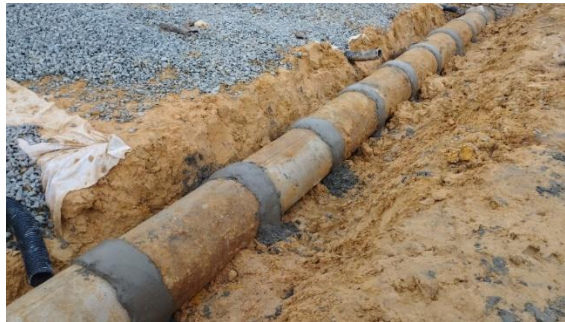
Gambar 3.77 Pemasangan Pipa beton Dia. 30 cm (Sumber: Dokumentasi Lapangan, 2024)
