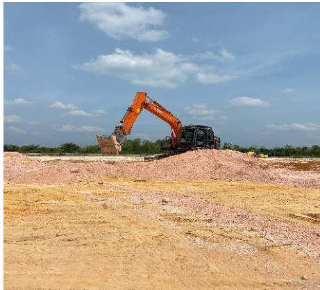
Gambar 3.2 Penimbunan Tanah (Sumber: Dokumentasi Lapangan, 2024)
