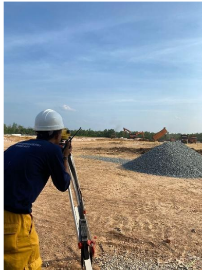
Gambar 3.22 Pengukuran Elevasi Pondasi (Sumber: Dokumentasi Lapangan, 2024)
