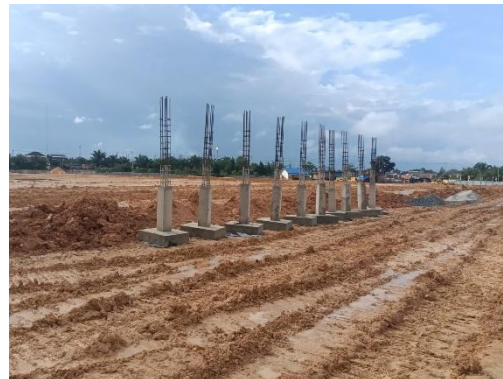
Gambar 3.21 Hasil Kolom Setelah Dibongkar (Sumber: Dokumentasi Lapangan, 2024)
