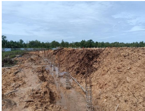
Gambar 3.25 Lantai Kerja Sloof (Sumber: Dokumentasi Lapangan, 2024)
