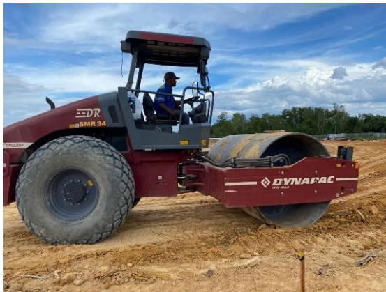
Gambar 3.75 Pemadatan Tanah dengan Alat Vibro Roller ( Sumber: Dokumentasi Lapangan, 2024)
