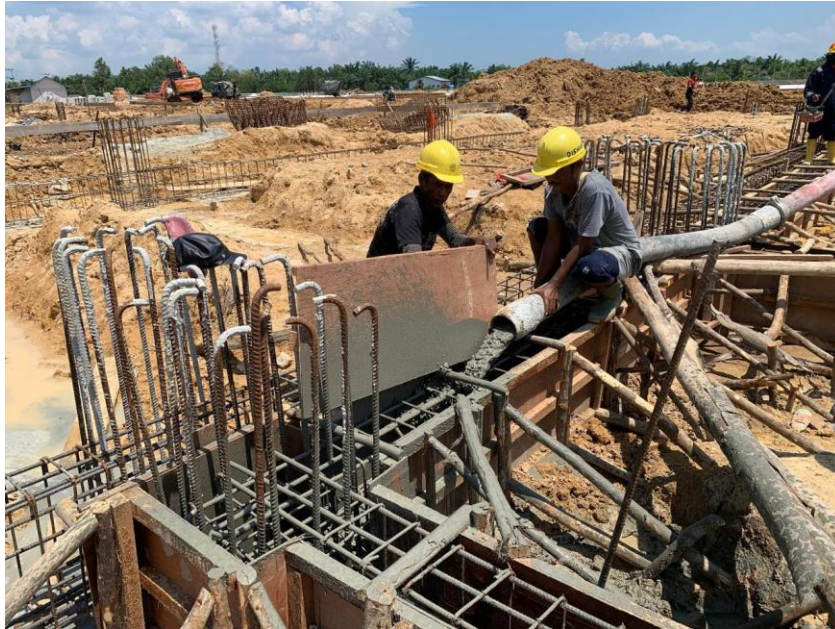
Gambar 3.133 Pengecoran sloof tribun (Sumber: Dokumentasi Pribadi)
