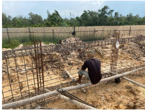
Gambar 3.29 Pembesian Balok dan Dinding Beton Bertulang (Sumber: Dokumentasi Lapangan, 2024)
