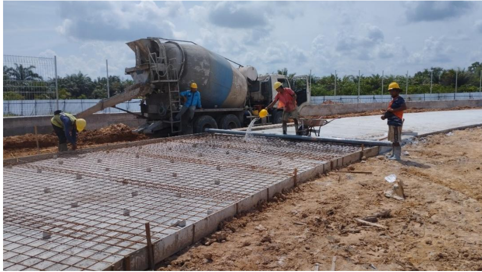
Gambar 3.119 penyiraman sebelum dilakukan pengecoran (Sumber: Dokumentasi Pribadi )
