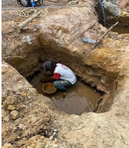
Gambar 3.8 Pekerjaan Lantai Kerja (Sumber: Dokumentasi Lapangan, 2024)
