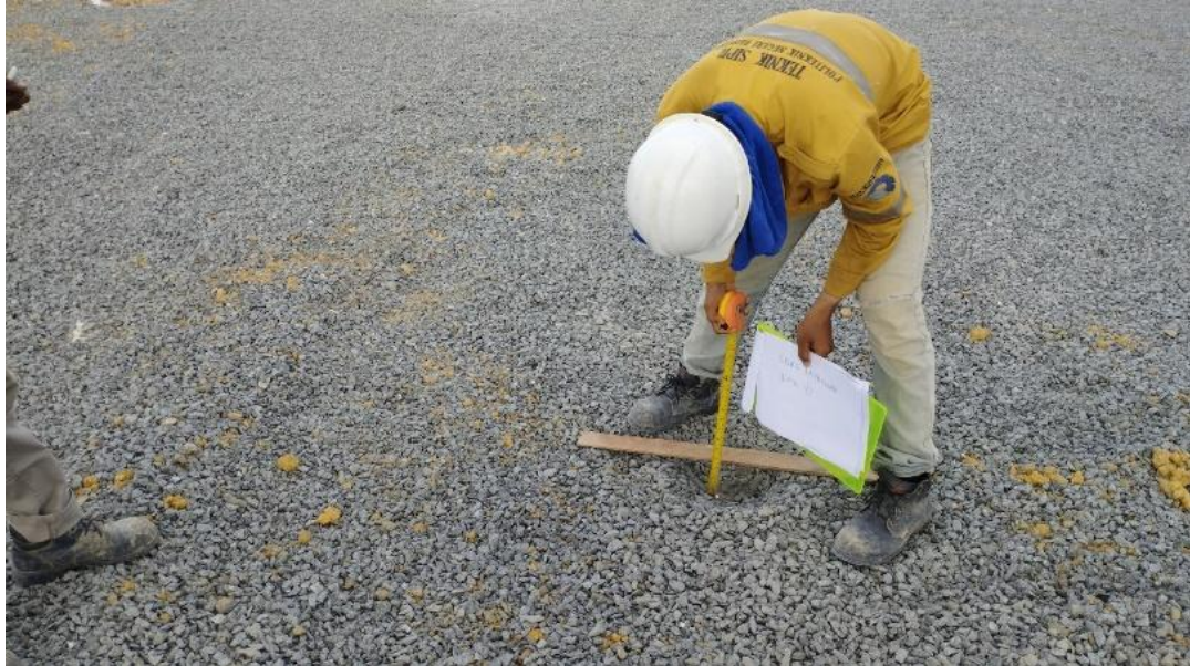
Gambar 3.112 Pengukuran ketebalan split lapangan (Sumber: Dokumentasi Pribadi)
