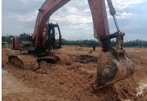
Gambar 3.6 Pekerjaan Galian (Sumber: Dokumentasi Lapangan, 2024)
