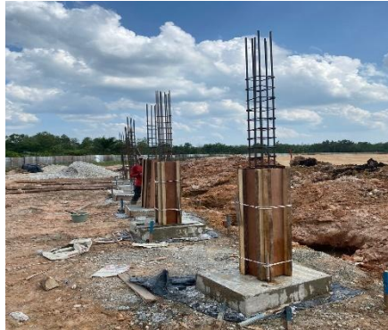
Gambar 3.17 Bekisting Terpasang (Sumber: Dokumentasi Lapangan, 2024)
