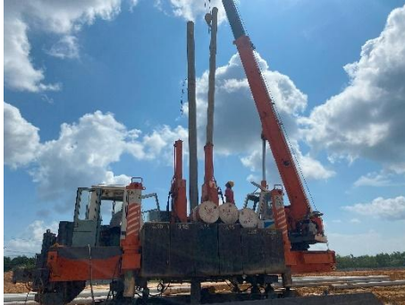
Gambar 3.42 Pemancangan Spun Pile (Sumber: Dokumentasi Lapangan, 2024 )
