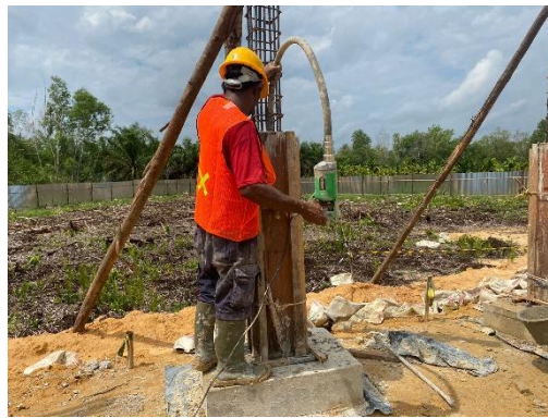
Gambar 3.20 Penggetaran Beton Menggunakan Vibrator Beton (Sumber: Dokumentasi Lapangan, 2024)
