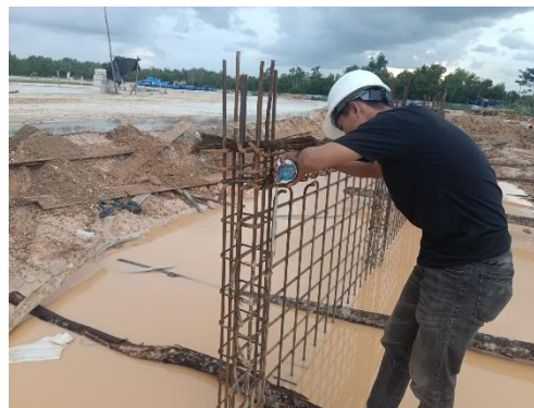
Gambar 3.16 Pengecekan Diameter Kolom (Sumber: Dokumentasi Lapangan, 2024)
