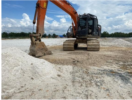
Gambar 3.3 Penghamparan Tanah (Sumber: Dokumentasi Lapangan, 2024)
