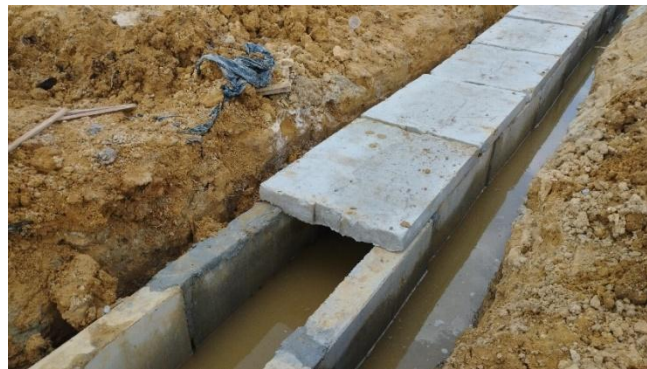
Gambar 3.72 Pemasangan Tutup U-Ditch (Sumber: Dokumentasi Lapangan, 2024)
