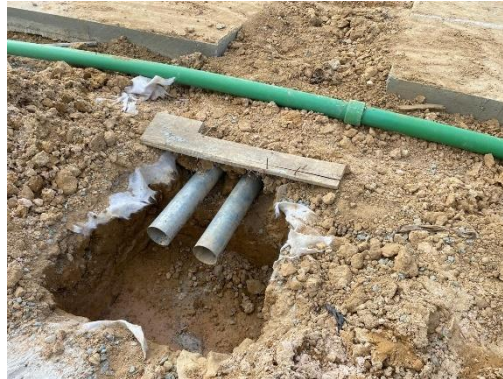
Gambar 3.80 Pemasangan Cabel Trench (Sumber: Dokumentasi Lapangan, 2024)
