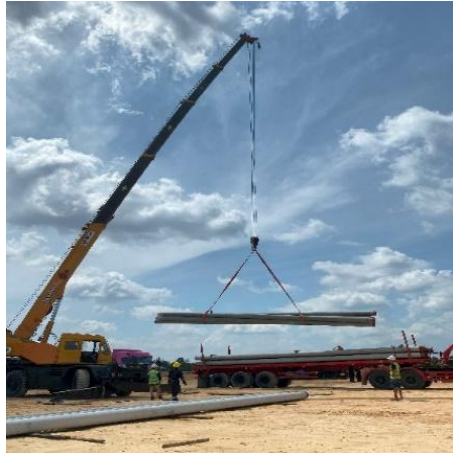
Gambar 3.41 Penurunan Spun Pile (Sumber: Dokumentasi Lapangan, 2024)
