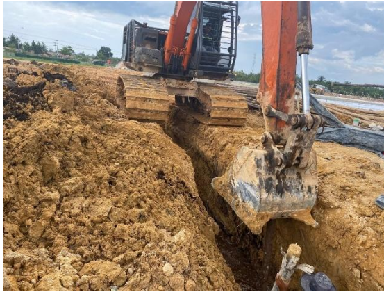
Gambar 3.68 Pekerjaan Pemancangan Cerucuk (Sumber: Dokumentasi Lapangan, 2024)
