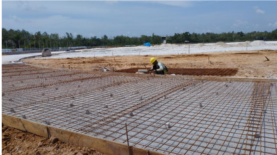
Gambar 3.117 Pemasangan bekisting (Sumber:Dokumentasi Pribadi)
