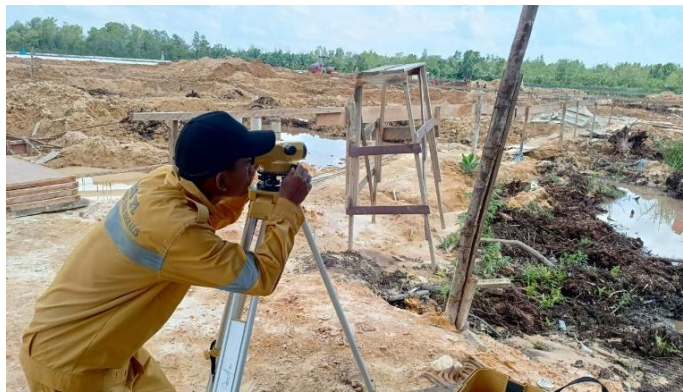
Gambar 3.59 Pengukuran Elevasi Bekisting Sloof (Sumber: Dokumentasi Lapangan, 2024)
