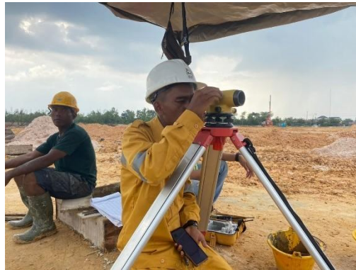
Gambar 3.69 Pengukuran Elevasi Lantai Kerja (Sumber: Dokumentasi Lapangan, 2024)
