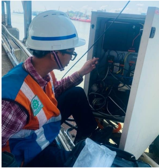
Gambar 3. 3 Pemasangan Kabel Jaringan LAN
