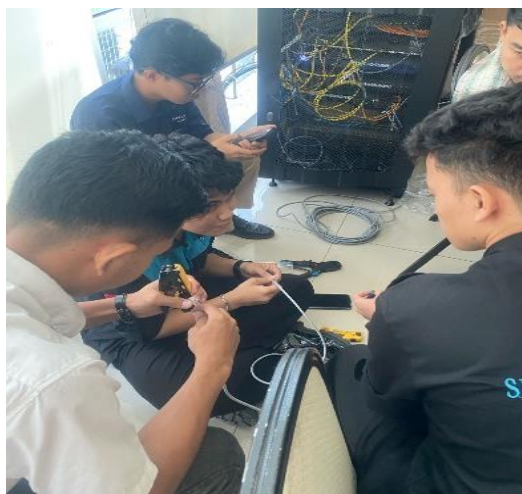
Gambar 3. 4 Crimping RJ45 Pada Kabel LAN
