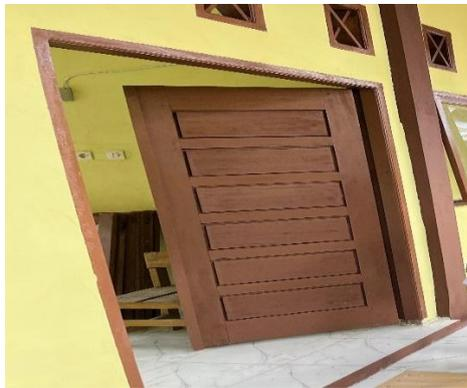
Gambar 3. 29 Pemasangan Pintu Panel
