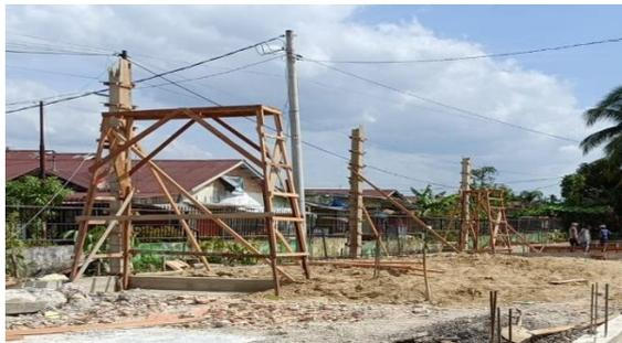
Gambar 3. 14 Pengecoran Kolom
