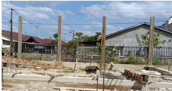
Gambar 3. 15 Pembongkaran Bekisting Kolom
