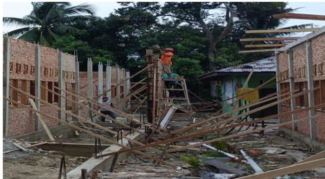
Gambar 3. 17 Pengecoran Kolom Praktis
