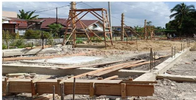
Gambar 3. 12 Pemasangan Bekisting Kolom
