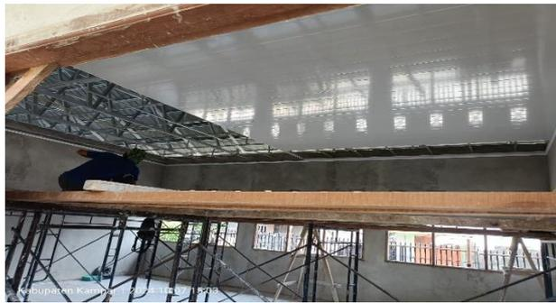
Gambar 3. 49 Pemasangan Plafon PVC
