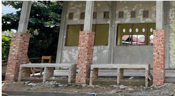
Gambar 3. 42 Pengecoran Tempat Duduk
