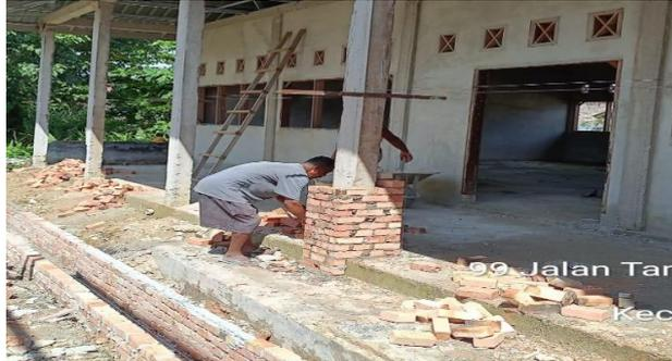
Gambar 3. 23 Pemasangan Bata Kolom
