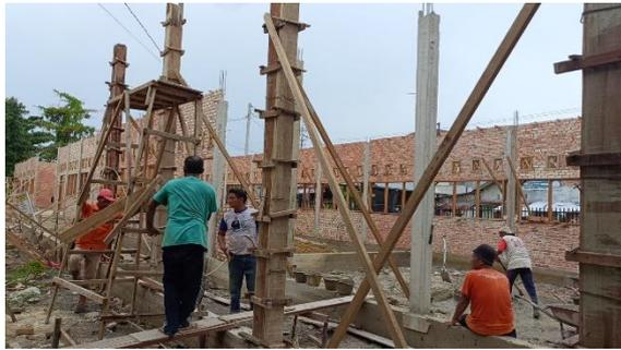
Gambar 3. 16 Pemasangan Bekisting Kolom Praktis
