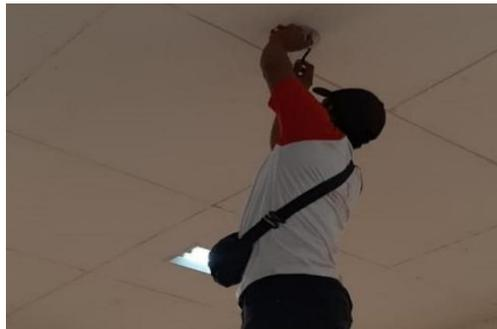
Gambar 3. 56 Pemasangan Lampu Down Light
