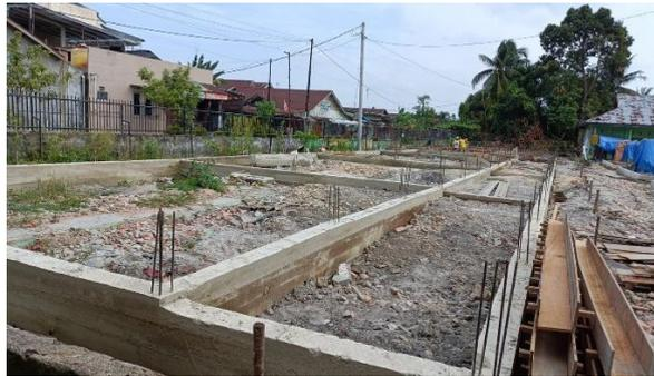
Gambar 3. 11 Pembongkaran Bekisting
