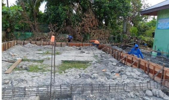
Gambar 3. 9 Pemasangan Bekisting Sloof
