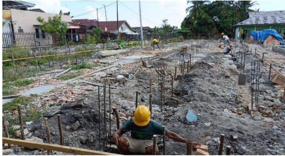
Gambar 3. 5 Pemasangan Pondasi Rollag
