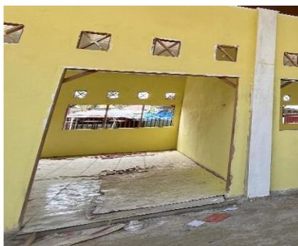
Gambar 3. 34 Pemasangan Ventilasi Pintu
