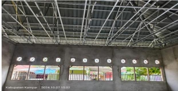
Gambar 3. 48 Pemasangan Rangka Hollow
