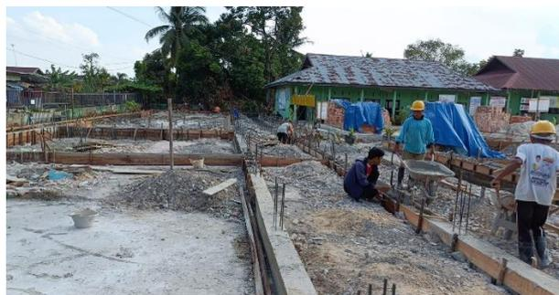
Gambar 3. 10 Pengecoran Sloof
