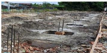
Gambar 3. 6 Pemasangan Bekisting Kolom Pedestel
