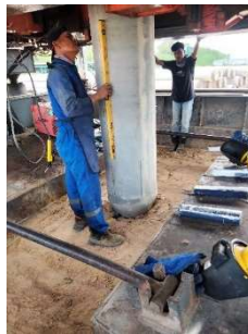
Gambar 3. 10 mengatur kepresisian spun pile (Sumber: Dokumentasi Kerja Praktek, 2024)
