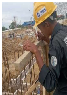
Gambar 3. 85 pengaturan elevasi anchor (Sumber: Dokumentasi Kerja Praktek, 2024)
