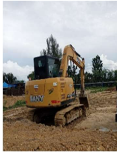
Gambar 3. 91 Excavator (Sumber: Dokumentasi Kerja Praktek, 2024)
