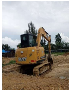
Gambar 3. 101 Excavator (Sumber: Dokumentasi Kerja Praktek, 2024)
