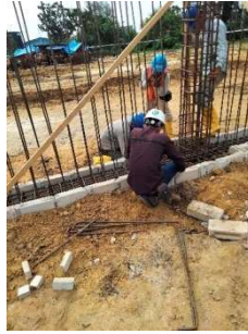
Gambar 3. 56 Pekerjaan pemasangan tulangan dinding ke Tie Bim (Sumber: Dokumentasi Kerja Praktek, 2024)
