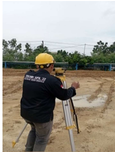
Gambar 3. 21 Centring alat akur waterpass (Sumber: Dokumentasi Kerja Praktek, 2024)
