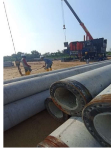
Gambar 3. 7 Spun pile (Sumber: Dokumentasi Kerja Praktek, 2024)
