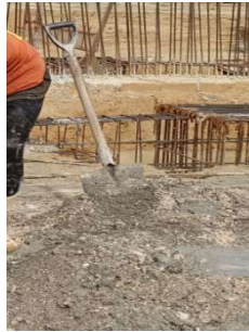
Gambar 3. 27 Sekop (Sumber: Dokumentasi Kerja Praktek, 2024)
