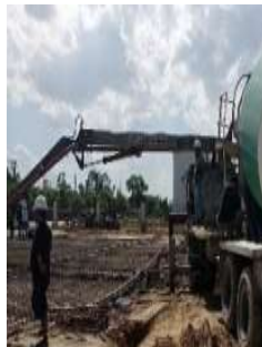
Gambar 3. 113 Concrete pump (Sumber: Dokumentasi Kerja Praktek, 2024)
