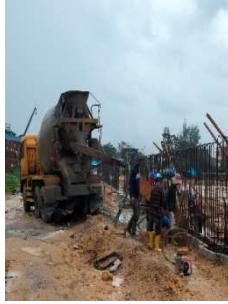
Gambar 3. 63 penuangan beton (Sumber: Dokumentasi Kerja Praktek, 2024)
