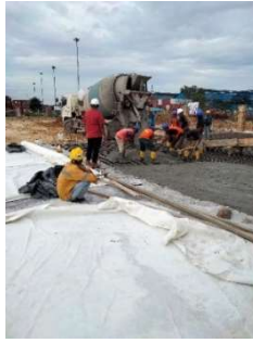
Gambar 3. 117 Pekerjaan pengecoran lantai (Sumber: Dokumentasi Kerja Praktek, 2024)
