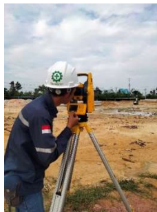
Gambar 3. 3 Pekerjaan stake out (Sumber: Dokumentasi Kerja Praktek, 2024)
