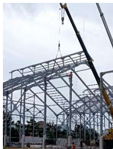
Gambar 3. 146 Pekerjaan erection atap (Sumber: Dokumentasi Kerja Praktek, 2024)
