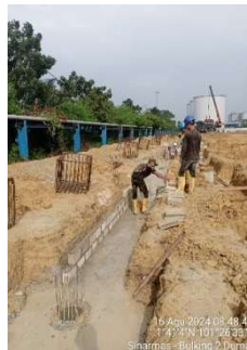
Gambar 3. 31 Pekerjaan urug pasir dan lantai kerja (Sumber: Dokumentasi Kerja Praktek, 2024)
