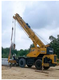
Gambar 3. 131 Mobile crane (Sumber: Dokumentasi Kerja Praktek, 2024)
