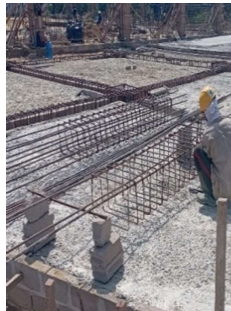
Gambar 3. 45 Pekerjaan pengangkatan tulangan Tie Bim (Sumber: Dokumentasi Kerja Praktek, 2024)
