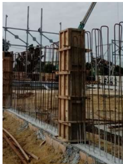
Gambar 3. 94 form work yang sudah terisi penuh (Sumber: Dokumentasi Kerja Praktek, 2024)
