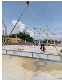
Gambar 3. 127 mengikat kolom baja dengan sling (Sumber: Dokumentasi Kerja Praktek, 2024)
