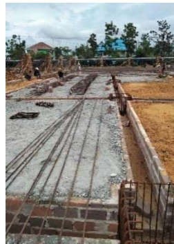
Gambar 3. 108 tulangan lantai (Sumber: Dokumentasi Kerja Praktek, 2024)
