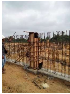
Gambar 3. 76 Pekerjaan perakitan formwork pedestal (Sumber: Dokumentasi Kerja Praktek, 2024)
