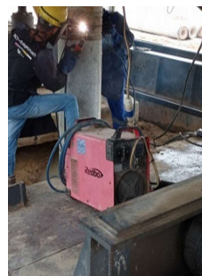
Gambar 3. 6 Alat las (Sumber: Dokumentasi Kerja Praktek, 2024)
