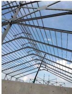
Gambar 3. 145 Pekerjaan erection atap (Sumber: Dokumentasi Kerja Praktek, 2024)
