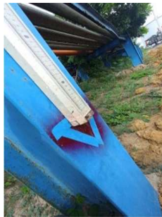
Gambar 3. 22 Pembacaan backsight (Sumber: Dokumentasi Kerja Praktek, 2024)
