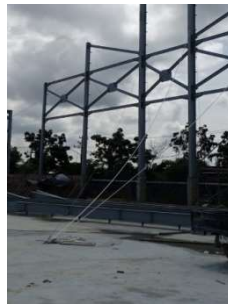
Gambar 3. 130 pemasangan tali penguat (Sumber: Dokumentasi Kerja Praktek, 2024)
