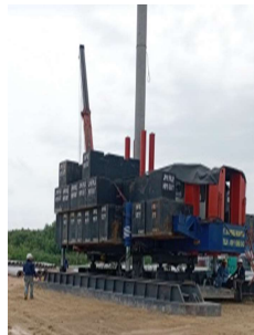
Gambar 3. 14 Penekanan spun pile (Sumber: Dokumentasi Kerja Praktek, 2024)
