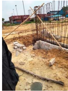
Gambar 3. 51 Pekerjaan pengangkatan tulangan (Sumber: Dokumentasi Kerja Praktek 2024 )
