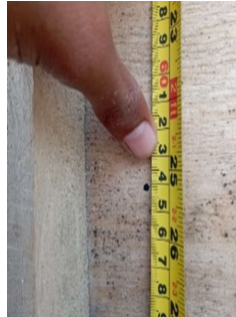
Gambar 3. 87 pengecekan ulang elevasi anchor (Sumber: Dokumentasi Kerja Praktek, 2024)
