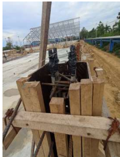
Gambar 3. 80 Anchor bolt (Sumber: Dokumentasi Kerja Praktek, 2024)
