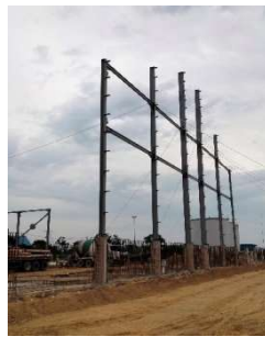
Gambar 3. 138 Erection balok baja (Sumber: Dokumentasi Kerja Praktek, 2024)
