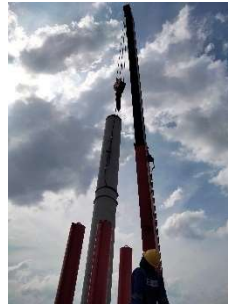
Gambar 3. 11 penekanan spun pile (Sumber: Dokumentasi Kerja Praktek, 2024)
