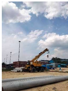
Gambar 3. 8 melangsir tiang pancang (Sumber: Dokumentasi Kerja Praktek, 2024)
