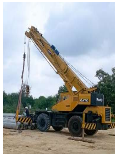
Gambar 3. 121 Mobile Crane (Sumber: Dokumentasi Kerja Praktek, 2024)
