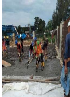
Gambar 3. 118 meratakan coran lantai (Sumber: Dokumentasi Kerja Praktek, 2024)
