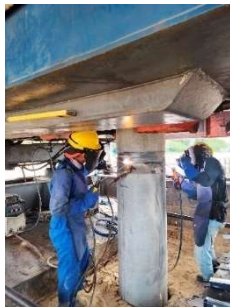
Gambar 3. 13 Penyambungan spun pile (Sumber: Dokumentasi Kerja Praktek, 2024)
