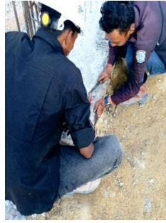
Gambar 3. 83 penentuan titik as anchor (Sumber: Dokumentasi Kerja Praktek, 2024)
