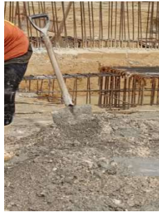
Gambar 3. 115 Sekop (Sumber: Dokumentasi Kerja Praktek, 2024)
