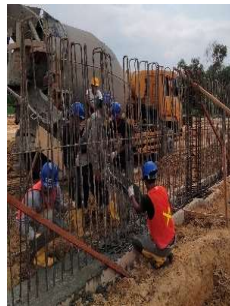
Gambar 3. 70 Pekerjaan pengecoran tie bim (Sumber: Dokumentasi Kerja Praktek, 2024)
