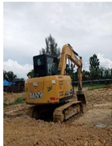
Gambar 3. 16 Excavator (Sumber: Dokumentasi Kerja Praktek, 2024)
