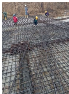
Gambar 3. 111 Pekerjaan lantai (Sumber: Dokumentasi Kerja Praktek, 2024)
