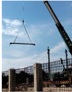
Gambar 3. 137 Pengangkatan balok baja (Sumber: Dokumentasi Kerja Praktek, 2024)
