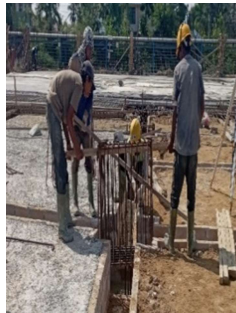
Gambar 3. 40 Pekerjaan pengangkatan tulangan (Sumber: Dokumentasi Kerja Praktek, 2024)
