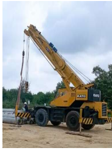
Gambar 3. 139 Mobile crane (Sumber: Dokumentasi Kerja Praktek, 2024)
