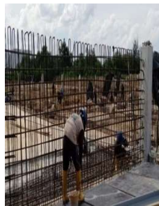
Gambar 3. 57 Pekerjaan pemasangan tulangan vertikal dinding (Sumber: Dokumentasi Kerja Praktek, 2024)
