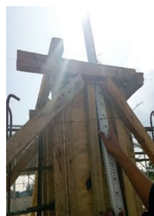
Gambar 3. 86 pengaturan elevasi anchor (Sumber: Dokumentasi Kerja Praktek, 2024)
