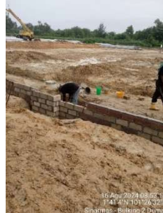
Gambar 3. 33 pemasangan spesi pada batako (Sumber: Dokumentasi Kerja Praktek, 2024)
