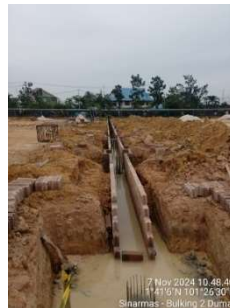
Gambar 3. 34 Pekerjaan pemasangan formwork (Sumber: Dokumentasi Kerja Praktek, 2024)
