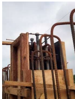
Gambar 3. 89 Pekerjaan pemasangan anchor (Sumber: Dokumentasi Kerja Praktek, 2024)
