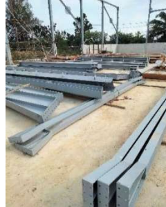
Gambar 3. 126 material baja (Sumber: Dokumentasi Kerja Praktek, 2024)
