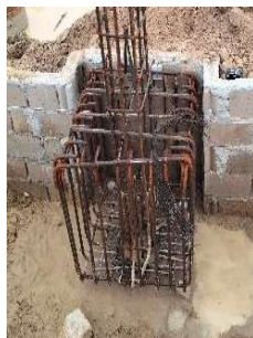
Gambar 3. 42 Pekerjaan pemasangan tulangan (Sumber: Dokumentasi Kerja Praktek, 2024)
