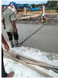
Gambar 3. 120 Pekerjaan pengecoran lantai (Sumber: Dokumentasi Kerja Praktek, 2024)
