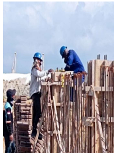
Gambar 3. 84 menarik benang ke anchor (Sumber: Dokumentasi Kerja Praktek, 2024)
