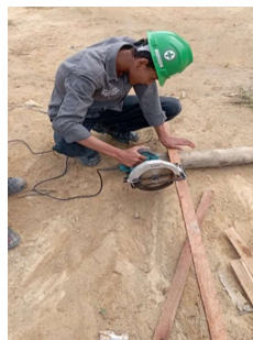
Gambar 3. 75 Pekerjaan pemotongan formwork pedestal (Sumber: Dokumentasi Kerja Praktek, 2024)
