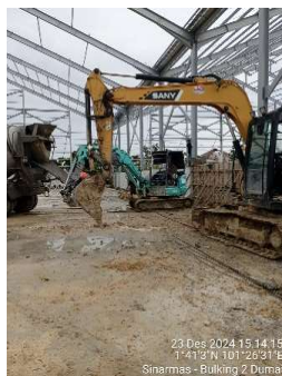
Gambar 3. 104 Pekerjaan pengecoran dinding (Sumber: Dokumentasi Kerja Praktek, 2024)
