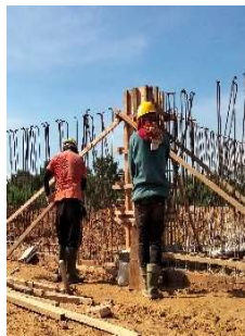
Gambar 3. 77 Pekerjaan pemasangan formwork pedestal (Sumber: Dokumentasi Kerja Praktek, 2024)
