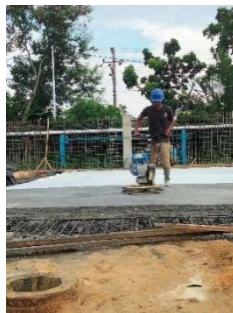
Gambar 3. 119 menghaluskan trowel beton (Sumber: Dokumentasi Kerja Praktek, 2024)
