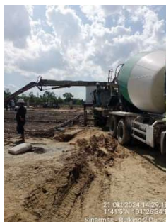
Gambar 3. 116 concrete pump dan truk mixer (Sumber: Dokumentasi Kerja Praktek, 2024)
