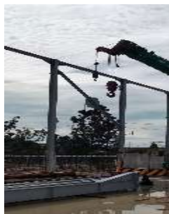
Gambar 3. 136 Pemasangan bracing (Sumber: Dokumentasi Kerja Praktek, 2024)
