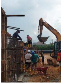
Gambar 3. 93 Pekerjaan pengecoran kolom pedestal (Sumber: Dokumentasi Kerja Praktek, 2024)
