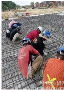
Gambar 3. 109 pekerjaan perakitan tulangan lantai (Sumber: Dokumentasi Kerja Praktek, 2024)
