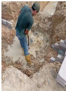
Gambar 3. 36 Pekerjaan pembobokan spun pile (Sumber: Dokumentasi Kerja Praktek, 2024)
