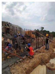
Gambar 3. 65 Pekerjaan pengecoran pile cap 1 (Sumber: Dokumentasi Kerja Praktek, 2024)
