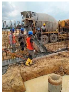
Gambar 3. 68 Arahkan corong ke tie bim (Sumber: Dokumentasi Kerja Praktek, 2024)
