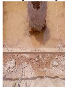
Gambar 3. 32 Pemasangan benang acuan (Sumber: Dokumentasi Kerja Praktek, 2024)
