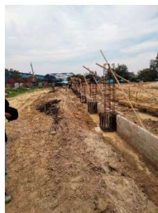
Gambar 3. 53 Pekerjaan pemasangan tulangan pedestal (Sumber: Dokumentasi Kerja Praktek, 2024)
