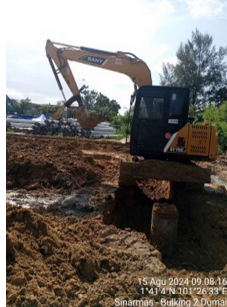
Gambar 3. 25 Excavator (Sumber: Dokumentasi Kerja Praktek, 2024)
