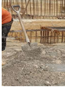
Gambar 3. 60 Sekop (Sumber: Dokumentasi Kerja Praktek, 2024)
