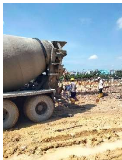
Gambar 3. 92 truk mixer (Sumber: Dokumentasi Kerja Praktek, 2024)
