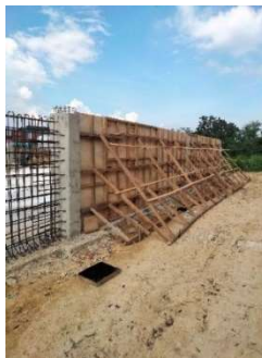
Gambar 3. 98 Pekerjaan pemasangan formwork dinding (Sumber: Dokumentasi Kerja Praktek, 2024)
