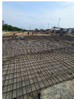
Gambar 3. 110 pekerjaan perakitan tulangan lantai lapisan ke 2 (Sumber: Dokumentasi Kerja Praktek, 2024)
