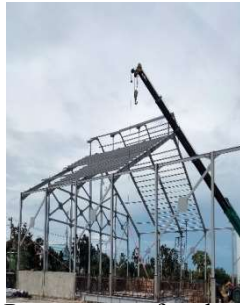
Gambar 3. 144 Pemasangan rafter ,bracing,dan gording (Sumber: Dokumentasi Kerja Praktek, 2024)
