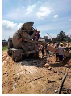
Gambar 3. 69 Pekerjaan pengecoran tie bim (Sumber: Dokumentasi Kerja Praktek, 2024)
