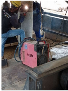
Gambar 3. 78 Alat las (Sumber: Dokumentasi Kerja Praktek, 2024)
