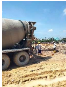
Gambar 3. 64 Pekerjaan pengecoran P1 (Sumber: Dokumentasi Kerja Praktek, 2024)
