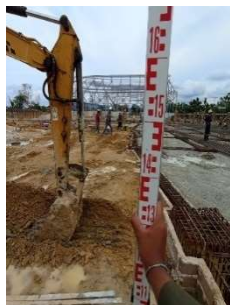
Gambar 3. 23 Excavator mulai menggali (Sumber: Dokumentasi Kerja Praktek, 2024)
