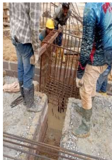
Gambar 3. 41 Pekerjaan pemasangan tulangan ke spun pile (Sumber: Dokumentasi Kerja Praktek, 2024)
