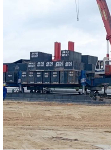
Gambar 3. 4 Hydraulic static pile driver (Sumber: Dokumentasi Kerja Praktek, 2024)
