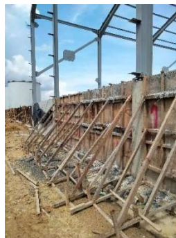
Gambar 3. 99 Pekerjaan pemasangan perancah dinding (Sumber: Dokumentasi Kerja Praktek, 2024)
