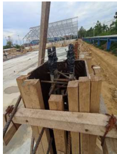
Gambar 3. 88 anchor yang sudah dibungkus (Sumber: Dokumentasi Kerja Praktek, 2024)
