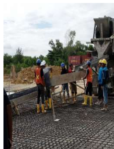
Gambar 3. 102 Playwood bekas pakai (Sumber: Dokumentasi Kerja Praktek, 2024)
