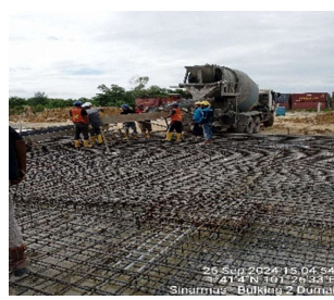
Pengecoran beton K-300
