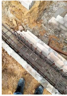
Gambar 3. 46 Pekerjaan pemasangan tulangan TIE BIM (Sumber: Dokumentasi Kerja Praktek 2024 )
