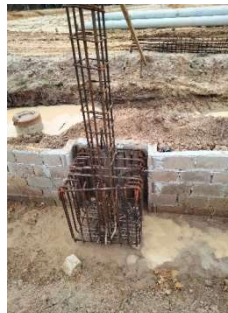
Gambar 3. 52 Pekerjaan pemasangan tulangan ke spun pile (Sumber: Dokumentasi Kerja Praktek 2024 )
