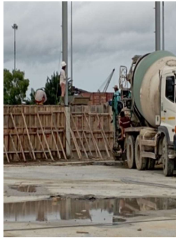
Gambar 3. 103 pengecoran dinding (Sumber: Dokumentasi Kerja Praktek, 2024)
