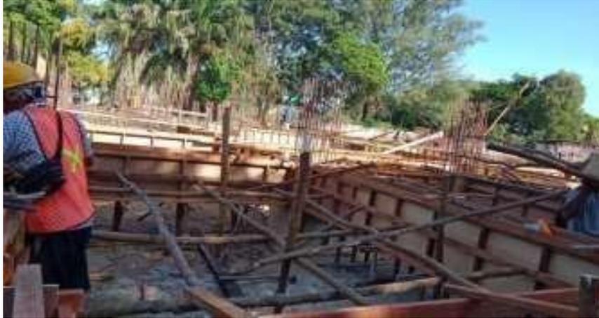
Gambar 3. 13 Pemasangan Bekisting
