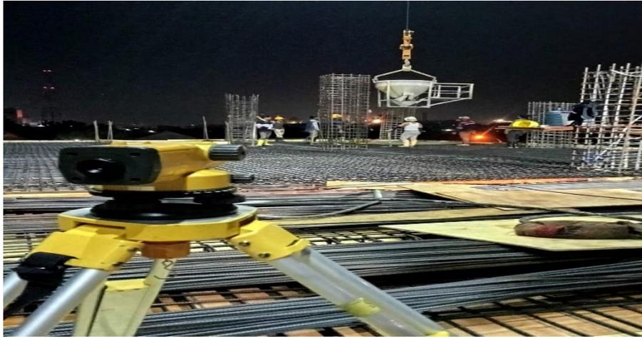
Gambar 3. 5 Pengukuran elevasi pengecoran
