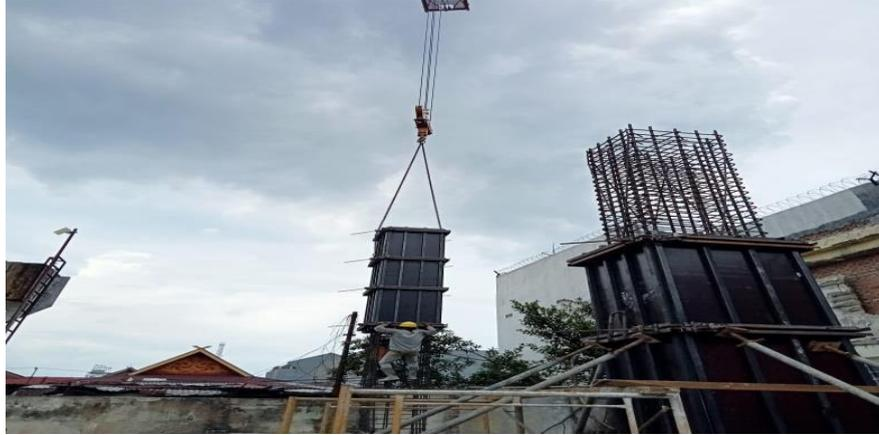
Gambar 3. 17 Proses Pemasangan Bekisting Kolom
