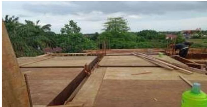
Gambar 3. 26 Pemasangan Bekisting
