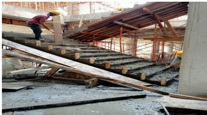
Gambar 3. 33 Pembongkaran Bekisting
