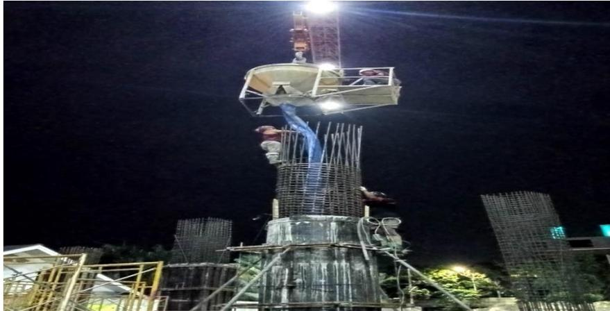
Gambar 3. 18 Pengecoran Kolom
