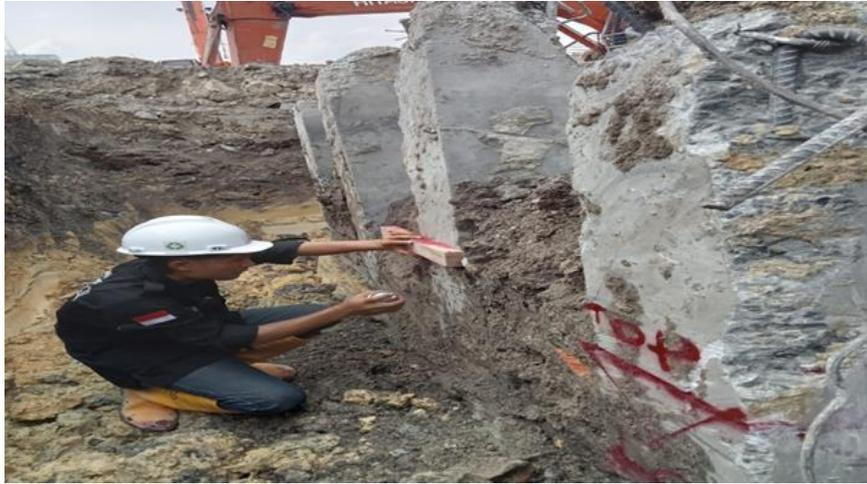
Gambar 3. 2 Pengukuran Top LC
