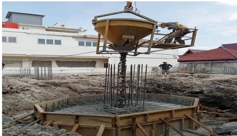
Gambar 3. 9 Proses Pengecoran
