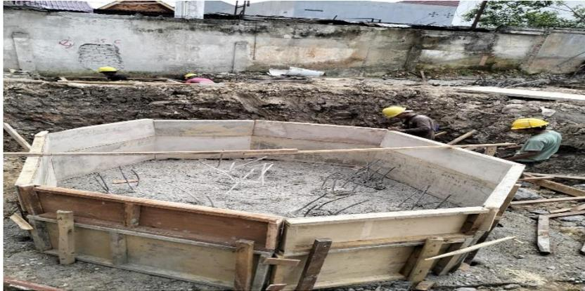
Gambar 3. 7 Proses perakitan bekisting
