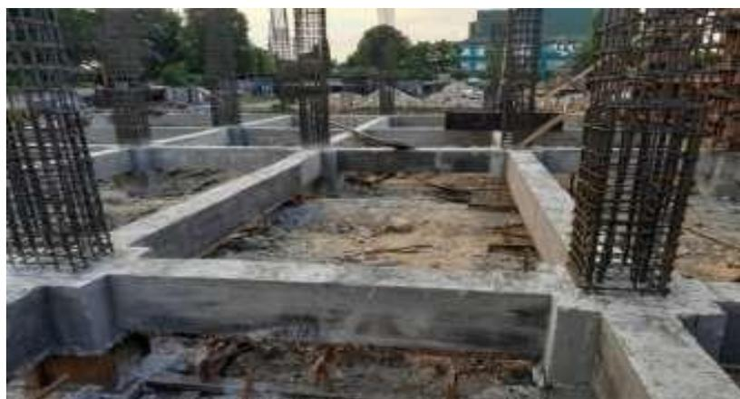
Gambar 3. 15 Pembongkaran Bekisting
