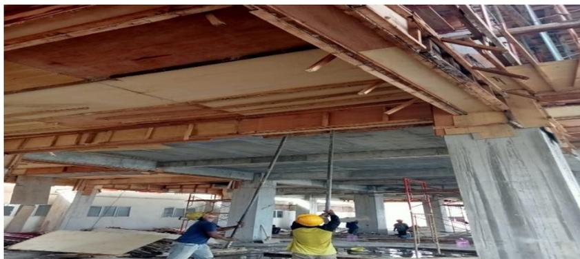
Gambar 3. 29 Pembongkaran Bekisting
