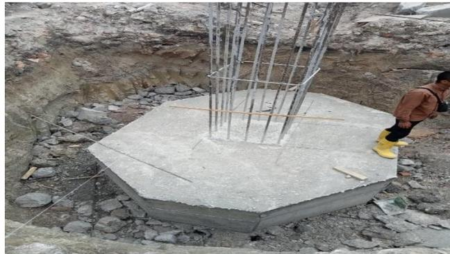
Gambar 3. 10 Proses Pembongkaran Bekisting
