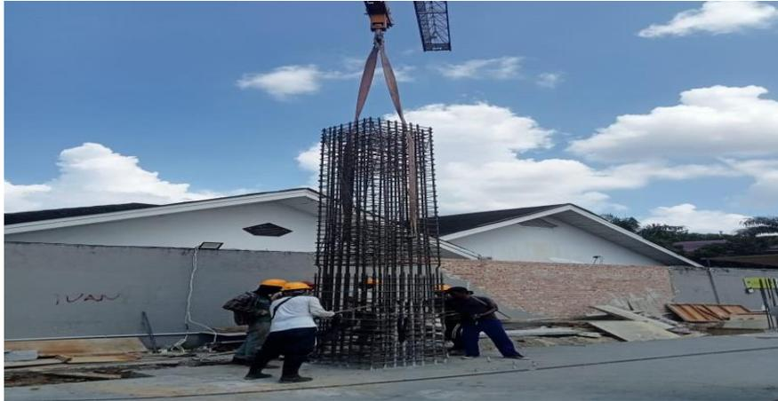
Gambar 3. 16 Proses Penulangan Kolom
