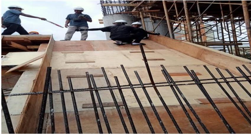
Gambar 3. 30 Pemasangan Bekisting
