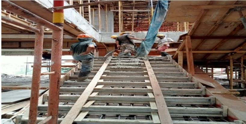
Gambar 3. 32 Pengecoran tangga
