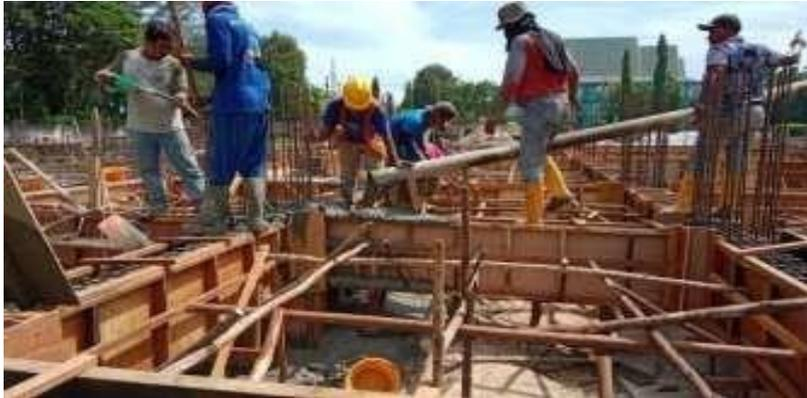
Gambar 3. 14 Proses Pengecoran Balok Sloof
