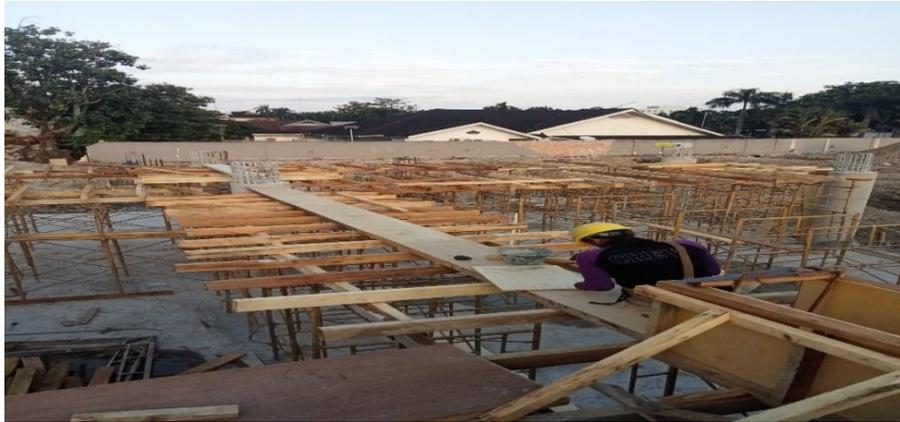
Gambar 3. 22 Pemasangan Bekisting
