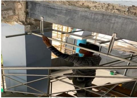
Gambar 3.24 Pekerjaan Pemasangan Profil Gantung
