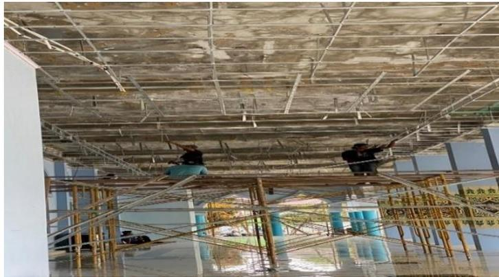
Gambar 3.23 Pekerjaan Pemasangan Profil utama
