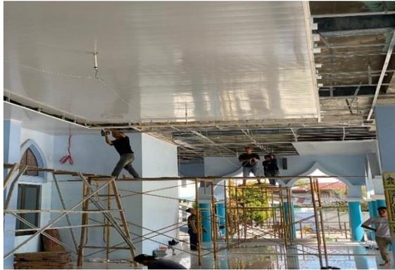
Gambar 3.27 Pekerjaan Pemasangan Plafond
