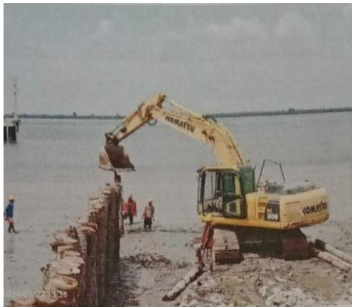
Gambar 3.15 Pemancang Batang Kelapa
