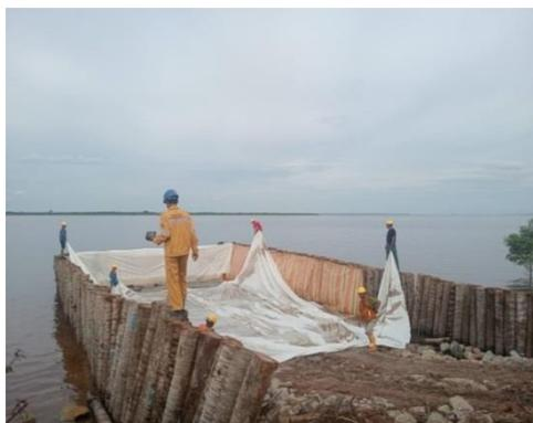
Gambar 3.17 Pemasangan *geotextile*
