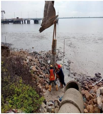
Gambar 3.12 Proses Pondasi Batang Kelapa
