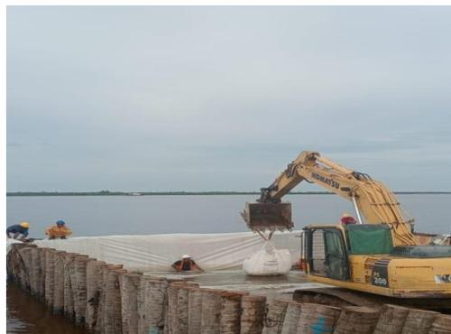
Gambar 3.20 Penyusunan *Jumbo Bag*
