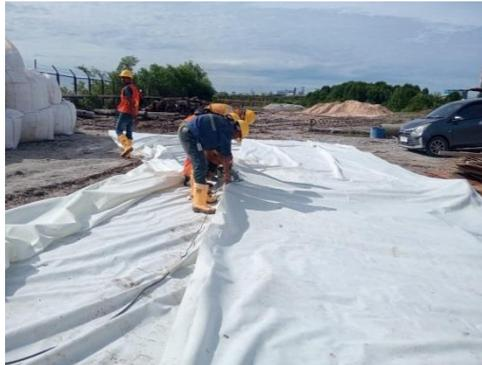
Gambar 3.16 Penjahitan *geotextile*
