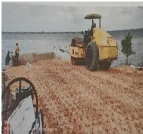
Gambar 3.22 Pematatan Tanah
