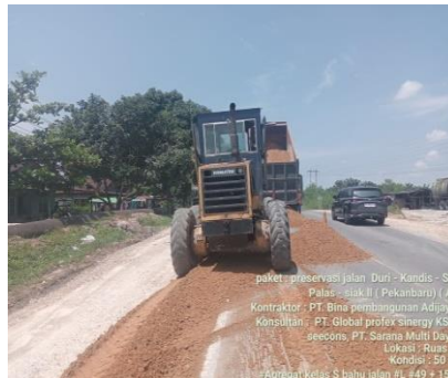
Gambar 3. 105 Penghamparan material agregat kelas S (Sumber Dokumentasi Lapangan 2025)
