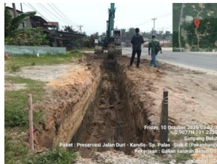
Gambar 3. 73 Galian Saluran Menggunakan Excavator (Sumber Dokumentasi Lapangan 2025)
