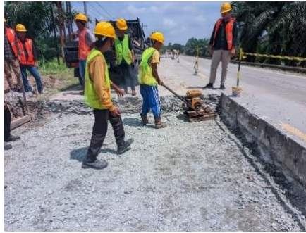
Gambar 3. 38 Pemadatan menggunakan Hand stamper (Sumber Dokumentasi Lapangan 2025)
