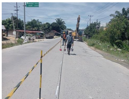
Gambar 3. 31 Penandaan Area Cutting (Sumber Dokumentasi Lapangan 2025)
