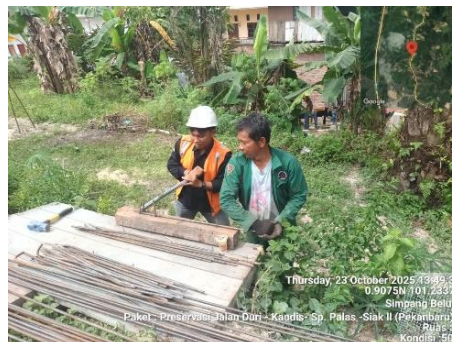
Gambar 3. 87 Memotong dan membengkokkan besi tulangan (Sumber Dokumentasi Lapangan 2025)
