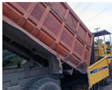
Gambar 3. 24 Menuangkan campuran ke hooper (Sumber Dokumentasi Lapangan 2025)
