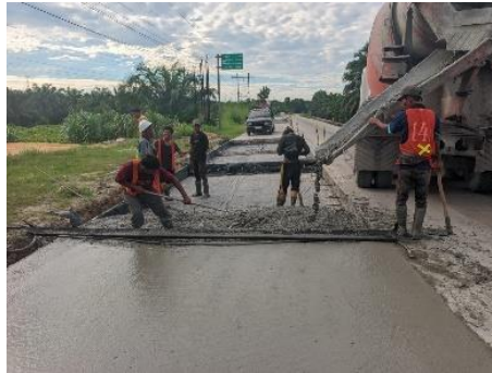
Gambar 3. 49 Meratakan Beton (Sumber Dokumentasi Lapangan 2025)
