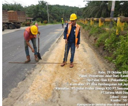
Gambar 3. 104 Opname pada area yang sudah di kupas (Sumber Dokumentasi Lapangan 2025)
