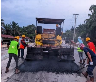
Gambar 3. 62 Penghamparan aspal dan diratakan (Sumber Dokumentasi Lapangan 2025)
