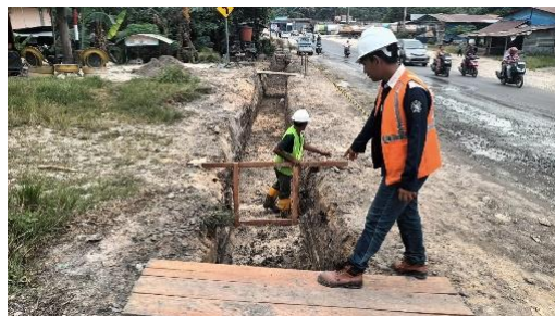
Gambar 3. 74 Pemasangan patok Kayu (Sumber Dokumentasi Lapangan 2025)
