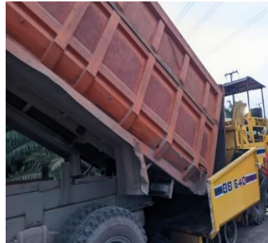
Gambar 3. 61 Menuangkan campuran aspal panas (Sumber Dokumentasi Lapangan 2025)
