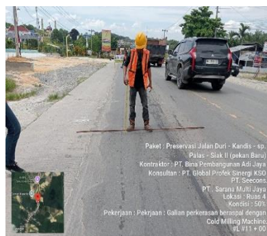
Gambar 3. 66 Menentukan kedalaman pengupasan (Sumber Dokumentasi Lapangan 2025)
