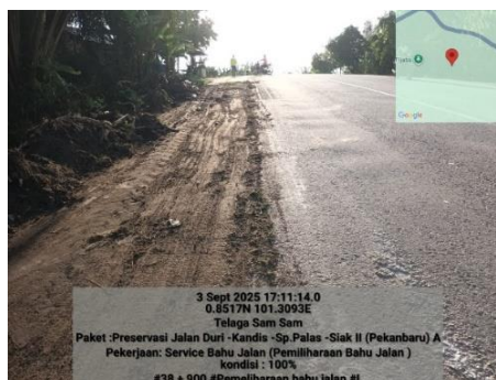
Gambar 3. 8 Tampak kondisi Bahu Jalan Setelah Bersih (Sumber Dokumentasi Lapangan 2025)
