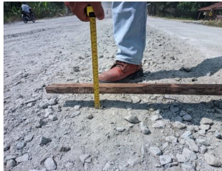
Gambar 3. 21 Opname Setelah Dikupas (Sumber Dokumentasi Lapangan 2025)
