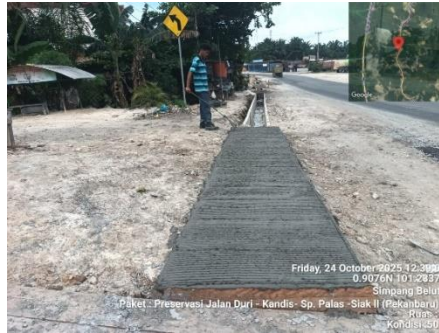
Gambar 3. 91 Menggroving plat jalan masuk (Sumber Dokumentasi Lapangan 2025)
