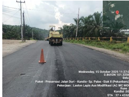
Gambar 3. 99 Pemadatan akhir aspal Menggunakan pneumatic tire roller (Sumber Dokumentasi Lapangan 2025)
