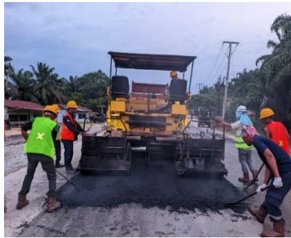
Gambar 3. 25 Penghamparan aspal dan diratakan (Sumber Dokumentasi Lapangan 2025)
