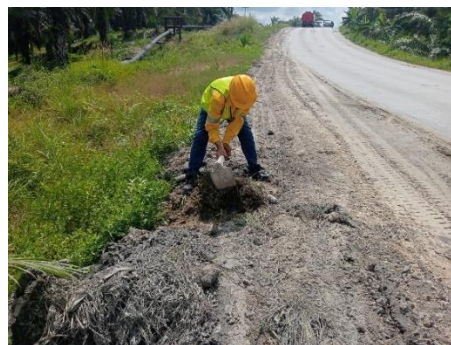
Gambar 3. 7 Pembuatan Saluran Air (Sumber Dokumentasi Lapangan 2025)
