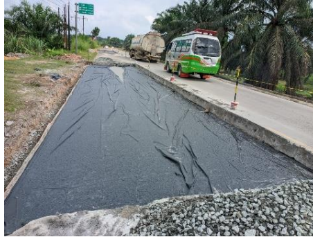
Gambar 3. 44 Pemasangan plastik beton (Sumber Dokumentasi Lapangan 2025)
