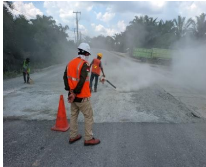
Gambar 3. 22 Compressor Permukaan Jalan (Sumber Dokumentasi Lapangan 2025)
