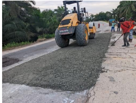
Gambar 3. 17 Pemadatan Agregat Kelas A (Sumber Dokumentasi Lapangan 2025)
