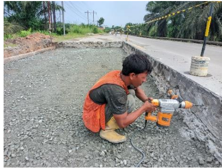
Gambar 3. 46 Pemasangan Tie-bar (Sumber Dokumentasi Lapangan 2025)
