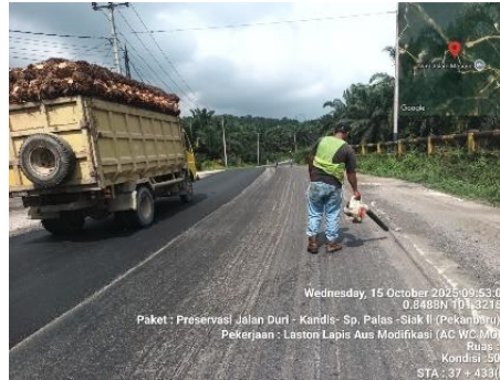
Gambar 3. 94 Membersihkan Permukaan Jalan (Sumber Dokumentasi Lapangan 2025)
