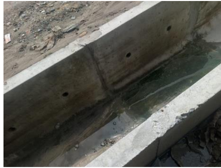
Gambar 3. 83 Penyambungan / Jointing U-Ditch. (Sumber Dokumentasi Lapangan 2025)
