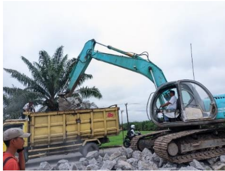
Gambar 3. 34 Pengangkutan material bongkaran beton (Sumber Dokumentasi Lapangan 2025)
