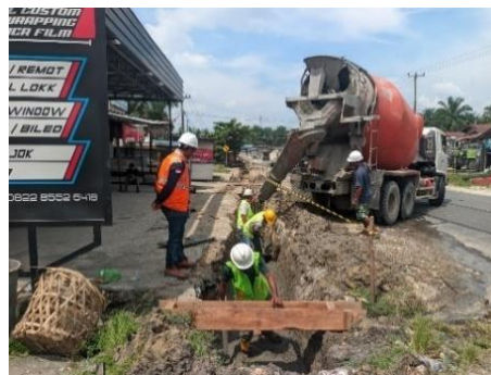
Gambar 3. 79 Meratakan LC menggunakan cangkul, raskam kayu (Sumber Dokumentasi Lapangan 2025)
