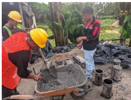
Gambar 3. 42 Pengambilan sampel beton (Sumber Dokumentasi Lapangan 2025)
