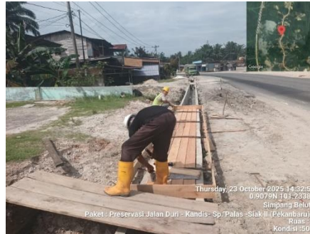
Gambar 3. 86 Pemasangan bekisting kayu (Sumber Dokumentasi Lapangan 2025)
