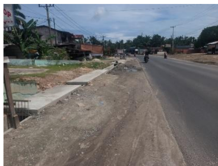
Gambar 3. 93 Plat jalan masuk bisa digunakan (Sumber Dokumentasi Lapangan 2025)
