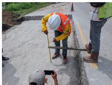
Gambar 3. 36 Opname Galian Beton (Sumber Dokumentasi Lapangan 2025)
