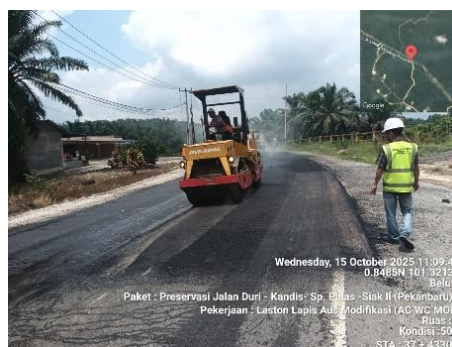
Gambar 3. 98 Pemadatan awal aspal Menggunakan Tandem Roller (Sumber Dokumentasi Lapangan 2025)
