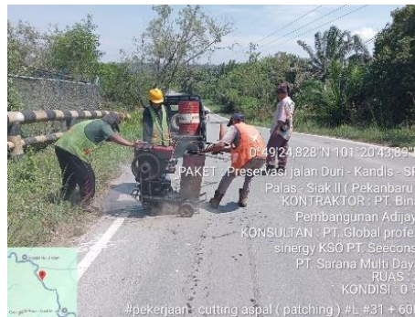
Gambar 3. 57 Pemotongan Batas Galian ( Cutting ) (Sumber Dokumentasi Lapangan 2025)
