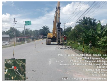
Gambar 3. 33 Pembongkaran / Galian Perkerasan Rigid (Sumber Dokumentasi Lapangan 2025)
