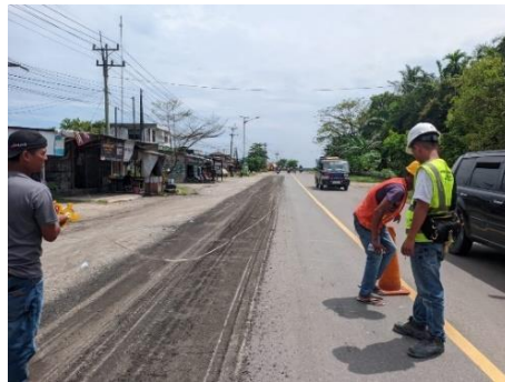
Gambar 3. 70 Pembersihan area hasil milling (Sumber Dokumentasi Lapangan 2025)
