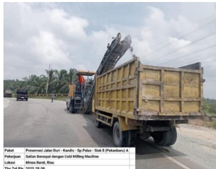
Gambar 3. 68 Galian beraspal dengan menggunakan alat cold milling machine (Sumber Dokumentasi Lapangan 2025)
