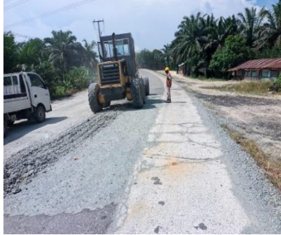
Gambar 3. 20 Pengupasan Agregat Kelas A (Sumber Dokumentasi Lapangan 2025)
