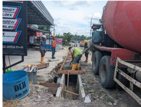
Gambar 3. 89 Pengecoran Beton Pelat Jalan Masuk (Sumber Dokumentasi Lapangan 2025)
