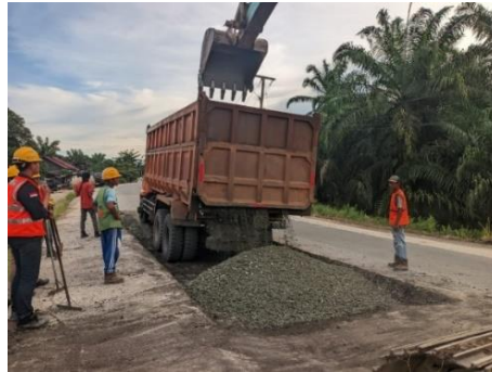
Gambar 3. 14 Penghamparan Material Agregat (Sumber Dokumentasi Lapangan 2025)
