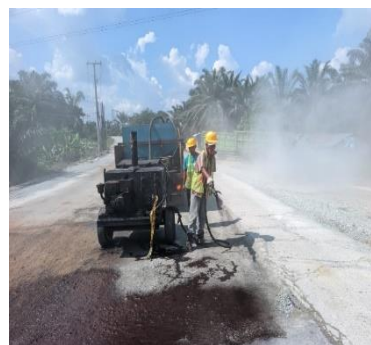
Gambar 3. 60 Penyemprotan Tack Coat (Sumber Dokumentasi Lapangan 2025)
