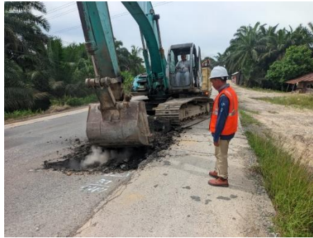
Gambar 3. 11 Membongkar lapisan aspal (Sumber Dokumentasi Lapangan 2025)
