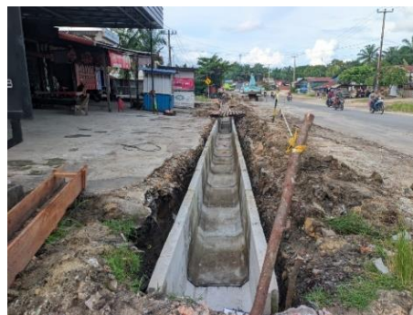
2. Selanjutnya Pemeriksaan Saluran U-Ditch , sebelum pelat jalan masuk dibuat: Pastikan U-Ditch di lokasi tersebut telah terpasang dengan baik dan Permukaan sekeliling U-Ditch bersih dari lumpur dan sampah.
