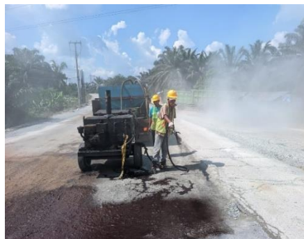
Gambar 3. 23 Penyemprotan Prime Coat (Sumber Dokumentasi Lapangan 2025)
