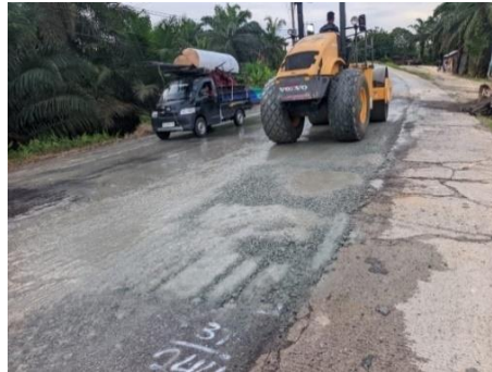
Gambar 3. 19 Pemadatan yang Kedua Agregat Kelas A (Sumber Dokumentasi Lapangan 2025)
