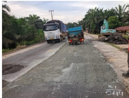
Gambar 3. 18 Penyiraman Agregat (Sumber Dokumentasi Lapangan 2025)
