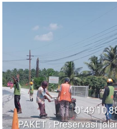
Gambar 3. 10 Cutting Aspal (Sumber Dokumentasi Lapangan 2025)
