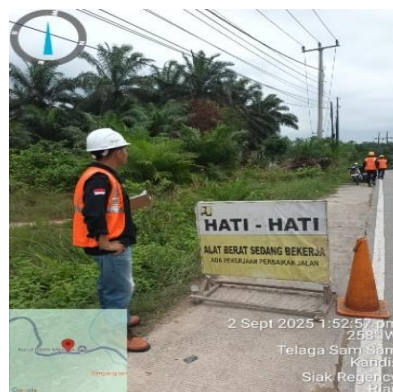
Gambar 3. 101 Memasang rambu-rambu peringatan (Sumber Dokumentasi Lapangan 2025)
