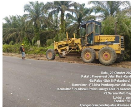
Gambar 3. 102 Membersihkan area bahu jalan ( Clearing ) (Sumber Dokumentasi Lapangan 2025)
