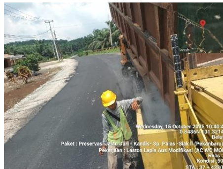
Gambar 3. 96 penuangan aspal AC-WC ke hooper finisher (Sumber Dokumentasi Lapangan 2025)
