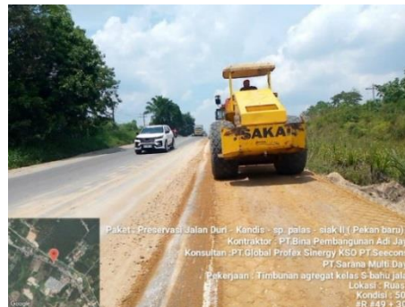
Gambar 3. 107 Pemadatan agregat Kelas S menggunakan alat vibratory roller (Sumber Dokumentasi Lapangan 2025)
