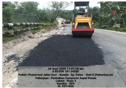
Gambar 3. 63 Pemadatan Menggunakan Roda Baja (Sumber Dokumentasi Lapangan 2025)
