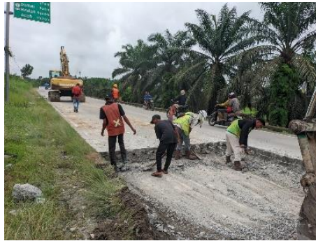
Gambar 3. 37 Opname Panjang dan Lebar Galian (Sumber Dokumentasi Lapangan 2025)
