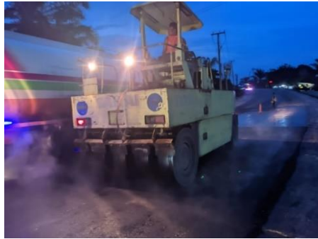
Gambar 3. 27 Pemadatan Akhir (Sumber Dokumentasi Lapangan 2025)
