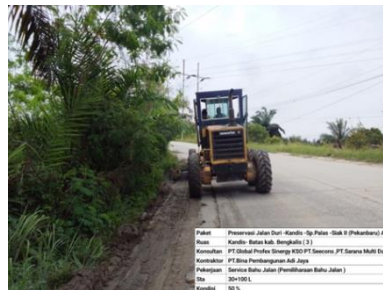
Gambar 3. 5 Pembersihan bahu jalan menggunakan motor grader (Sumber Dokumentasi Lapangan 2025)
