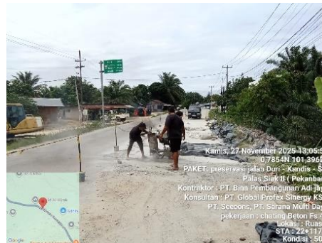
Gambar 3. 32 Cutting (Pemotongan Beton) (Sumber Dokumentasi Lapangan 2025)
