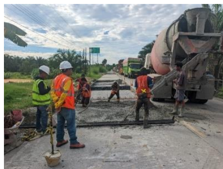
Gambar 3. 48 Penuangan beton rigid FS 45 (Sumber Dokumentasi Lapangan 2025)
