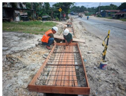
Gambar 3. 88 Pemasangan Tulangan (Reinforcement) (Sumber Dokumentasi Lapangan 2025)
