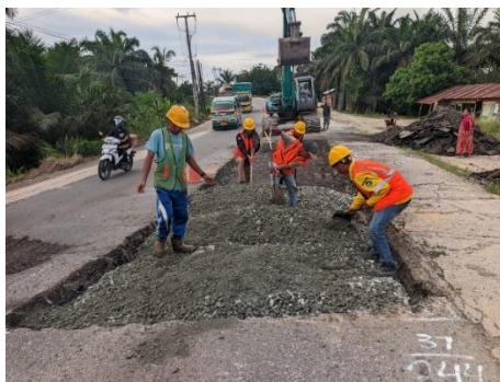
Gambar 3. 16 Meratakan Agregat Menggunakan Sekop (Sumber Dokumentasi Lapangan 2025)
