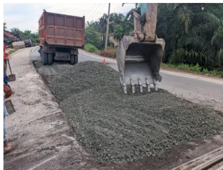
Gambar 3. 15 Meratakan Agregat Menggunakan Excavator (Sumber Dokumentasi Lapangan 2025)
