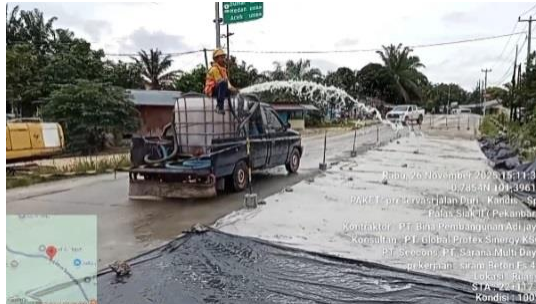
Gambar 3. 51 penyiraman beton (Sumber Dokumentasi Lapangan 2025)
