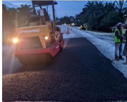
Gambar 3. 26 Pemadatan Awal (Sumber Dokumentasi Lapangan 2025)
