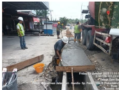
Gambar 3. 90 Meratakan Permukaan Beton (Sumber Dokumentasi Lapangan 2025)
