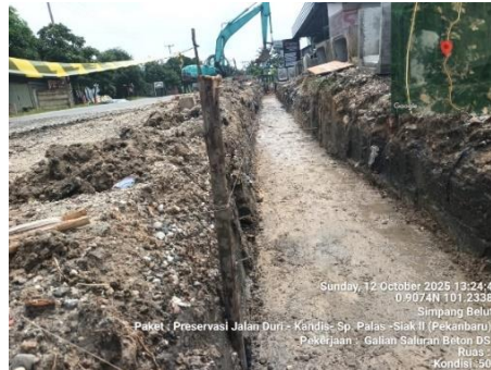
Gambar 3. 81 Memasang patok kayu (Sumber Dokumentasi Lapangan 2025)
