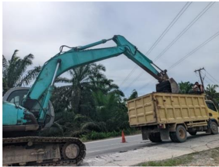
Gambar 3. 12 Mengangkut Material ke Dump Truck (Sumber Dokumentasi Lapangan 2025)
