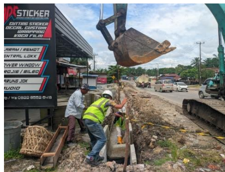
Gambar 3. 82 Pemasangan U Ditch tipe DS 3 (Sumber Dokumentasi Lapangan 2025)
