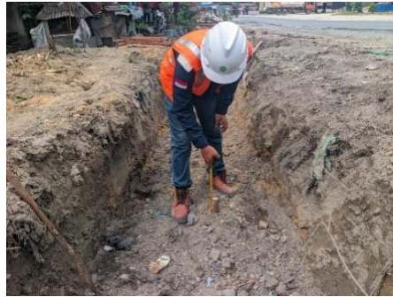
Gambar 3. 75 Pemasangan benang pada kayu (Sumber Dokumentasi Lapangan 2025)
