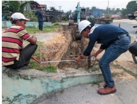
Gambar 3. 72 Pemasangan patok dan benang (Sumber Dokumentasi Lapangan 2025)
