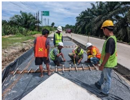
Gambar 3. 45 Pemasangan dowel bar (Sumber Dokumentasi Lapangan 2025)
