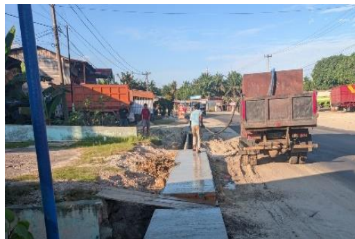
Gambar 3. 92 Perawatan Beton ( Curing ) (Sumber Dokumentasi Lapangan 2025)
