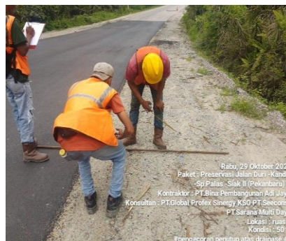
Gambar 3. 100 Pengecekan kondisi lokasi bahu jalan (Sumber Dokumentasi Lapangan 2025)
