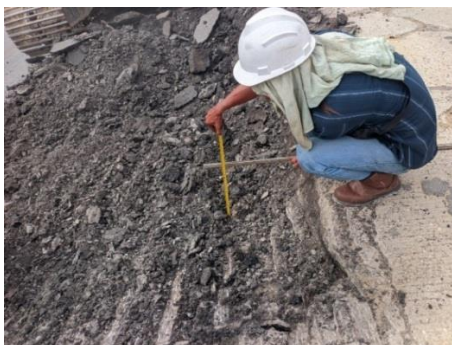
Gambar 3. 13 Opname kedalaman galian (Sumber Dokumentasi Lapangan 2025)
