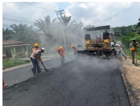
Gambar 3. 97 Meratakan Permukaan Aspal AC-WC (Sumber Dokumentasi Lapangan 2025)
