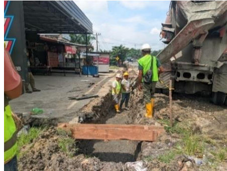
Gambar 3. 78 Pengecoran LC (Sumber Dokumentasi Lapangan 2025)
