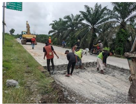
Gambar 3. 35 Pembersihan Bekas Galian Beton (Sumber Dokumentasi Lapangan 2025)
