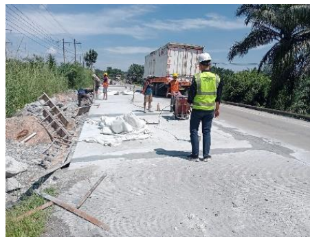
Gambar 3. 52 Cutting Beton (Sumber Dokumentasi Lapangan 2025)
