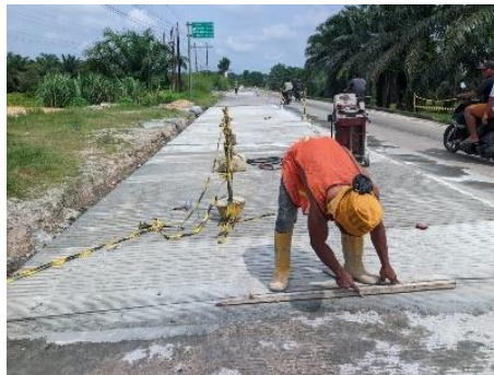
Gambar 3. 50 grooving Beton (Sumber Dokumentasi Lapangan 2025)
