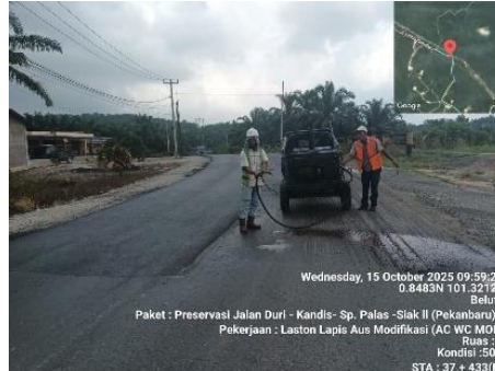
Gambar 3. 95 Penyemprotan Tack Coat (Sumber Dokumentasi Lapangan 2025)
