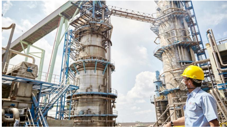
Gambar 1. 2 Pembangunan Fasilitas Produksi PT Indah Kiat Pulp & Paper Tbk. Sumber: (Indah Kiat Pulp & Paper , 2026): https://indahkiat.co.id/in/indah-kiat-perawang
