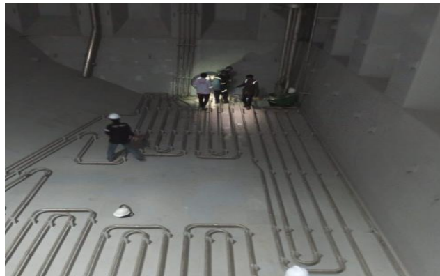
Gambar 3. 65 Proses pengecekan Pipa Pemanas
