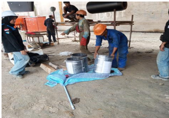
Gambar 3.70 Proses Pemasangan Bracket
