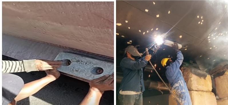
Gambar 4. 6 Pemasangan Zinc Anode
