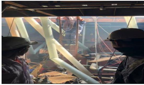
Gambar 3.15 Pemasangan pipa pada Tugboat
