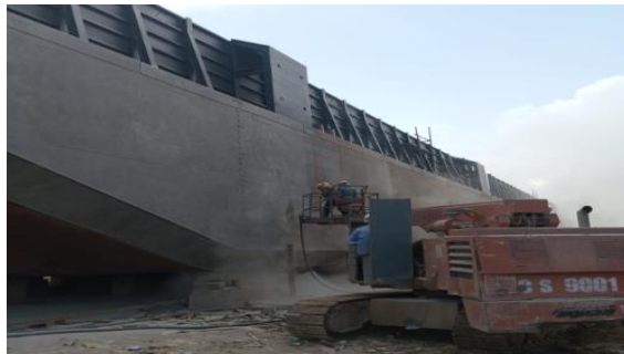
Gambar 3.68 Proses Blasting pada Shed Shell
