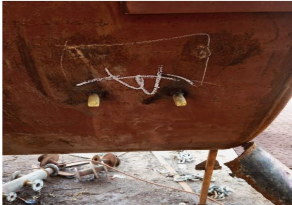
Gambar4. 2 Kedudukan Zinc Anode
