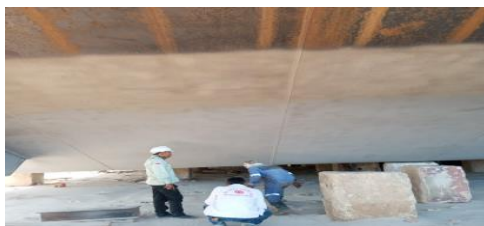
Gambar 3. 60 Inspeksi hasil Blasting
