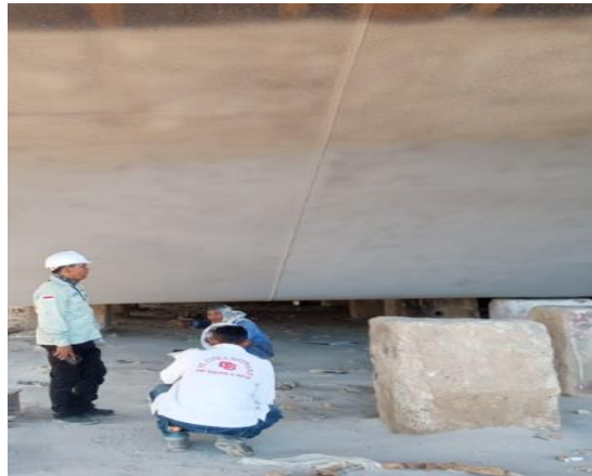
Gambar 4.14 Pemeriksaan Hasil Blasting
