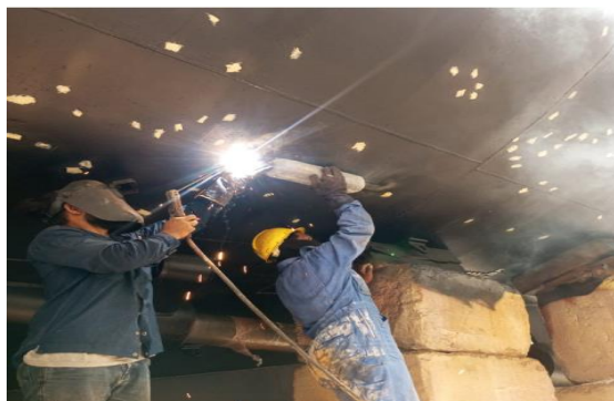
Gambar 3.71 Proses Pemasangan Zinc Anode
