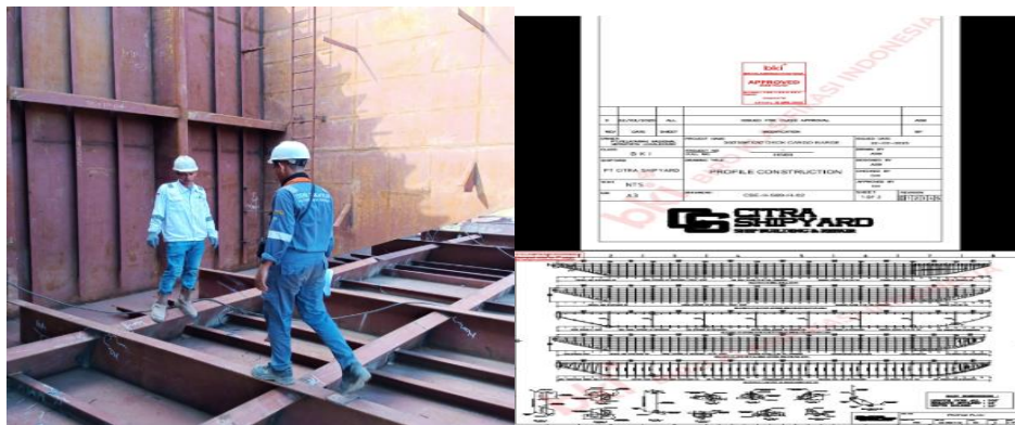
Gambar 3. 12 Pengecekan pada kapal Tongkang
