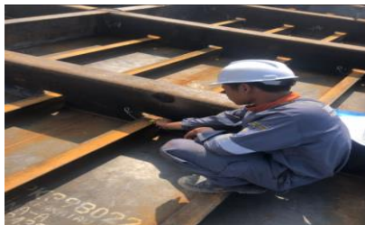
Gambar 3. 42 Inspeksi pada Main Deck
