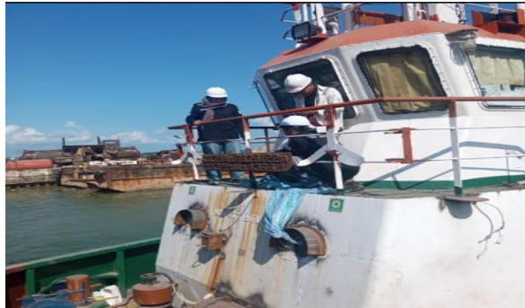
Gambar 3. 63 Mengukur Plat yang di Repair
