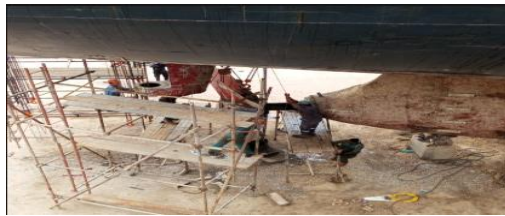
Gambar3. 59 Proses Pencabutan Propeler
