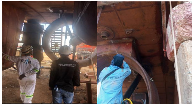
Gambar 3. 44 Proses Airtest pada Tangki Balas
