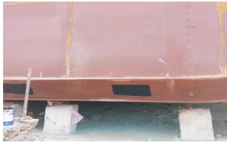
Gambar 4.4 Posisi Zinc Anode
